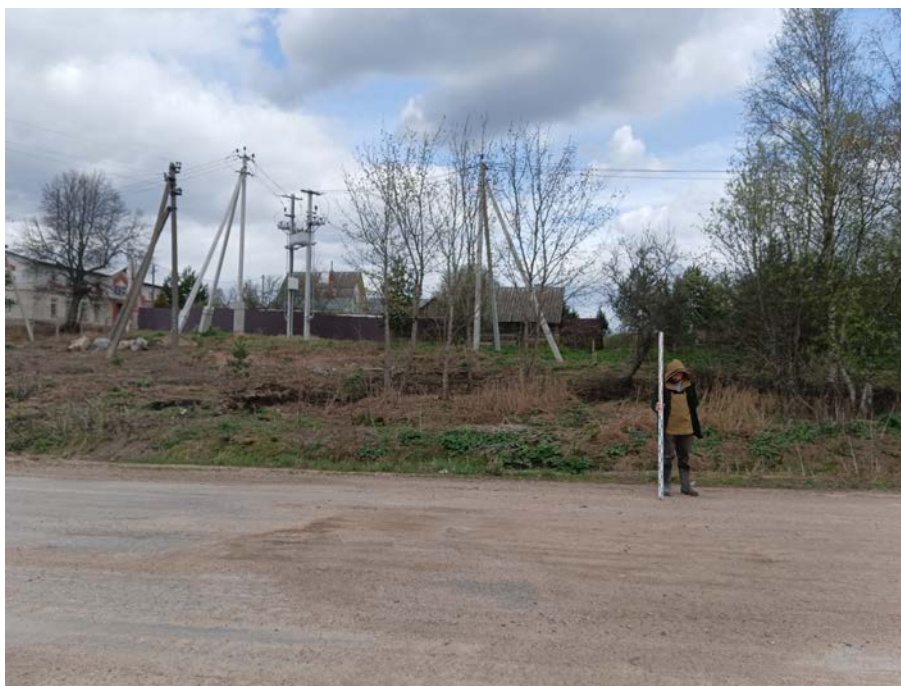
Рис. 141. Ленинградская область, Тосненский район, «Межпоселковый газопровод от д. Померанье до д. Чудской Бор Тосненского района Ленинградской области». 2023 г. Общий вид участка обследования. Точка фиксации 33. Вид с 3
