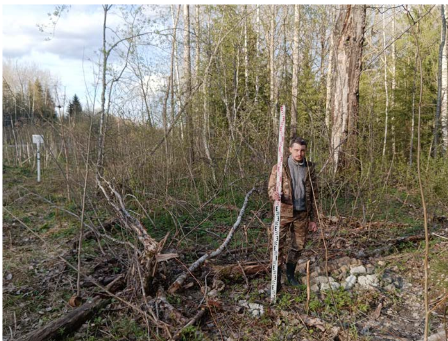
Рис. 114. Ленинградская область, Тосненский район, «Межпоселковый газопровод от д. Померанье до д. Чудской Бор Тосненского района Ленинградской области». 2023 г. Общий вид участка обследования. Точка фиксации 27. Вид с ЮЗ
