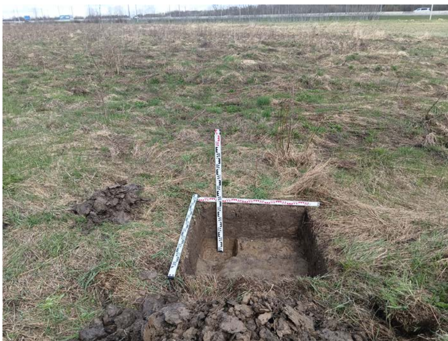
Рис. 18. Ленинградская область, Тосненский район, «Межпоселковый газопровод от д. Померанье до д. Чудской Бор Тосненского района Ленинградской области». 2023 г. Шурф 1. Зачистка по материке. Общий вид с Ю
