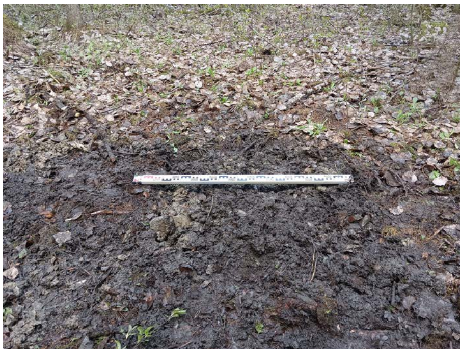
Рис. 39. Ленинградская область, Тосненский район, «Межпоселковый газопровод от д. Померанье до д. Чудской Бор Тосненского района Ленинградской области». 2023 г. Шурф 2. Рекультивация. Общий вид с Ю
