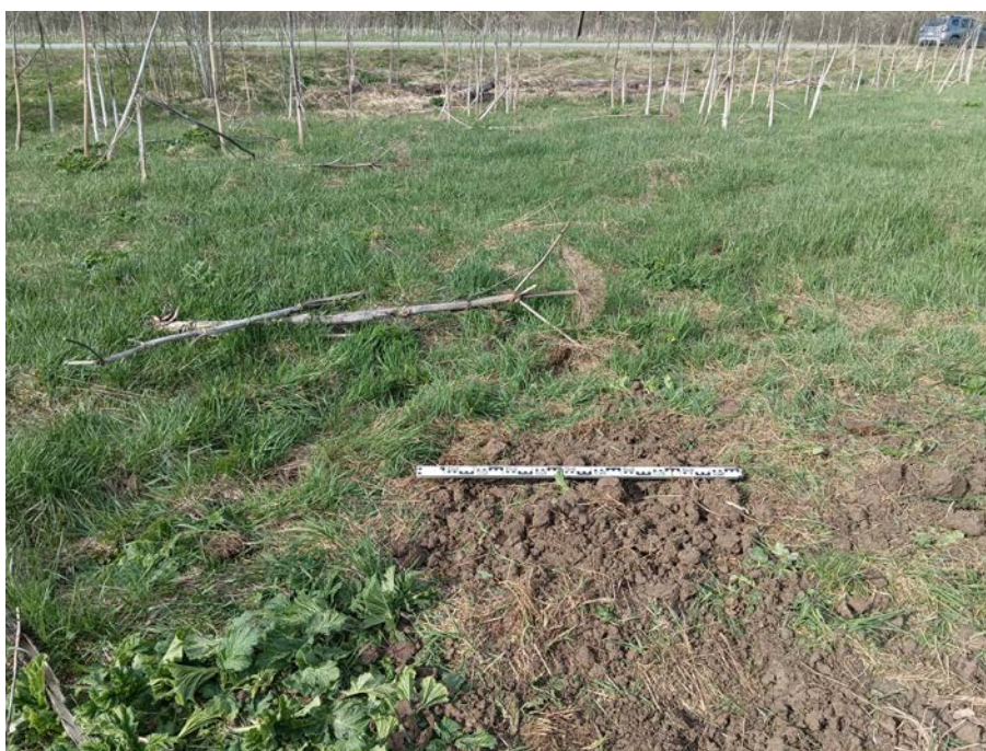
Рис. 124. Ленинградская область, Тосненский район, «Межпоселковый газопровод от д. Померанье до д. Чудской Бор Тосненского района Ленинградской области». 2023 г. Шурф 8. Рекультивация. Общий вид с Ю
