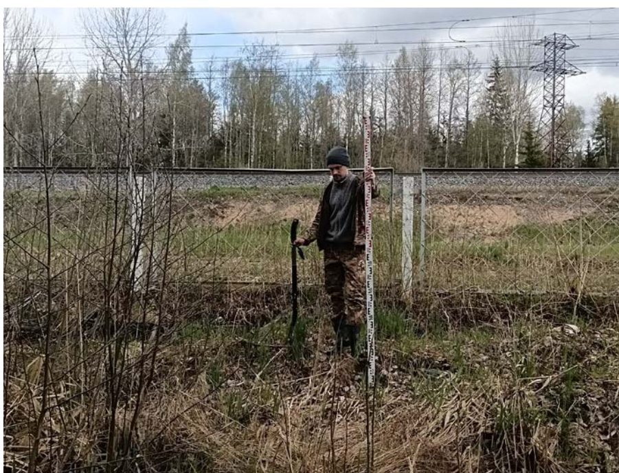
Рис. 42. Ленинградская область, Тосненский район, «Межпоселковый газопровод от д. Померанье до д. Чудской Бор Тосненского района Ленинградской области». 2023 г. Общий вид участка обследования. Точка фиксации 9. Вид с СВ
