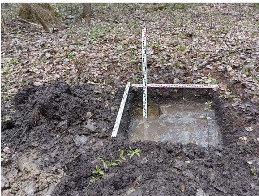
Рис. 36. Ленинградская область, Тосненский район, «Межпоселковый газопровод от д. Померанье до д. Чудской Бор Тосненского района Ленинградской области». 2023 г. Шурф 2. Зачистка по материку. Общий вид с Ю
