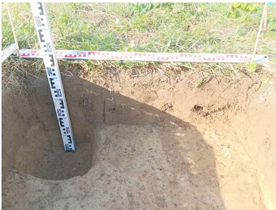
Рис. 79. Ленинградская область, Тосненский район, «Межпоселковый газопровод от д. Померанье до д. Чудской Бор Тосненского района Ленинградской области». 2023 г. Шурф 5. Северная стенка и контрольный прокоп. Вид с Ю
