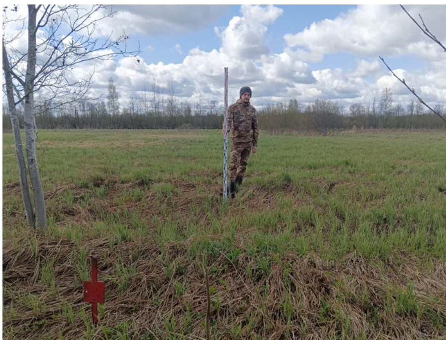
Рис. 24. Ленинградская область, Тосненский район, «Межпоселковый газопровод от д. Померанье до д. Чудской Бор Тосненского района Ленинградской области». 2023 г. Общий вид участка обследования. Точка фиксации 3. Вид с СВ
