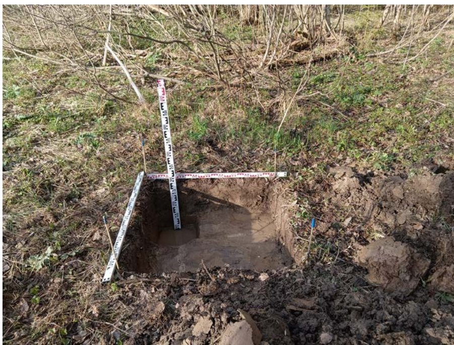
Рис. 94. Ленинградская область, Тосненский район, «Межпоселковый газопровод от д. Померанье до д. Чудской Бор Тосненского района Ленинградской области». 2023 г. Шурф 6. Зачистка по материке. Общий вид с Ю
