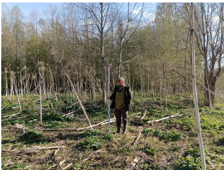
Рис. 72. Ленинградская область, Тосненский район, «Межпоселковый газопровод от д. Померанье до д. Чудской Бор Тосненского района Ленинградской области». 2023 г. Общий вид участка обследования. Точка фиксации 17. Вид с СВ
