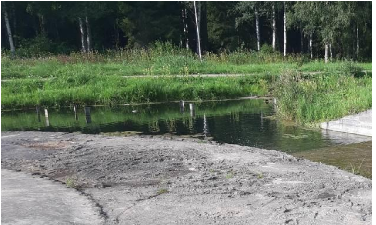
38. Дворцовый парк. Холодная ванная. Свайные конструкции в Павловском канале. Штиглиц М.С. 12.08.2023.
