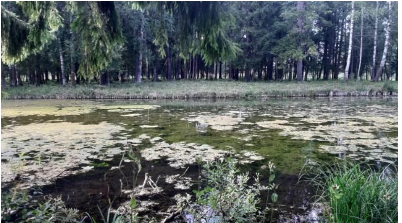
24. Дворцовый парк. Юго-восточный берег острова Топкий. Деревянный шпунт. Штиглиц М.С. 12.08.2023.
