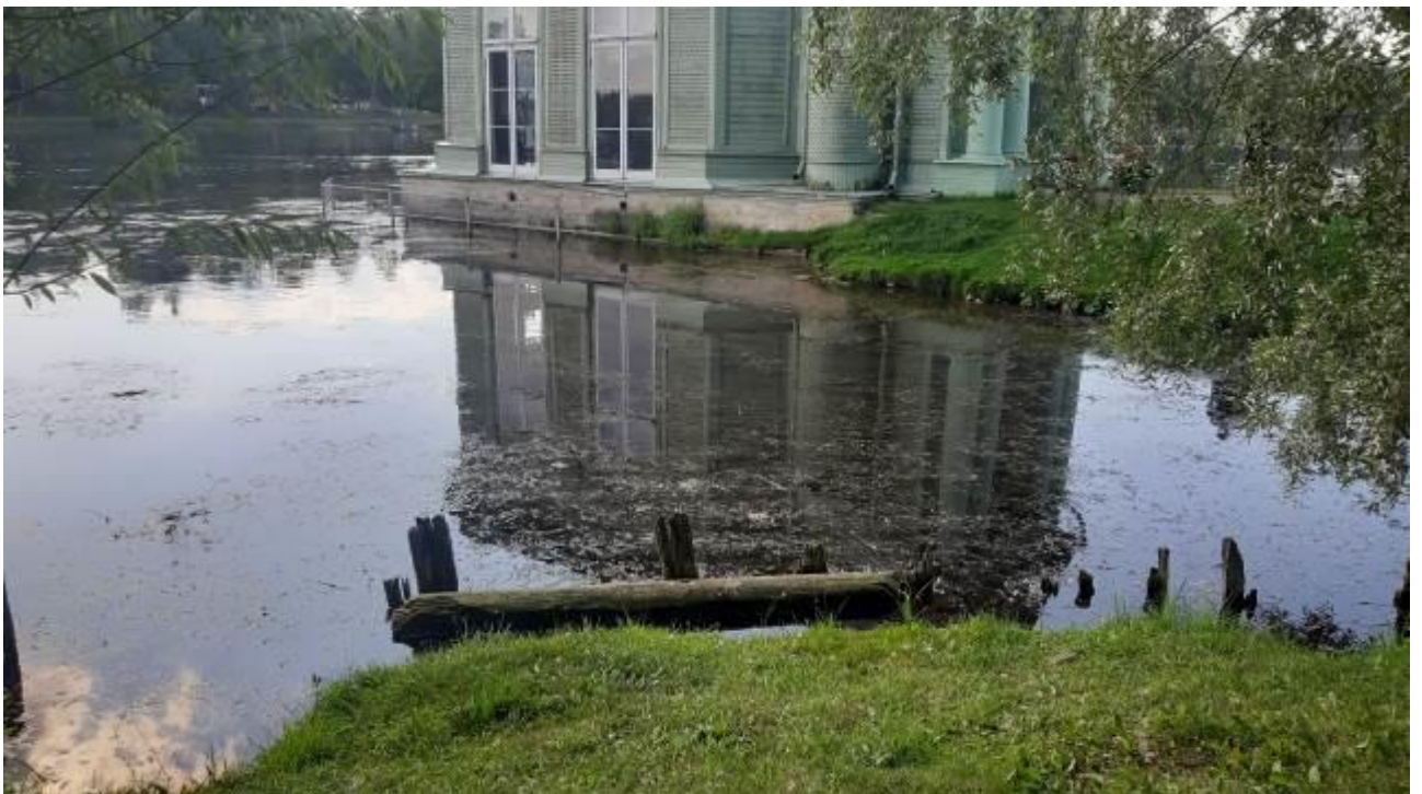
79. Дворцовый парк. Восточный берег Белого озера с южной стороны о. Любви. Разрушенные деревянные конструкции берегоукрепления. Штиглиц М.С. 12.08.2023.
