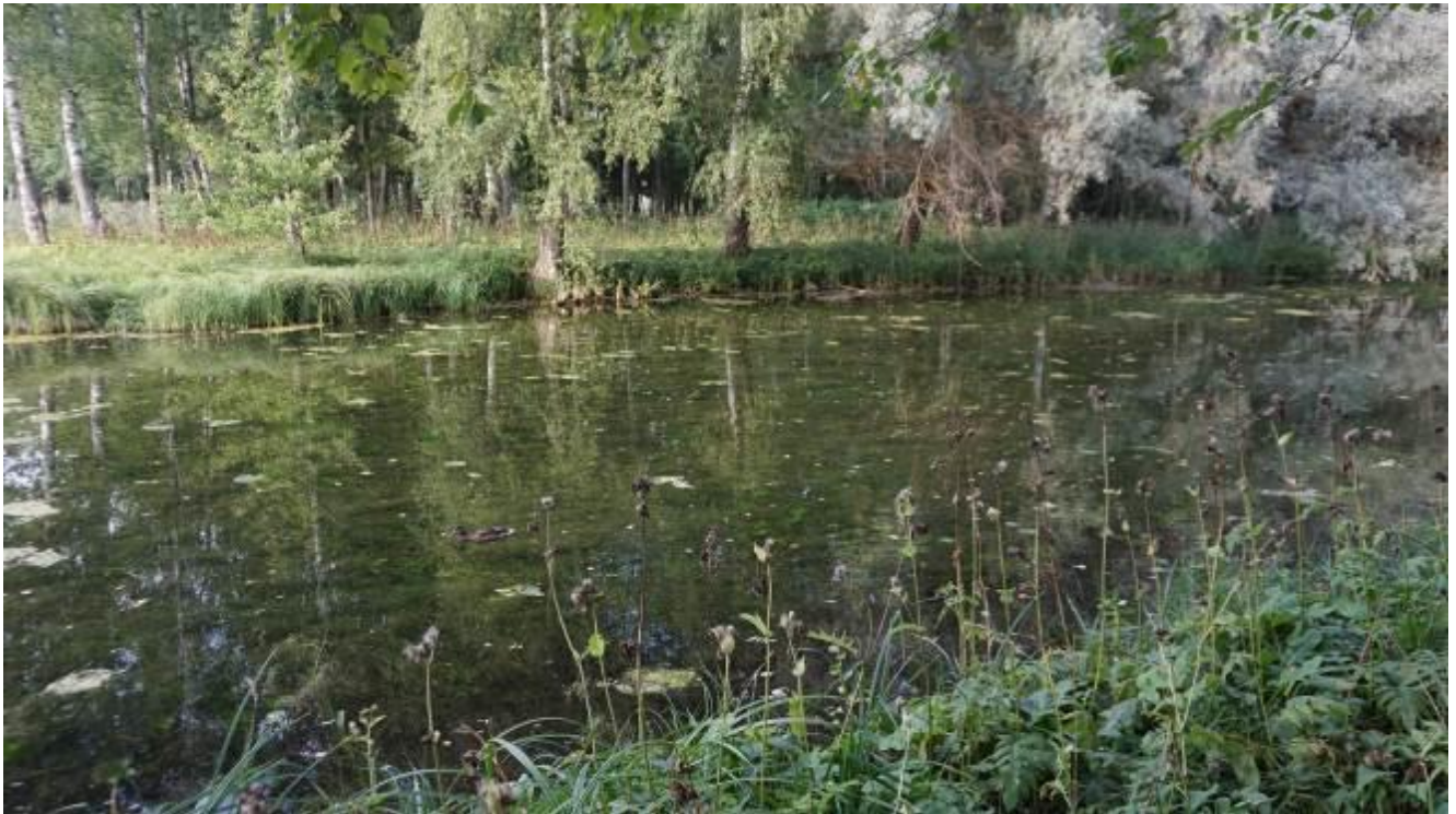
40. Дворцовый парк. Южный берег острова Топкий. Разрушенный деревянный шпунт. Штиглиц М.С. 12.08.2023.
