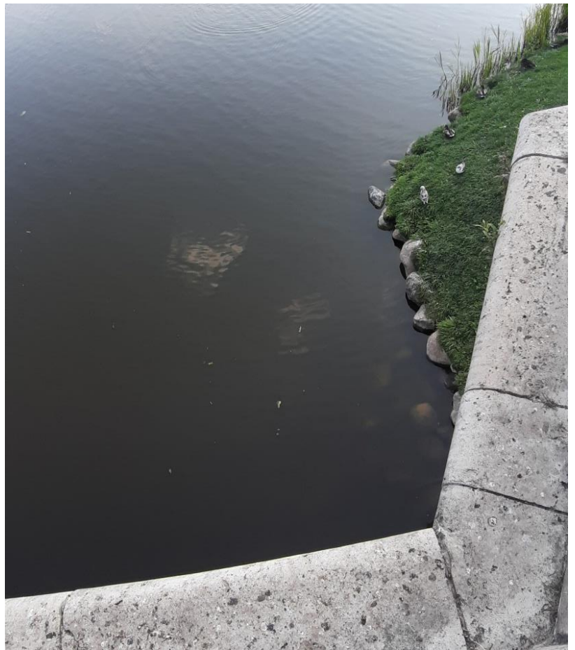
66. Дворцовый парк. Карпин пруд. Северный берег у Карпина моста. Крепление камнем. Штиглиц М.С. 12.08.2023.
