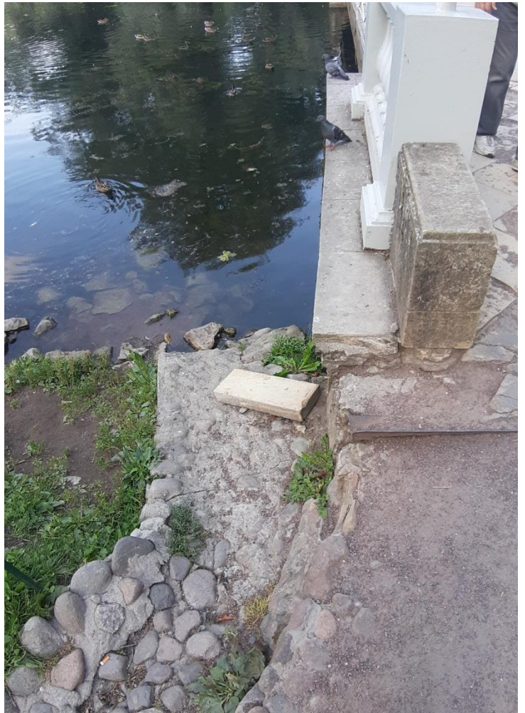
68. Дворцовый парк. Белое озеро у пешеходного моста. Крепление западного берега каменной наброской с северной стороны моста. Штиглиц М.С. 12.08.2023.
