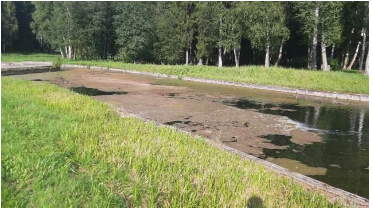
36. Дворцовый парк. Холодная ванная. Бетонное берегоукрепление. Штиглиц М.С. 12.08.2023.
