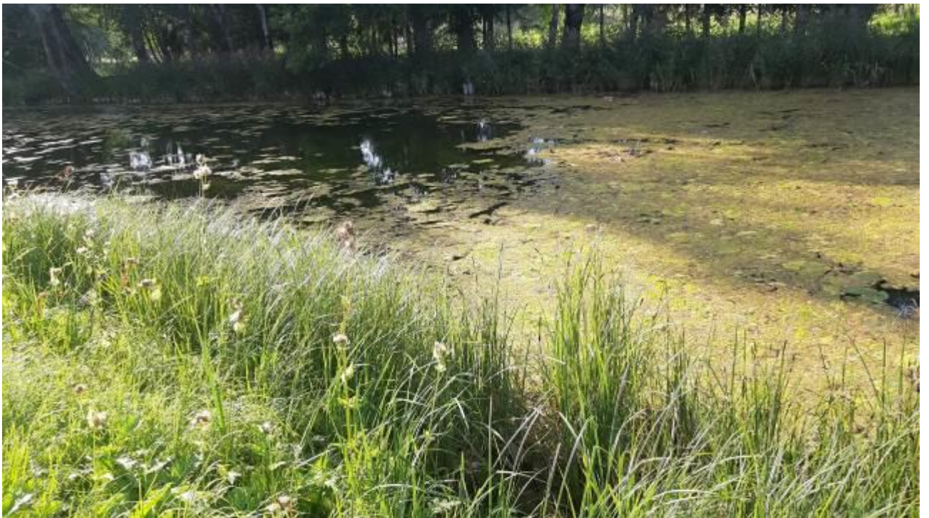
43. Дворцовый парк. Вид на юго-восточный берег острова Топкий. Остатки деревянного шпунта. Штиглиц М.С. 12.08.2023.
