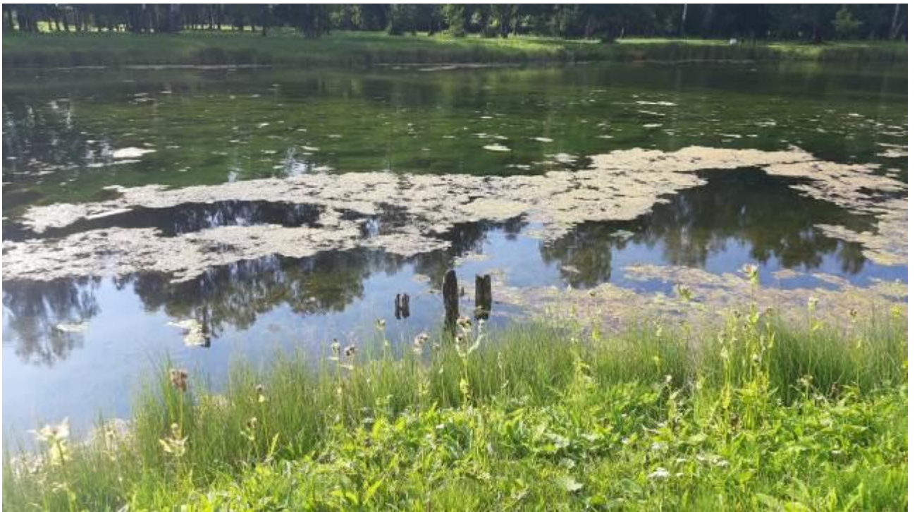
29. Дворцовый парк. Разрушенный деревянный шпунт на западе острова Захаров. Штиглиц М.С. 12.08.2023.
