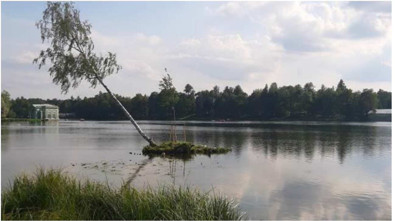
50. Дворцовый парк. Вид на остров Плавающий. Разрушенный деревянный шпунт по периметру острова. Штиглиц М.С. 12.08.2023.
