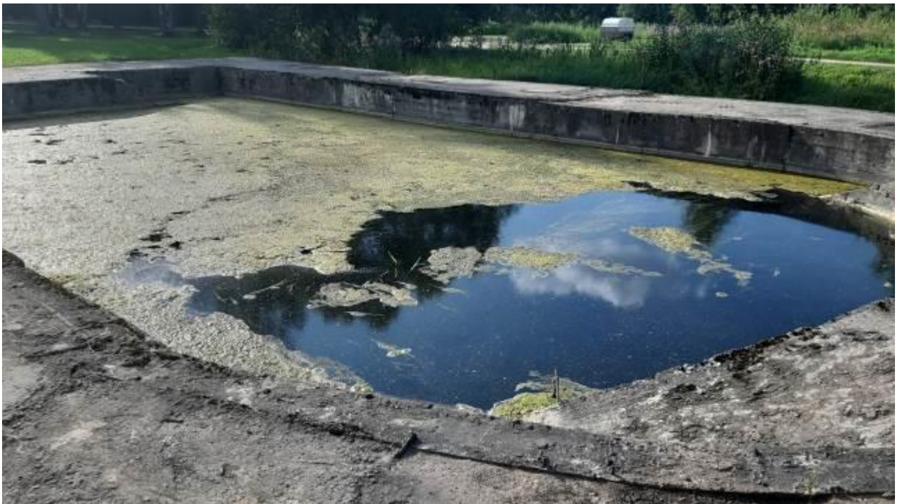
37. Дворцовый парк. Холодная ванная. Бетонное берегоукрепление. Штиглиц М.С. 12.08.2023.
