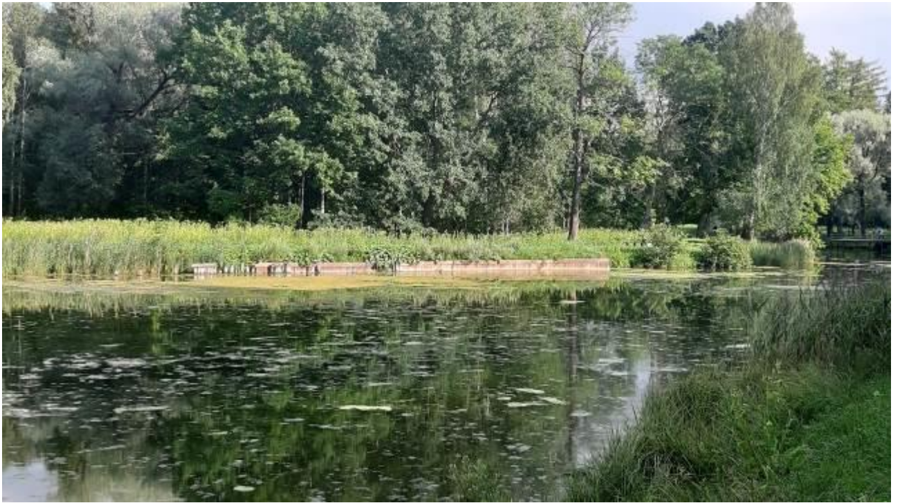
32. Дворцовый парк. Современный деревянный шпунт на западном берегу острова Захаров. Штиглиц М.С. 12.08.2023.
