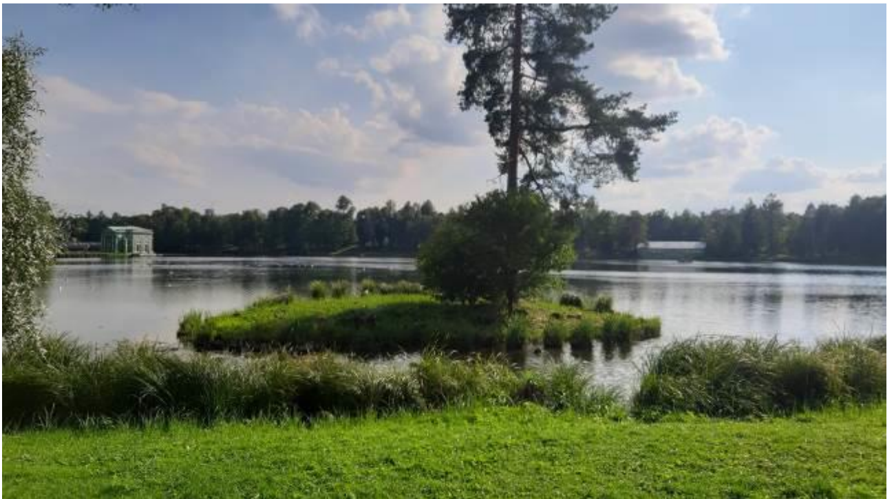
51. Дворцовый парк. Вид на остров Сосновый. Разрушенный деревянный шпунт по периметру острова. Штиглиц М.С. 12.08.2023.
