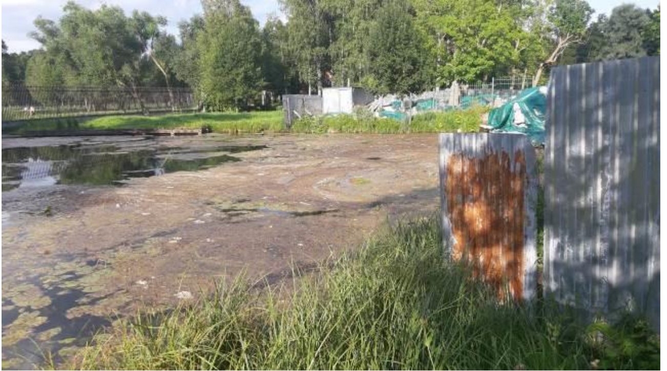
42. Дворцовый парк. Вид на шлюз в северной части парка. Деревянный шпунт в районе шлюза. Штиглиц М.С. 12.08.2023.
