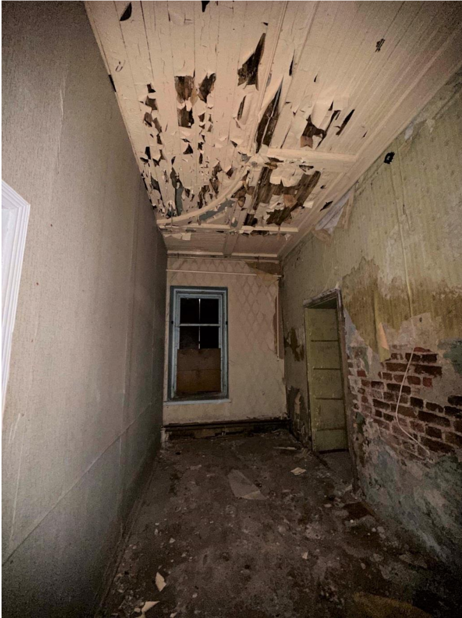
Фото 37. Пом. 1.8. Общий вид помещения с запада. Дата съемки: 30.08.2023 г. Автор съемки: Куваева Ю.П.
