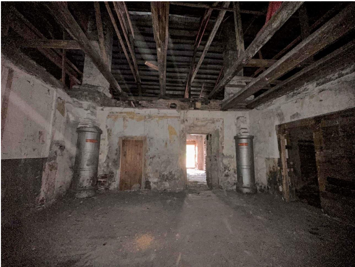
Фото 52. Пом. 1.39. Общий вид помещения с юга. Дата съемки: 30.08.2023 г. Автор съемки: Куваева Ю.П.
