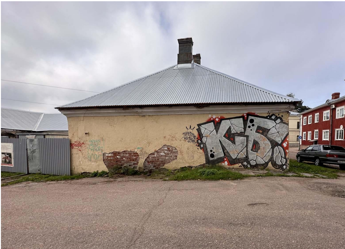
Фото 17. Общий вид торцевого восточного фасада дворового крыла здания. Дата съемки: 30.08.2023 г. Автор съемки: Куваева Ю.П.
