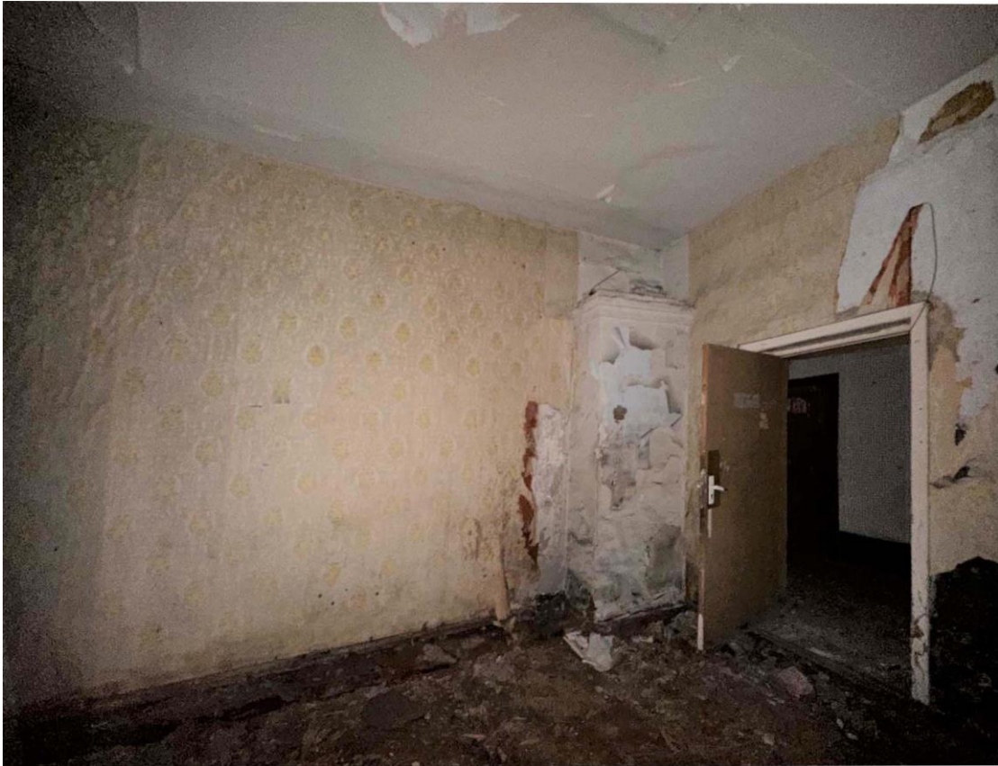
Фото 57. Пом. 1.52. Сохранившаяся печь в перегородке между помещениями 1.52 – 1.53. Фото с юго-запада. Дата съемки: 30.08.2023 г. Автор съемки: Куваева Ю.П.
