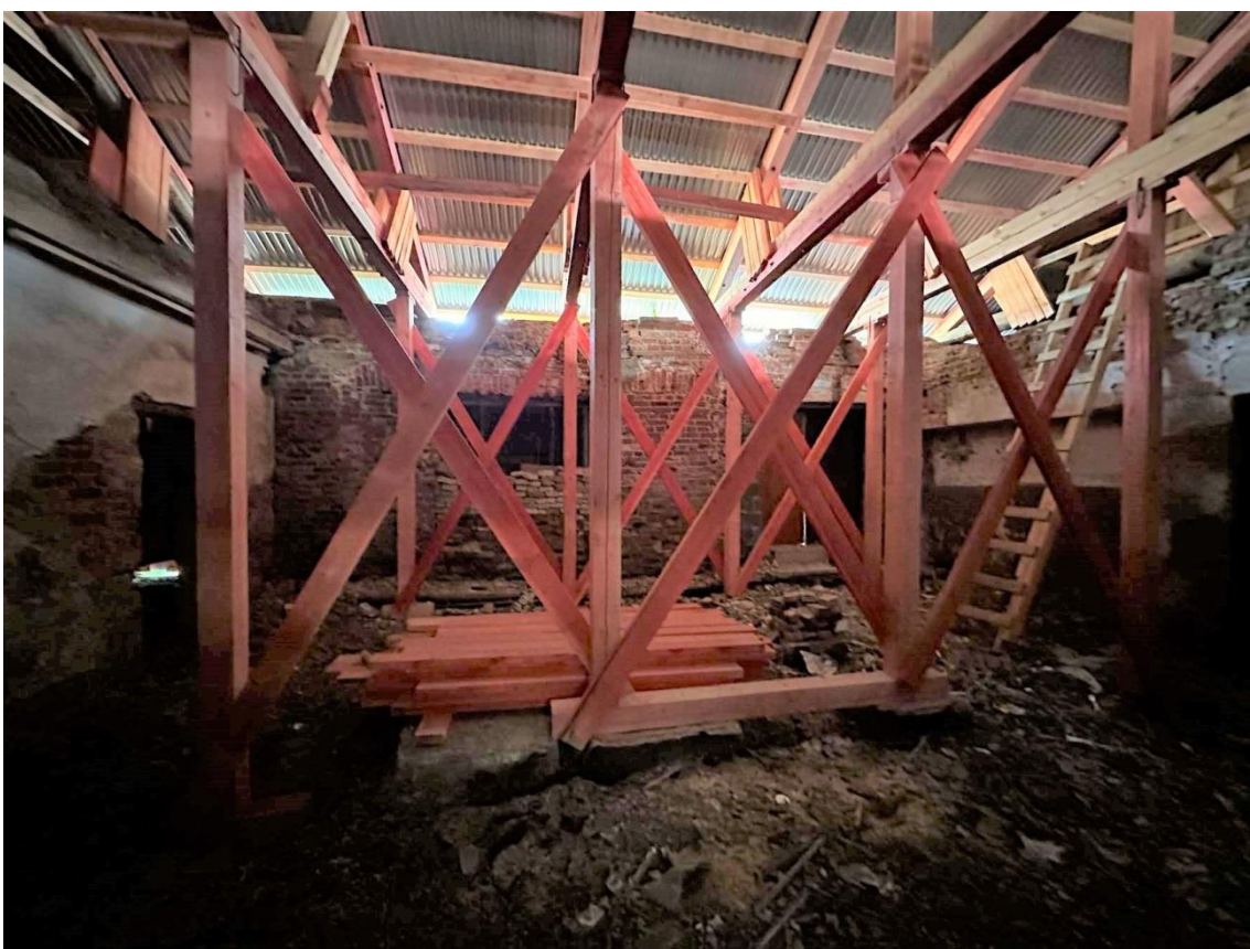
Фото 43. Пом. 1.22. Общий вид помещения с юга. Усиление конструкций крыши при первоочередных противоаварийных работах. Дата съемки: 30.08.2023 г. Автор съемки: Куваева Ю.П.
