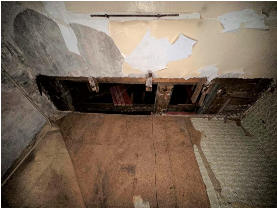
Фото 54. Пом. 1.50. Фрагмент перекрытия в помещении. Дата съемки: 30.08.2023 г. Автор съемки: Куваева Ю.П.
