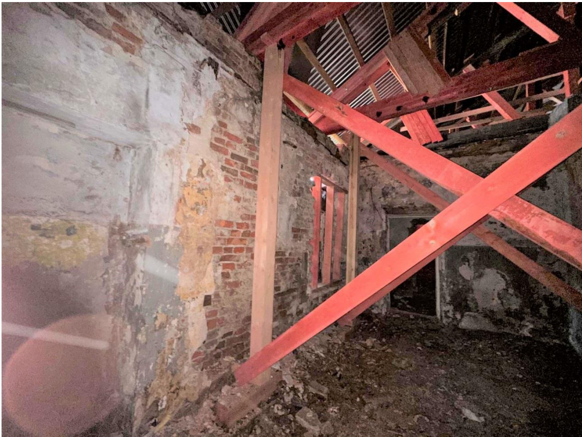
Фото 42. Пом. 1.17. Вид на северную часть помещения с юго-запада. Дата съемки: 30.08.2023 г. Автор съемки: Куваева Ю.П.
