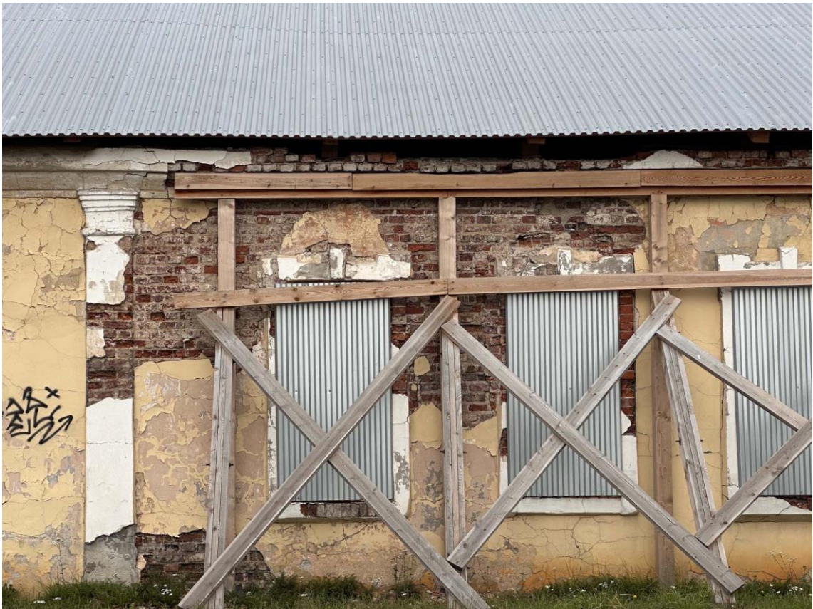
Фото 7. Фрагмент левой части уличного южного фасада восточного крыла здания. Дата съемки: 30.08.2023 г. Автор съемки: Куваева Ю.П.
