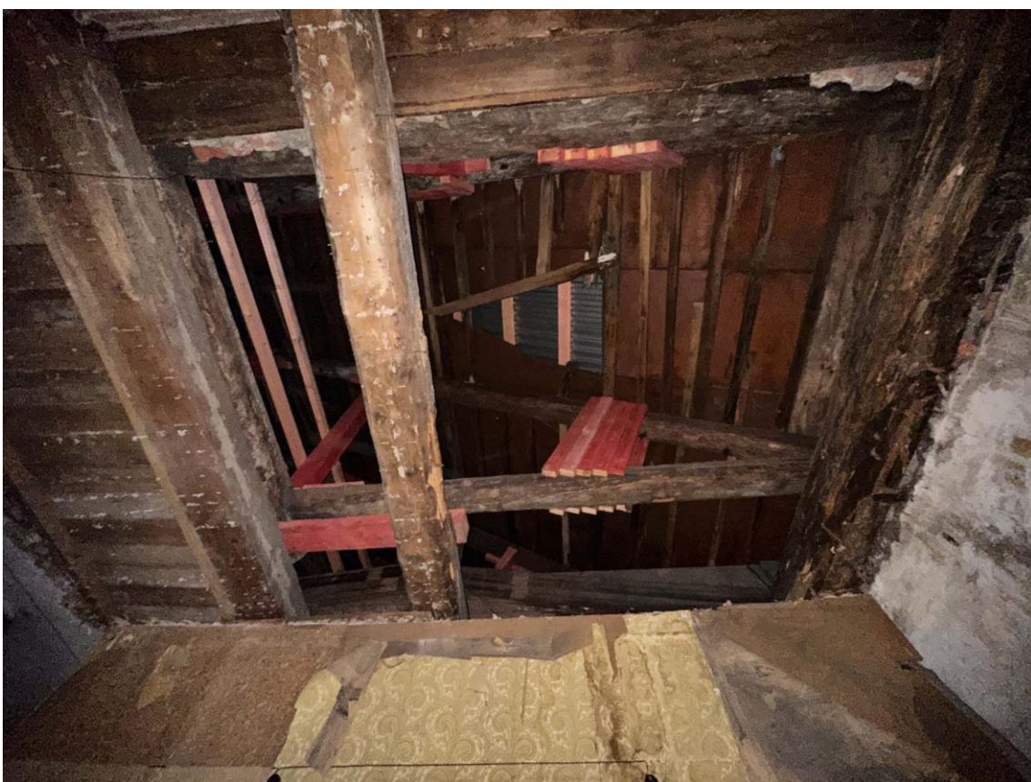
Фото 55. Пом. 1.51. Фрагмент перекрытия в помещении. Дата съемки: 30.08.2023 г. Автор съемки: Куваева Ю.П.
