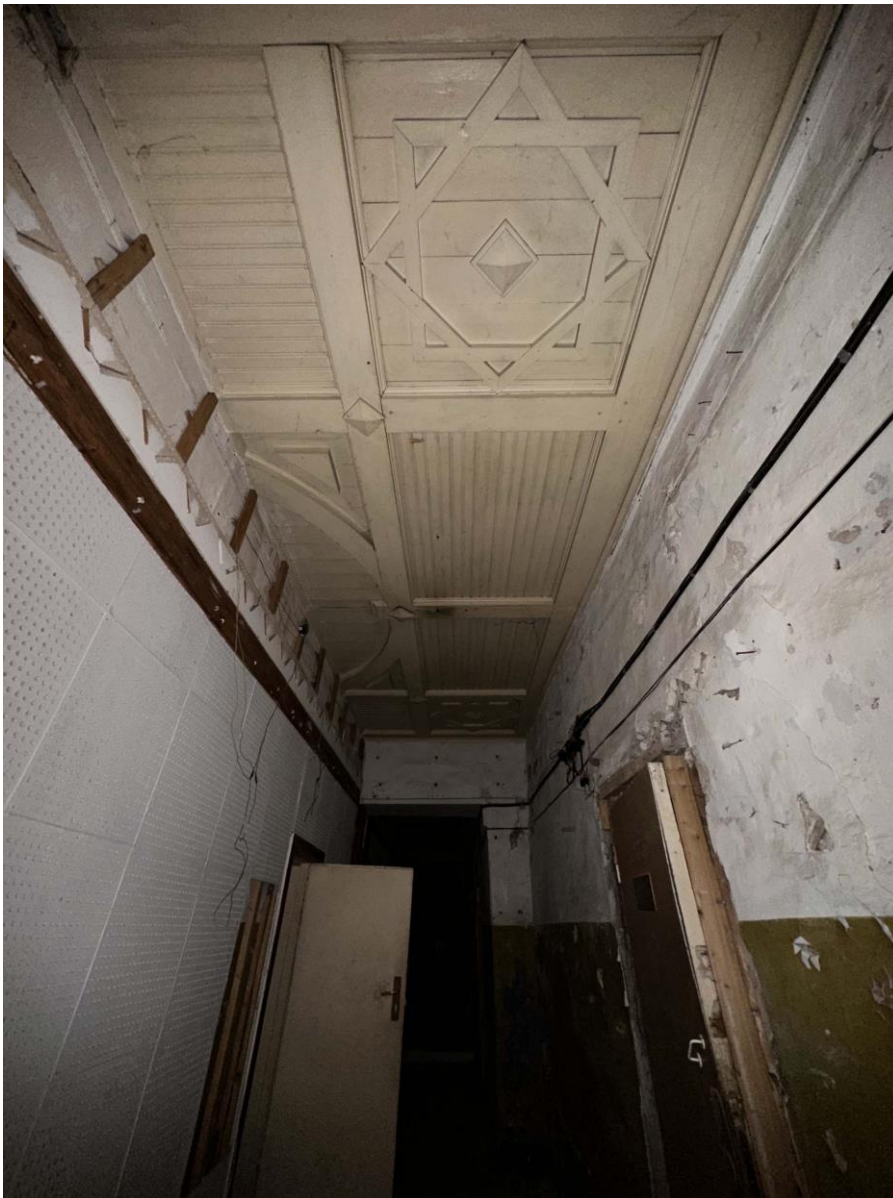
Фото 38. Пом. 1.9. Вид на деревянный декоративный потолок с севера. Дата съемки: 30.08.2023 г. Автор съемки: Куваева Ю.П.
