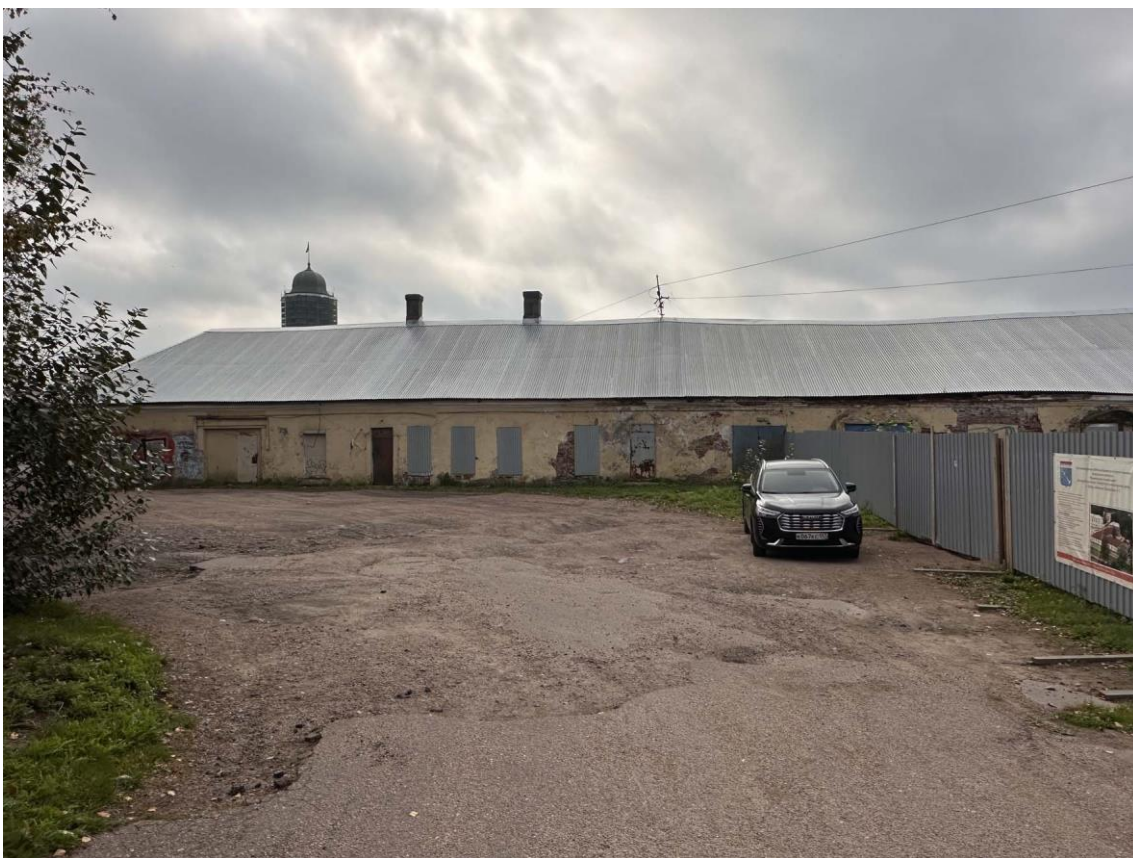
Фото 18. Общий вид левой части дворового северного фасада восточного крыла здания. Дата съемки: 30.08.2023 г. Автор съемки: Куваева Ю.П.
