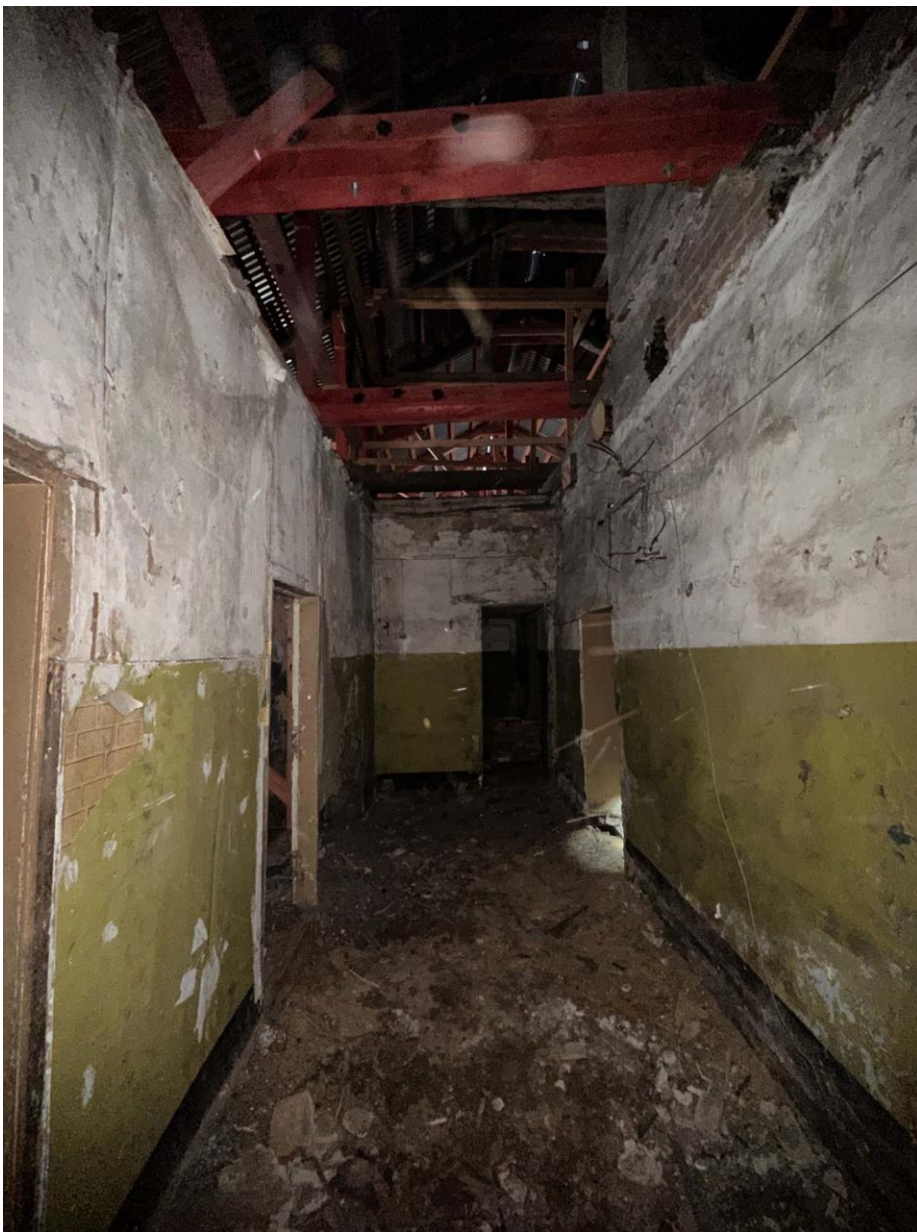
Фото 41. Пом. 1.16. Общий вид помещения с запада. Дата съемки: 30.08.2023 г. Автор съемки: Куваева Ю.П.
