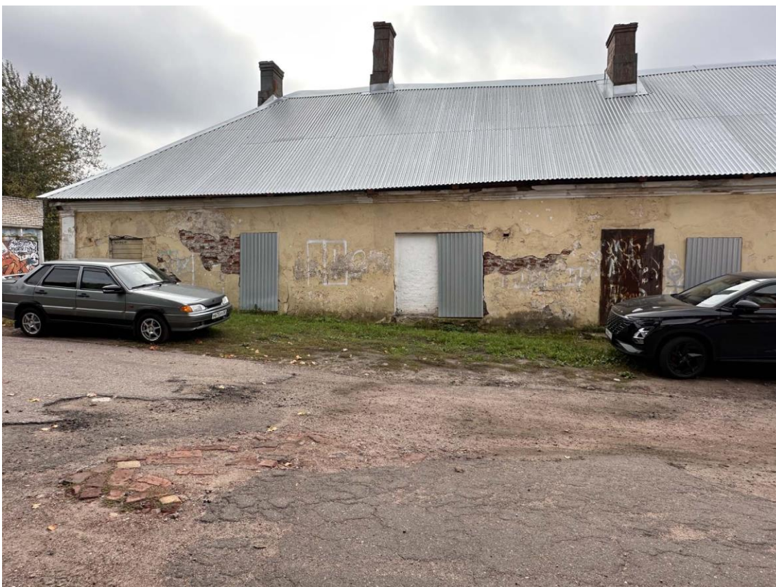
Фото 16. Фрагмент уличного северного фасада здания. Левая часть. Дата съемки: 30.08.2023 г. Автор съемки: Куваева Ю.П.
