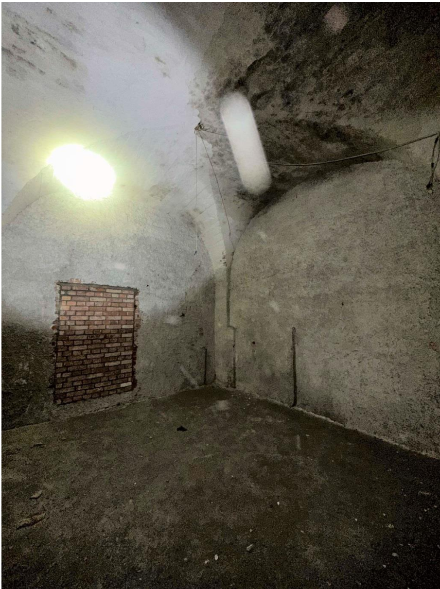
Фото 68. Пом. 1.66. Общий вид помещения с северо-востока. Дата съёмки: 30.08.2023 г. Автор съёмки: Куваева Ю.П.
