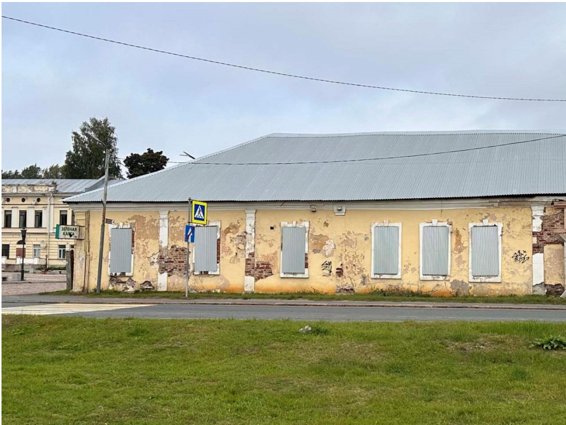
Фото 5. Фрагмент левой части уличного южного фасада восточного крыла здания. Дата съемки: 30.08.2023 г. Автор съемки: Куваева Ю.П.
