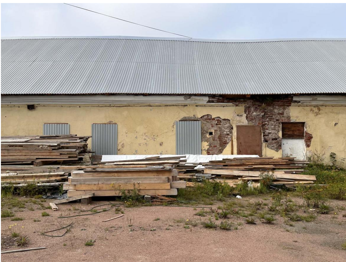
Фото 24. Фрагмент дворового восточного фасада западного крыла здания. Центральная часть. Дата съемки: 30.08.2023 г. Автор съемки: Куваева Ю.П.
