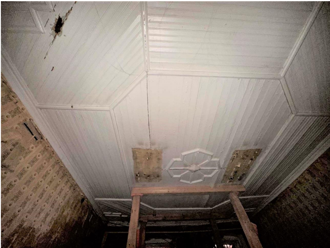
Фото 61. Пом. 1.56. Деревянный декоративный потолок. Фото с востока. Дата съемки: 30.08.2023 г. Автор съемки: Куваева Ю.П.
