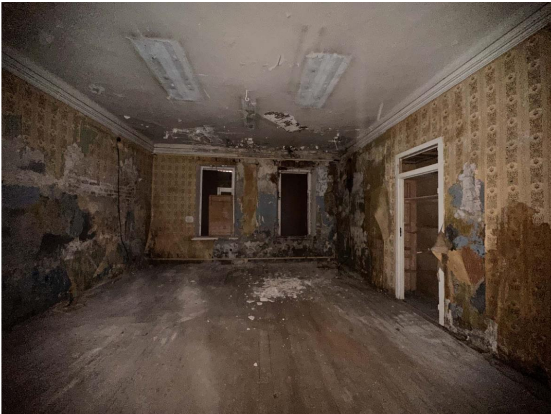
Фото 59. Пом. 1.55. Общий вид помещения с востока. Дата съёмки: 30.08.2023 г. Автор съёмки: Куваева Ю.П.
