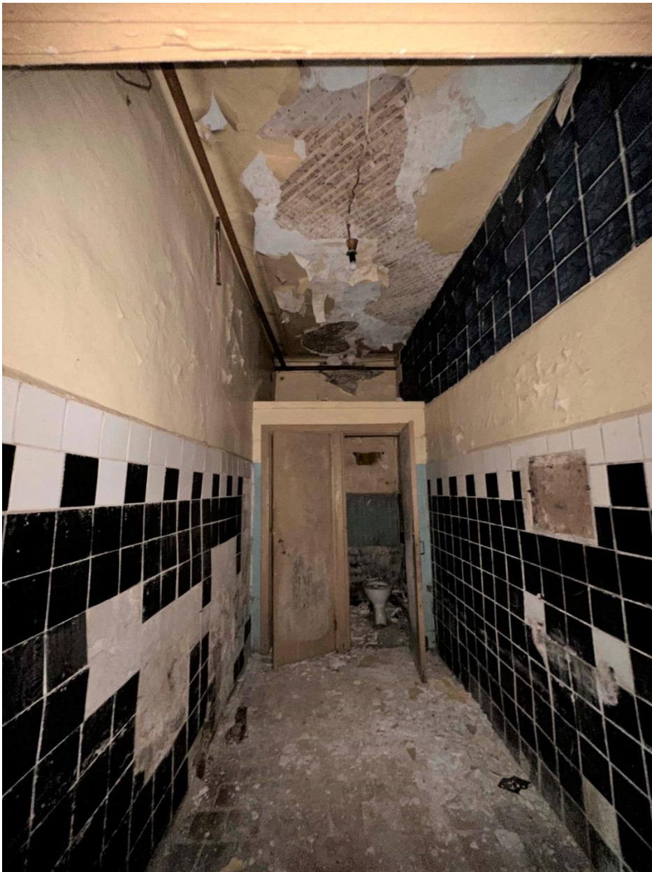
Фото 33. Пом. 1.3. Общий вид помещения с запада. Дата съемки: 30.08.2023 г. Автор съемки: Куваева Ю.П.
