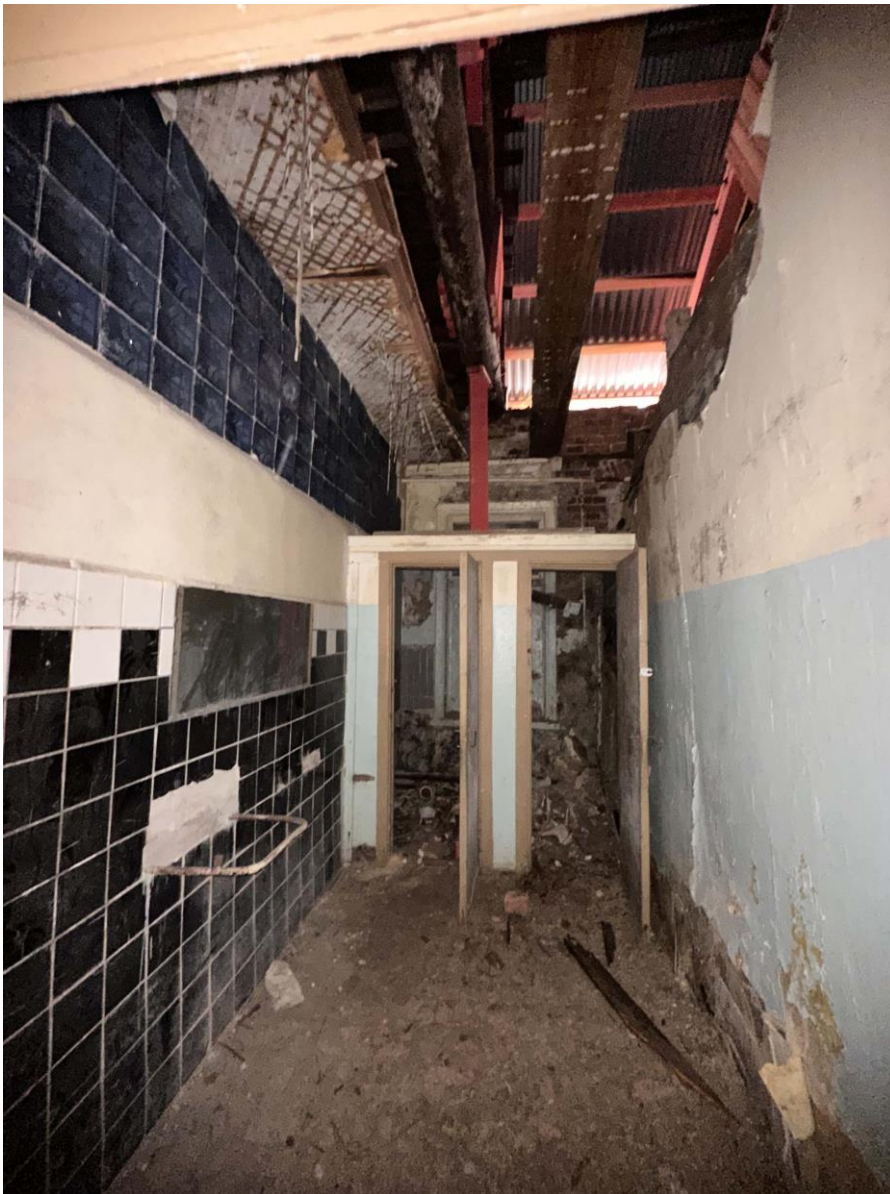
Фото 34. Пом. 1.4. Общй вид помещения с запада. Дата съемки: 30.08.2023 г. Автор съемки: Куваева Ю.П.
