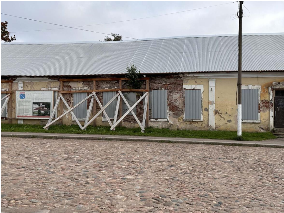
Фото 12. Фрагмент левой части западного фасада здания. Дата съемки: 30.08.2023 г. Автор съемки: Куваева Ю.П.
