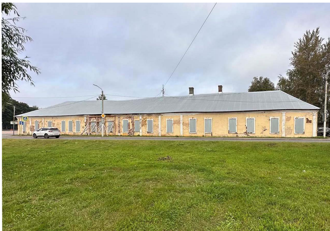
Фото 4. Общий вид уличного южного фасада восточного крыла здания. Дата съемки: 30.08.2023 г. Автор съемки: Куваева Ю.П.
