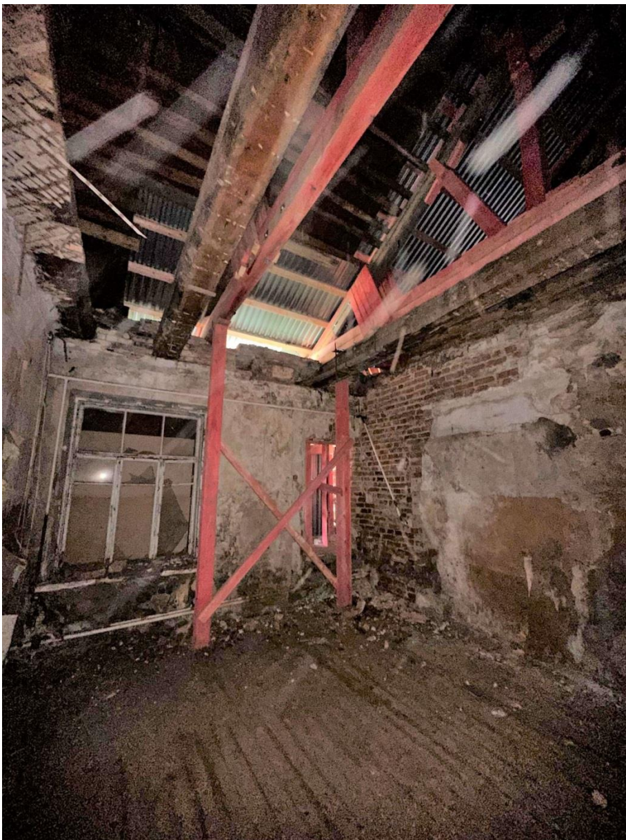
Фото 39. Пом. 1.11. Общий вид помещения после проведения первоочередных противоаварийных работ с северо-запада. Дата съемки: 30.08.2023 г. Автор съемки: Куваева Ю.П.
