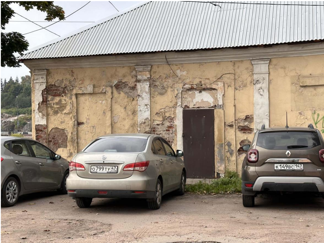
Фото 29. Фрагмент торцевого восточного фасада восточного крыла здания. Левая часть. Дата съемки: 30.08.2023 г. Автор съемки: Куваева Ю.П.
