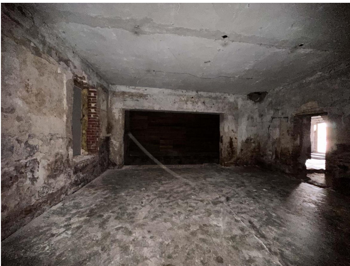
Фото 49. Общий вид помещения с востока. Пом. 1.35. Дата съемки: 30.08.2023 г. Автор съемки: Куваева Ю.П.
