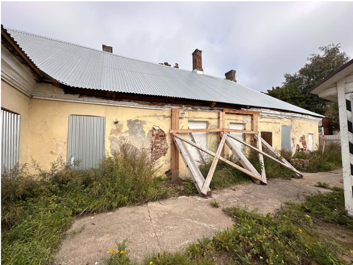
Фото 27. Общий вид южного фасада дворового крыла здания. Фото с юго-запада. Дата съемки: 30.08.2023 г. Автор съемки: Куваева Ю.П.
