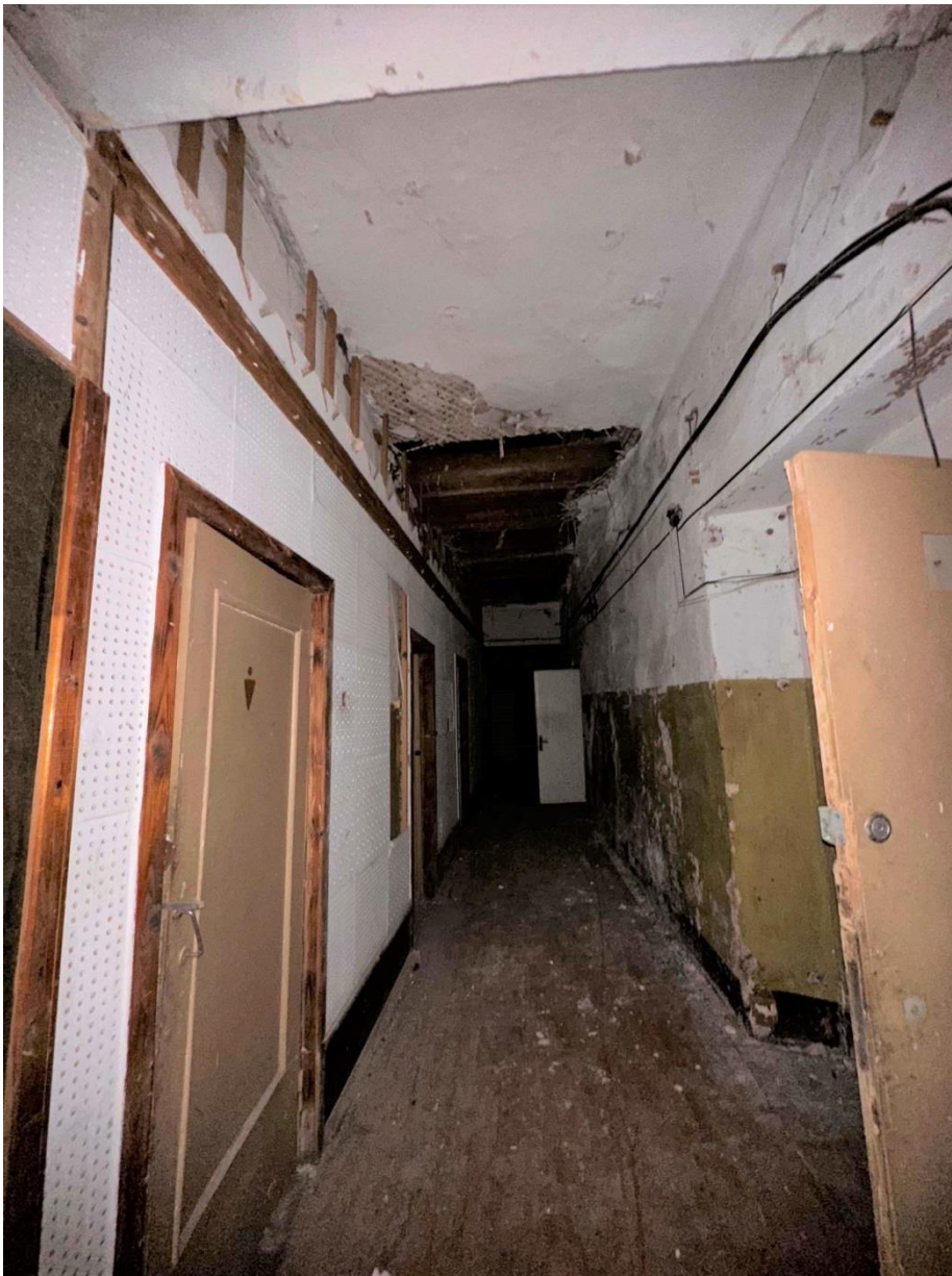
Фото 32. Пом. 1.2. Общий вид помещения с севера. Дата съёмки: 30.08.2023 г. Автор съёмки: Куваева Ю.П.
