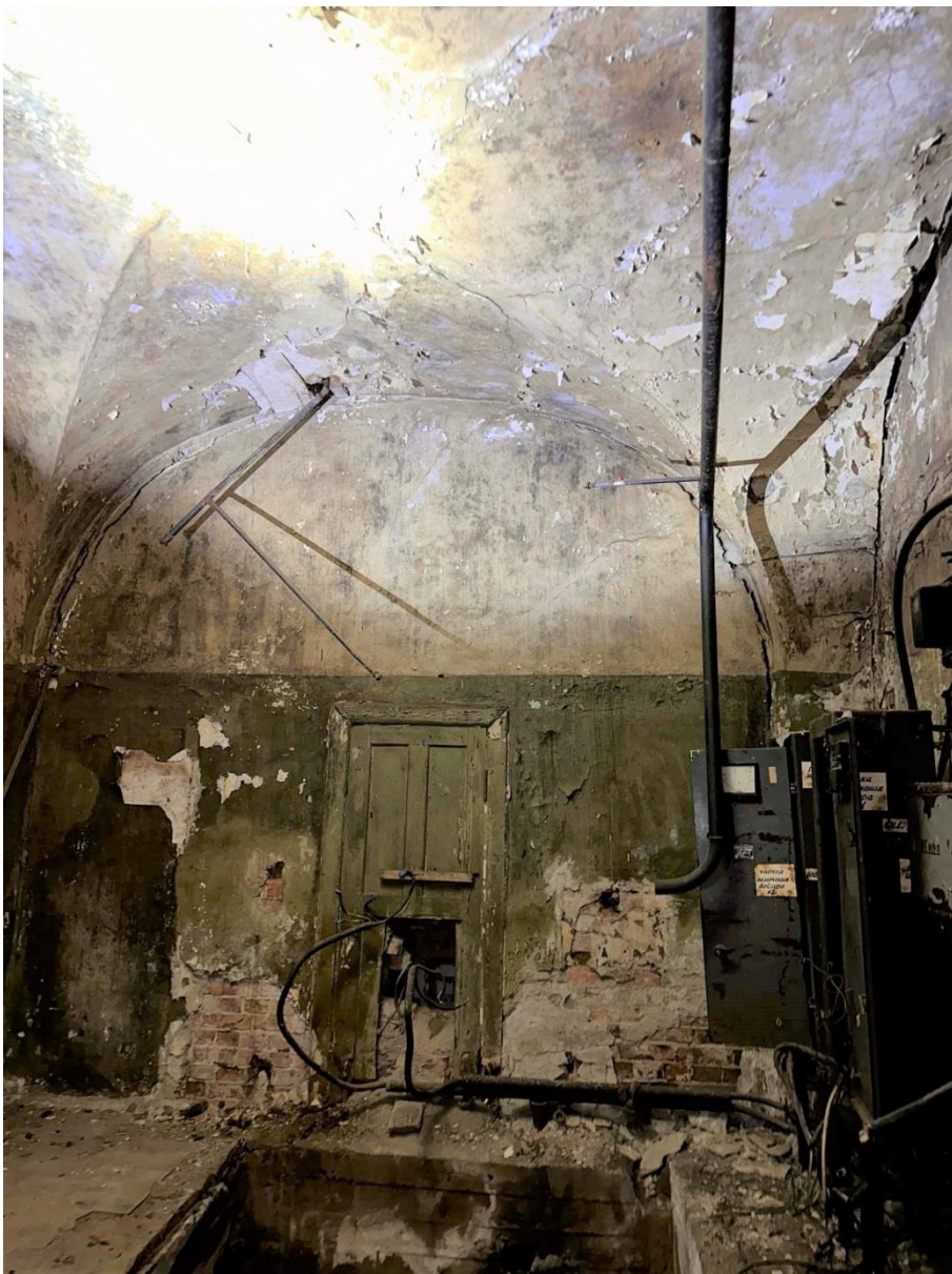
Фото 70. Пом. 1.72. Общий вид помещения с запада. Дата съемки: 30.08.2023 г. Автор съемки: Куваева Ю.П.
