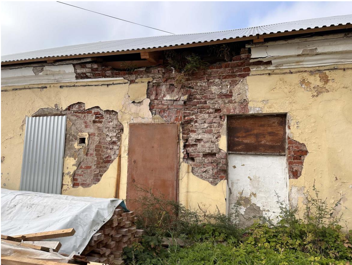
Фото 25. Фрагмент центральной части дворового восточного фасада западного крыла здания. Дата съемки: 30.08.2023 г. Автор съемки: Куваева Ю.П.
