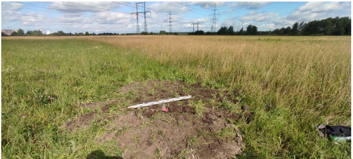
Рис. 111. ЛО-2023, Всеволожский район, «Свердловское городское поселение», дер. Новосаратовка, центральное отделение, планировочный квартал 05-04. Шурф 5. Рекультивация. Вид с юга.
