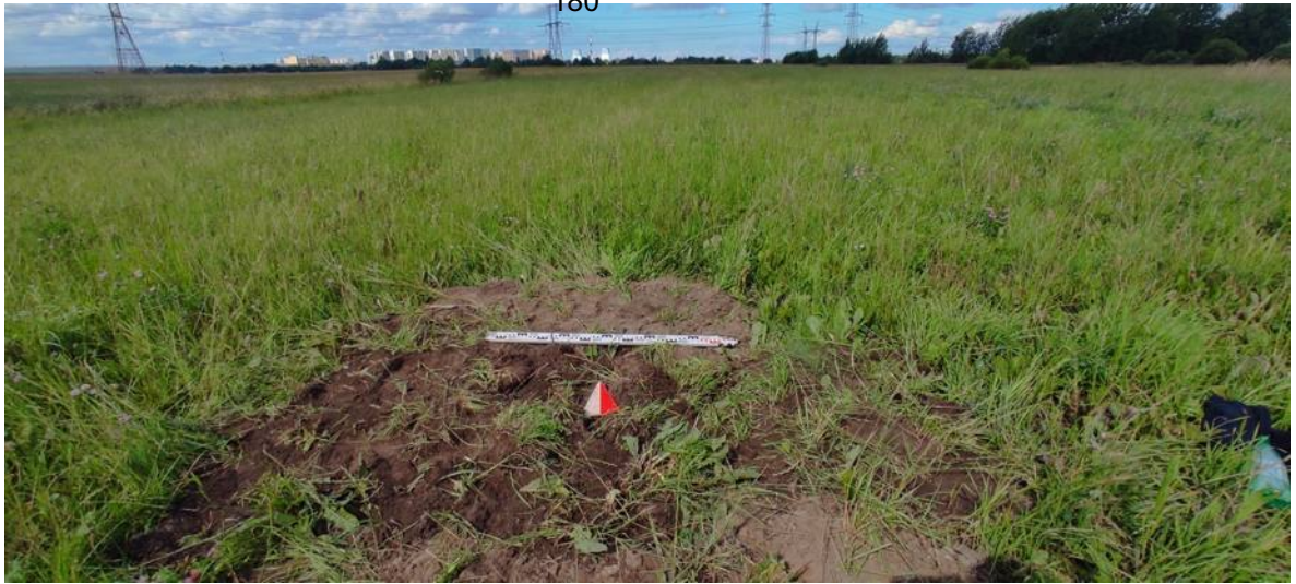
Рис. 121. ЛО-2023, Всеволожский район, «Свердловское городское поселение», дер. Новосаратовка, центральное отделение, планировочный квартал 05-04. Шурф 7. Рекультивация. Вид с юга.
