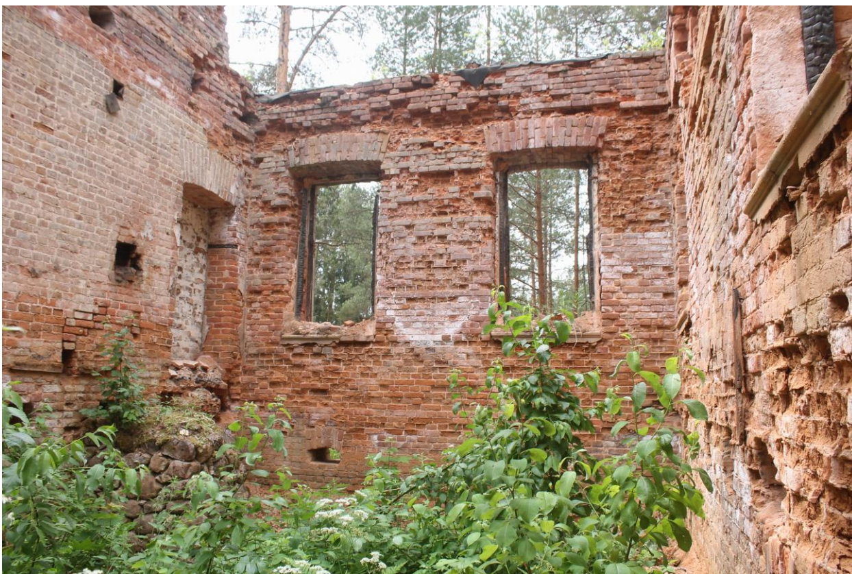
Фото 9. Помещение в северной части здания.
