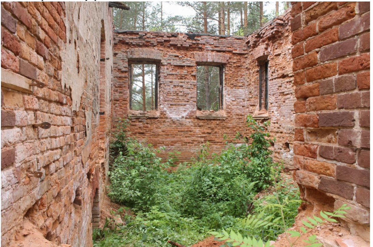
Фото 8. Помещение в северной части здания.
