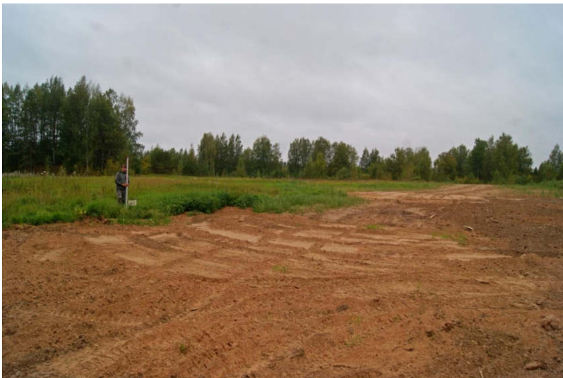
Рис. 207. Объект «Реконструкция ЕСГ Северо-Западного региона для обеспечения транспортировки этансодержащего газа по побережью Балтийского моря» (км 332,0-км 850,0 (до КПЭГ). Ленинградская область. Фотофиксация 2019 г. Комплекс памятников у дер. Городище: «Курганный могильник Бесовы Харчевни», «Курганный и грунтовый могильник Красня Заря». Вид с В на центральную часть памятника.
