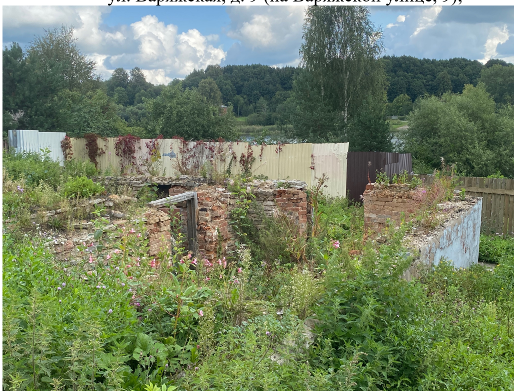
2. Вид на объект культурного наследия регионального значения «Деревянный дом (б. дом Калязина) XIX в.», расположенного по адресу: Ленинградская область, Волховский р-он, с. Старая Ладога, ул. Варяжская, д. 9 (на Варяжской улице, 9);
