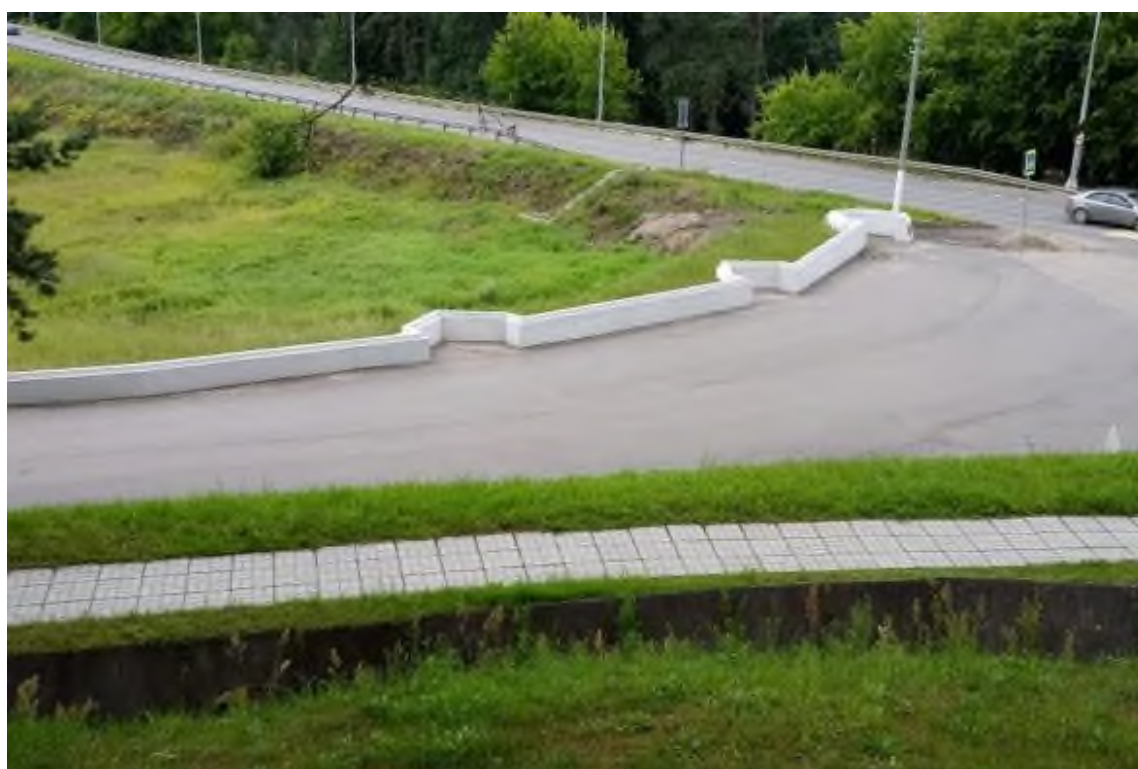
Рис. 29. Ленинградская область. Лужский муниципальный район, Лужское городское поселение, г. Луга, пр. Володарского, соор. 41/1п, 56/2п, 56/1п. “Мемориальный комплекс на рубеже обороны 1941 г”. Общий вид на южную границу ОКН со стороны ДОТа. Вид с севера.
