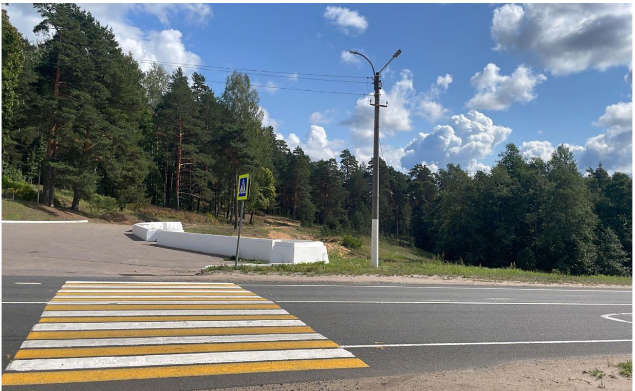
Ленинградская область. Лужский муниципальный район, Лужское городское поселение, г. Луга, пр. Володарского, соор. 41/1п, 56/2п, 56/1п. “Мемориальный комплекс на рубеже обороны 1941 г”. Общий вид юго-восточной части ОКН. Вид с юга.
