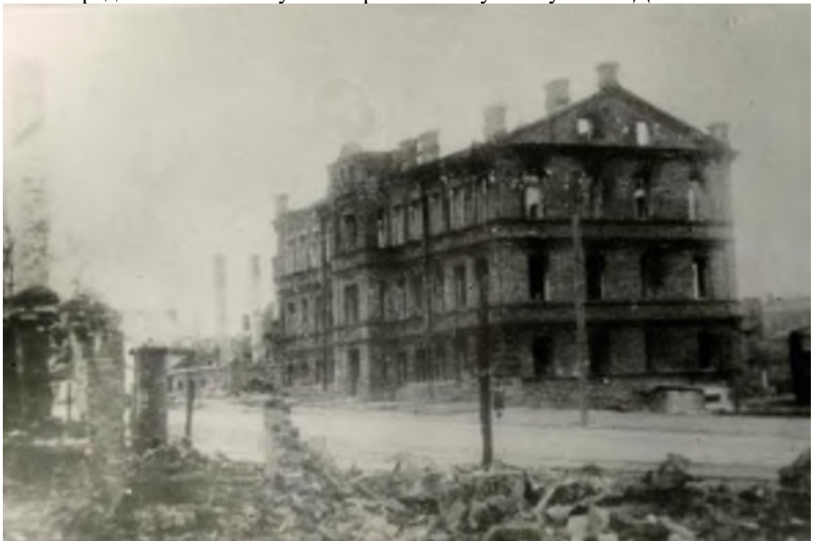
Рис. 19. Ленинградская область. Лужский район. Г. Луга после авиаударов в августе 1941 г. Немецкое фото 1941 г.
