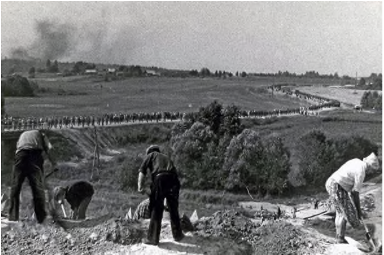
Рис. 12. Ленинградская область. Лужский оборонительный рубеж. Строительство укреплений в июле 1941 г. Фото 1941 г.
