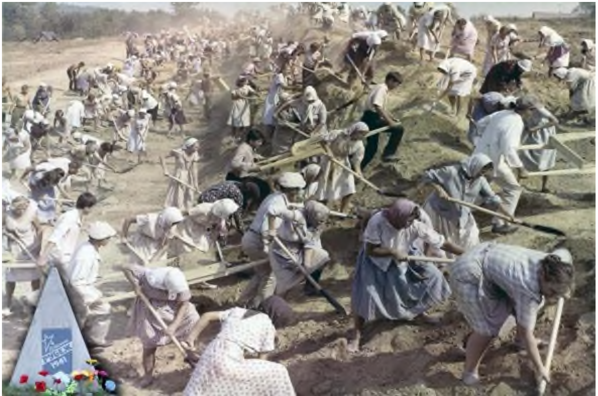
Рис. 13. Ленинградская область. Лужский оборонительный рубеж. Строительство укреплений в июле 1941 г. Фото 1941 г.
