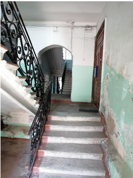
16. «Жилой дом» в составе объекта культурного наследия регионального значения «Комплекс военного городка Лужского Сергиевского артиллерийского полигона», Ленинградская область, Лужский район, г. Луга-3, 1-й полигон, тер. в/г №3, д.3/40. Лестничная клетка №2. Общий вид. Фото 01.08.2023г.
