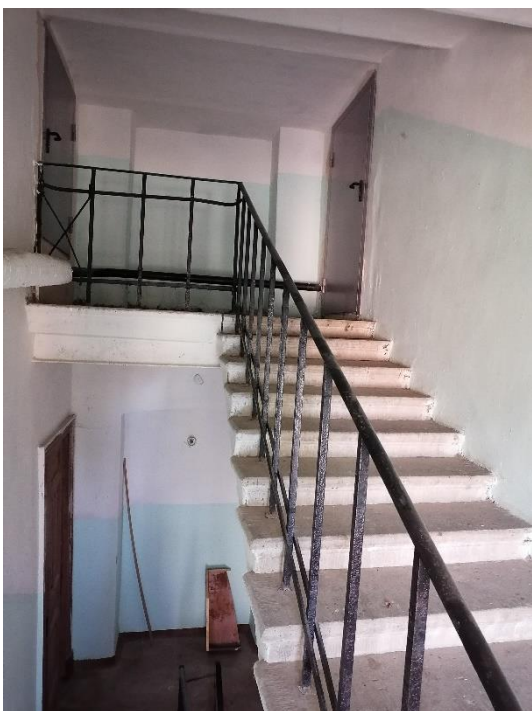
29. «Жилой дом» в составе объекта культурного наследия регионального значения «Комплекс военного городка Лужского Сергиевского артиллерийского полигона», Ленинградская область, Лужский район, г. Луга-3, 1-й полигон, тер. в/г №3, д.3/40. Лестничная клетка №3. Общий вид. Фото 01.08.2023г.
