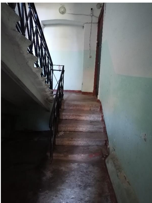
26. «Жилой дом» в составе объекта культурного наследия регионального значения «Комплекс военного городка Лужского Сергиевского артиллерийского полигона», Ленинградская область, Лужский район, г. Луга-3, 1-й полигон, тер. в/г №3, д.3/40. Лестничная клетка №3. Общий вид. Фото 01.08.2023г.
