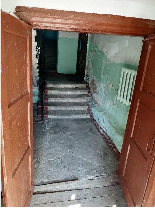
15. «Жилой дом» в составе объекта культурного наследия регионального значения «Комплекс военного городка Лужского Сергиевского артиллерийского полигона», Ленинградская область, Лужский район, г. Луга-3, 1-й полигон, тер. в/г №3, д.3/40. Лестничная клетка №2. Общий вид. Фото 01.08.2023г.
