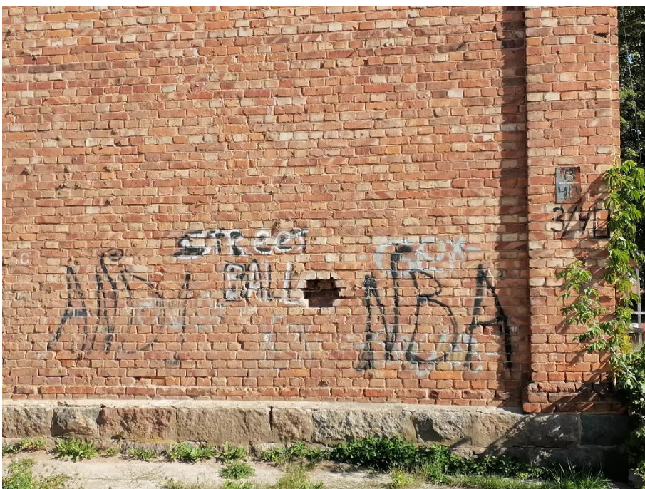
8. «Жилой дом» в составе объекта культурного наследия регионального значения «Комплекс военного городка Лужского Сергиевского артиллерийского полигона», Ленинградская область, Лужский район, г. Луга-3, 1-й полигон, тер. в/г №3, д.3/40. Юго-западный фасад. Фрагмент. Фото 01.08.2023г.
