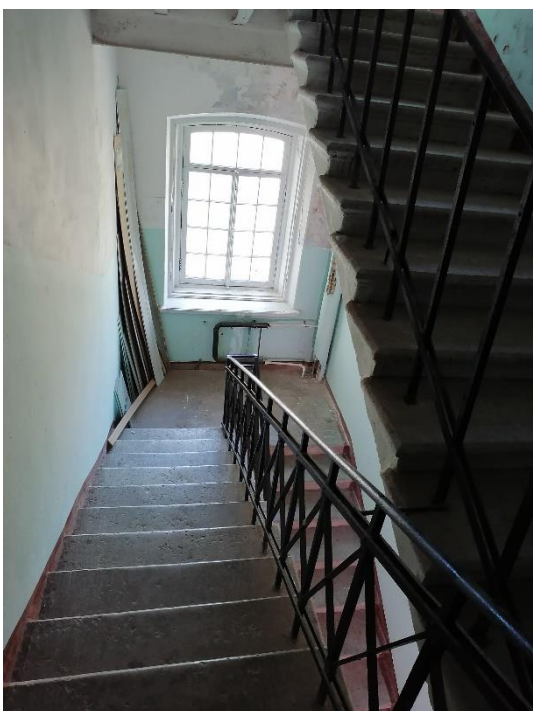
28. «Жилой дом» в составе объекта культурного наследия регионального значения «Комплекс военного городка Лужского Сергиевского артиллерийского полигона», Ленинградская область, Лужский район, г. Луга-3, 1-й полигон, тер. в/г №3, д.3/40. Лестничная клетка №3. Общий вид. Фото 01.08.2023г.
