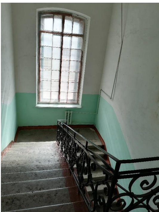
20. «Жилой дом» в составе объекта культурного наследия регионального значения «Комплекс военного городка Лужского Сергиевского артиллерийского полигона», Ленинградская область, Лужский район, г. Луга-3, 1-й полигон, тер. в/г №3, д.3/40. Лестничная клетка №2. Общий вид. Фото 01.08.2023г.
