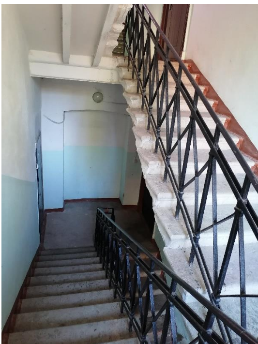
27. «Жилой дом» в составе объекта культурного наследия регионального значения «Комплекс военного городка Лужского Сергиевского артиллерийского полигона», Ленинградская область, Лужский район, г. Луга-3, 1-й полигон, тер. в/г №3, д.3/40. Лестничная клетка №3. Общий вид. Фото 01.08.2023г.
