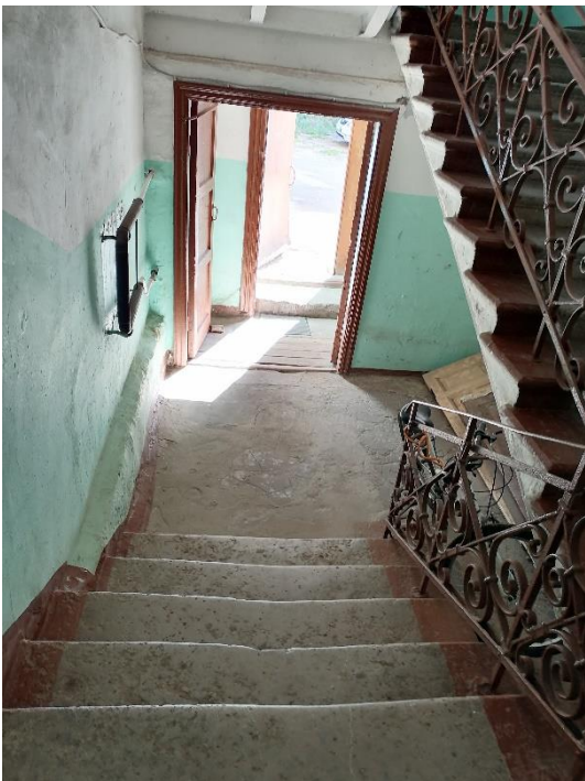
22. «Жилой дом» в составе объекта культурного наследия регионального значения «Комплекс военного городка Лужского Сергиевского артиллерийского полигона», Ленинградская область, Лужский район, г. Луга-3, 1-й полигон, тер. в/г №3, д.3/40. Лестничная клетка №1. Общий вид. Фото 01.08.2023г.
