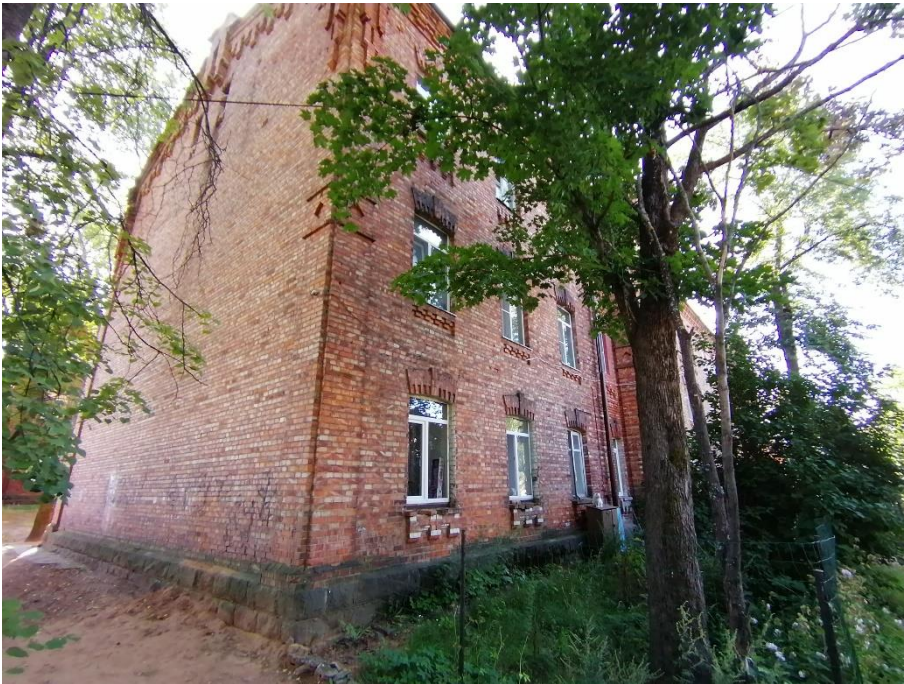
4. «Жилой дом» в составе объекта культурного наследия регионального значения «Комплекс военного городка Лужского Сергиевского артиллерийского полигона», Ленинградская область, Лужский район, г. Луга-3, 1-й полигон, тер. в/г №3, д.3/40. Северо-восточный фасад. Общий вид. Фото 01.08.2023г.
