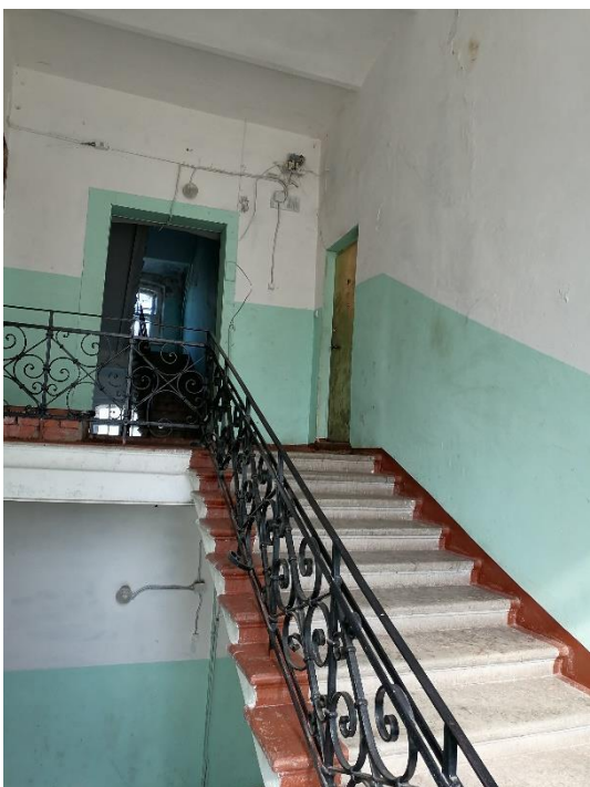
19. «Жилой дом» в составе объекта культурного наследия регионального значения «Комплекс военного городка Лужского Сергиевского артиллерийского полигона», Ленинградская область, Лужский район, г. Луга-3, 1-й полигон, тер. в/г №3, д.3/40. Лестничная клетка №2. Общий вид. Фото 01.08.2023г.
