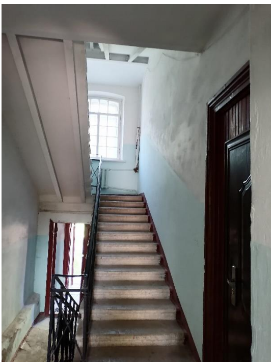
17. «Жилой дом» в составе объекта культурного наследия регионального значения «Комплекс военного городка Лужского Сергиевского артиллерийского полигона», Ленинградская область, Лужский район, г. Луга-3, 1-й полигон, тер. в/г №3, д.3/40. Лестничная клетка №2. Общий вид. Фото 01.08.2023г.
