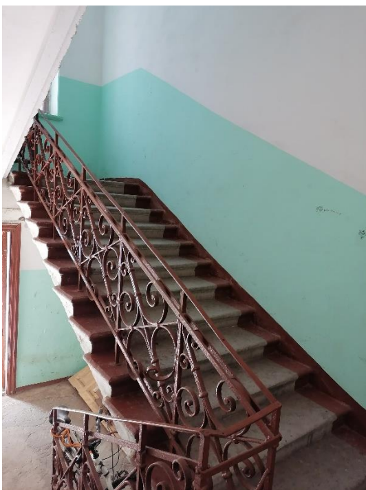
23. «Жилой дом» в составе объекта культурного наследия регионального значения «Комплекс военного городка Лужского Сергиевского артиллерийского полигона», Ленинградская область, Лужский район, г. Луга-3, 1-й полигон, тер. в/г №3, д.3/40. Лестничная клетка №1. Общий вид. Фото 01.08.2023г.
