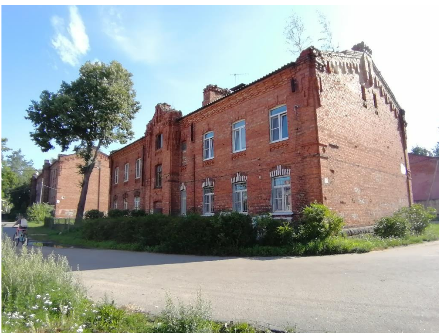
2. «Жилой дом» в составе объекта культурного наследия регионального значения «Комплекс военного городка Лужского Сергиевского артиллерийского полигона», Ленинградская область, Лужский район, г. Луга-3, 1-й полигон, тер. в/г №3, д.3/42. Общий вид с севера. Фото 01.08.2023г.
