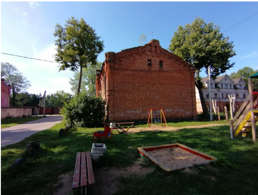
4. «Жилой дом» в составе объекта культурного наследия регионального значения «Комплекс военного городка Лужского Сергиевского артиллерийского полигона», Ленинградская область, Лужский район, г. Луга-3, 1-й полигон, тер. в/г №3, д.3/42. Юго-восточный фасад. Общий вид. Фото 01.08.2023г.
