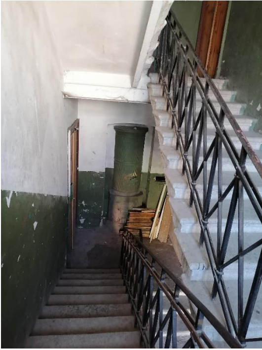
31. «Жилой дом» в составе объекта культурного наследия регионального значения «Комплекс военного городка Лужского Сергиевского артиллерийского полигона», Ленинградская область, Лужский район, г. Луга-3, 1-й полигон, тер. в/г №3, д.3/42. Лестничная клетка №2. Общий вид. Фото 01.08.2023г.
