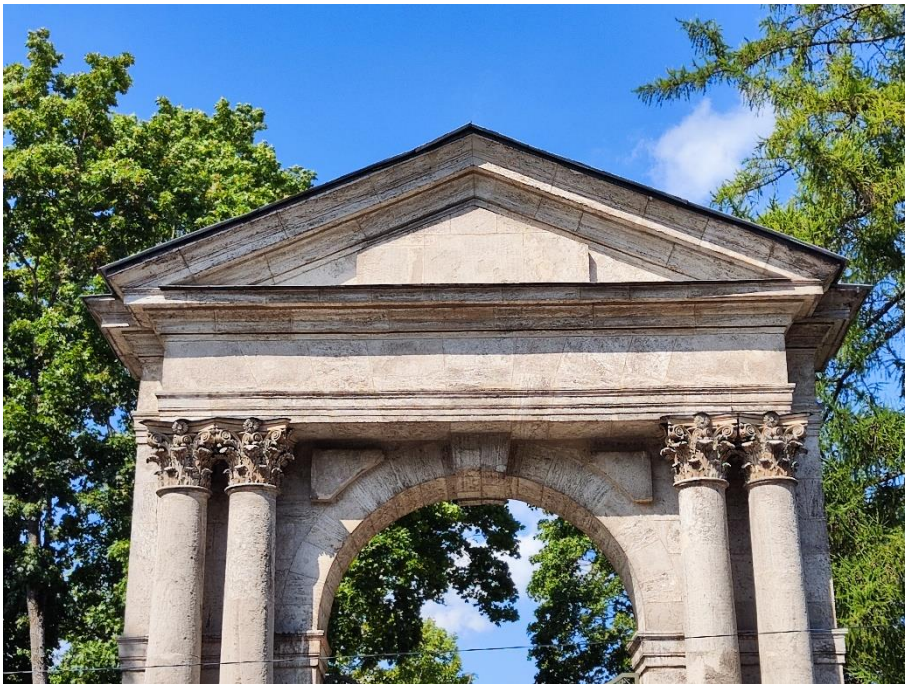
18. «Адмиралтейские ворота», 1797г.», Ленинградская область, Гатчинский район, город Гатчина, Дворцовый парк, сооружение 5. Юго-восточный фасад. Фрагмент. Фото 25.07.2023г.
