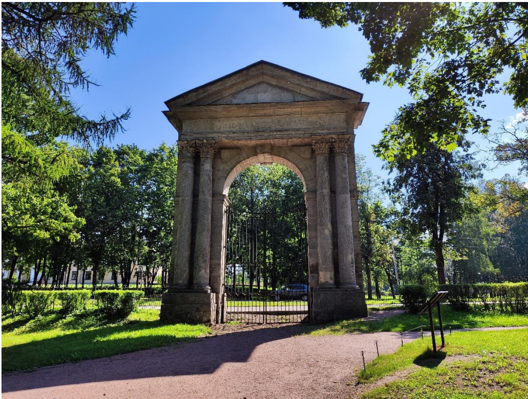
1. «Адмиралтейские ворота», 1797г.», Ленинградская область, Гатчинский район, город Гатчина, Дворцовый парк, сооружение 5. Общий вид с северо-запада. Фото 25.07.2023г.
