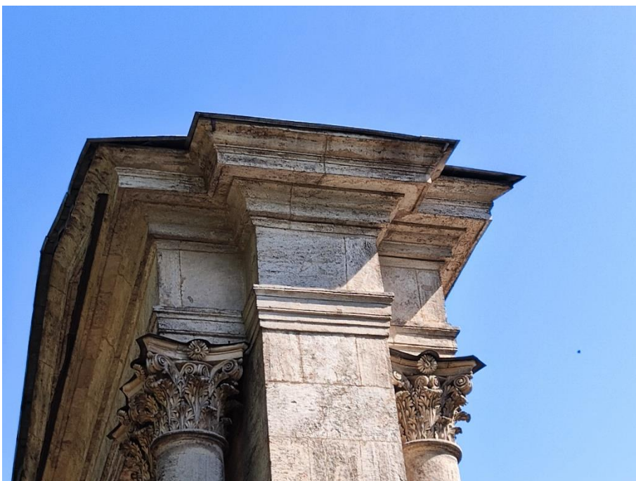
16. «Адмиралтейские ворота», 1797г.», Ленинградская область, Гатчинский район, город Гатчина, Дворцовый парк, сооружение 5. Юго-западный фасад. Фрагмент. Фото 25.07.2023г.
