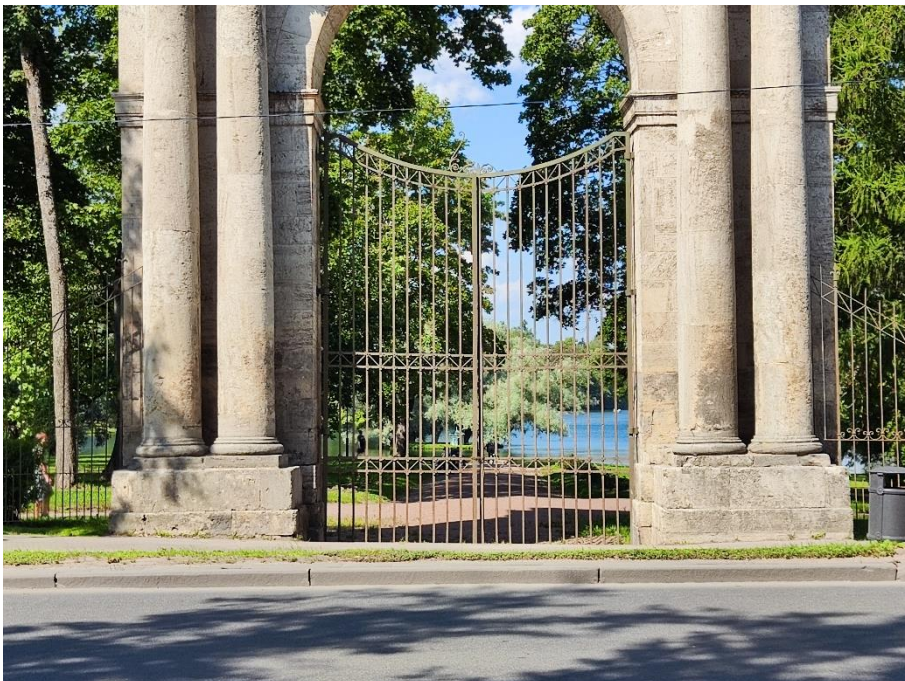
19. «Адмиралтейские ворота», 1797г.», Ленинградская область, Гатчинский район, город Гатчина, Дворцовый парк, сооружение 5. Юго-восточный фасад. Фрагмент. Фото 25.07.2023г.
