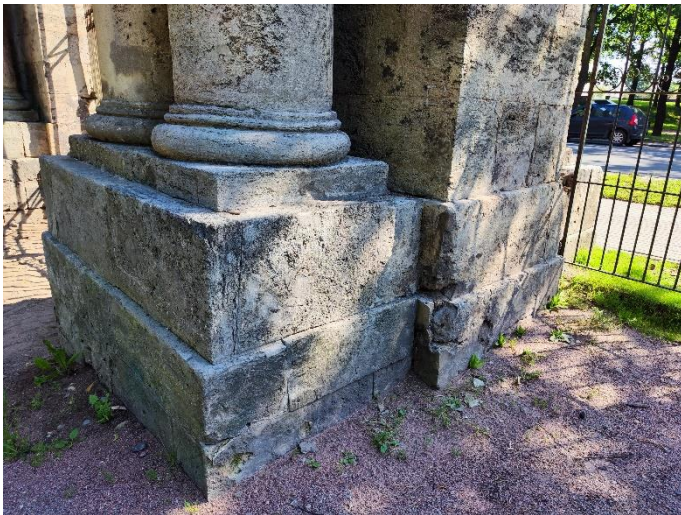
12. «Адмиралтейские ворота», 1797г.», Ленинградская область, Гатчинский район, город Гатчина, Дворцовый парк, сооружение 5. Северо-западный фасад. Фрагмент. Фото 25.07.2023г.
