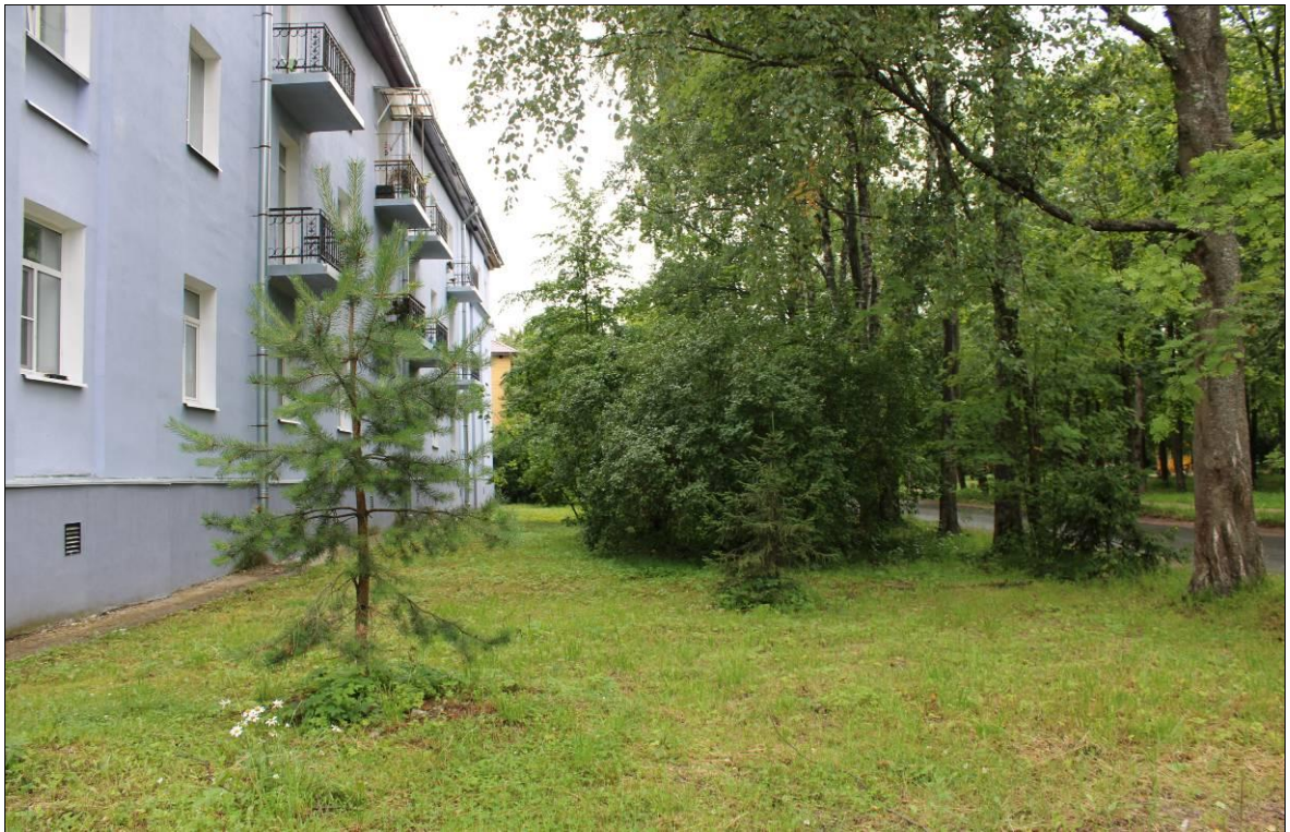
9. Территория между объектом культурного наследия регионального значения «Дом, где в 1943 г. находился штаб бригады воинов-понтонеров, наводивших переправы через Неву, после прорыва блокады Ленинграда. На доме установлена памятная доска» и улицей Спорта. Вид на юго-запад. 18.07.23 г.
