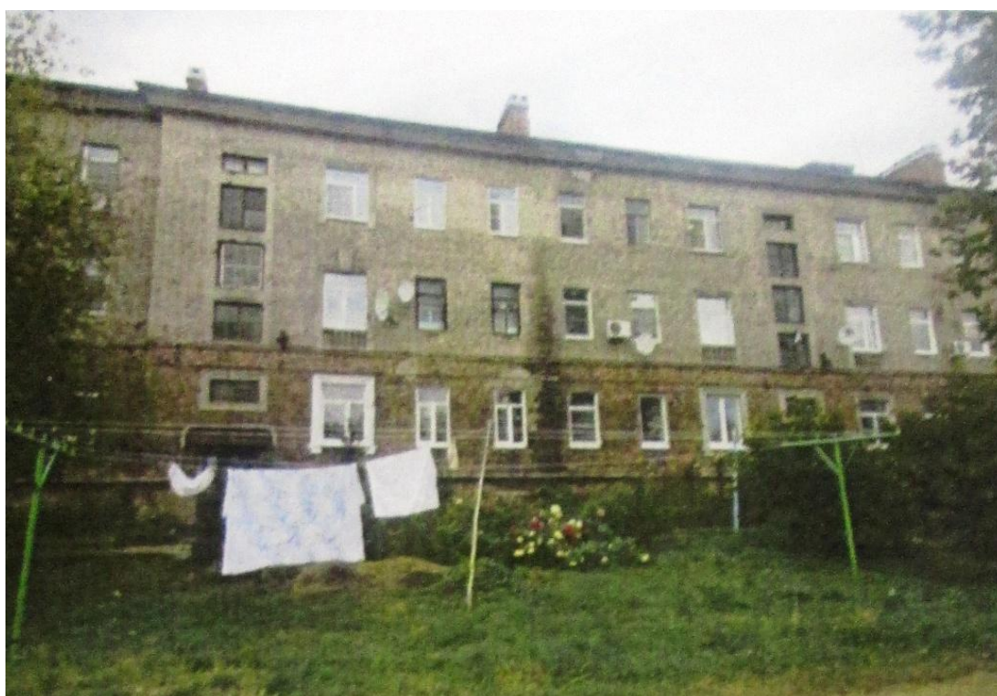
Ил. 12. Архив Комитета по сохранению культурного наследия Ленинградской области. Поселок имени Морозова. Дом, где в 1943 году находился штаб 3-й Понтонно-мостовой бригады РГК. Вид на южную стену здания. Фото 2017 г.
