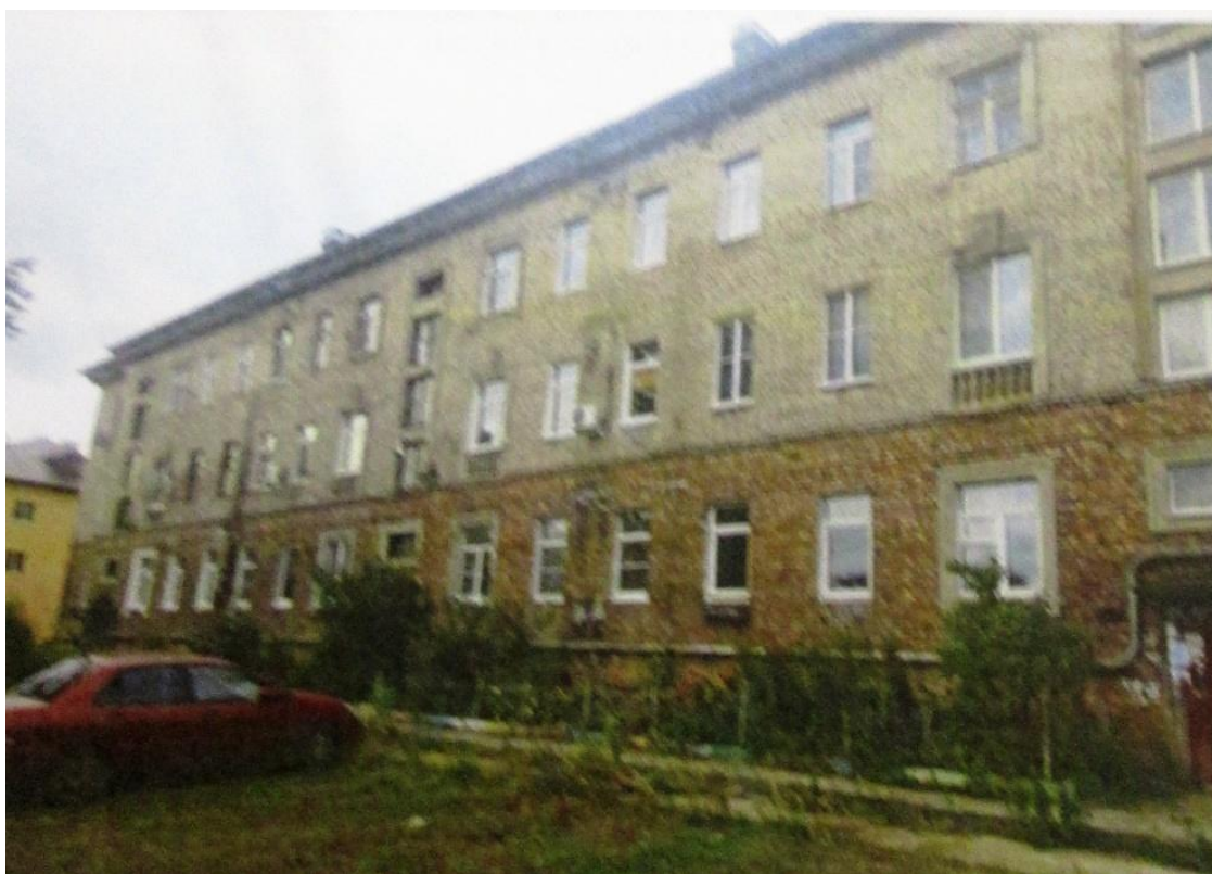
Ил. 13. Архив Комитета по сохранению культурного наследия Ленинградской области. Поселок имени Морозова. Дом, где в 1943 году находился штаб 3-й Понтонно-мостовой бригады РГК. Вид на центральную часть южной стены здания. Фото 2017 г.
