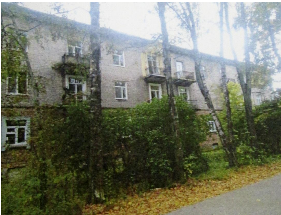
Ил. 15. Архив Комитета по сохранению культурного наследия Ленинградской области. Поселок имени Морозова. Дом, где в 1943 году находился штаб 3-й Понтонно-мостовой бригады РГК. Вид на центральную часть северной стены здания. Фото 2017 г.
