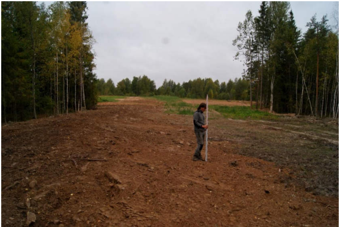
Рис. 2 6. Объект «Реконструкция ЕСГ Северо-Западного региона для обеспечения транспортировки этансодержащего газа по побережью Балтийского моря» (км 332,0-км 850,0 (до КПЭГ). Ленинградская область. Фотофиксация 2019 г. Комплекс памятников у дер. Городище: «Курганный могильник Бесовы Харчевни», «Курганный и грунтовый могильник Красня Заря». Вид с В на центральную часть памятника.
