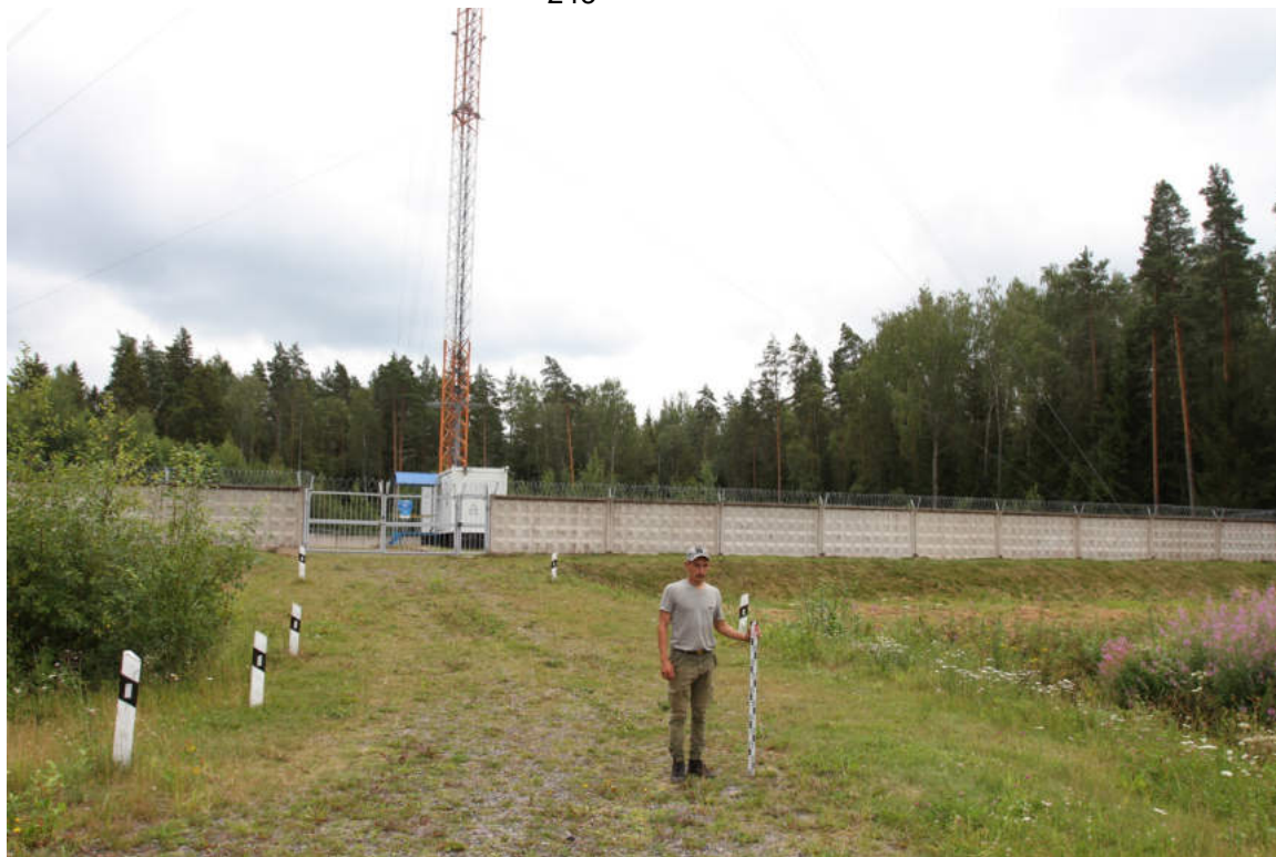
Рис. 153. Ленинградская область. Волховский район. Колчановское СП. Общий вид южной части участка обследования. Вид с З.
