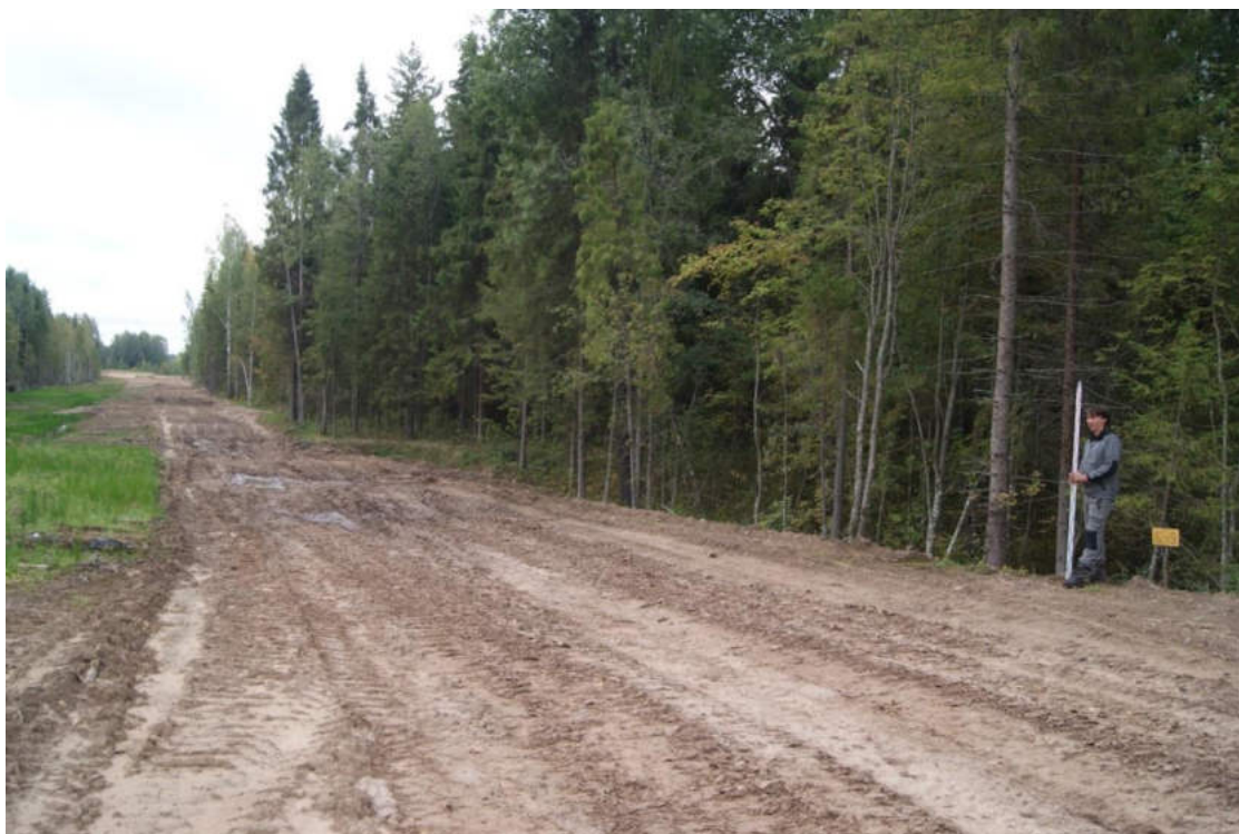
Рис. 210. Объект «Реконструкция ЕСГ Северо-Западного региона для обеспечения транспортировки этансодержащего газа по побережью Балтийского моря» (км 332,0-км 850,0 (до КПЭГ). Ленинградская область. Фотофиксация 2019 г. Комплекс памятников у дер. Городище: «Курганный могильник Бесовы Харчевни», «Курганный и грунтовый могильник Красня Заря». Вид с С-СВ на северную часть памятника.
