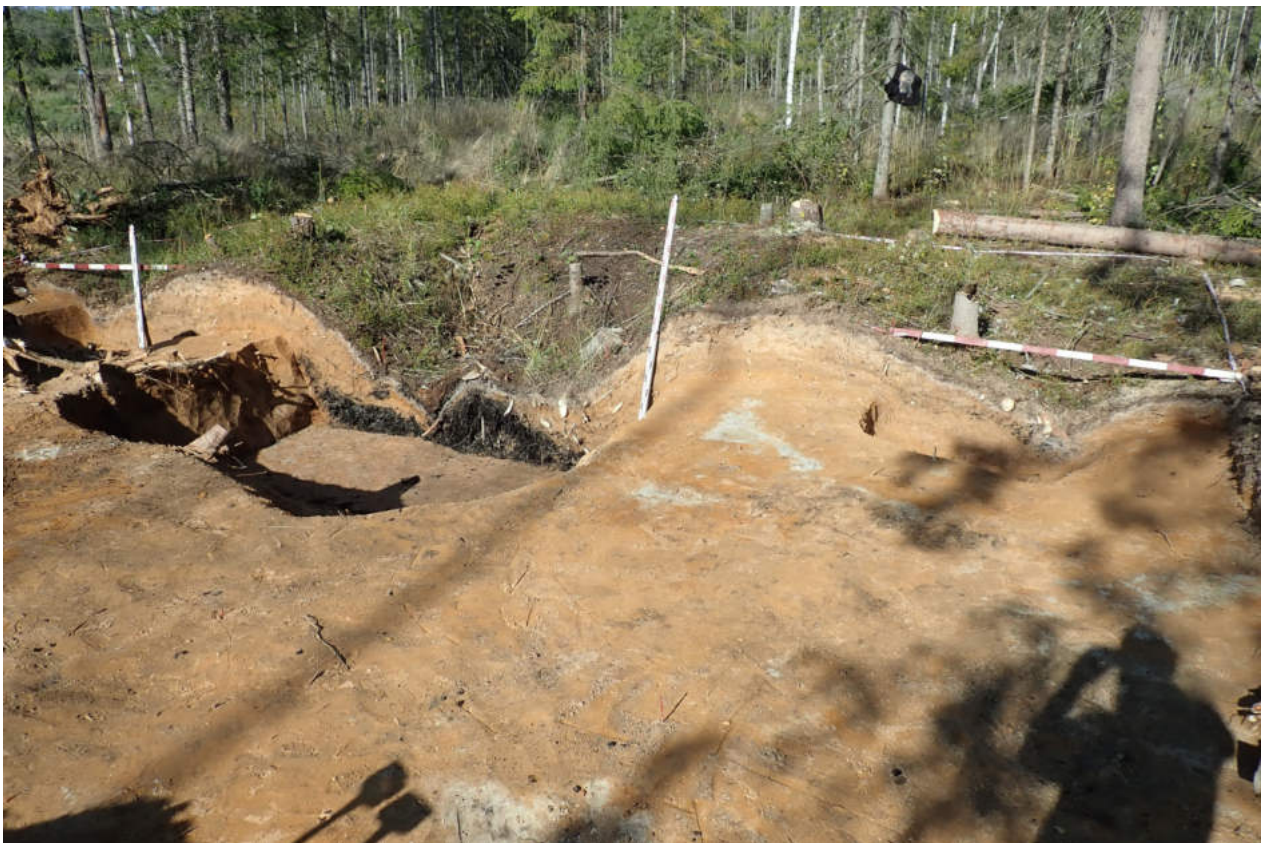
Илл. 54 Ленинградская область. Тихвинский муниципальный район. Выявленный ОАН «Углежогная яма Сарка-7». Разрез по линии квадратов А-Д 2. Вид с востока.
