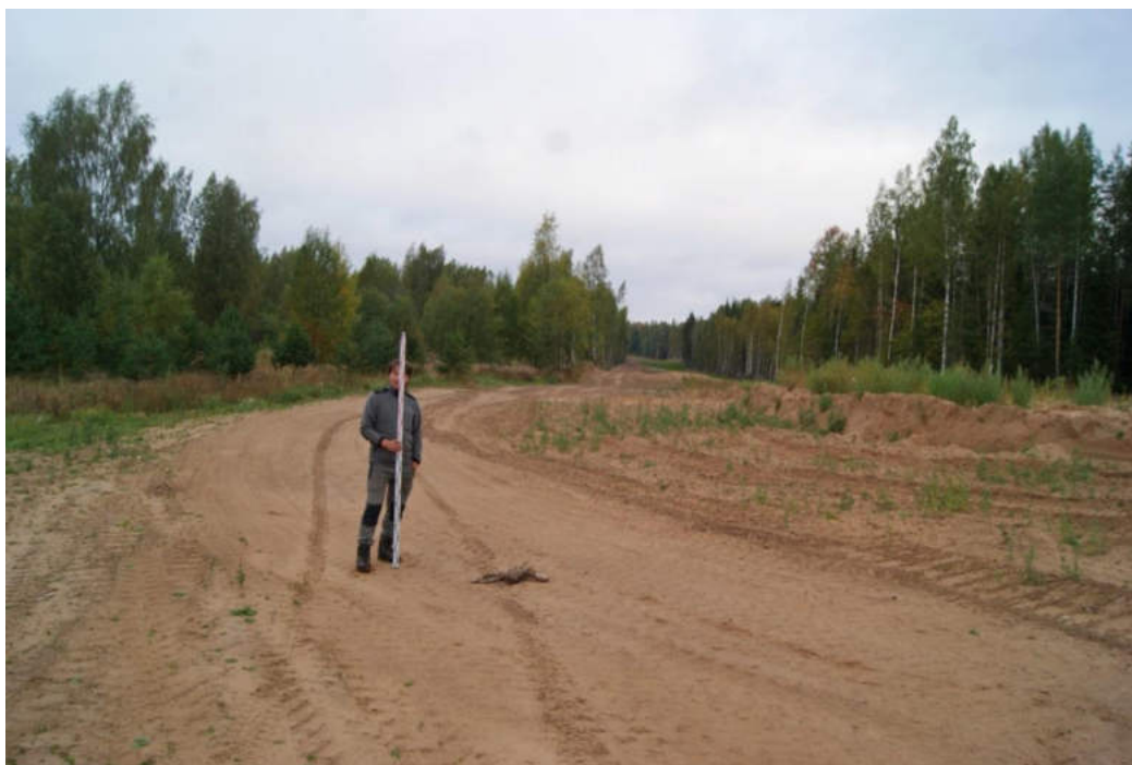
Рис. 209. Объект «Реконструкция ЕСГ Северо-Западного региона для обеспечения транспортировки этансодержащего газа по побережью Балтийского моря» (км 332,0-км 850,0 (до КПЭГ)). Ленинградская область. Фотофиксация 2019 г. Комплекс памятников у дер. Городище: «Курганный могильник Бесовы Харчевни», «Курганный и грунтовый могильник Красня Заря». Вид с Ю-ЮВ на северную часть памятника.
