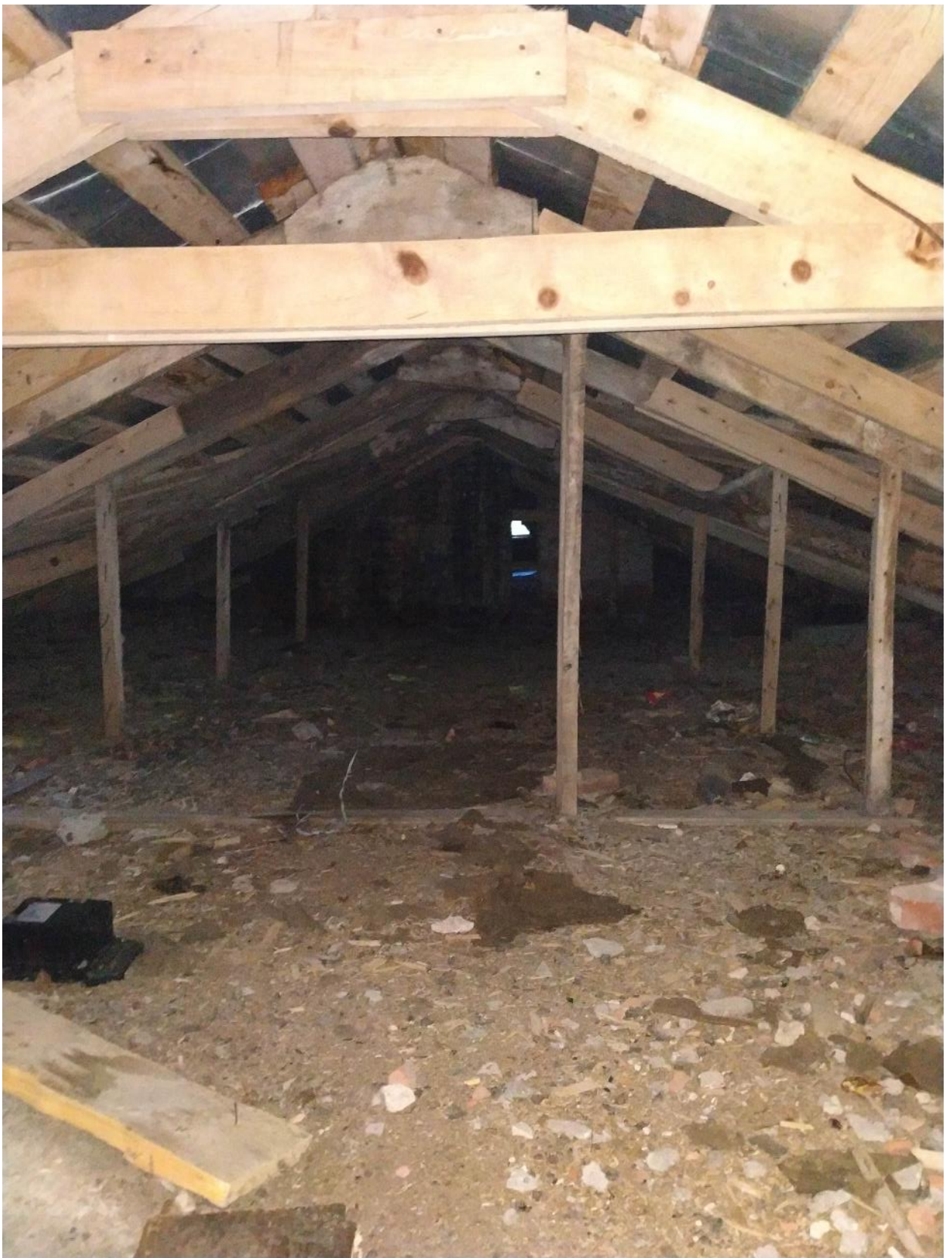
Фото 31. 06 Октября 2023г. Стропильная система центрального флигеля.
