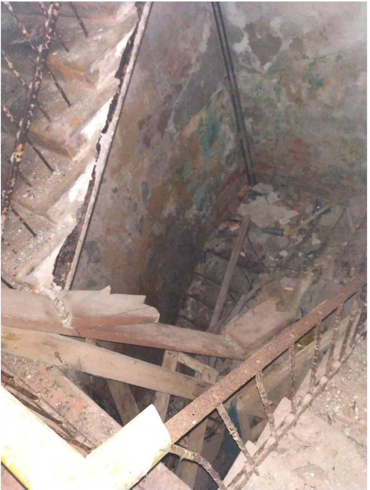
Фото 24. 06 Октября 2023г. Лестничная клетка центрального флигеля по оси 11.
