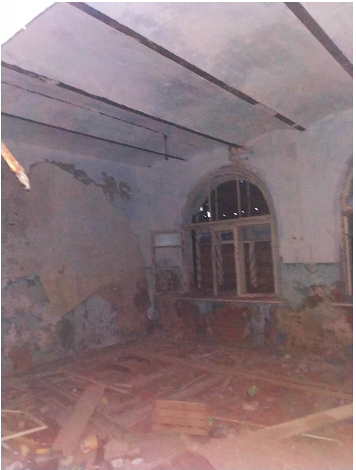
06 Октября 2023г. Помещение первого этажа южного крыла.
