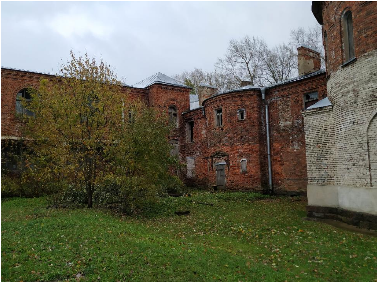
Фото 14. 06 Октября 2023г. Северное крыло, восточный фасад, общий вид.
