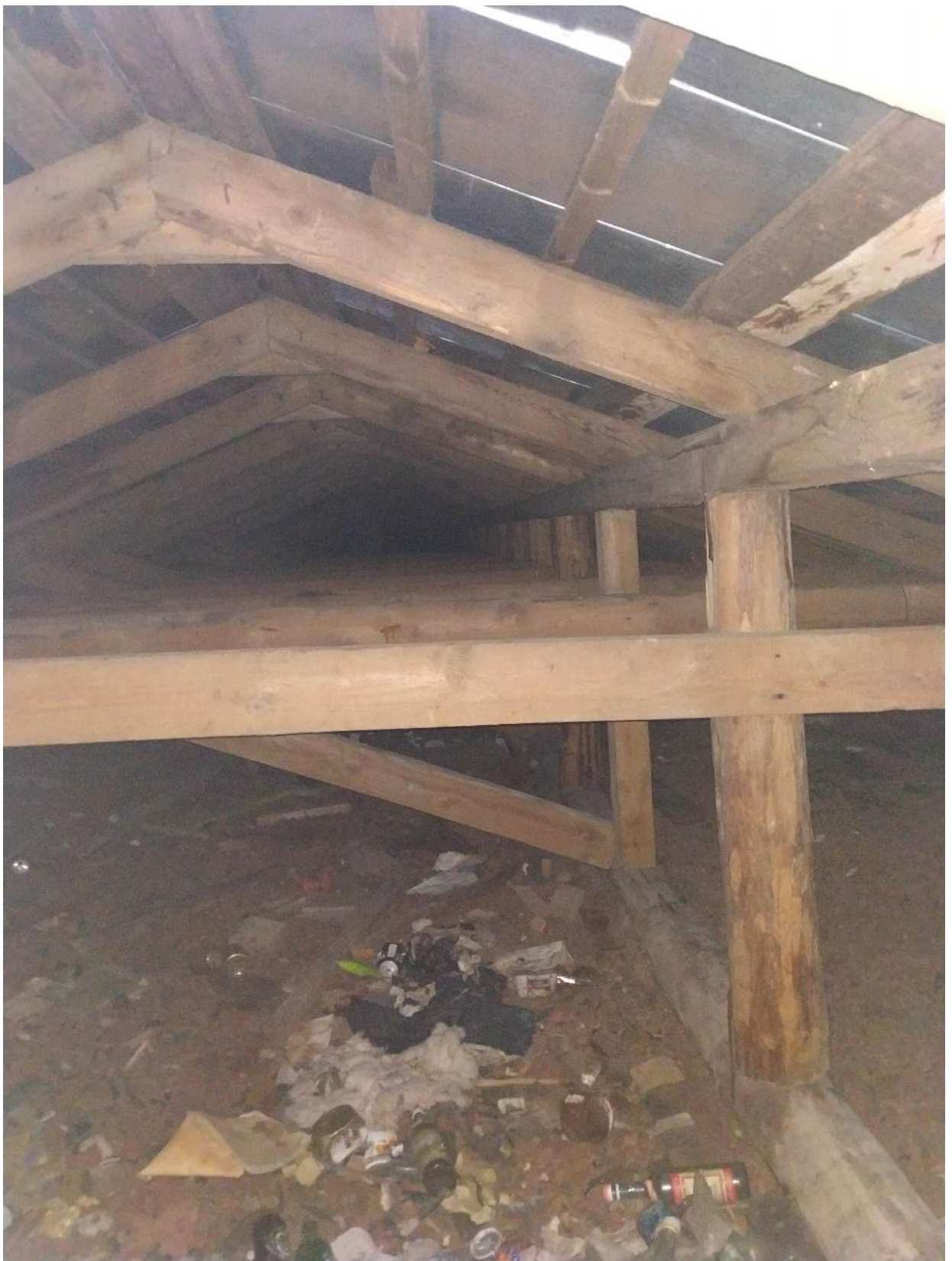
Фото 23. 06 Октября 2023г. Стропильная система южного крыла.
