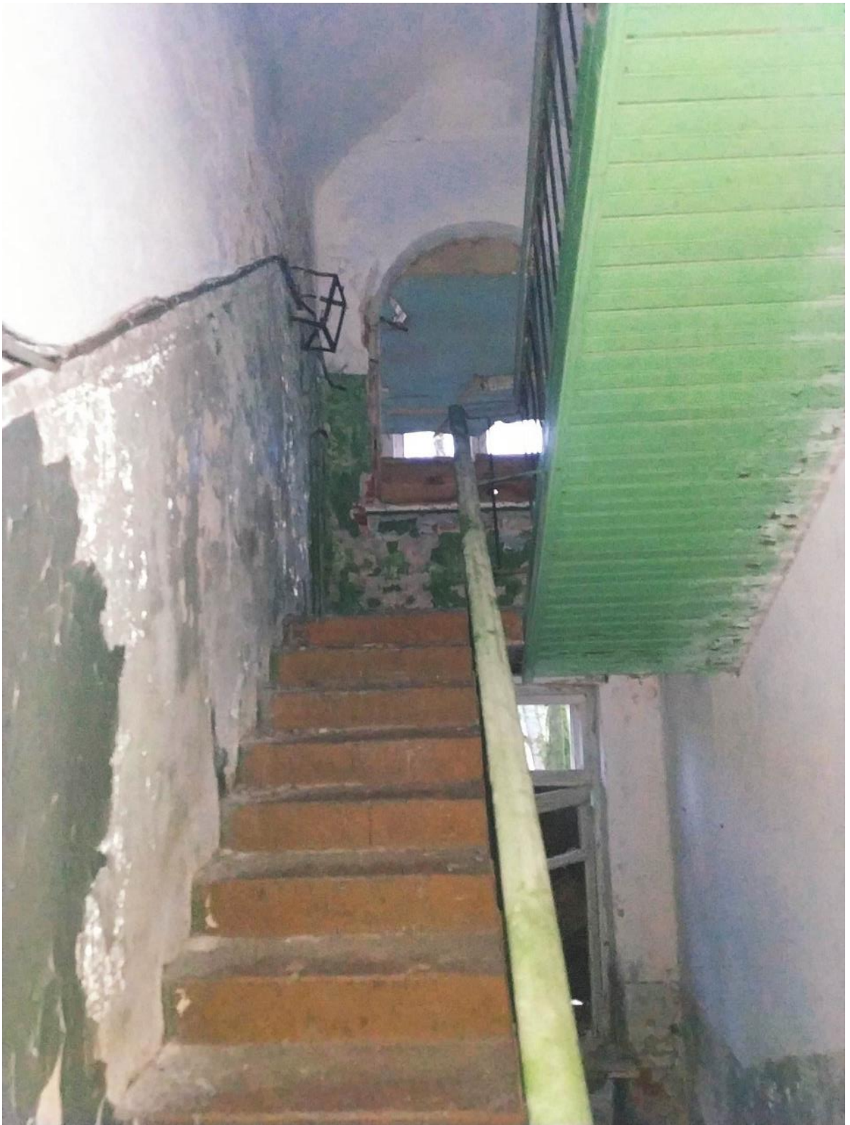
Фото 18. 06 Октября 2023г. Лестница южного крыла по оси 27.
