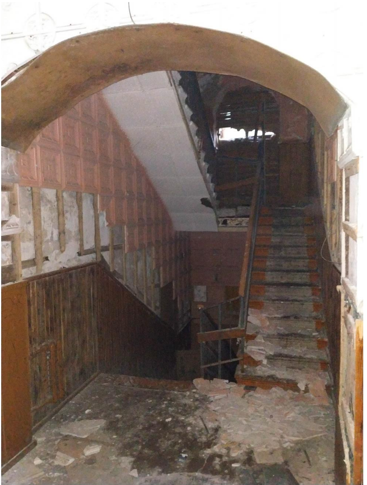
Фото 30. 06 Октября 2023г. Лестница центрального флигеля по оси 14.
