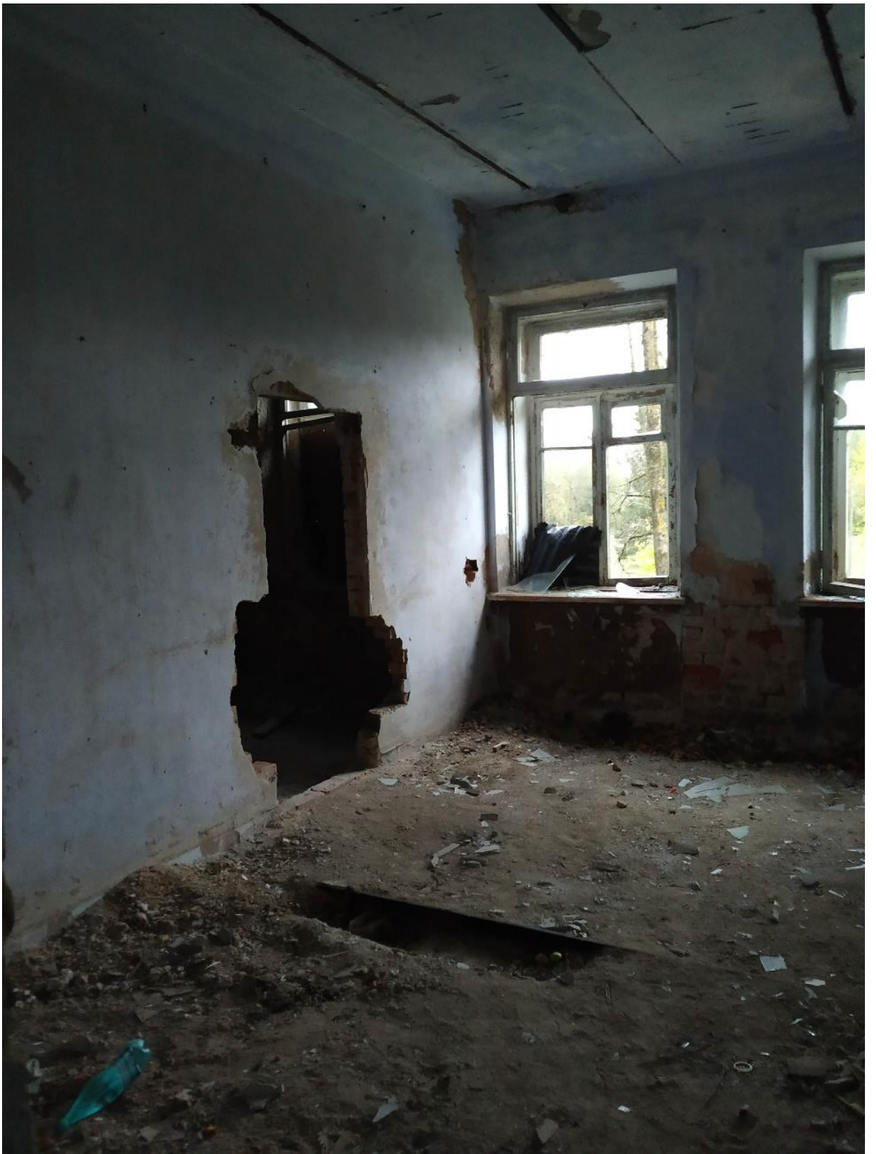
Фото 34. 06 Октября 2023г. Помещение второго этажа северного крыла.
