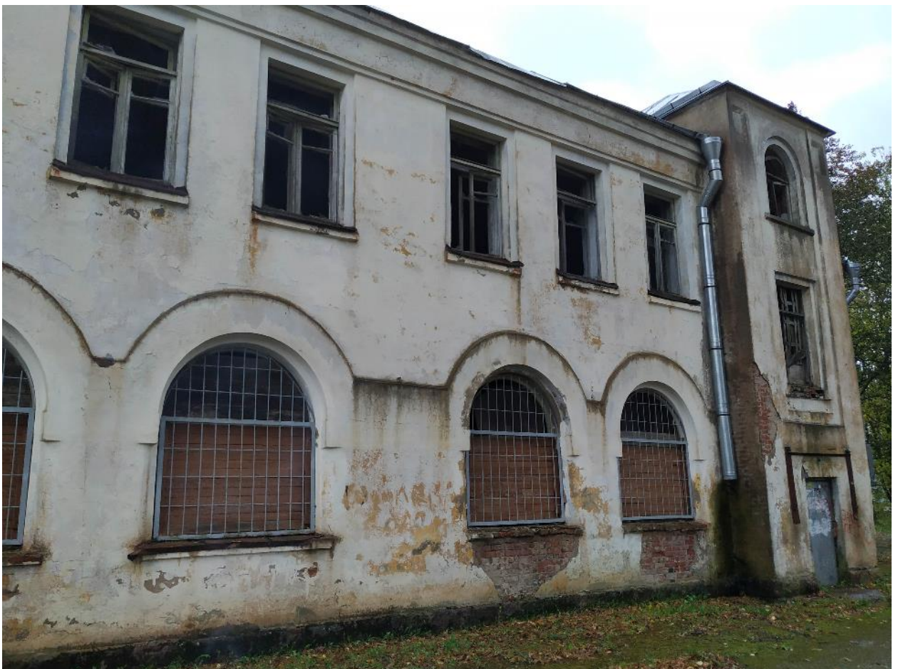
Фото 4. 06 Октября 2023г. Южное крыло, западный фасад, фрагмент.
