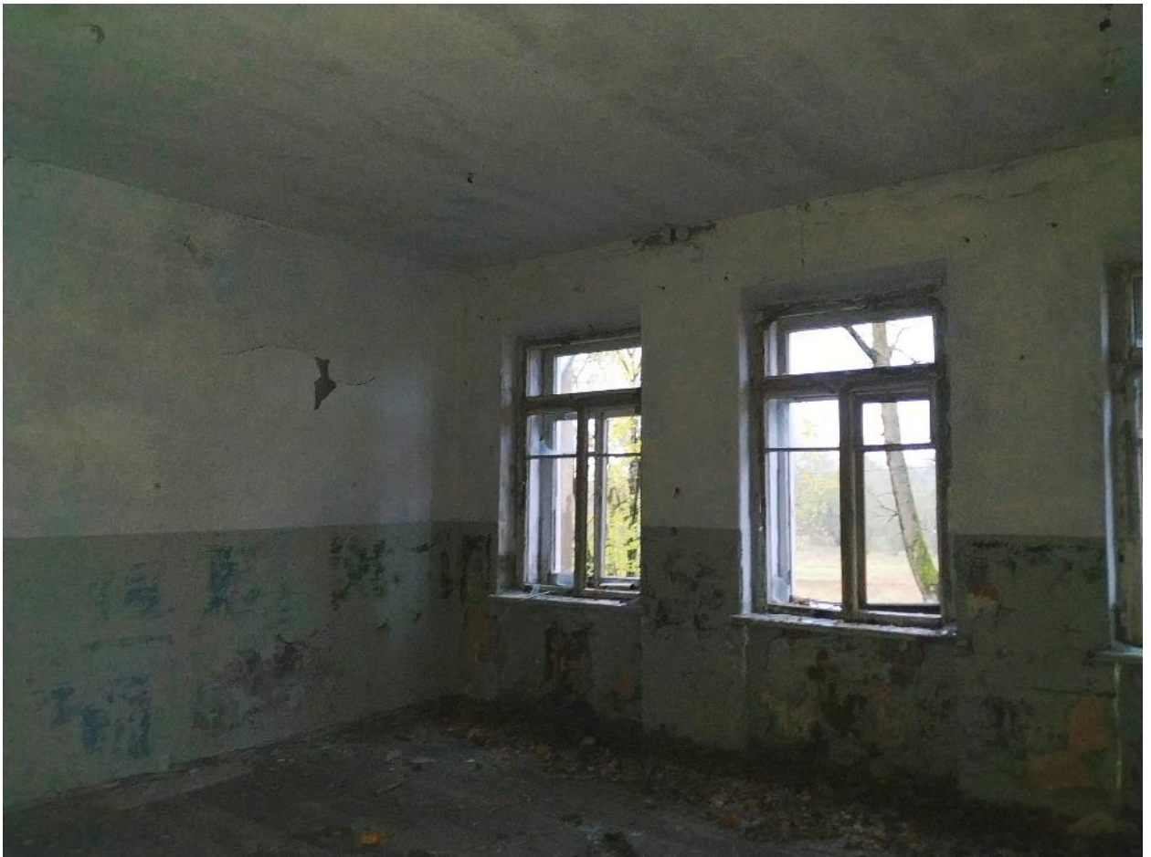
Фото 17. 06 Октября 2023г. Помещение второго этажа южного крыла.
