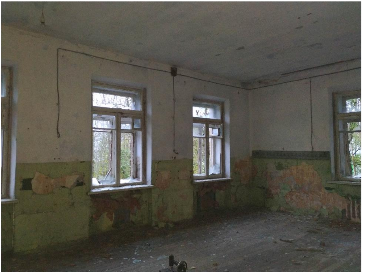
Фото 21. 06 Октября 2023г. Помещение второго этажа южного крыла.
