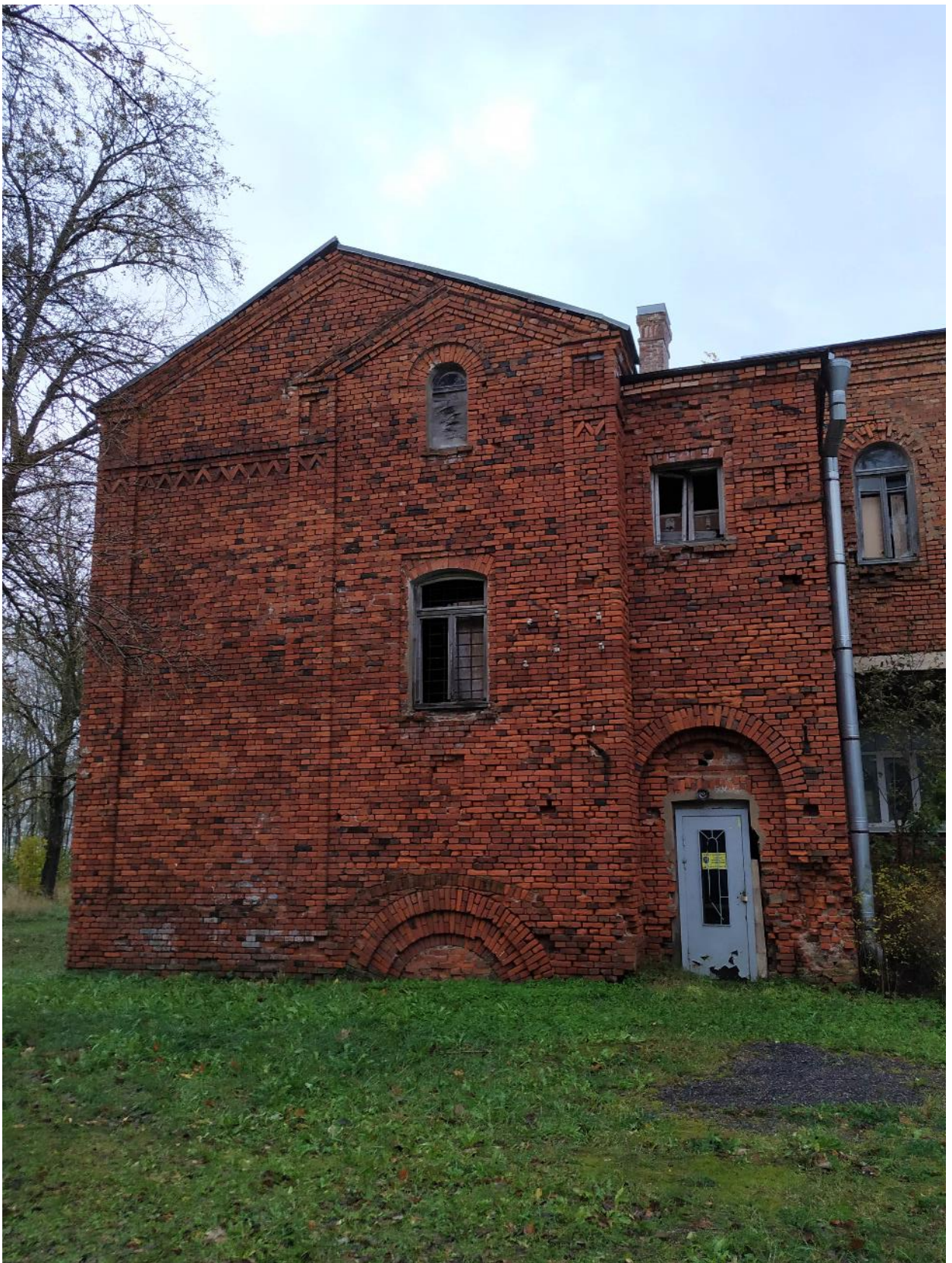
Фото 12. 06 Октября 2023г. Центральный флигель, северный фасад, фрагмент в осях С/П.
