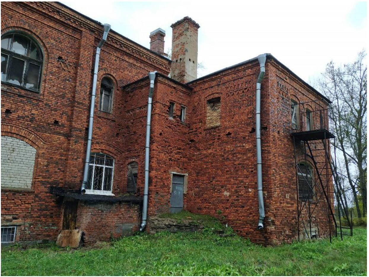
Фото 9. 06 Октября 2023г. Центральный флигель, южный фасад, фрагмент в осях И/С.
