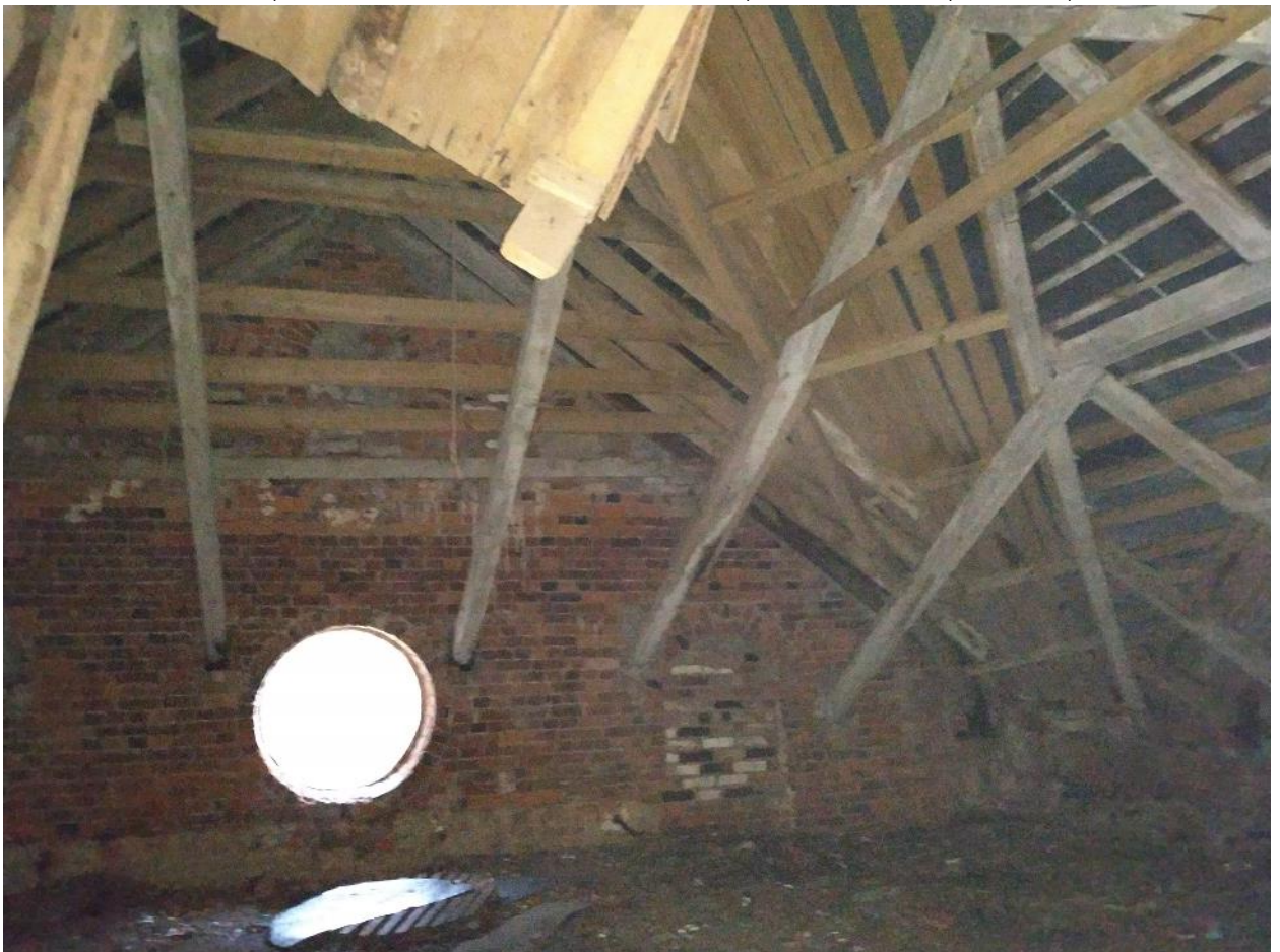
Фото 28. 06 Октября 2023г. Стропильная система центрального флигеля.
