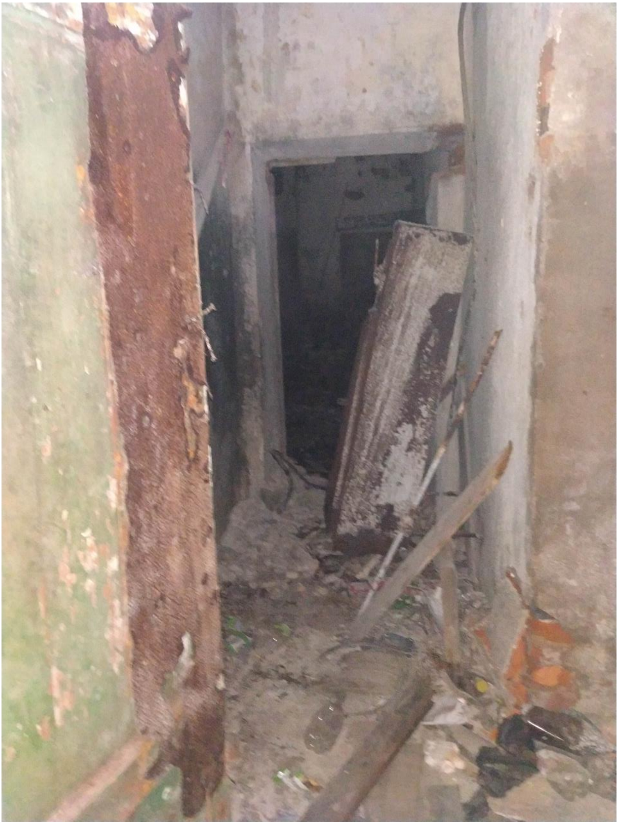
Фото 25. 06 Октября 2023г. Коридор подвального этажа центрального флигеля.
