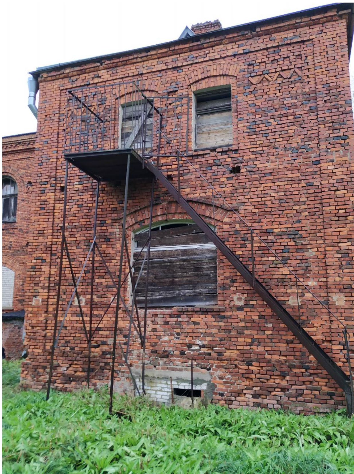
Фото 11. 06 Октября 2023г. Центральный флигель, южный фасад, фрагмент в осях П/С.
