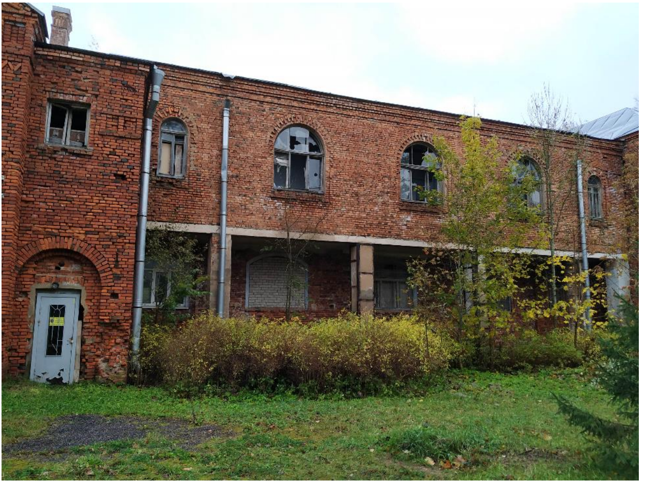
Фото 13. 06 Октября 2023г. Центральный флигель, северный фасад, Общий вид в осях И/С.
