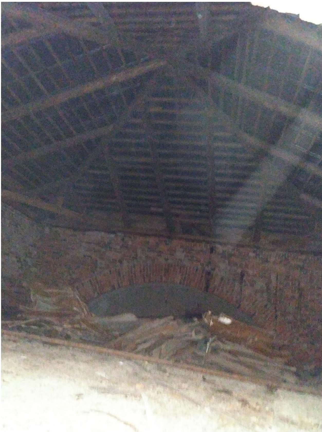
Фото 41. 06 Октября 2023г. Стропильная система церкви.
