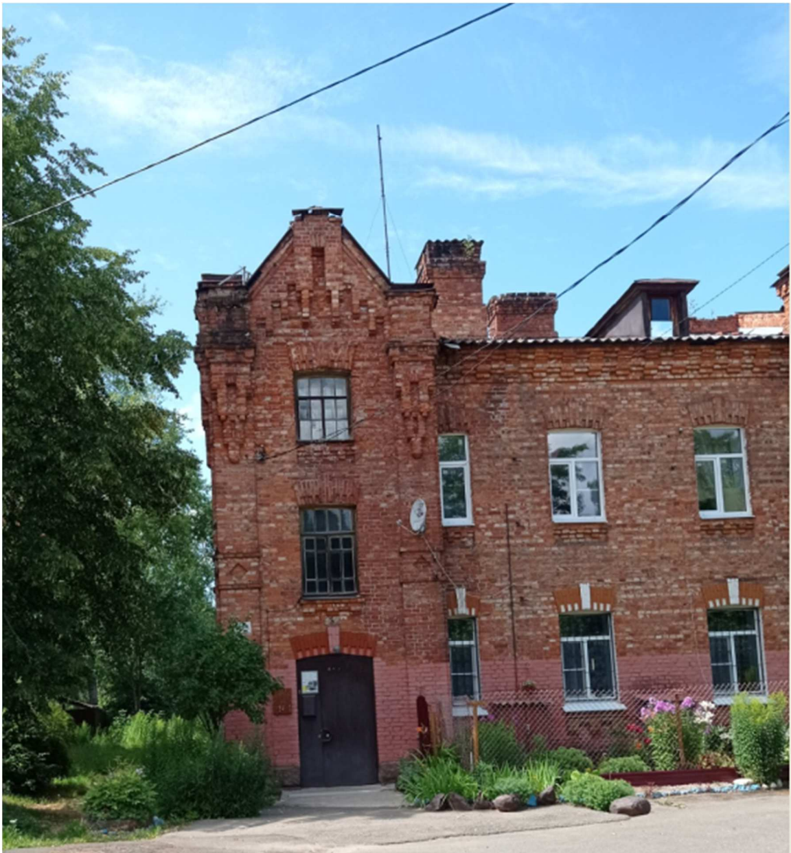
1. Восточный фасад. Фрагмент
