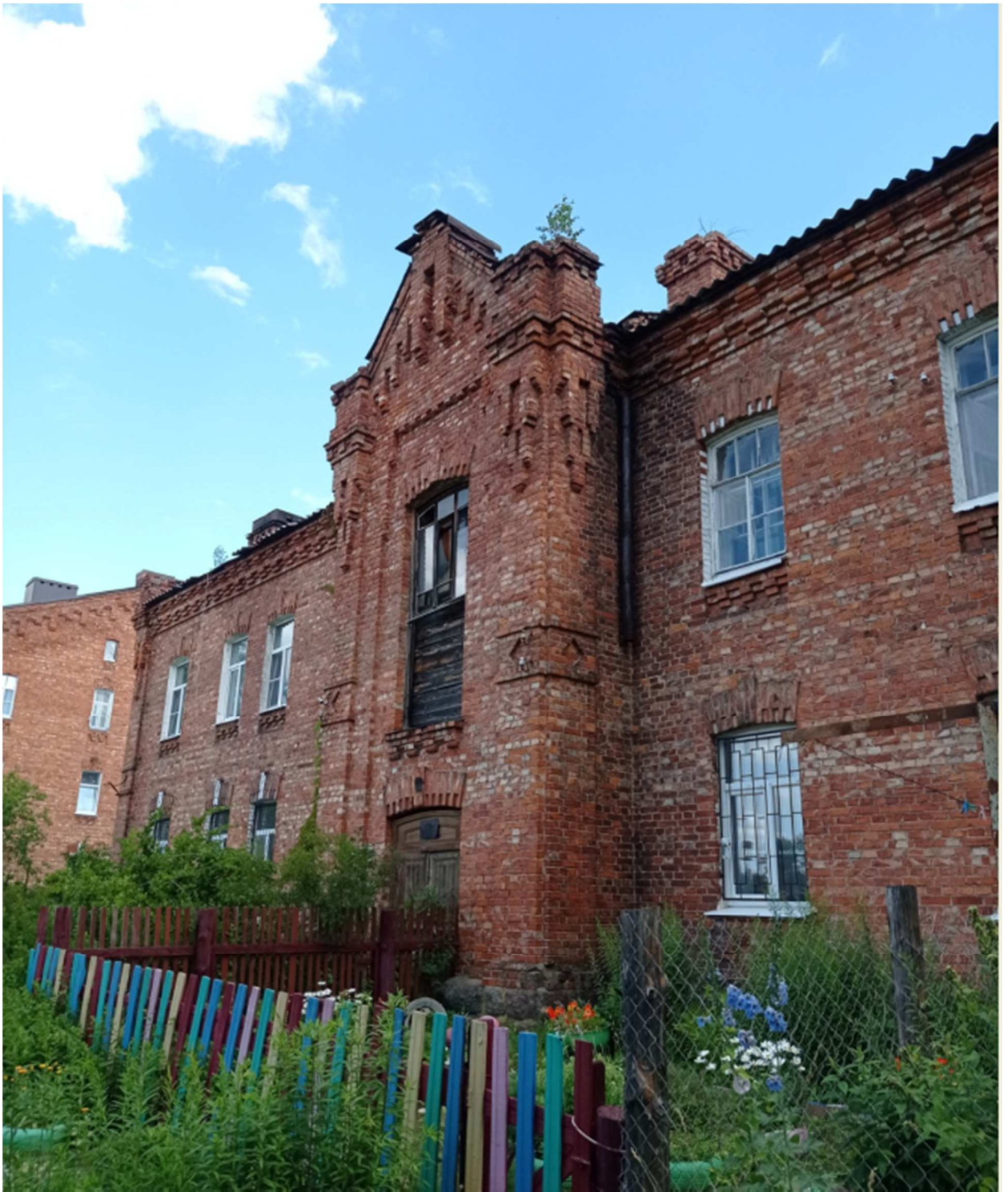
4. Западный фасад. Общий вид.
