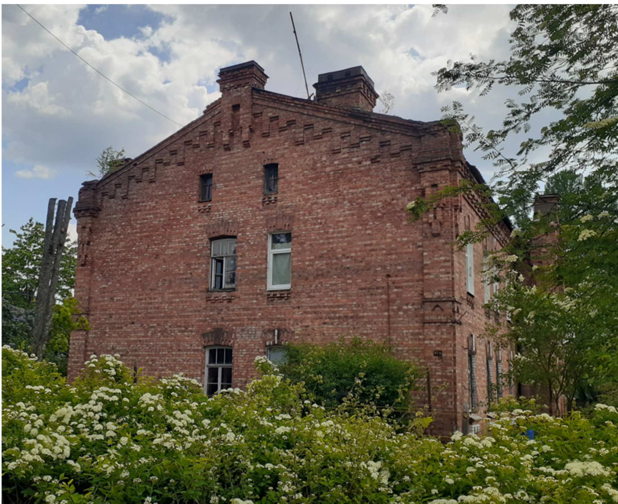
5. Северный торцевой фасад. Общий вид.
