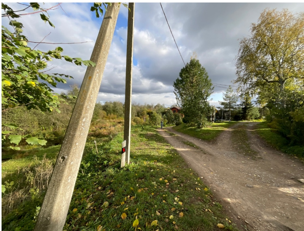
Рис. 29. Ленинградская область, Волховский район, «Распределительный газопровод и газопроводы-вводы по дер.Ахматова Гора». Участок 2. Точка фотофиксации 8. Вид на ЮВ.
