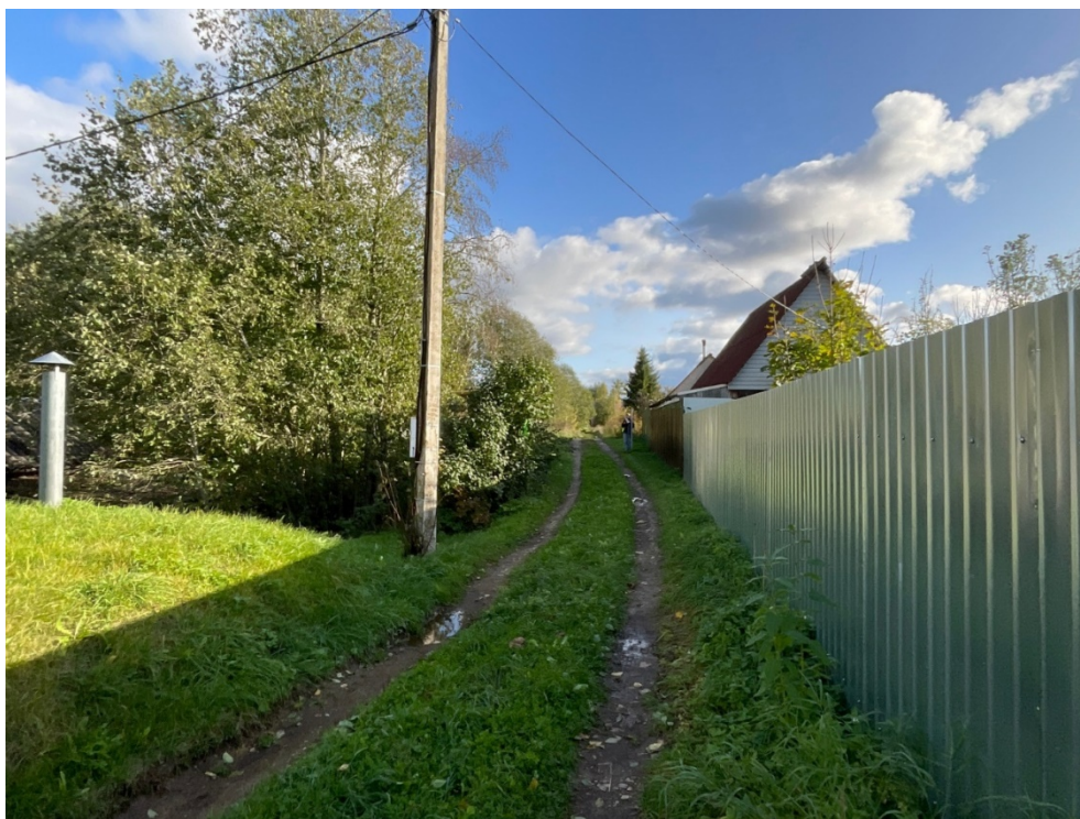
Рис. 15. Ленинградская область, Волховский район, «Распределительный газопровод и газопроводы-вводы по дер.Ахматова Гора». Участок 1. Точка фотофиксации 3. Вид на ЮВ.
