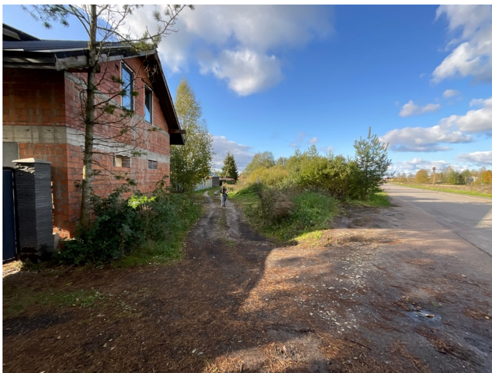
Рис. 14. Ленинградская область, Волховский район, «Распределительный газопровод и газопроводы-вводы по дер.Ахматова Гора». Участок 1. Точка фотофиксации 2. Вид на СЗ.
