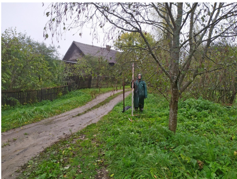
Рис. 20. Ленинградская область, Волховский район, «Распределительный газопровод и газопроводы-вводы по дер.Ахматова Гора». Участок 1. Шурф 1. Вид с Ю.
