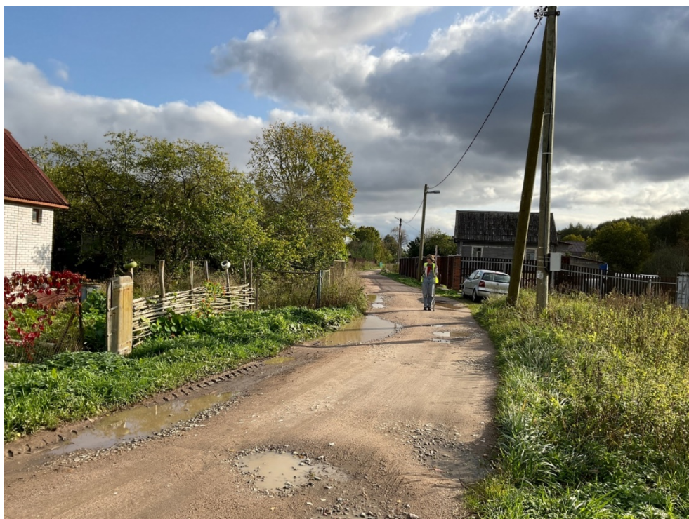
Рис. 27. Ленинградская область, Волховский район, «Распределительный газопровод и газопроводы-вводы по дер.Ахматова Гора». Участок 2. Точка фотофиксации 7. Вид на ЮВ.
