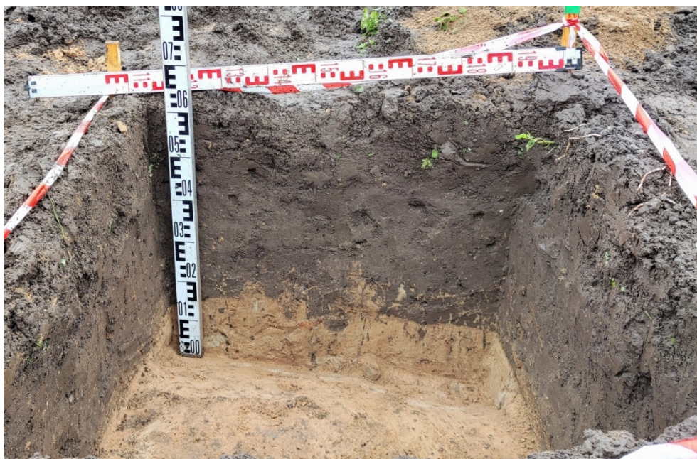
Рис. 37. Ленинградская область, Волховский район, «Распределительный газопровод и газопроводы-вводы по дер.Ахматова Гора». Участок 2. Шурф 2 Западная стенка и контрольный прокоп. Вид на З.
