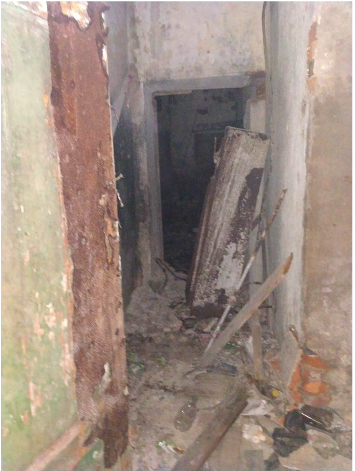
Фото 25. 06 Октября 2023г. Коридор подвального этажа центрального флигеля.
