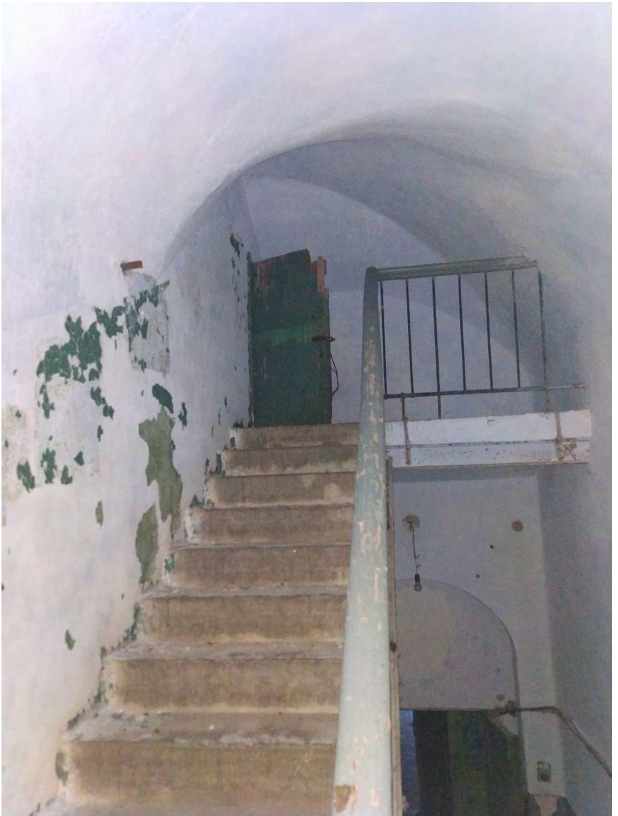
Фото 22. 06 Октября 2023г. Выход на чердак с лестницы по оси 27 южного крыла.
