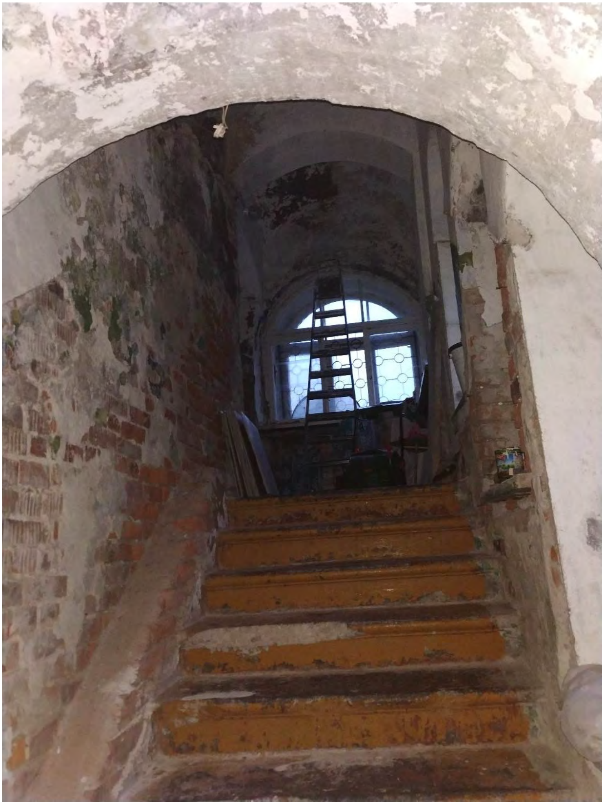
Фото 38. 06 Октября 2023г. Выход на хоры церкви.
