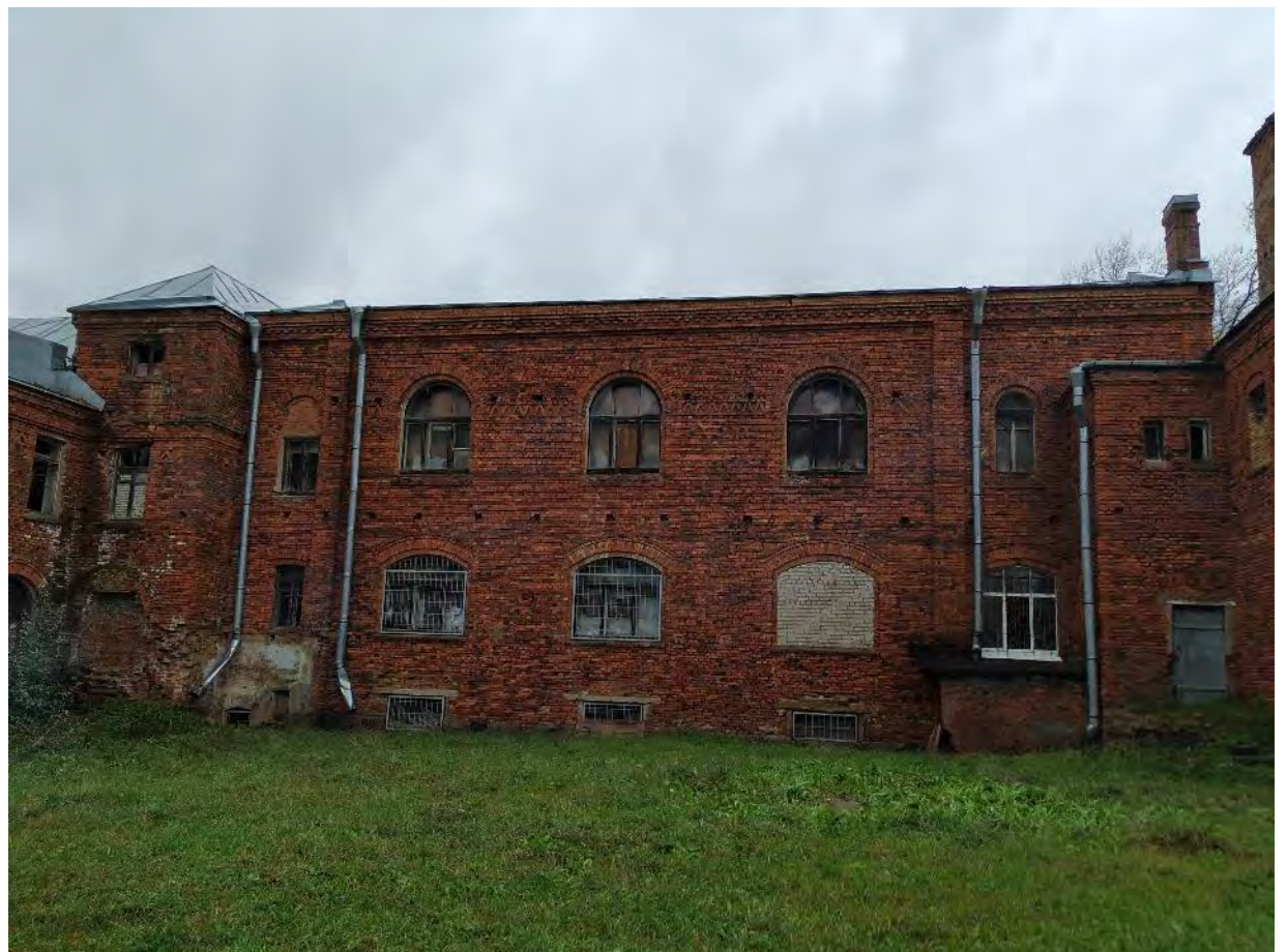
Фото 8. 06 Октября 2023г. Центральный флигель, южный фасад, общий вид.
