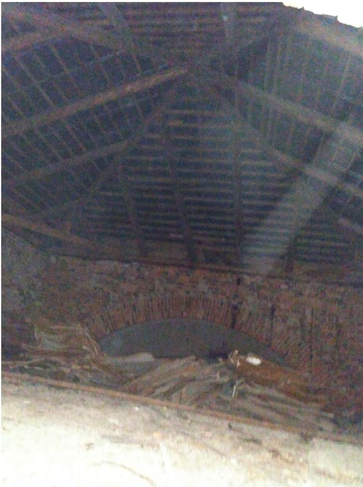
Фото 41. 06 Октября 2023г. Стропильная система церкви.
