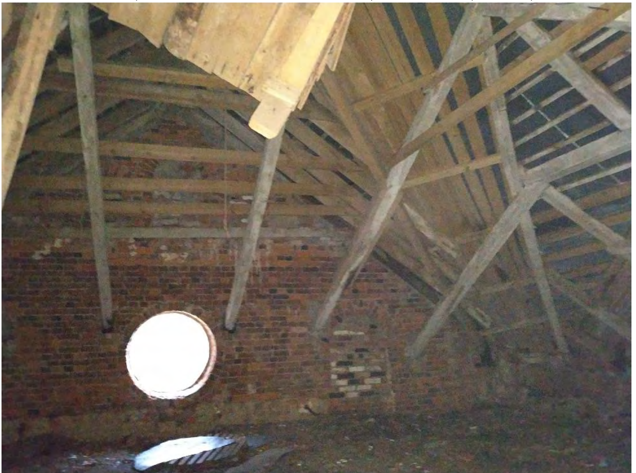
Фото 28. 06 Октября 2023г. Стропильная система центрального флигеля.
