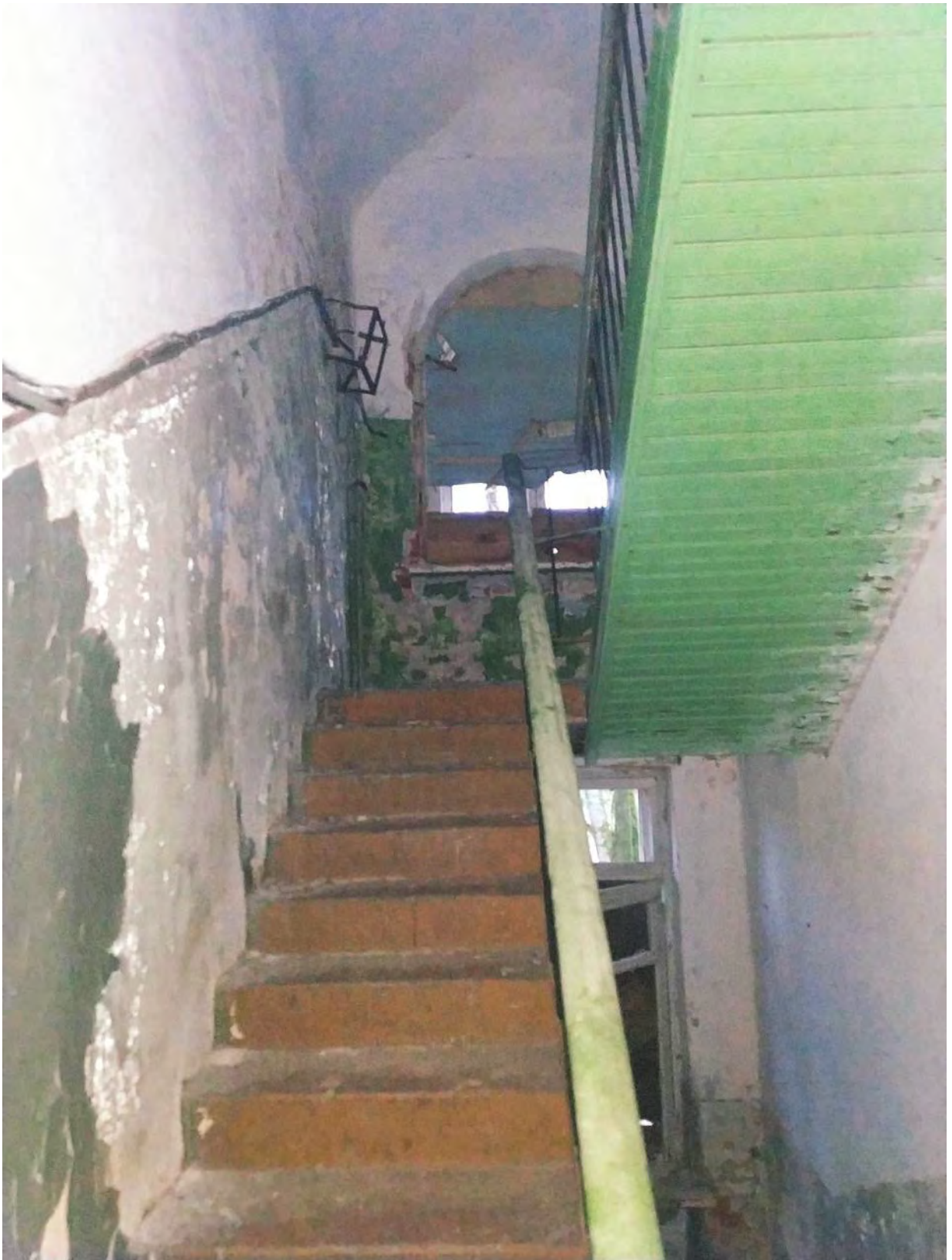
Фото 18. 06 Октября 2023г. Лестница южного крыла по оси 27.
