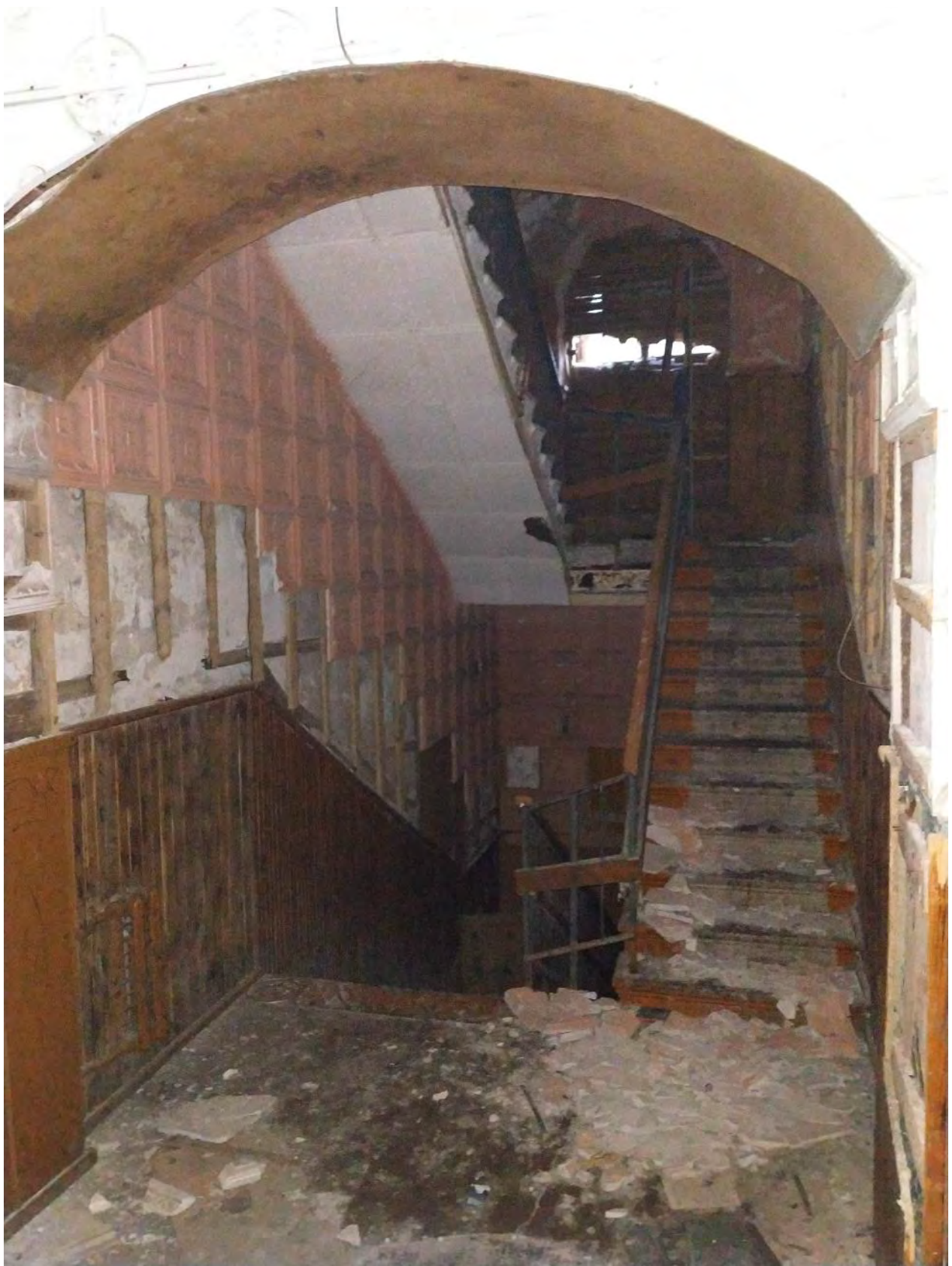
Фото 30. 06 Октября 2023г. Лестница центрального флигеля по оси 14.
