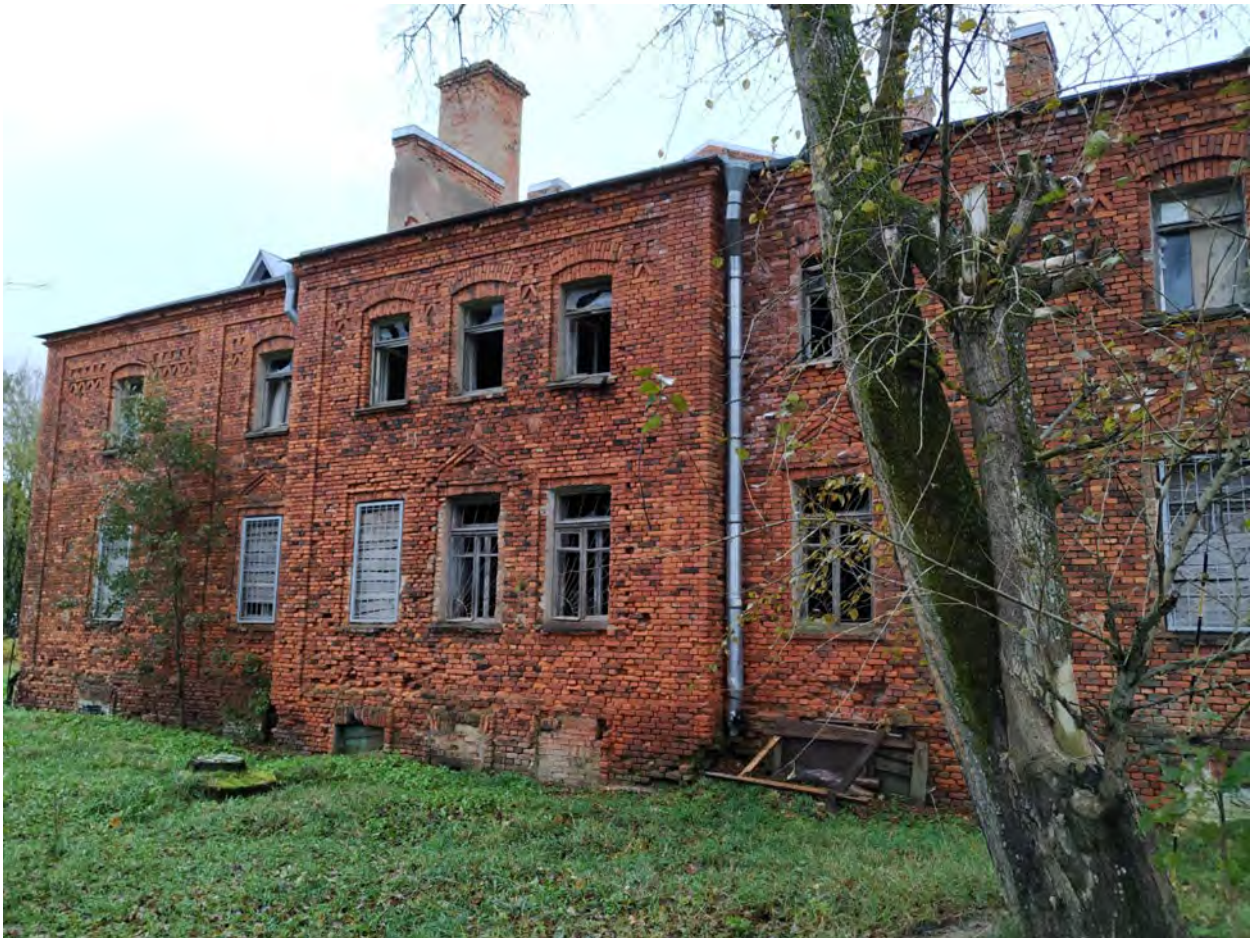
Фото 10. 06 Октября 2023г. Центральный флигель, восточный фасад, Общий вид в осях 22/11.
