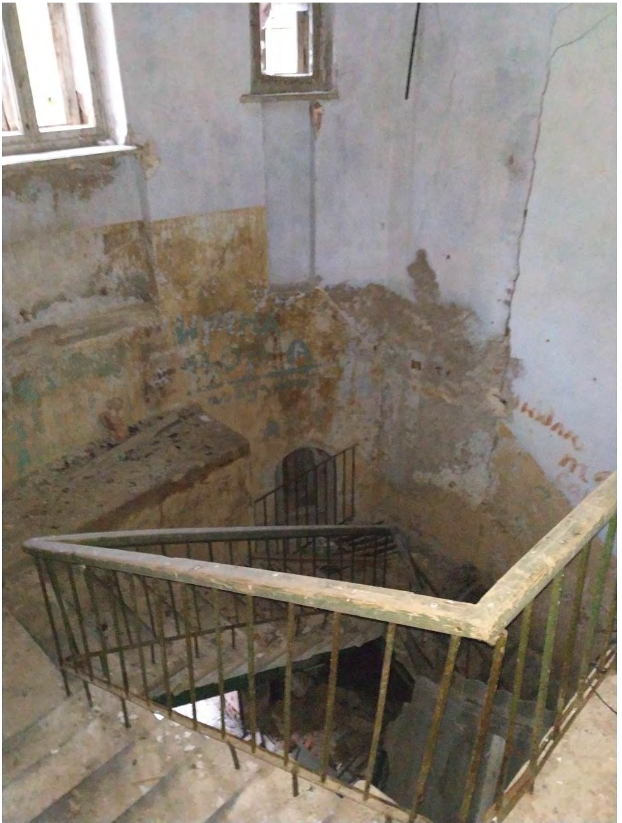
Фото 32. 06 Октября 2023г. Лестничная клетка северного крыла по оси Д.
