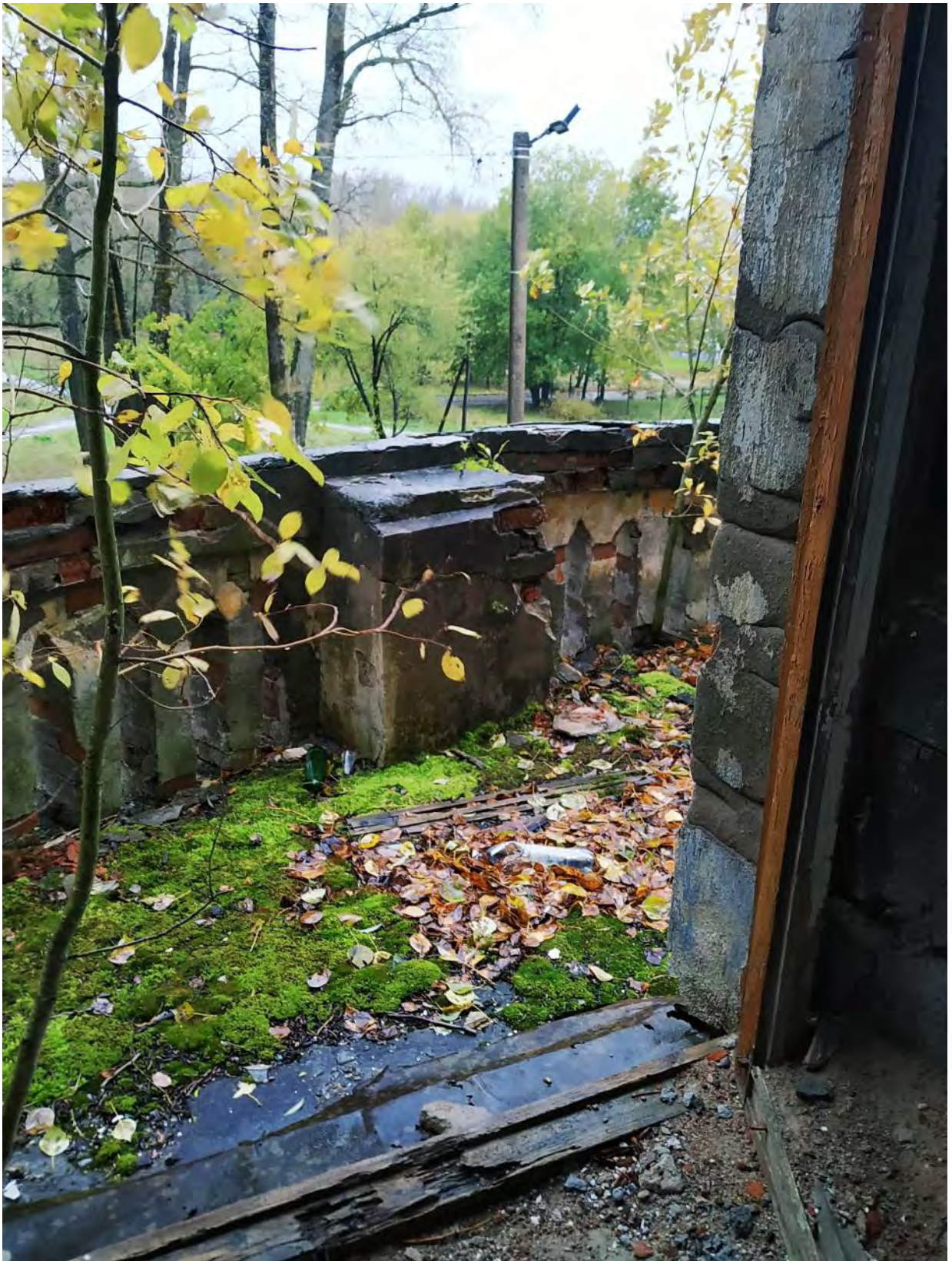
Фото 20. 06 Октября 2023г. Центральный балкон второго этажа западного фасада.
