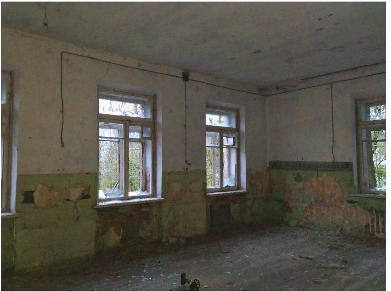
Фото 21. 06 Октября 2023г. Помещение второго этажа южного крыла.
