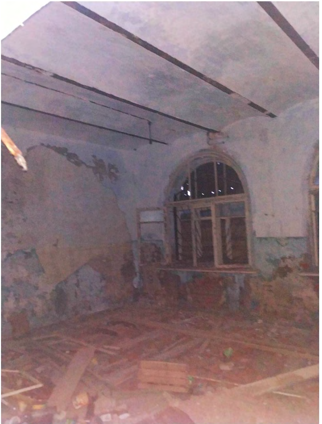
06 Октября 2023г. Помещение первого этажа южного крыла.
