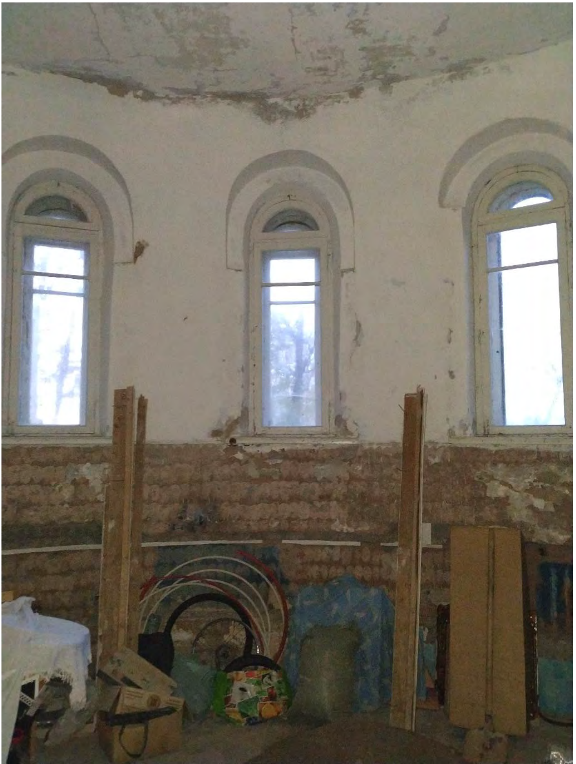
Фото 39. 06 Октября 2023г. Второй этаж, зона апсид церкви.
