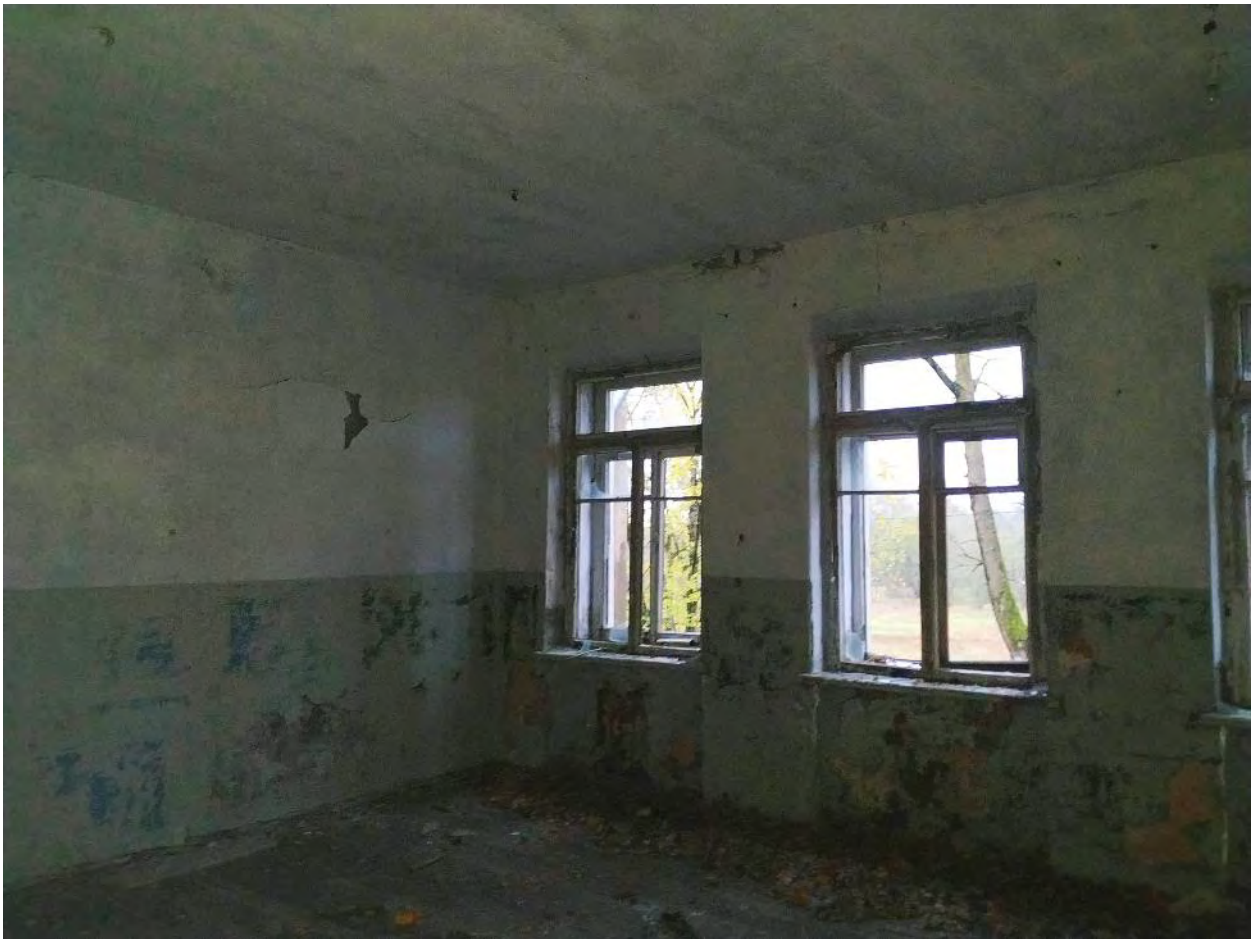
Фото 17. 06 Октября 2023г. Помещение второго этажа южного крыла.
