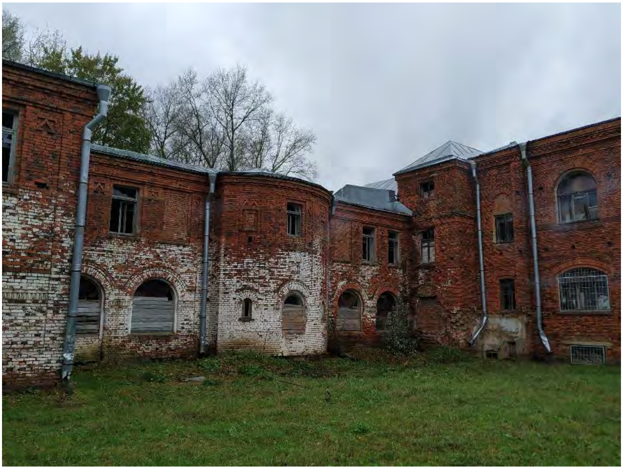
Фото 7. 06 Октября 2023г. Южное крыло, восточный фасад, общий вид.
