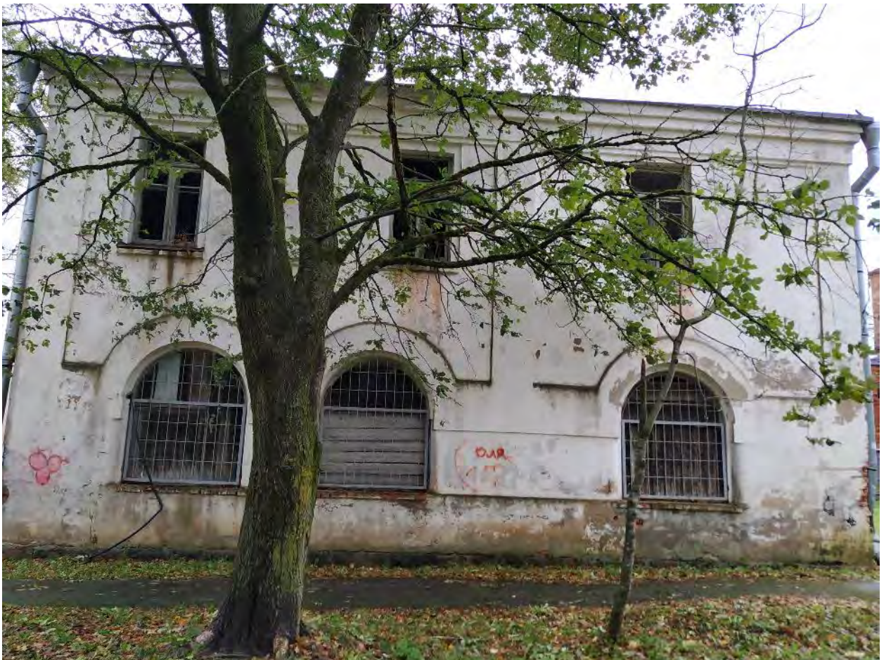
Фото 5. 06 Октября 2023г. Южное крыло, южный фасад, общий вид.
