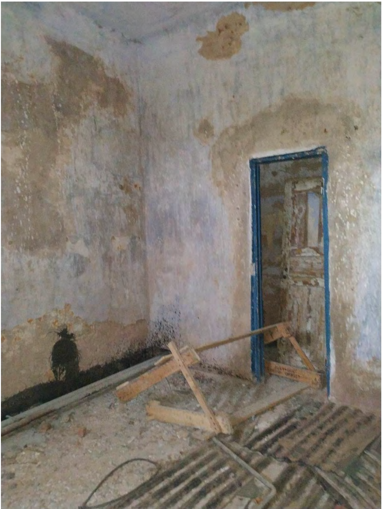
Фото 33. 06 Октября 2023г. Помещение второго этажа северного крыла.
