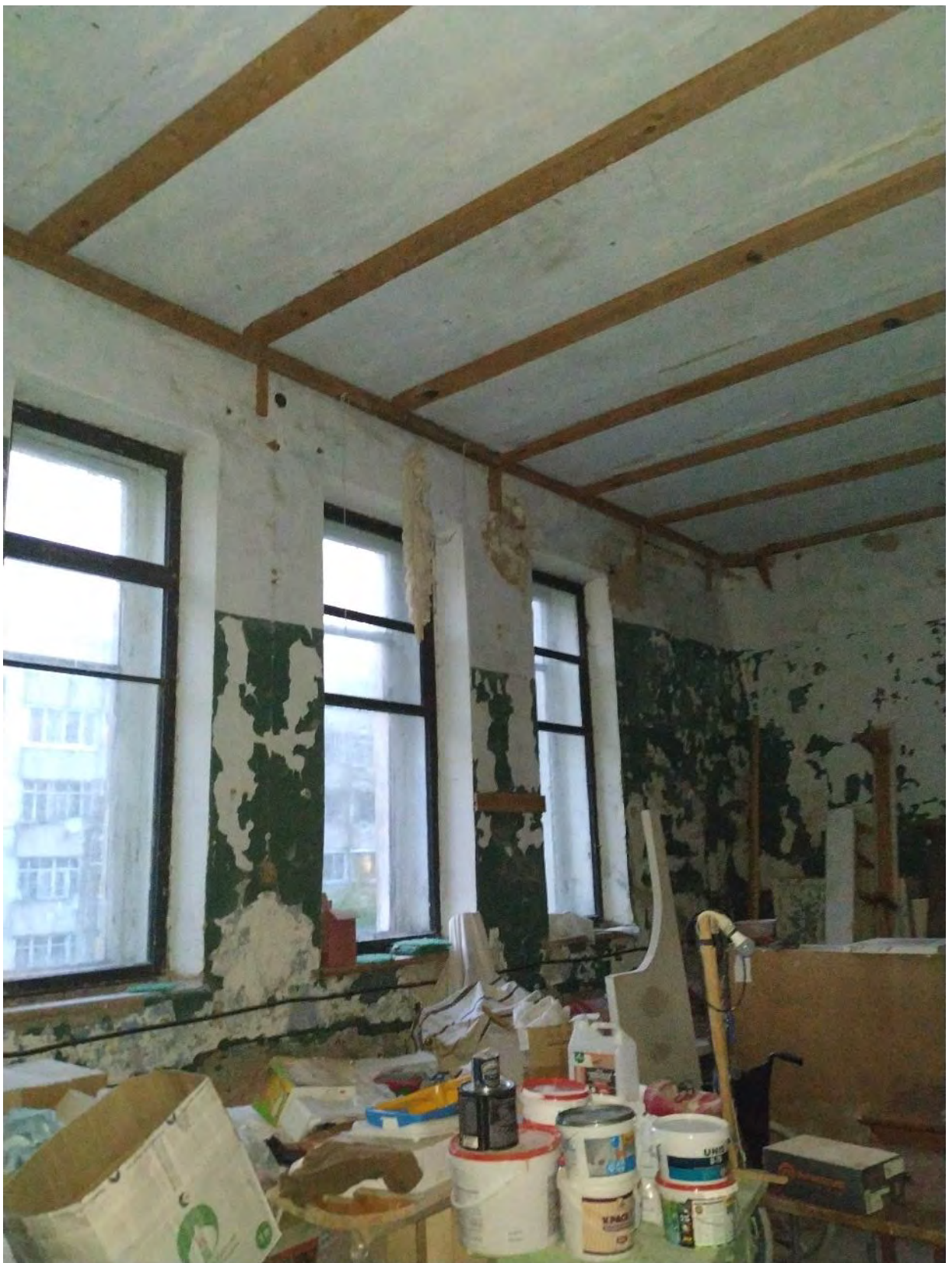
Фото 40. 06 Октября 2023г. Второй этаж, подсобные помещения над церковью.
