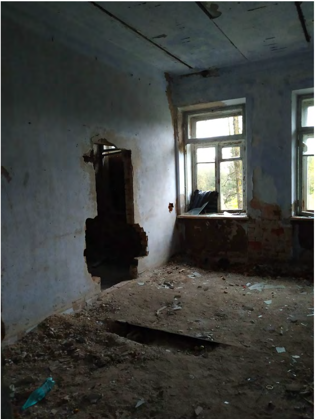
Фото 34. 06 Октября 2023г. Помещение второго этажа северного крыла.
