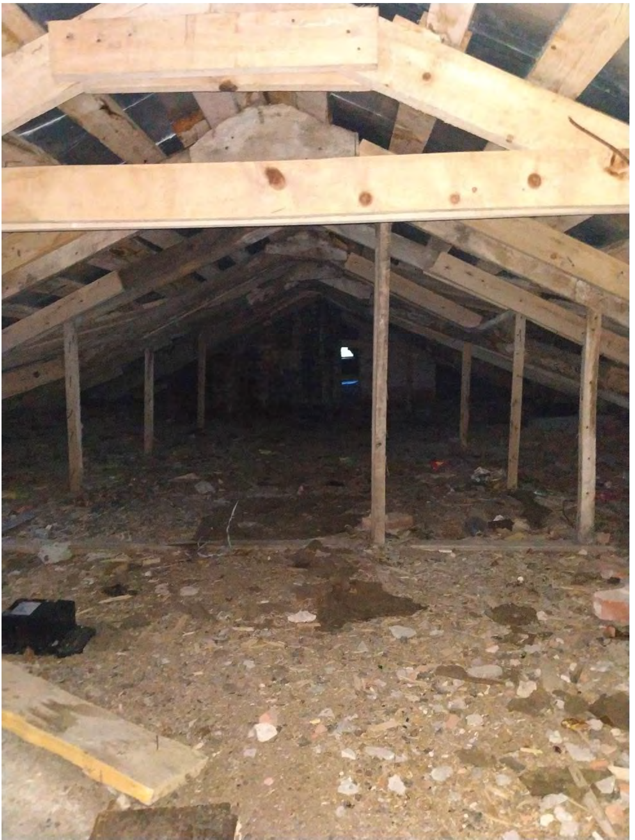
Фото 31.06 Октября 2023г. Стропильная система центрального филигеля.
