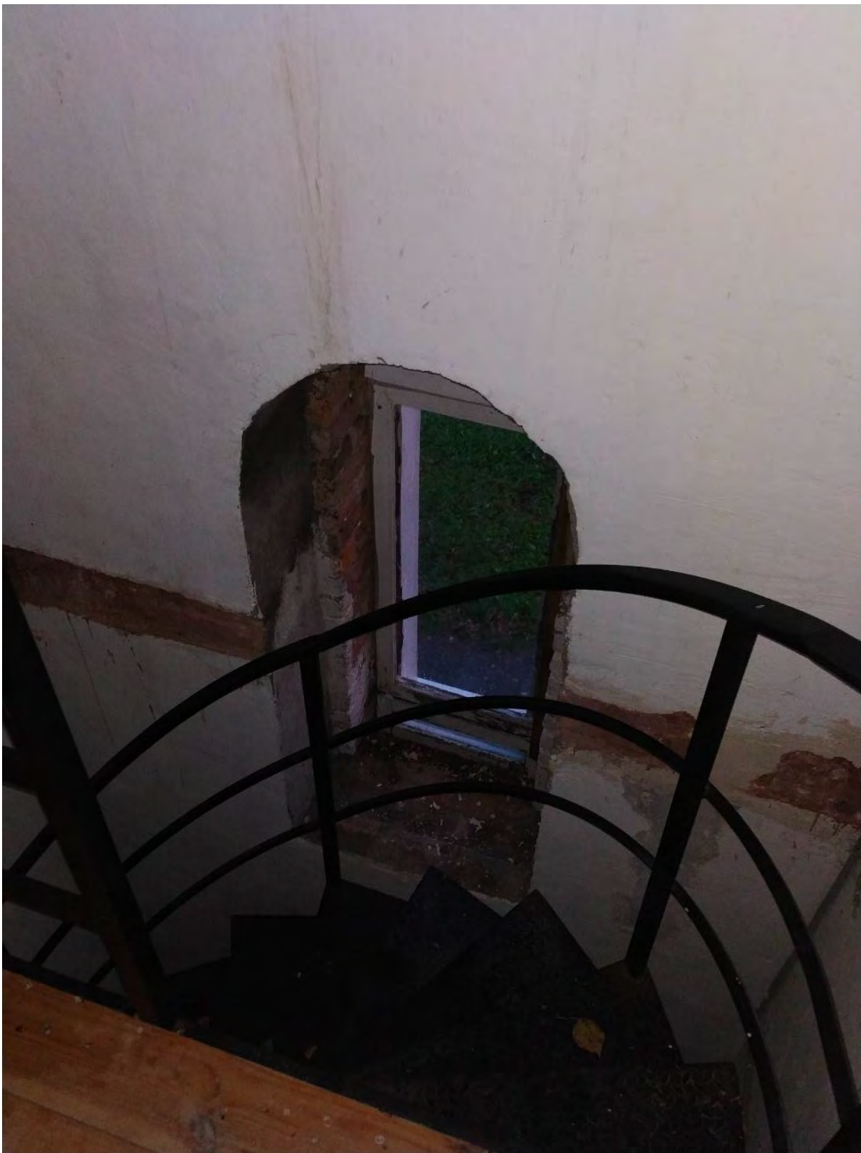
Фото 42. 06 Октября 2023г. Винтовая лестница на колокольню.
