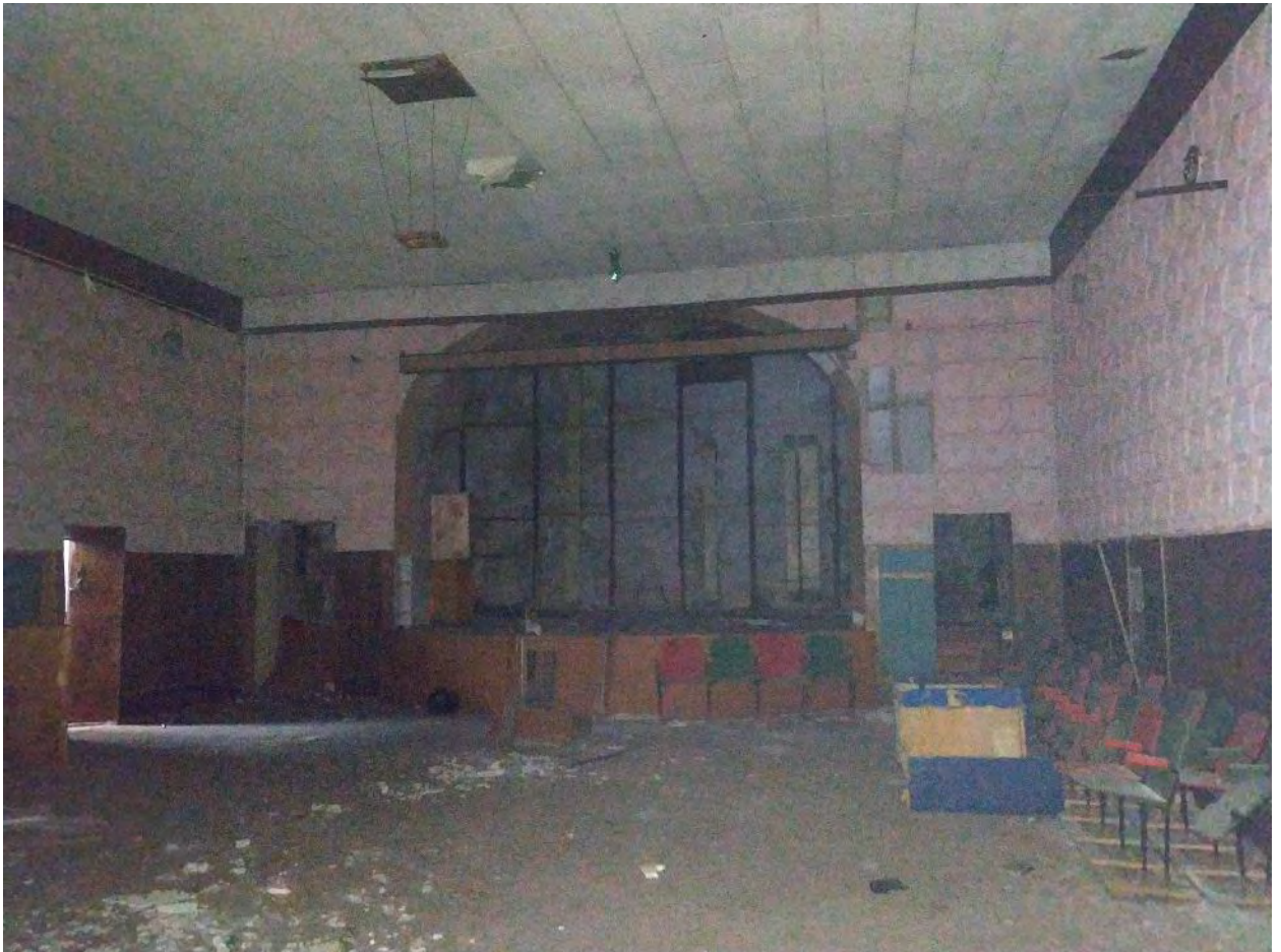
Фото 27. 06 Октября 2023г. Помещение актового зала второго этажа центрального флигеля.
