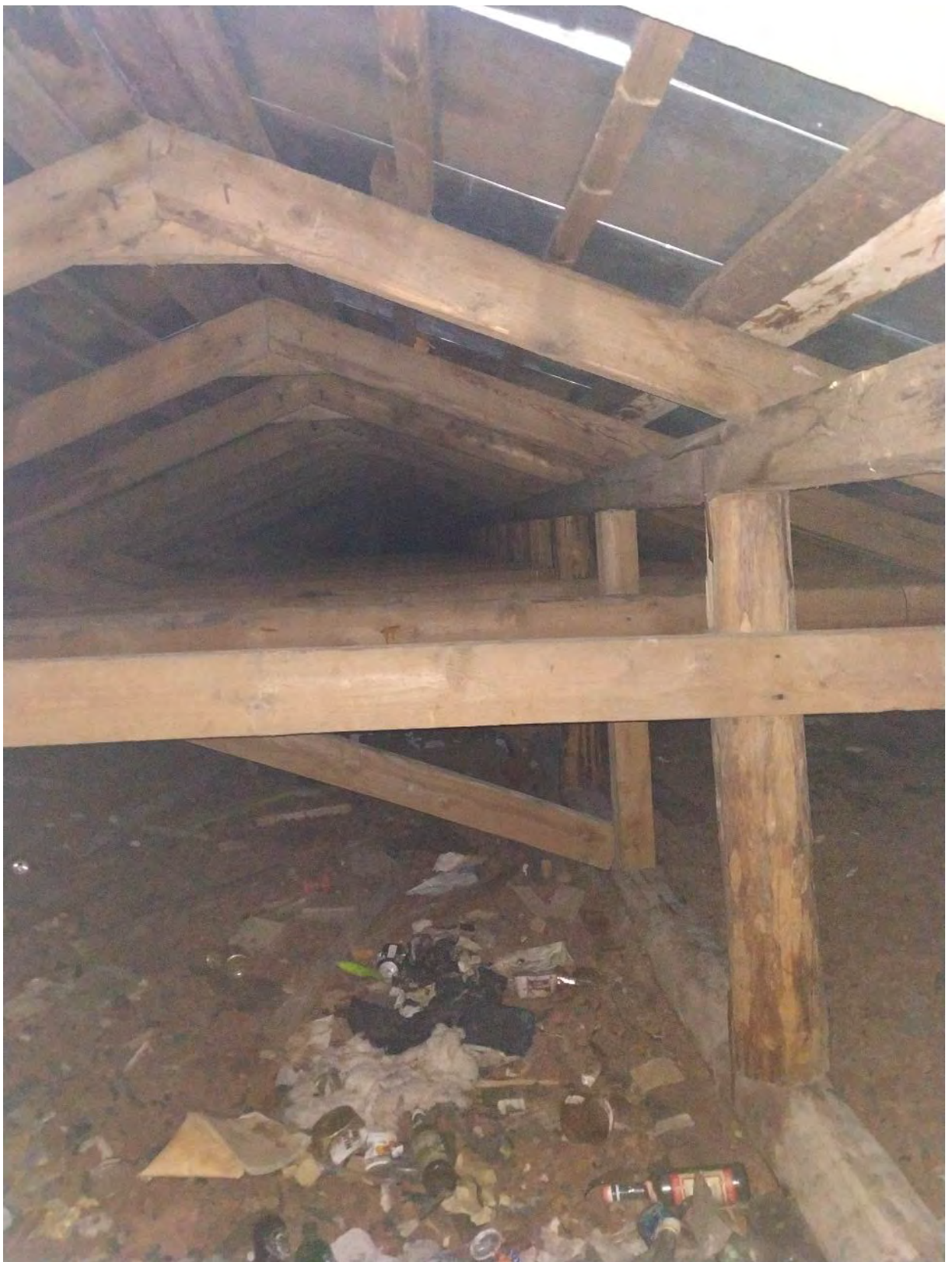
Фото 23. 06 Октября 2023г. Стропильная система южного крыла.
