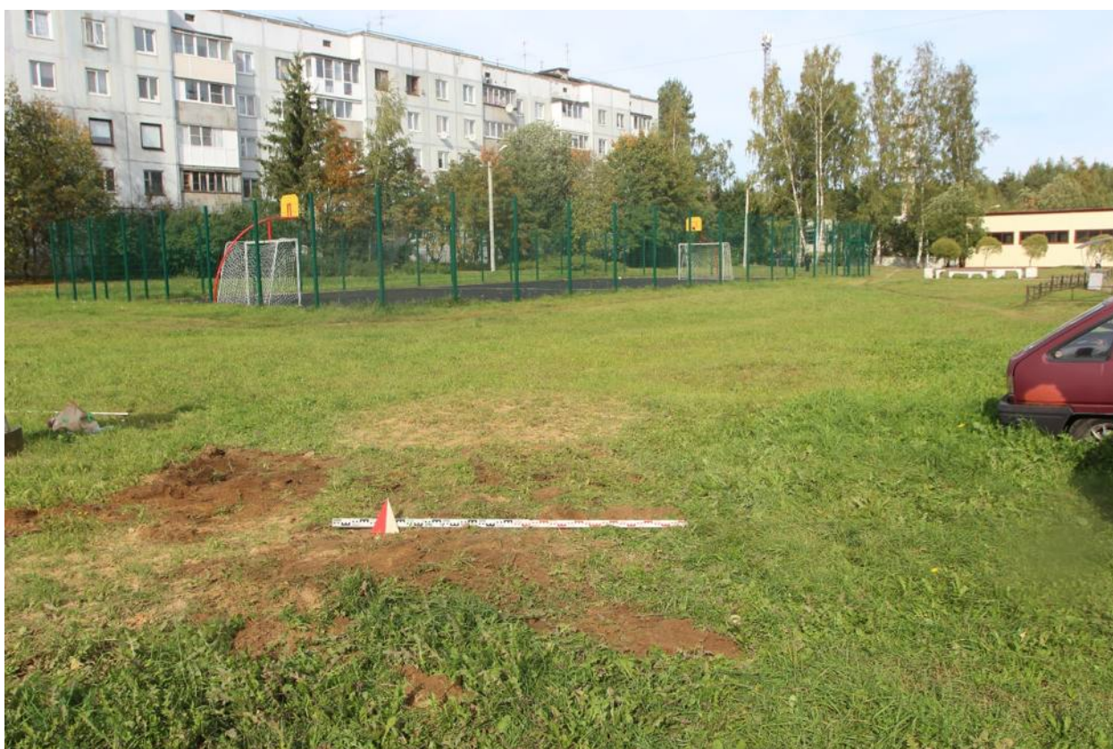
Рис. 67. Сертолово, территории ТЖ-4, ТСН-1-2023. Шурф 1 после рекультивации, вид на север.
