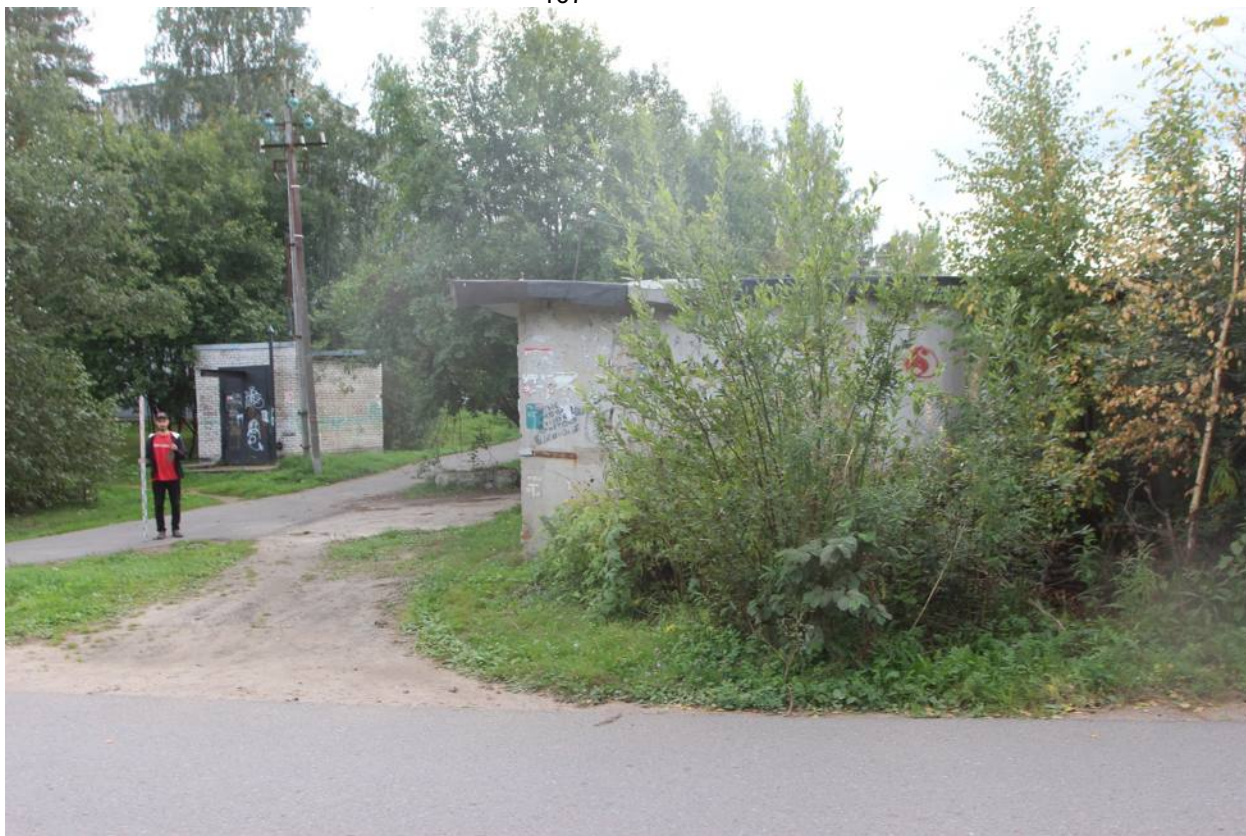
Рис. 28. Сердолово, территории ТЖ-4, ТСН-1-2023. Точка фотофиксации 5, вид на юг.
