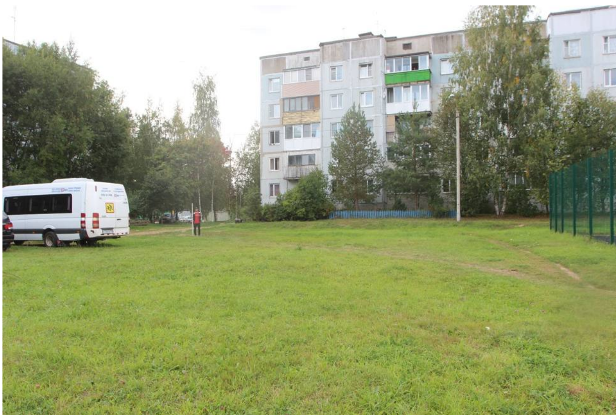
Рис. 23. Сертолово, территории ТЖ-4, ТСН-1-2023. Точка фотофиксации 4, вид на запад.
