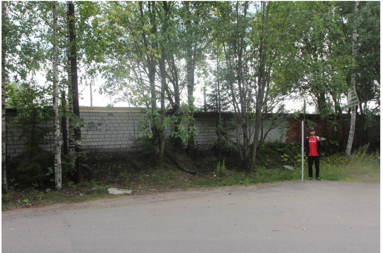
Рис. 34. Сертолово, территории ТЖ-4, ТСН-1-2023. Точка фотофиксации 6, вид на запад.
