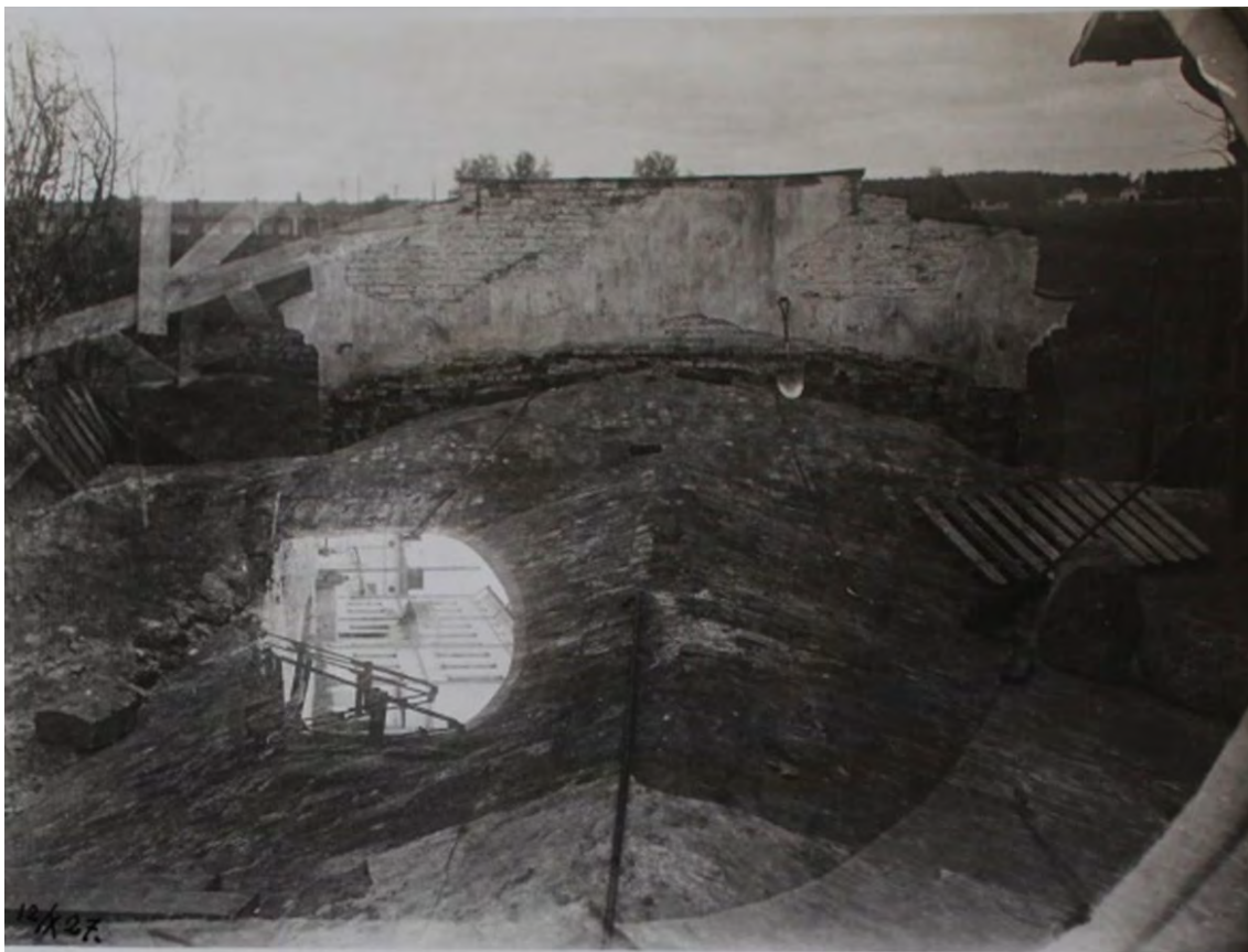
Илл. 31. Фото раскрытой кирпичной кладки свода при ремонтных работах 1928 г. Фото О.-И. Меурман. Национальный архив Финляндии (Миккели)
