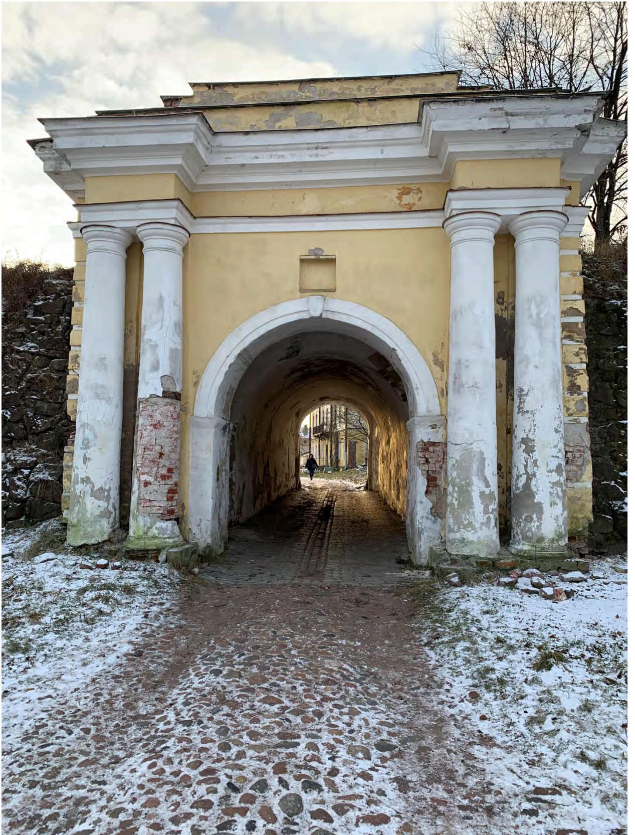
Фото 3. 20 ноября 2023 г. Ворота Фридрихсгамские 1-е. Северный фасад, общий вид
