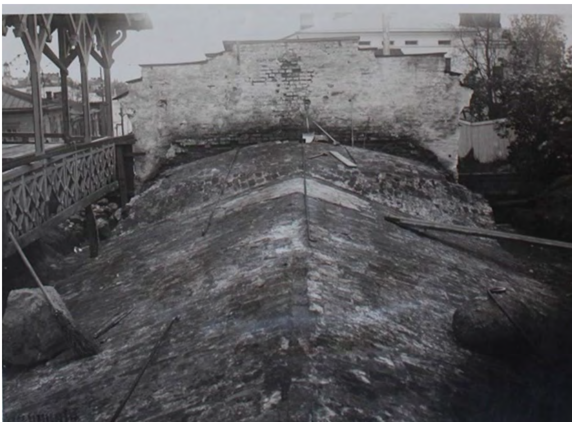
Илл. 32. Фото раскрытой кирпичной кладки свода при ремонтных работах 1928 г. Фото О.-И. Меурман. Национальный архив Финляндии (Миккели)
