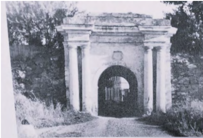
Фасад до реставрации
