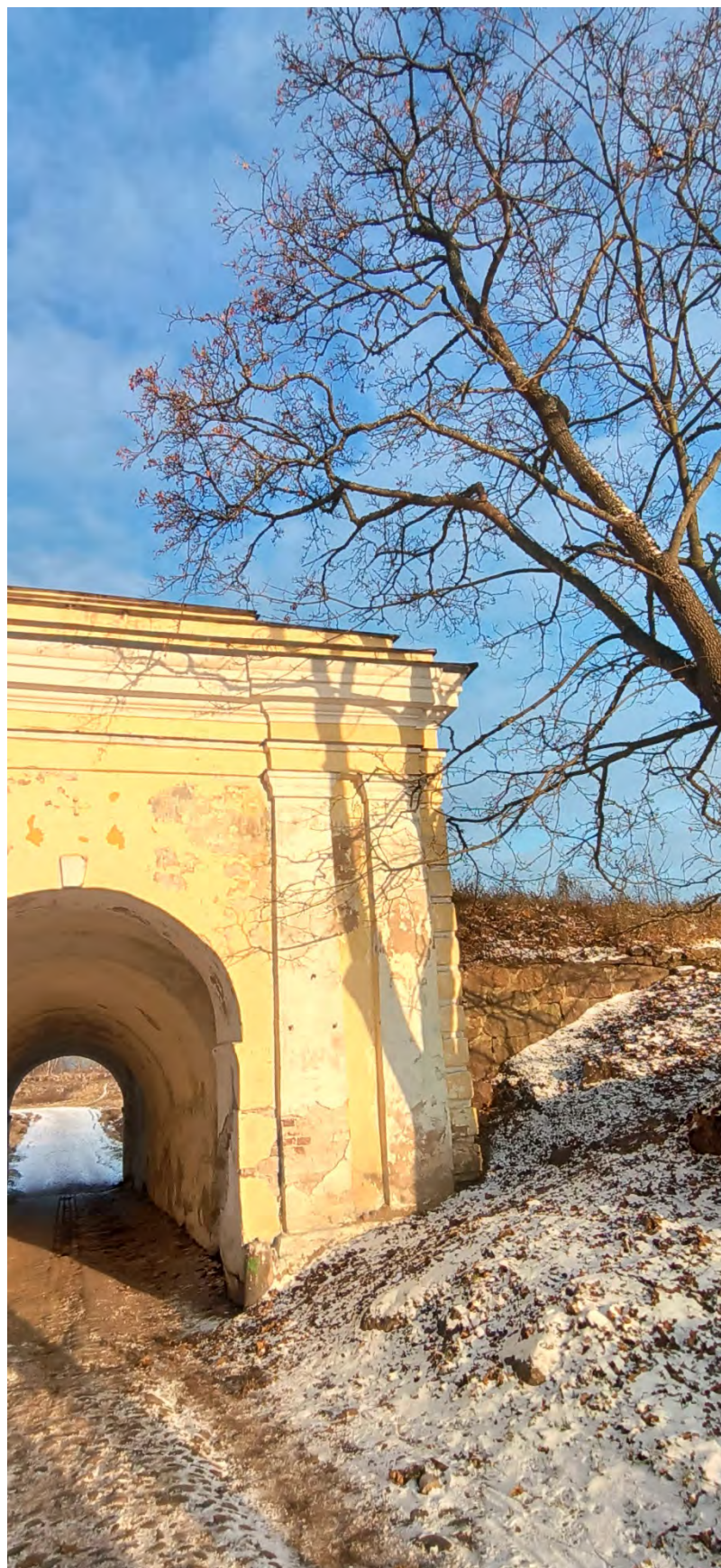
Фото 13. 20 ноября 2023 г. Ворота Фридрихсгамские 1-е. Южный фасад, фрагмент, восточная пара пилястр с антаблементом, примыкающая гранитная стенка куртины
