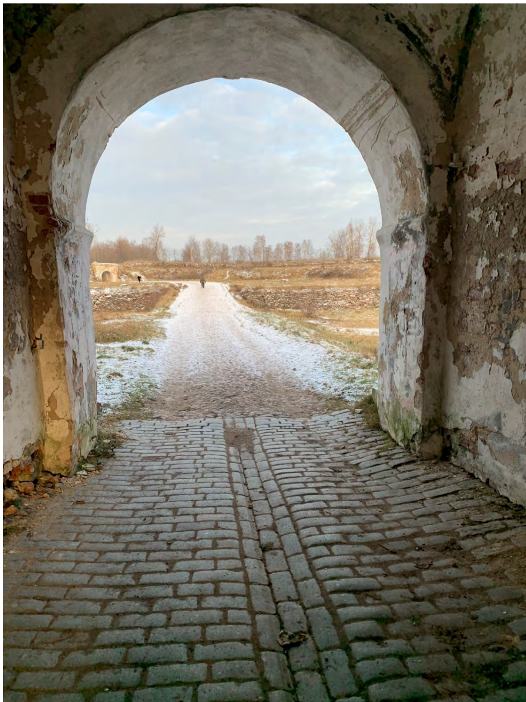
Фото 21. 20 ноября 2023 г. Ворота Фридрихсгамские 1-е. Вид на север, мощение из гранитной брусчатки с центральным лотком водоотвода
