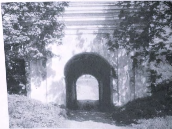
Фасад до реставрации
