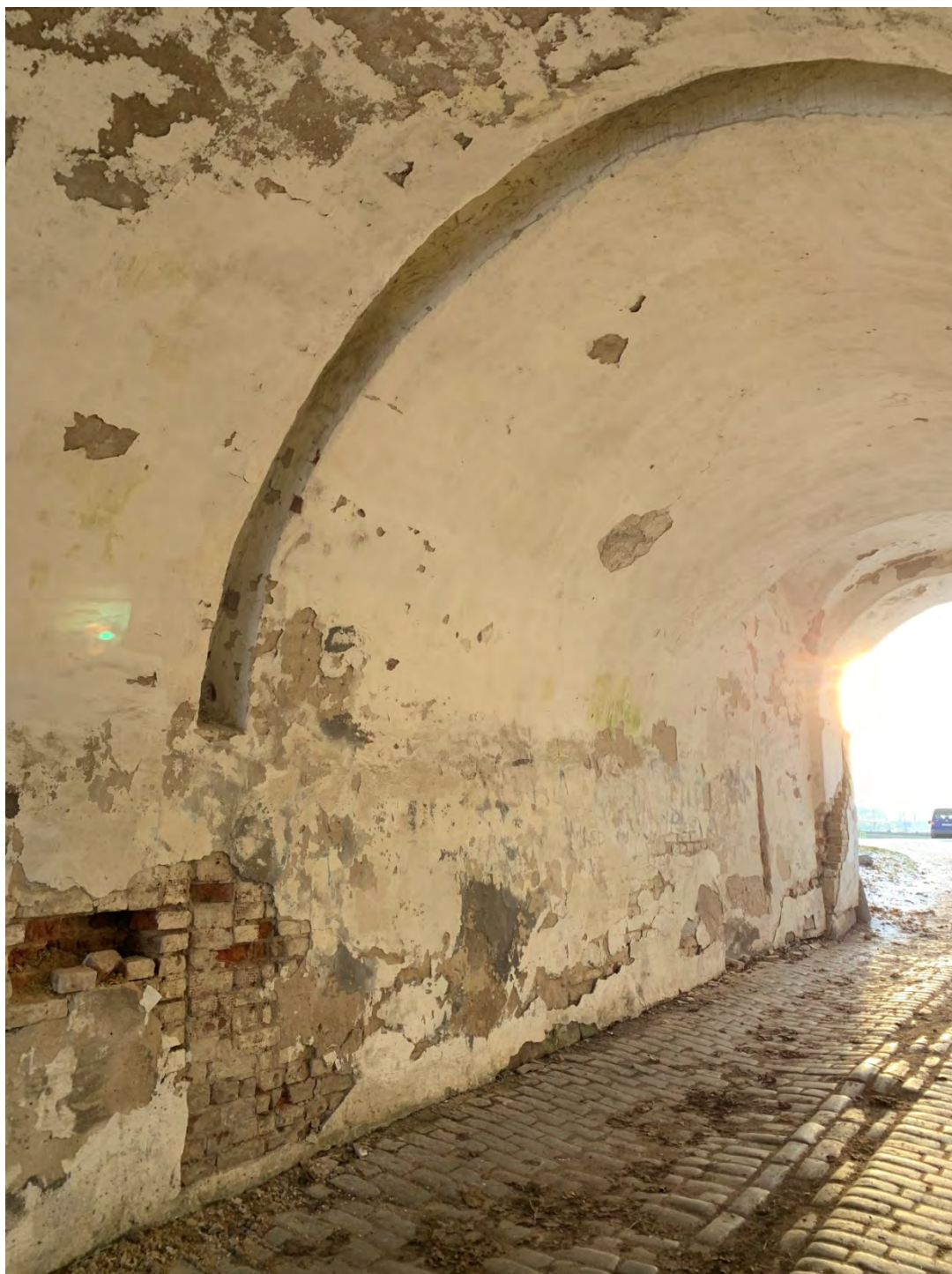
Фото 20. 20 ноября 2023 г. Ворота Фридрихсгамские 1-е. Отверстие для решетки-герсы (частично заложено)
