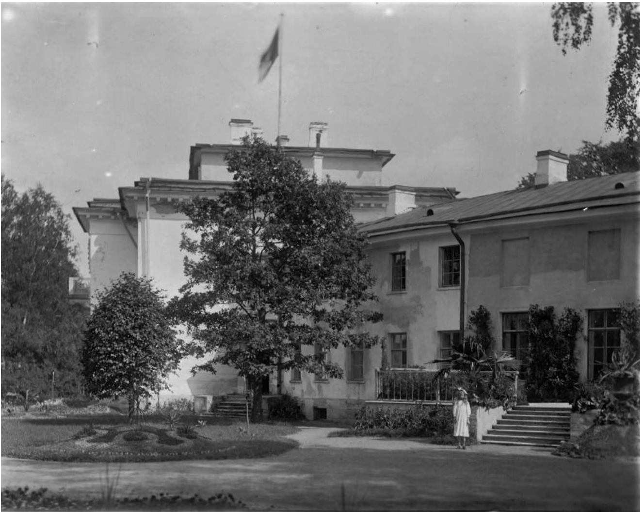
Илл. 23. Северный фасад, западный ризалит после пожара 1901-го года. 1910-1915 гг. (?). РГИА: Ф 927.Оп.І. Д. 1780 л. 1-4, Д 1781 л.1.
