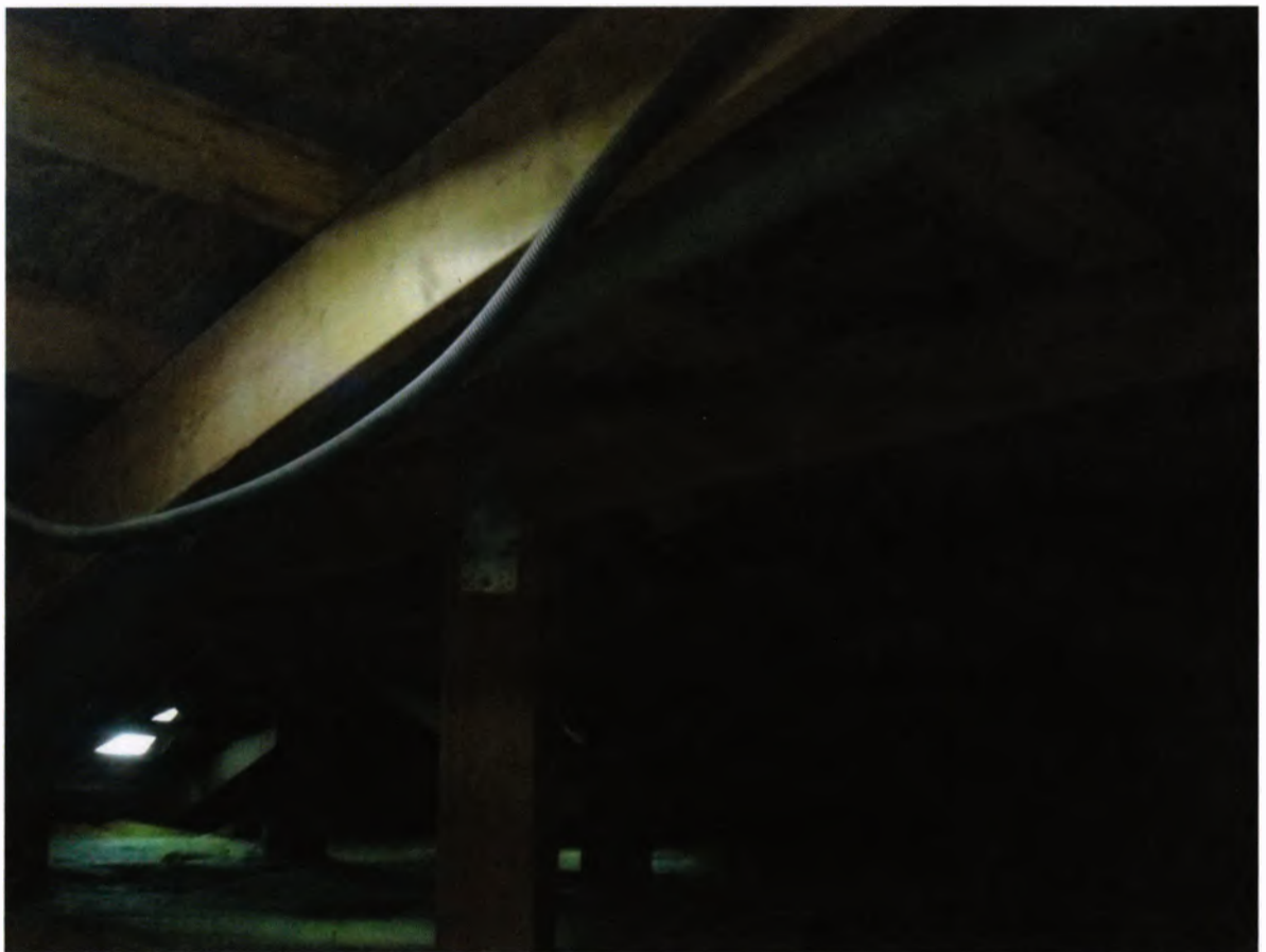
Фото 14. Вид на стропильную систему восточного крыла.
