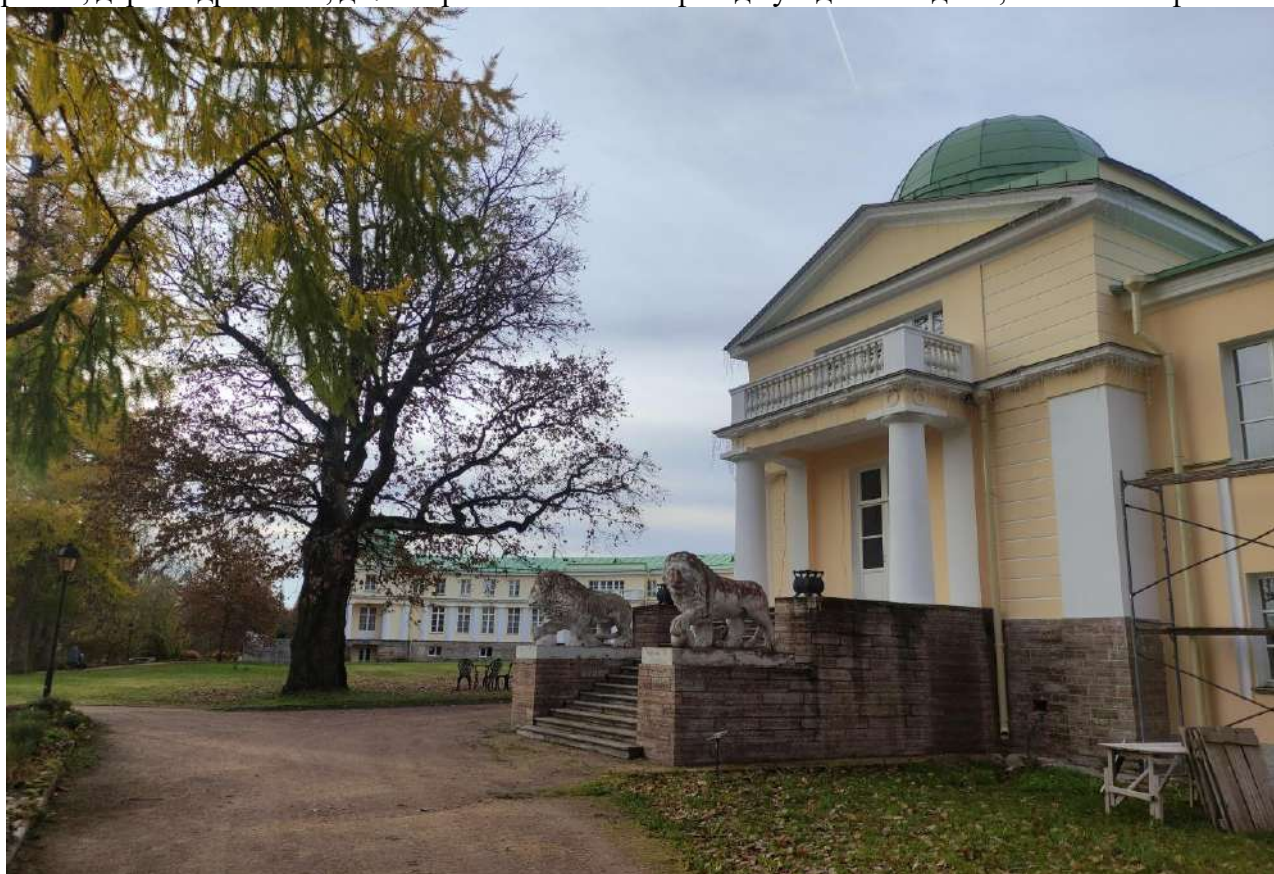
Фото 45. Объект культурного наследия федерального значения «Усадьба Строгановых (Марьино)», расположенный по адресу: Ленинградская область, Госненский муниципальный район, дер. Андрианово, д. 72. Фрагмент южного фасада усадебного дома. Восточное крыльцо.
