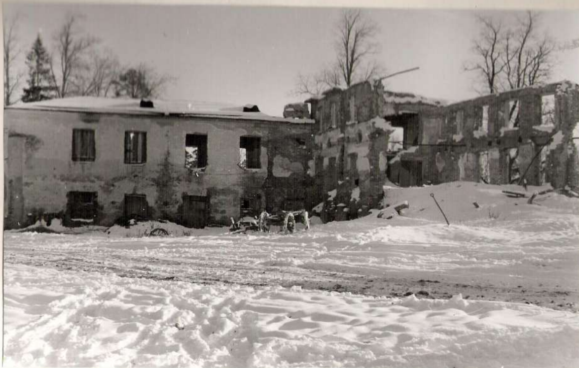
14. Разрушенное восточное крыло дома с флигелем
