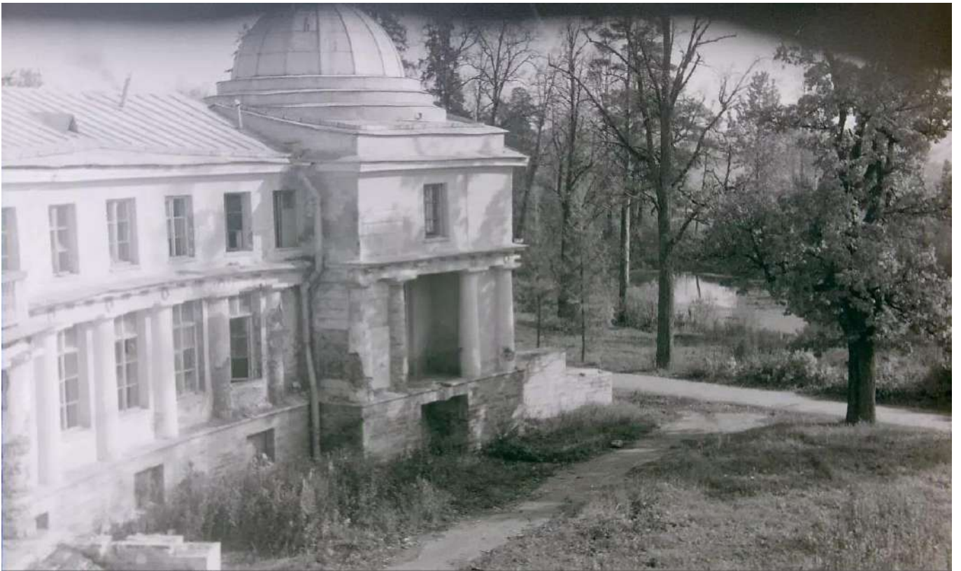
Илл. 45. Фото 1983 г. Фрагмент южного фасада. Интернет-ресурс https://pastvu.com/p/480136 .
