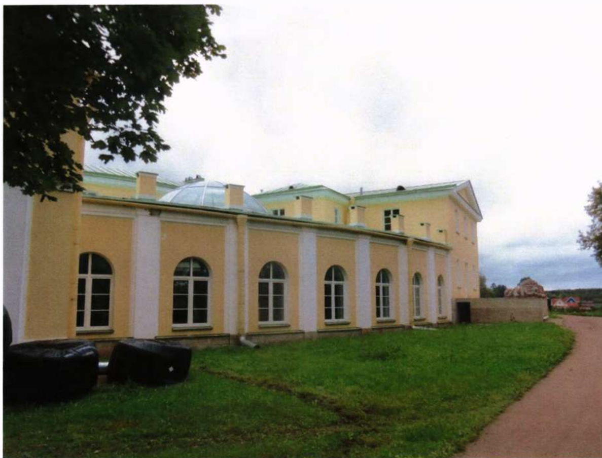
Фото 7. Вид на Усадебный дом с юго-востока. Дворовой фасад.
