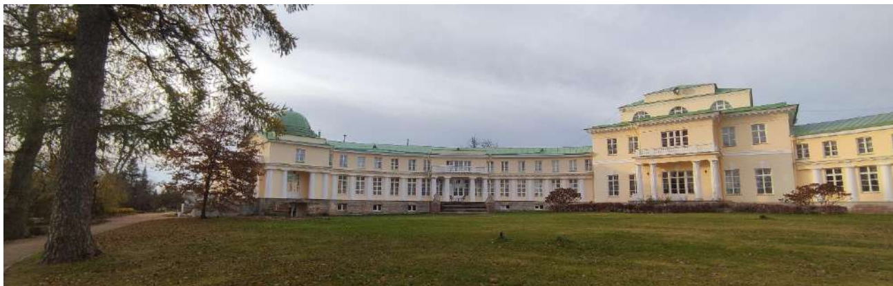
Фото 3. Объект культурного наследия федерального значения «Усадьба Строгановых (Марьино)», расположенный по адресу: Ленинградская область, Госненский муниципальный район, дер. Андрианово, д. 72. Фрагмент южного фасада усадебного дома, западная часть.
