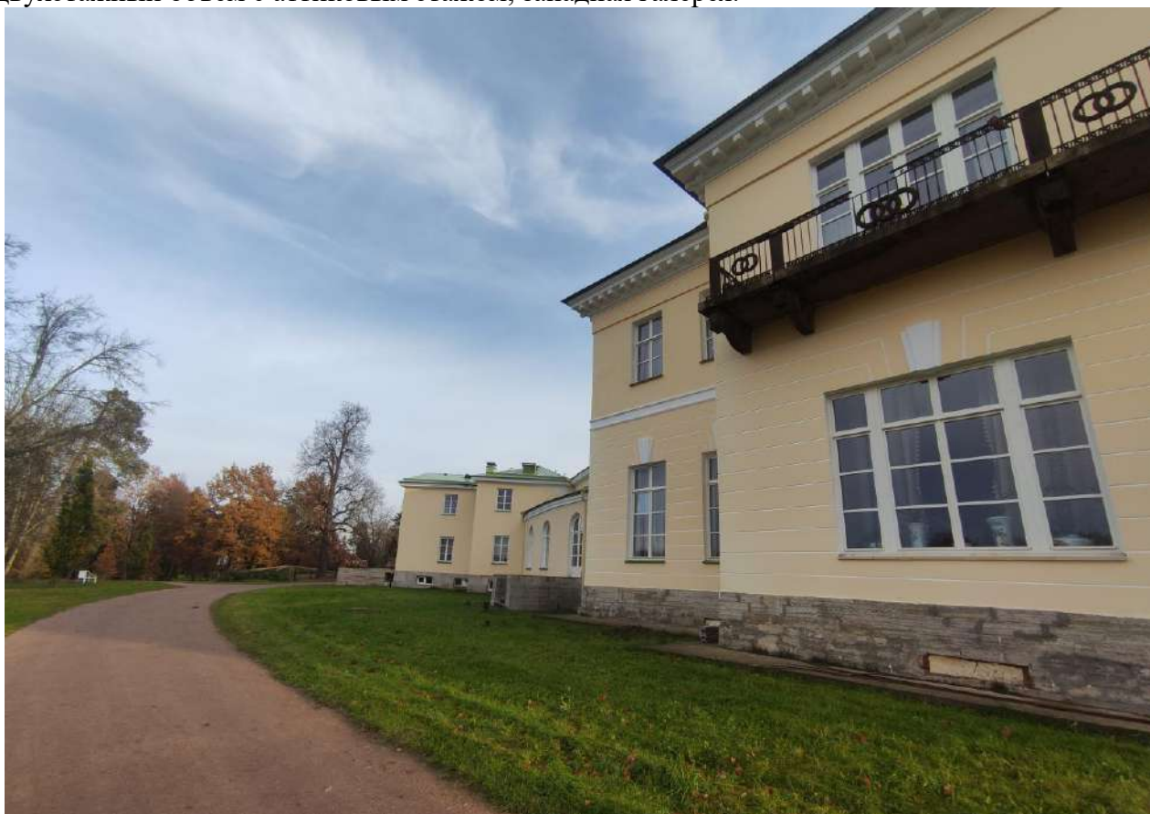
Фото 31. Объект культурного наследия федерального значения «Усадьба Строгановых (Марьино)», расположенный по адресу: Ленинградская область, Госненский муниципальный район, дер. Андрианово, д. 72. Фрагмент северного фасада усадебного дома. Воссозданный восточный ризалит, восточная галерея, центральный двухэтажный объем с аттиковым этажом.
