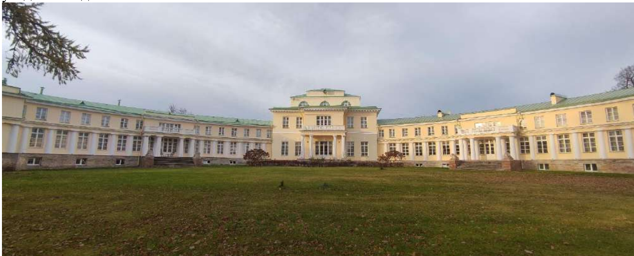
Фото 2. Объект культурного наследия федерального значения «Усадьба Строгановых (Марьино)», расположенный по адресу: Ленинградская область, Тосненский муниципальный район, дер. Андрианово, д. 72. Фрагмент южного фасада усадебного дома, центральная часть.
