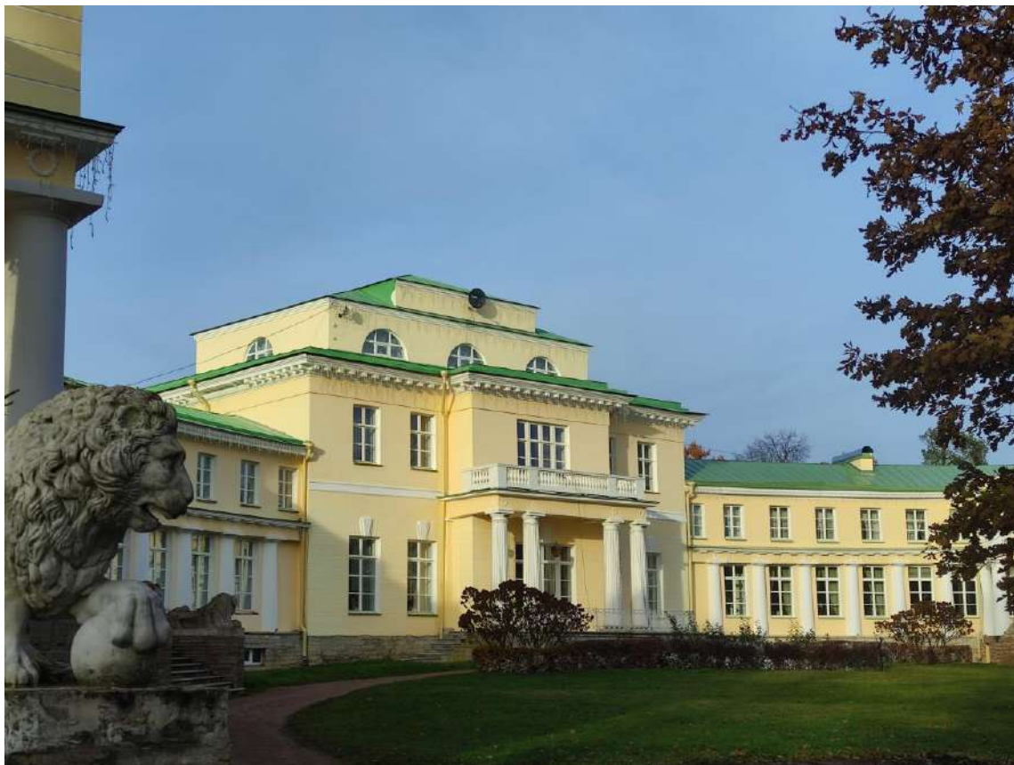
Фото 6. Объект культурного наследия федерального значения «Усадьба Строгановых (Марьино)», расположенный по адресу: Ленинградская область, Госненский муниципальный район, дер. Андрианово, д. 72. Фрагмент южного фасада усадебного дома, центральный двухэтажный объем с аттиковым этажом.
