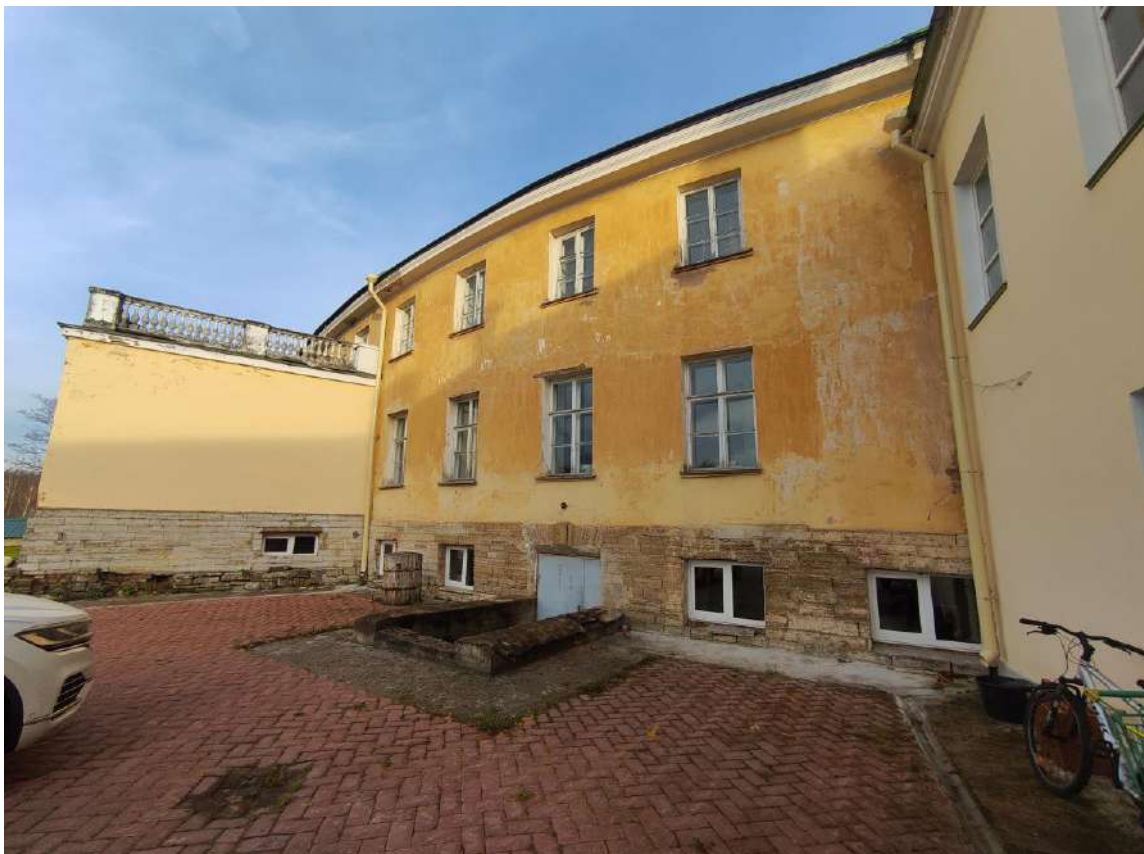
Фото 14. Объект культурного наследия федерального значения «Усадьба Строгановых (Марьино)», расположенный по адресу: Ленинградская область, Тосненский муниципальный район, дер. Андрианово, д. 72. Фрагмент северного фасада усадебного дома. Местоположение бывшего западного двора.
