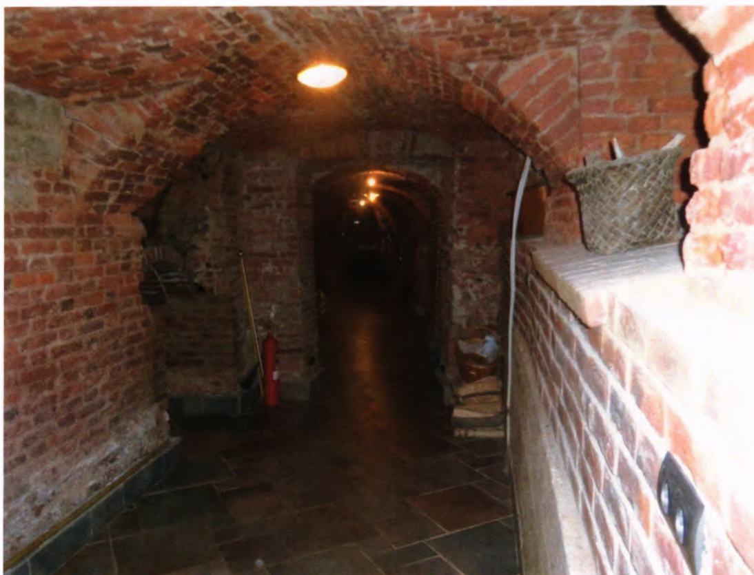
Фото 15. Подвалы. Исторические своды.
