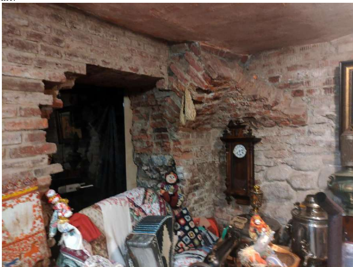
Фото 57. Объект культурного наследия федерального значения «Усадьба Строгановых (Марьино)», расположенный по адресу: Ленинградская область, Гостненский муниципальный район, дер. Андрианово, д. 72. Фрагмент помещения в отметке цокольного этажа. Западный ризалит.
