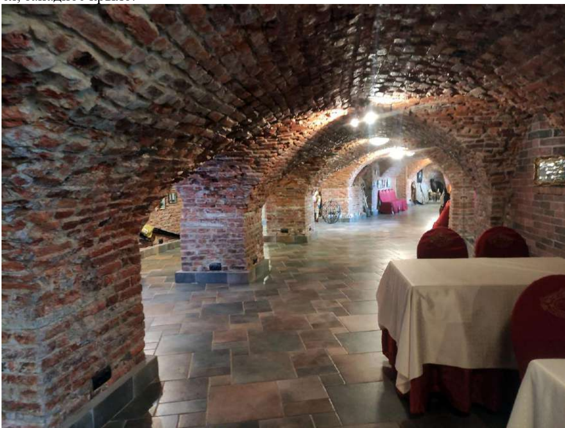
Фото 51. Объект культурного наследия федерального значения «Усадьба Строгановых (Марьино)», расположенный по адресу: Ленинградская область, Госненский муниципальный район, дер. Андрианово, д. 72. Фрагмент помещения в отметке цокольного этажа. Внутренняя галерея, западное крыло.
