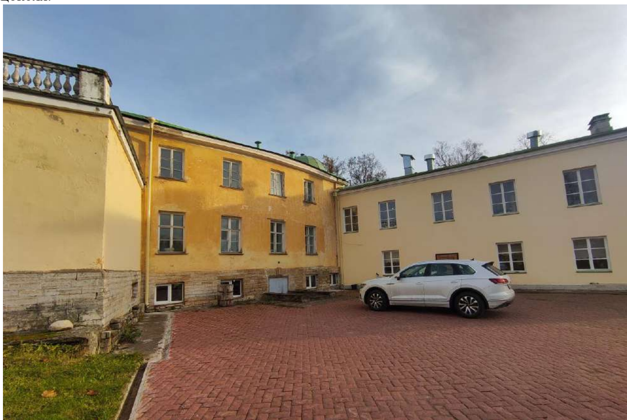
Фото 19. Объект культурного наследия федерального значения «Усадьба Строгановых (Марьино)», расположенный по адресу: Ленинградская область, Госненский муниципальный район, дер. Андрианово, д. 72. Фрагмент северного фасада усадебного дома. Западный ризалит, западный флигель. Местоположение бывшего западного двора.
