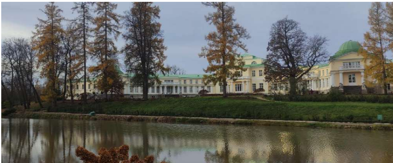
Фото 1. Объект культурного наследия федерального значения «Усадьба Строгановых (Марьино)», расположенный по адресу: Ленинградская область, Тосненский муниципальный район, дер. Андрианово, д. 72 1 . Парк усадьбы, усадебный дом. Общий вид южного фасада усадебного дома.
