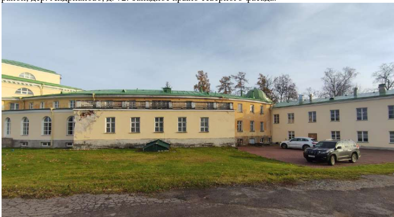
Фото 21. Объект культурного наследия федерального значения «Усадьба Строгановых (Марьино)», расположенный по адресу: Ленинградская область, Тосненский муниципальный район, дер. Андрианово, д. 72. Фрагмент северного фасада усадебного дома. Западное крыло северного фасада.
