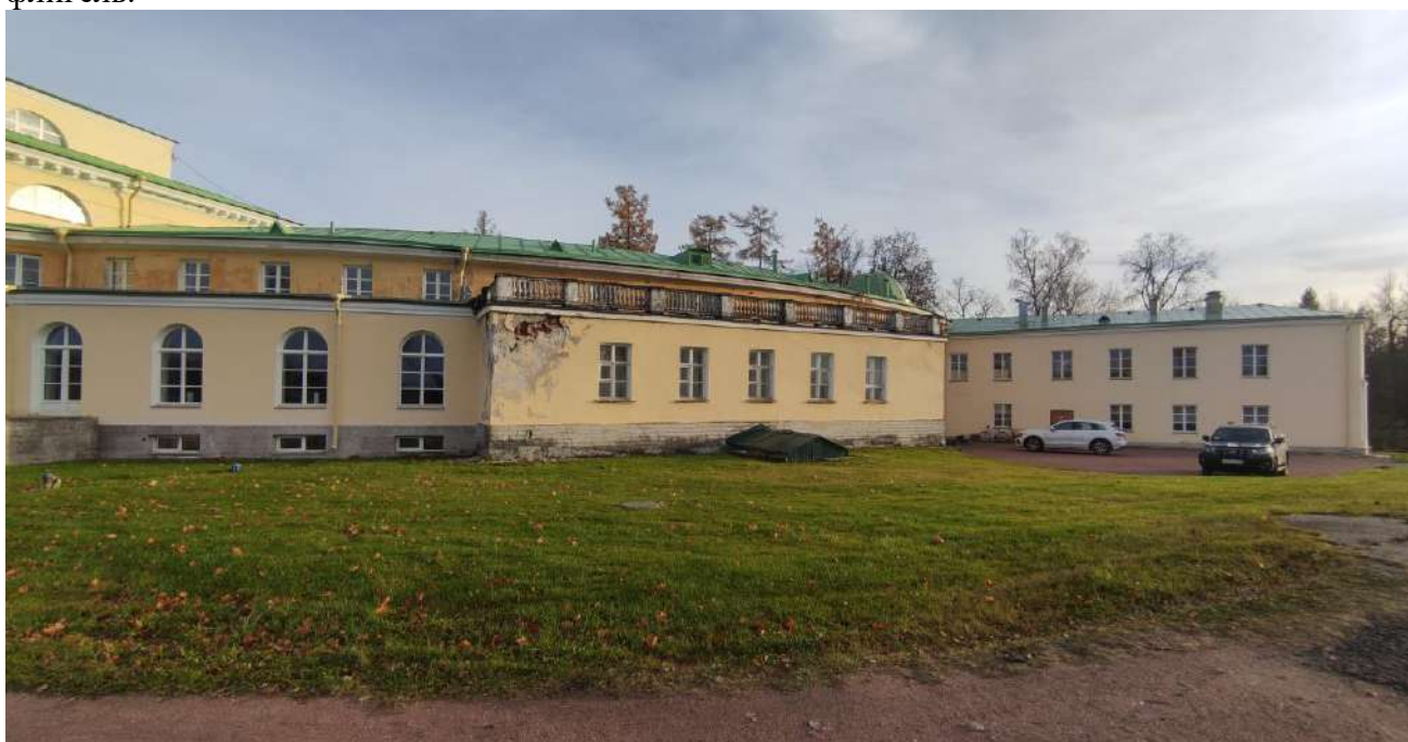
Фото 25. Объект культурного наследия федерального значения «Усадьба Строгановых (Марьино)», расположенный по адресу: Ленинградская область, Госненский муниципальный район, дер. Андрианово, д. 72. Фрагмент северного фасада усадебного дома. Западная галерея, западный ризалит, западный флигель. Вид с парковой дорожки.
