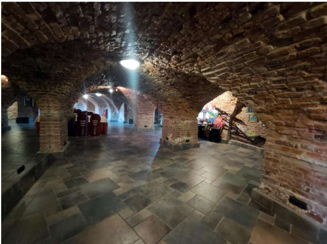
Фото 50. Объект культурного наследия федерального значения «Усадьба Строгановых (Марьино)», расположенный по адресу: Ленинградская область, Госненский муниципальный район, дер. Андрианово, д. 72. Фрагмент помещения в отметке цокольного этажа. Внутренняя галерея, западное крыло.
