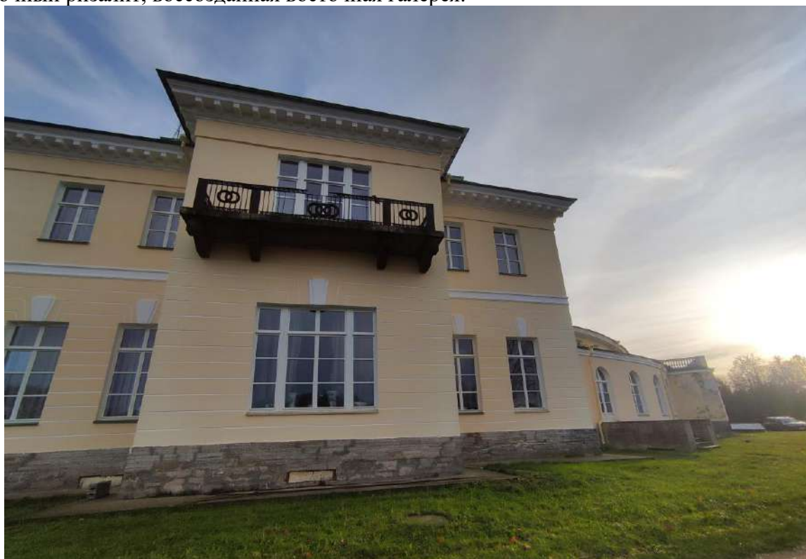
Фото 33. Объект культурного наследия федерального значения «Усадьба Строгановых (Марьино)», расположенный по адресу: Ленинградская область, Тосненский муниципальный район, дер. Андрианово, д. 72. Фрагмент северного фасада усадебного дома. Центральный двухэтажный объем с аттиковым этажом. Балкон в отметке второго этажа.
