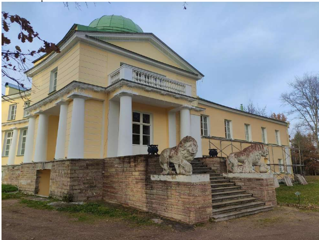
Фото 47. Объект культурного наследия федерального значения «Усадьба Строгановых (Марьино)», расположенный по адресу: Ленинградская область, Госненский муниципальный район, дер. Андрианово, д. 72. Фрагмент южного фасада усадебного дома. Восточное крыльцо, восточный флигель.
