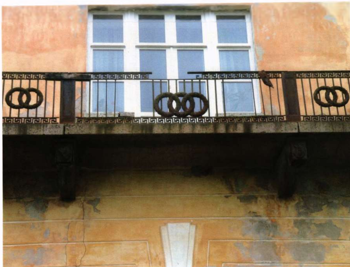
Фото 9. Вид на Усадебный дом. Дворовой фасад. Исторический балкон.
