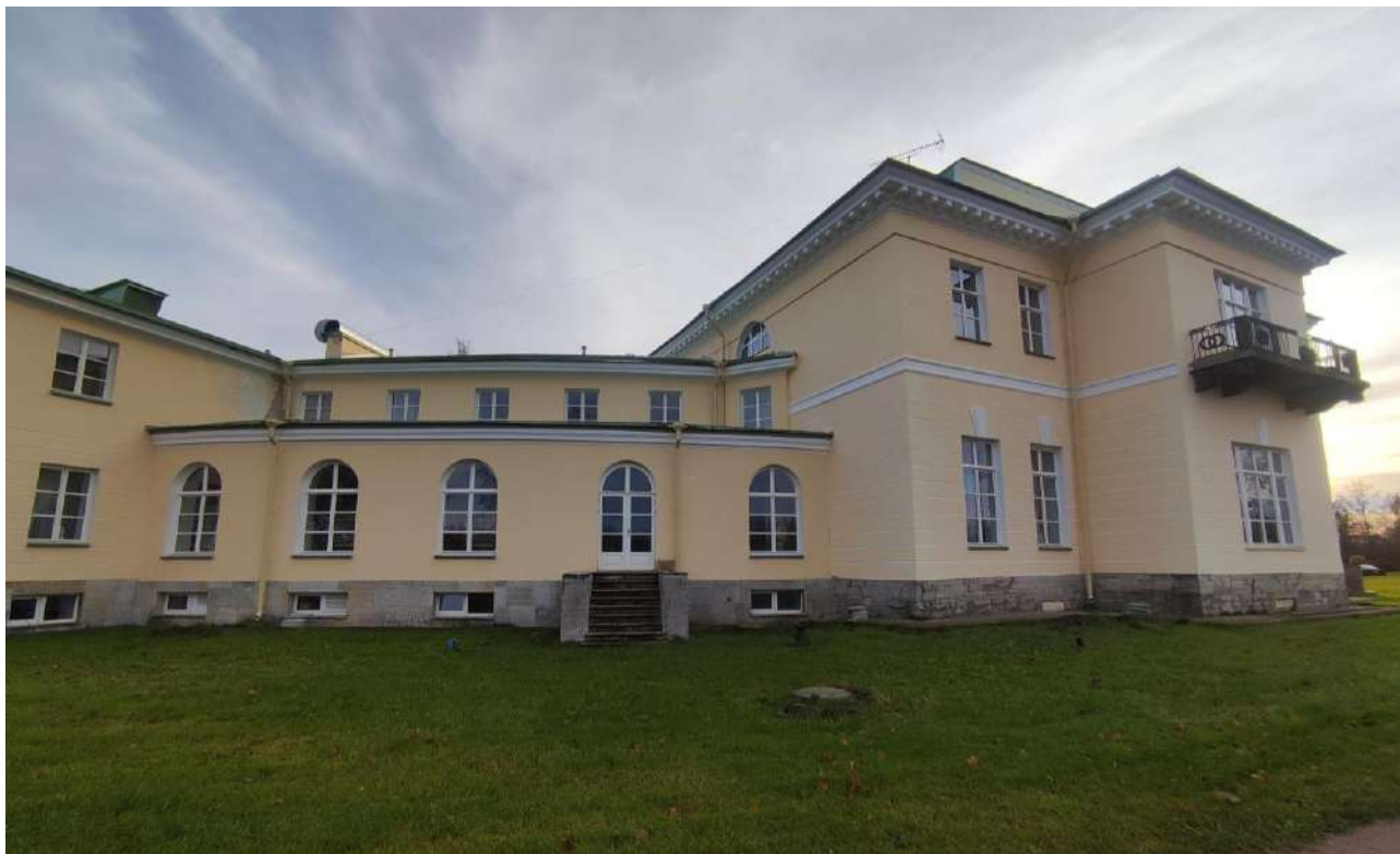
Фото 36. Объект культурного наследия федерального значения «Усадьба Строгановых (Марьино)», расположенный по адресу: Ленинградская область, Госненский муниципальный район, дер. Андрианово, д. 72. Фрагмент северного фасада усадебного дома. Воссозданная восточная галерея, центральный двухэтажный объем с аттиковым этажом.
