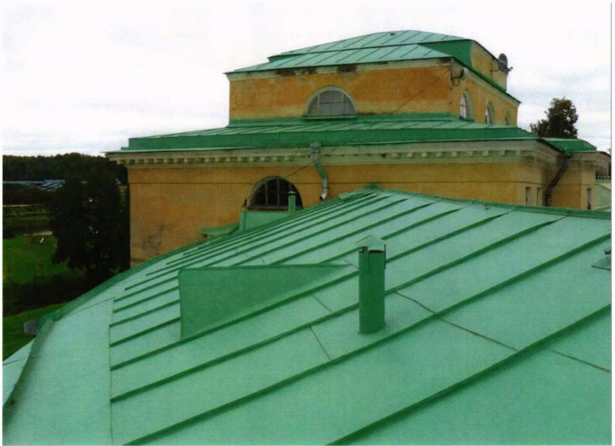
Фото 4. Вид на крышу усадьбы. Центральная часть.
