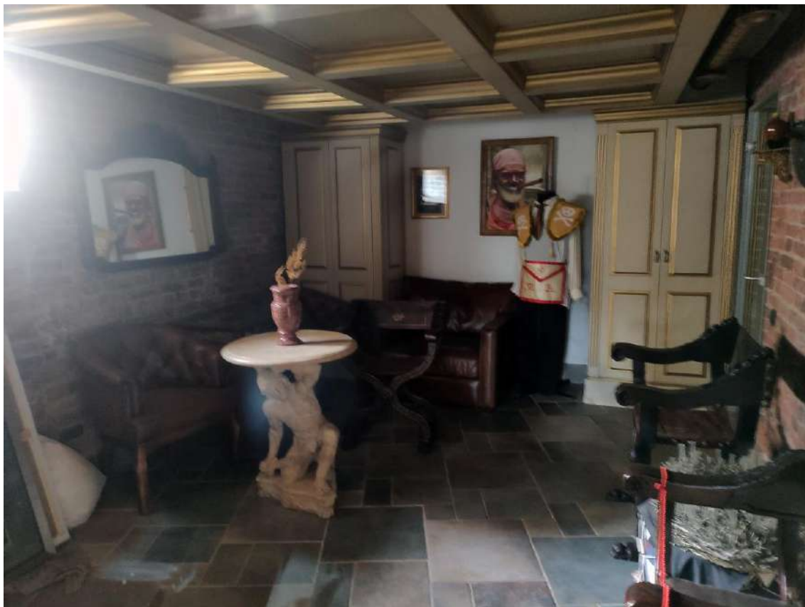
Фото 54. Объект культурного наследия федерального значения «Усадьба Строгановых (Марьино)», расположенный по адресу: Ленинградская область, Тосненский муниципальный район, дер. Андрианово, д. 72. Фрагмент помещения в отметке цокольного этажа. Западный ризалит.
