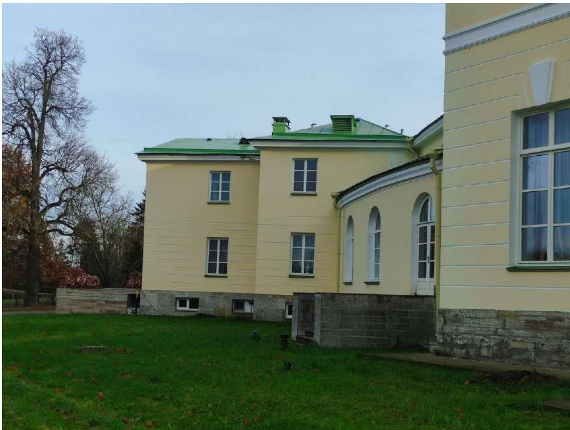
Фото 32. Объект культурного наследия федерального значения «Усадьба Строгановых (Марьино)», расположенный по адресу: Ленинградская область, Тосненский муниципальный район, дер. Андрианово, д. 72. Фрагмент северного фасада усадебного дома. Воссозданный восточный ризалит, воссозданная восточная галерея.
