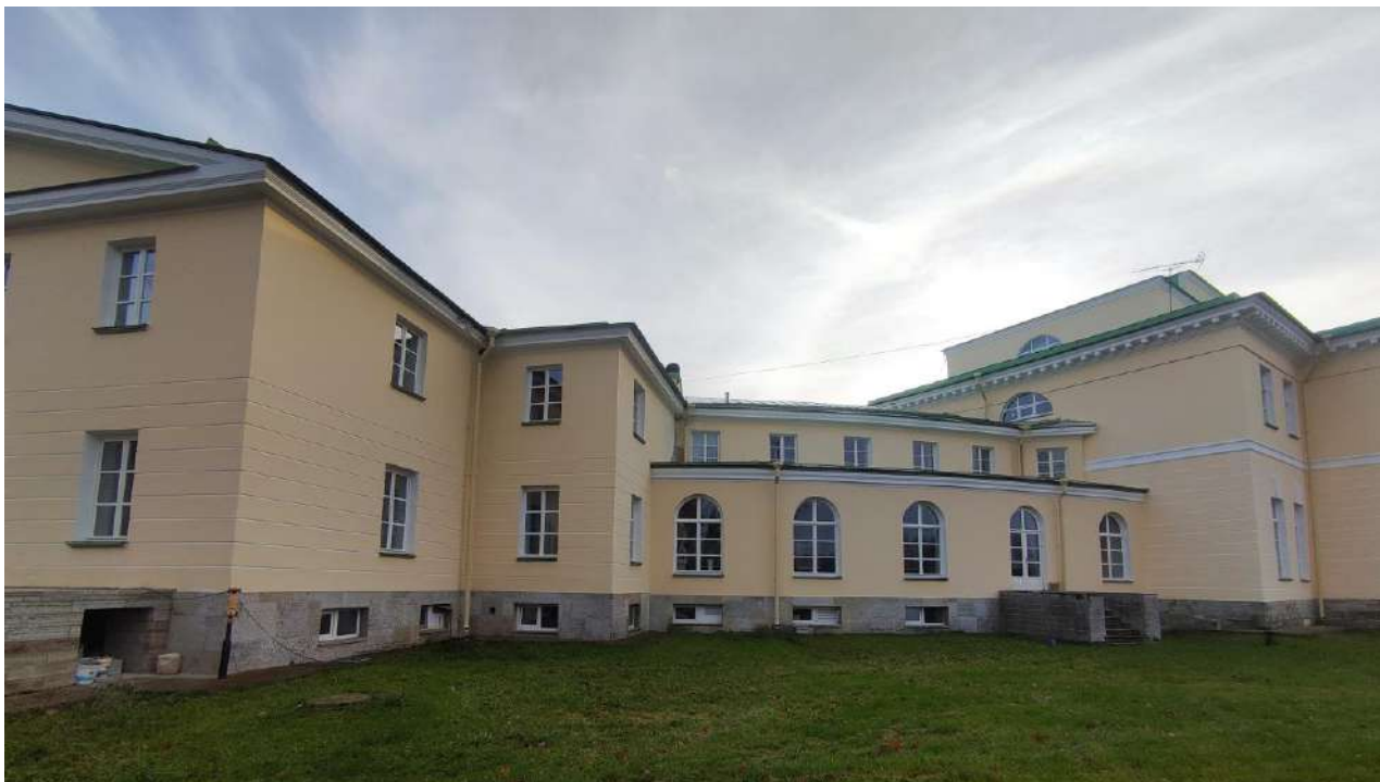
Фото 38. Объект культурного наследия федерального значения «Усадьба Строгановых (Марьино)», расположенный по адресу: Ленинградская область, Тосненский муниципальный район, дер. Андрианово, д. 72. Фрагмент северного фасада усадебного дома. Воссозданный восточный ризалит, воссозданная восточная галерея.
