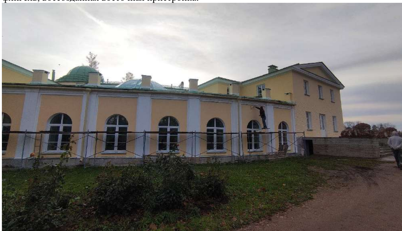
Фото 41. Объект культурного наследия федерального значения «Усадьба Строгановых (Марьино)», расположенный по адресу: Ленинградская область, Тосненский муниципальный район, дер. Андрианово, д. 72. Фрагмент северного фасада усадебного дома. Воссозданные восточная пристройка, восточный ризалит
