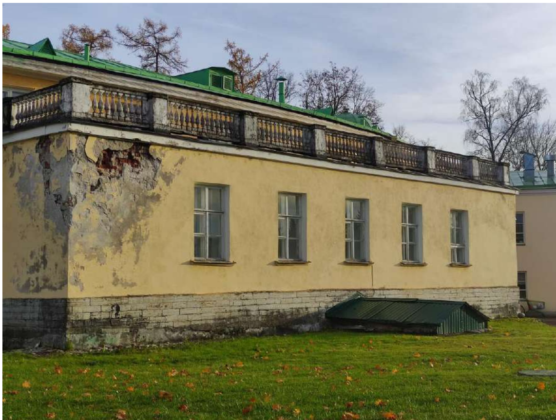
Фото 28. Объект культурного наследия федерального значения «Усадьба Строгановых (Марьино)», расположенный по адресу: Ленинградская область, Госненский муниципальный район, дер. Андрианово, д. 72. Фрагмент северного фасада усадебного дома. Фрагмент северного фасада усадебного дома. Разрушения штукатурного слоя и облицовки цоколя западного ризалита.
