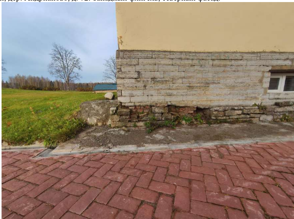
Фото 17. Объект культурного наследия федерального значения «Усадьба Строгановых (Марьино)», расположенный по адресу: Ленинградская область, Тосненский муниципальный район, дер. Андрианово, д. 72. Западный ризалит северного фасада. Фрагмент облицовки цоколя.
