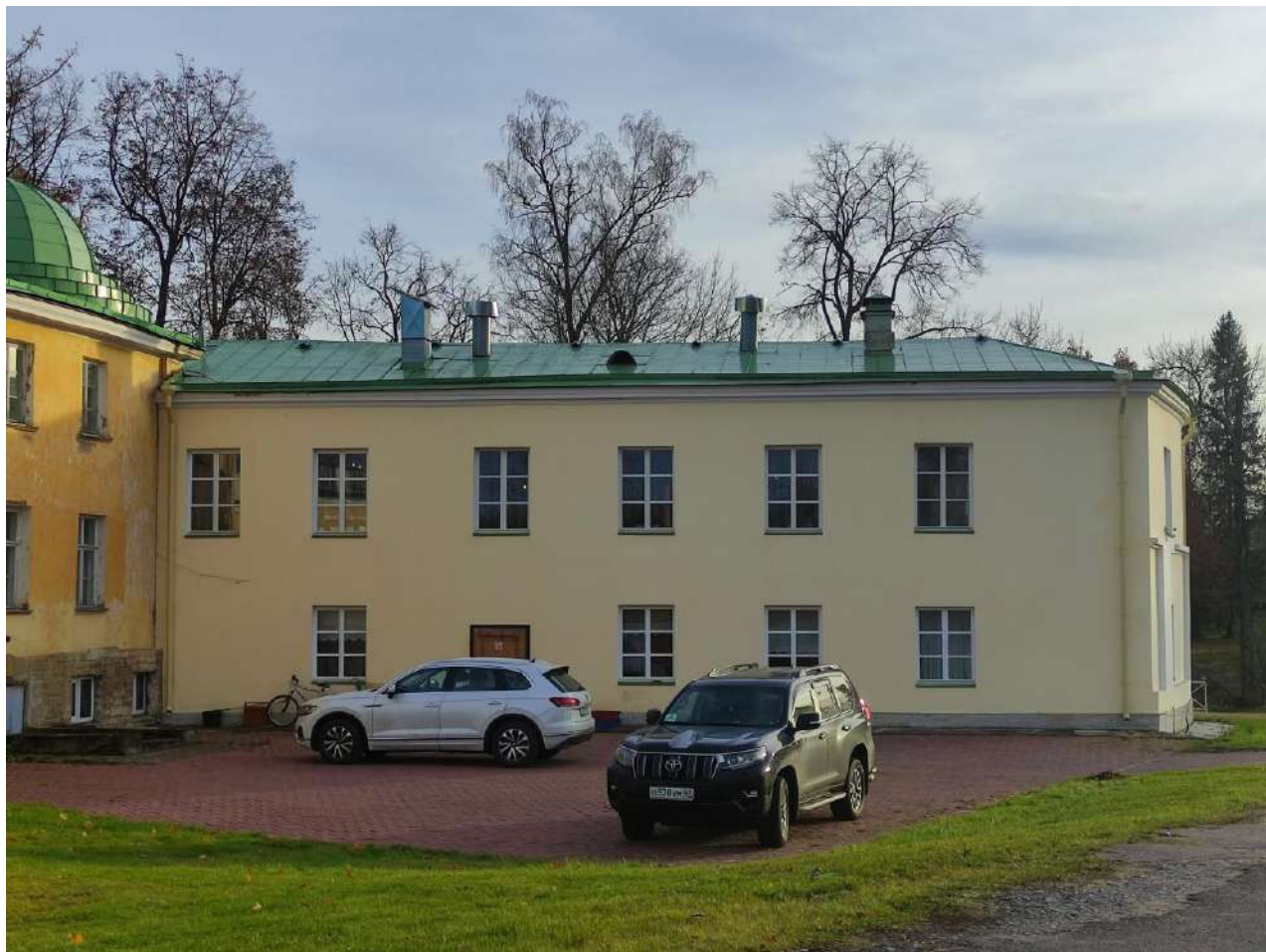
Фото 24. Объект культурного наследия федерального значения «Усадьба Строгановых (Марьино)», расположенный по адресу: Ленинградская область, Госненский муниципальный район, дер. Андрианово, д. 72. Фрагмент северного фасада усадебного дома. Западный флигель.
