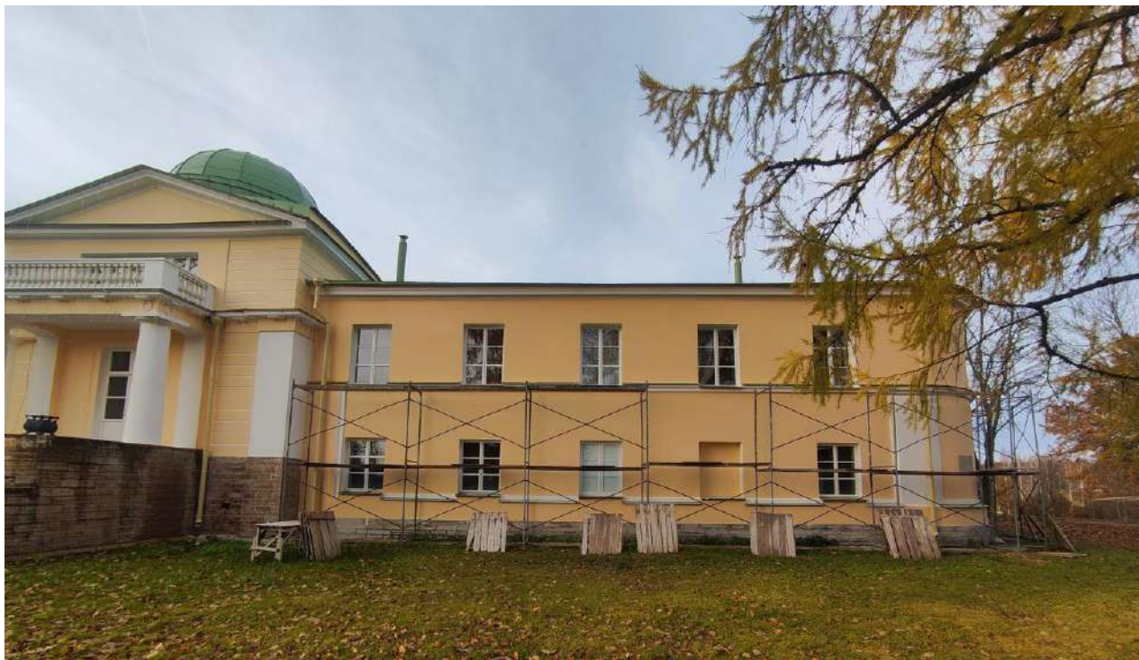
Фото 46. Объект культурного наследия федерального значения «Усадьба Строгановых (Марьино)», расположенный по адресу: Ленинградская область, Госненский муниципальный район, дер. Андрианово, д. 72. Фрагмент южного фасада усадебного дома. Восточное крыльцо, восточный флигель.
