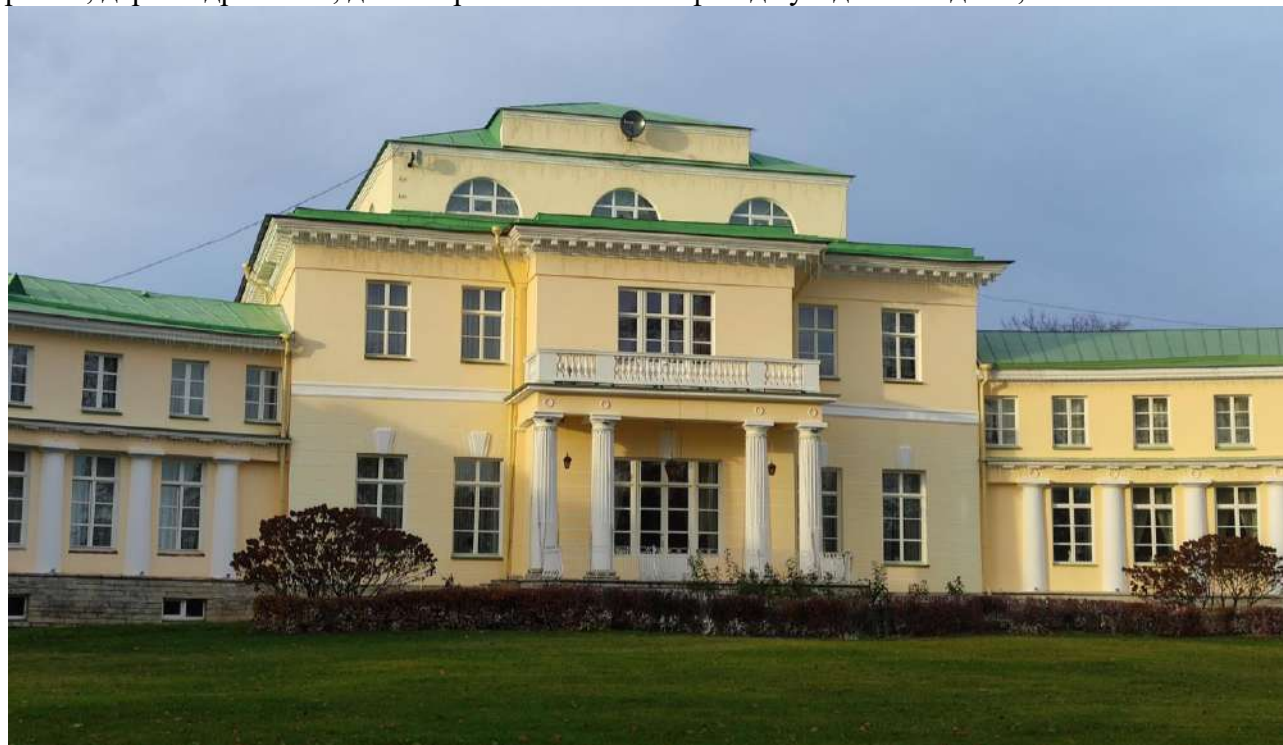
Фото 5. Объект культурного наследия федерального значения «Усадьба Строгановых (Марьино)», расположенный по адресу: Ленинградская область, Госненский муниципальный район, дер. Андрианово, д. 72. Фрагмент южного фасада усадебного дома, центральный двухэтажный объем с аттиковым этажом.
