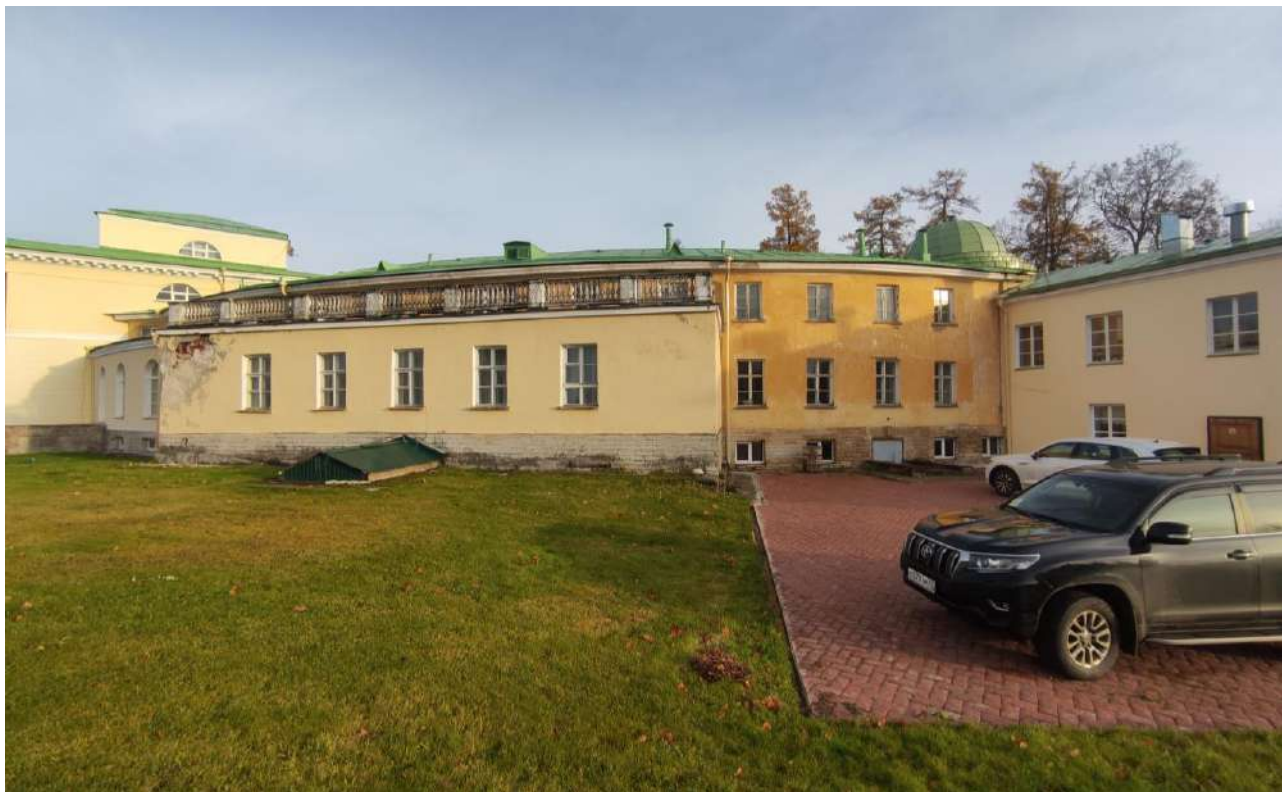
Фото 20. Объект культурного наследия федерального значения «Усадьба Строгановых (Марьино)», расположенный по адресу: Ленинградская область, Тосненский муниципальный район, дер. Андрианово, д. 72. Западное крыло северного фасада.
