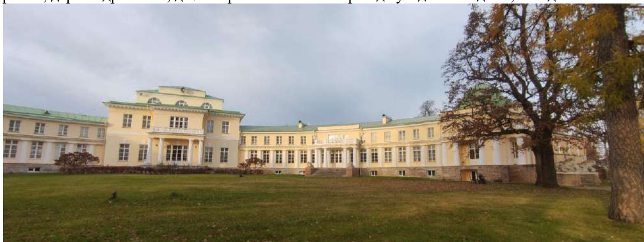
Фото 4. Объект культурного наследия федерального значения «Усадьба Строгановых (Марьино)», расположенный по адресу: Ленинградская область, Госненский муниципальный район, дер. Андрианово, д. 72. Фрагмент южного фасада усадебного дома, восточная часть.
