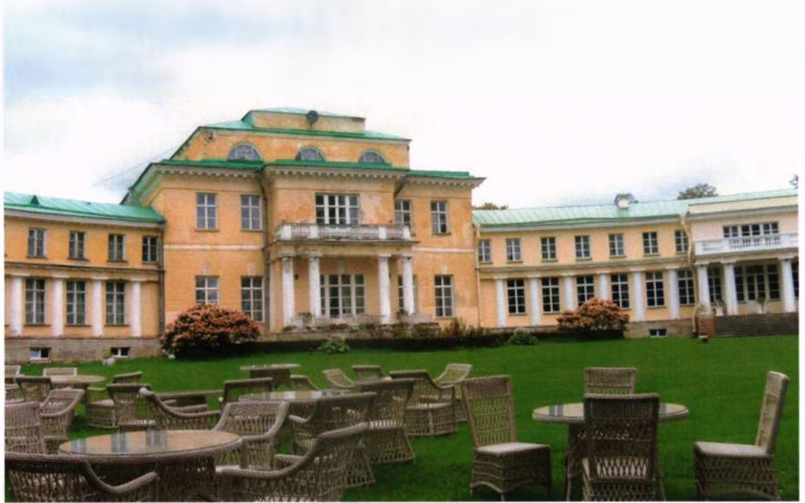
Фото 3. Вид на Усадебный дом, центральная часть. Главный фасад.
