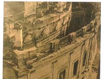
стропильной системе. Окрытие – фальцевая кровля без окраски. Водосточная система металлические трубы по фасадам с коваными ухватами по фасадам. Дымовые и вентиляционные трубы – кирпичные с покрытием оголовков. Парапетное ограждение в виде секций с каменными стойками и кованой решеткой.
