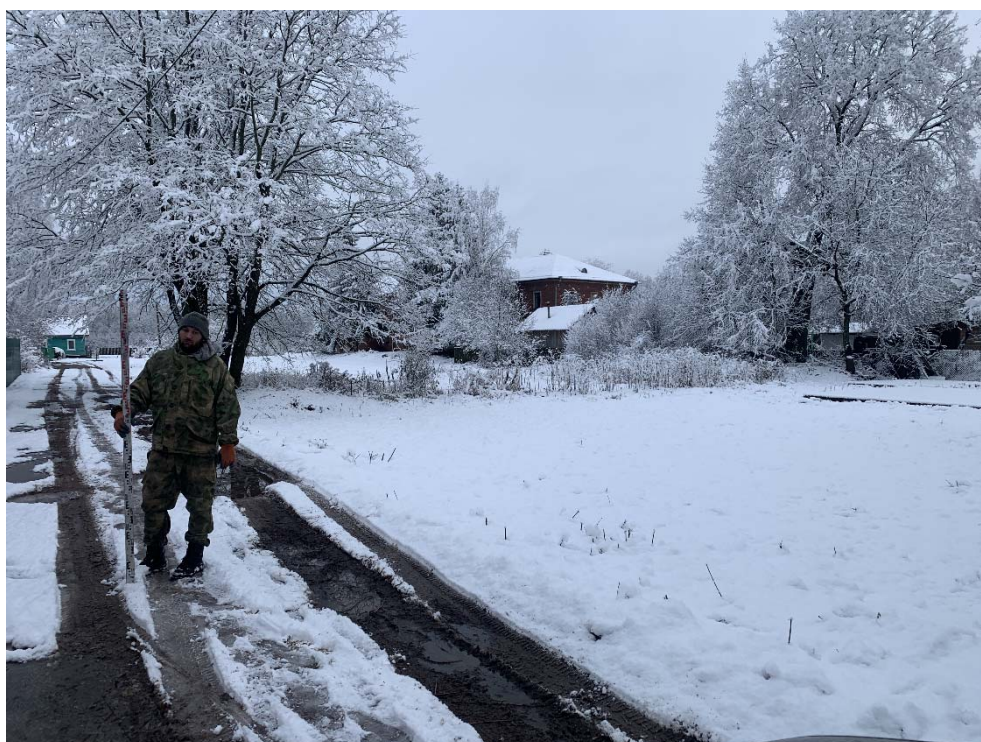
Рис. 127. Ленинградская область, Волховский район, «Распределительный газопровод и газопроводы-вводы в с. Старая Ладога». Участок 3-2. Точка фотофиксации 33. Вид с СЗ.
