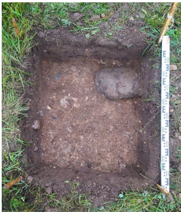
Рис. 40. Ленинградская область, Волховский район, «Распределительный газопровод и газопроводы-вводы в с. Старая Ладога». Участок 1. Шурф 4. Зачистка по материке. Вид сверху и с Ю.
