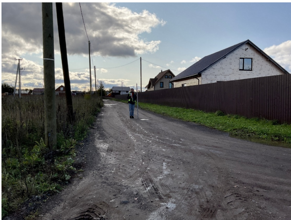
Рис. 34. Ленинградская область, Волховский район, «Распределительный газопровод и газопроводы-вводы в с. Старая Ладога». Участок 1. Точка фотофиксации 4. Вид с С.
