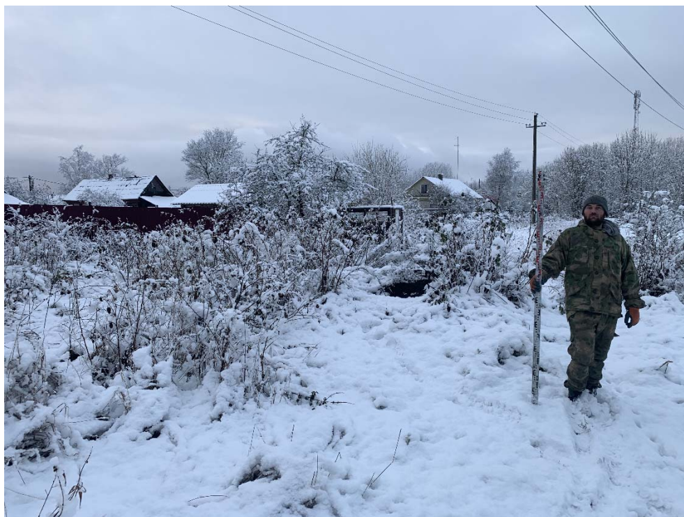
Рис. 196. Ленинградская область, Волховский район, «Распределительный газопровод и газопроводы-вводы в с. Старая Ладога». Участок 3-3. Точка фотофиксации 66. Вид с СВ.
