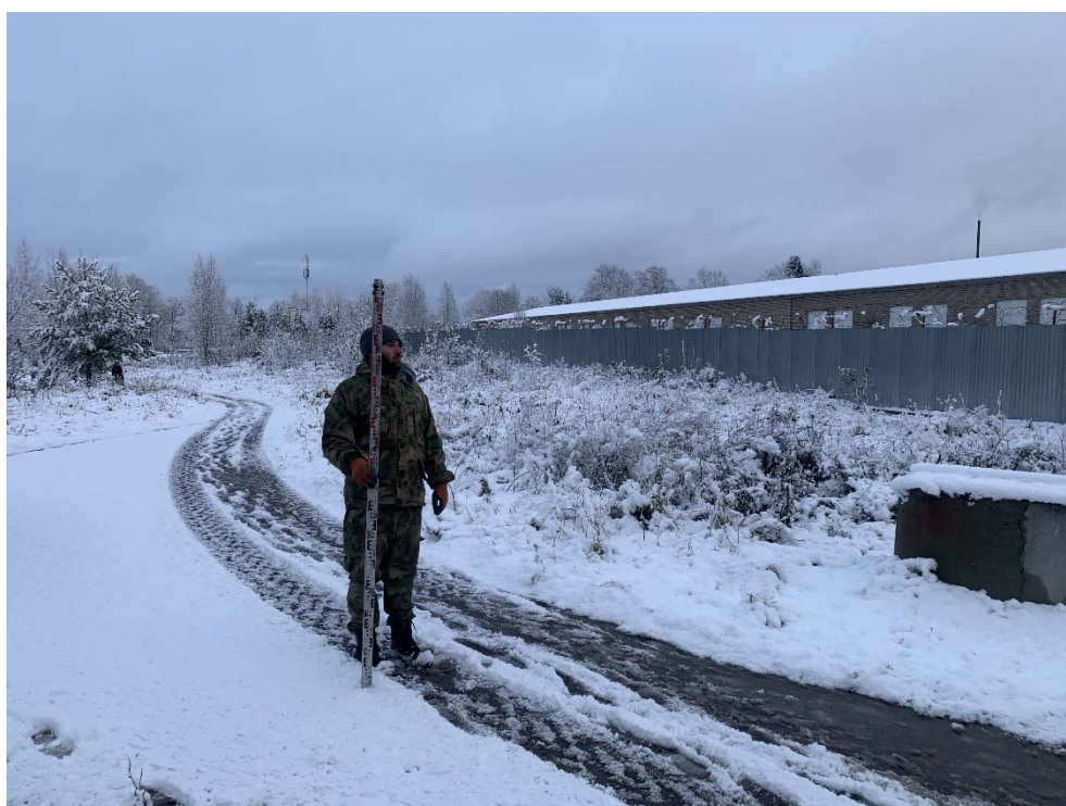
Рис. 187. Ленинградская область, Волховский район, «Распределительный газопровод и газопроводы-вводы в с. Старая Ладога». Участок 3-3. Точка фотофиксации 61. Вид с ЗСЗ.
