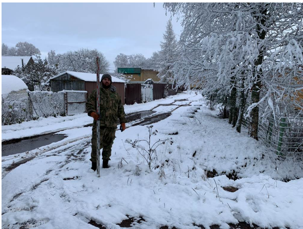
Рис. 151. Ленинградская область, Волховский район, «Распределительный газопровод и газопроводы-вводы в с. Старая Ладога». Участок 3-3. Точка фотофиксации 43. Вид с ЗСЗ.
