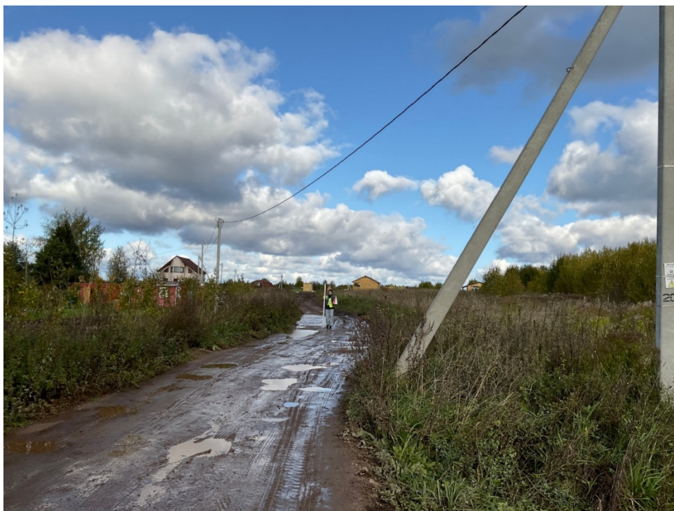
Рис. 36. Ленинградская область, Волховский район, «Распределительный газопровод и газопроводы-вводы в с. Старая Ладога». Участок 1. Точка фотофиксации 5. Вид с ЮВ.
