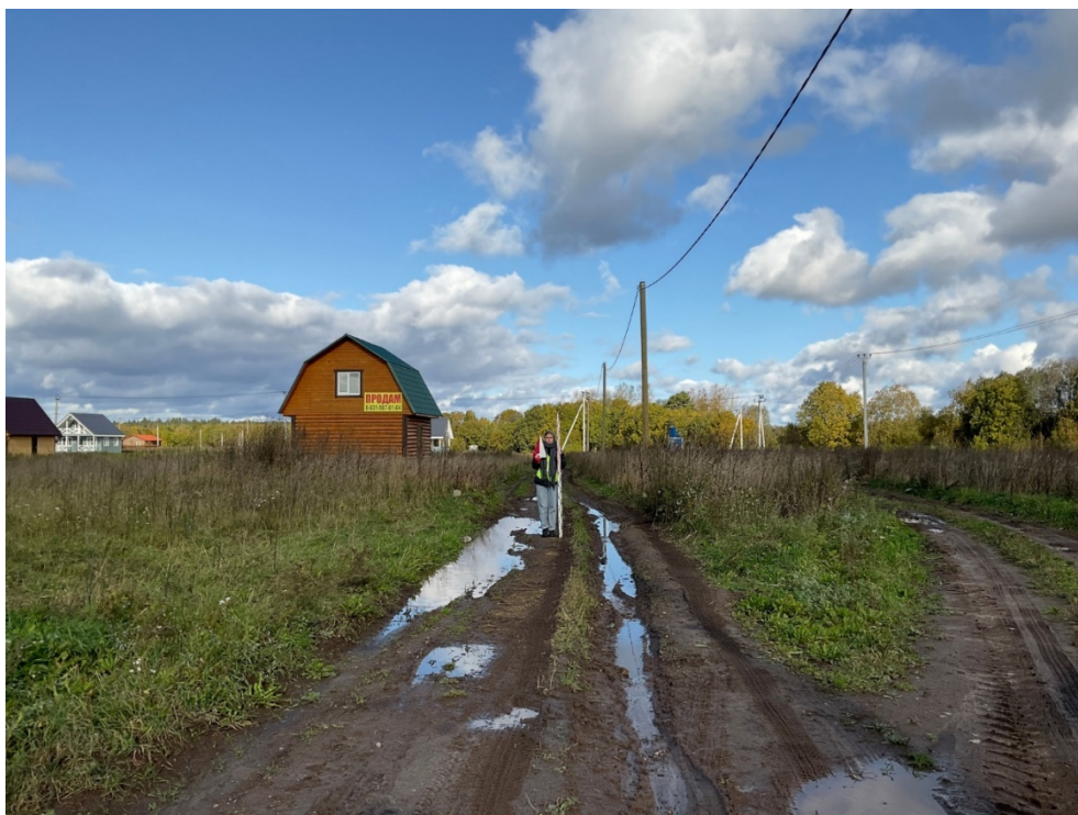
Рис. 32. Ленинградская область, Волховский район, «Распределительный газопровод и газопроводы-вводы в с. Старая Ладога». Участок 1. Точка фотофиксации 4. Вид с Ю.
