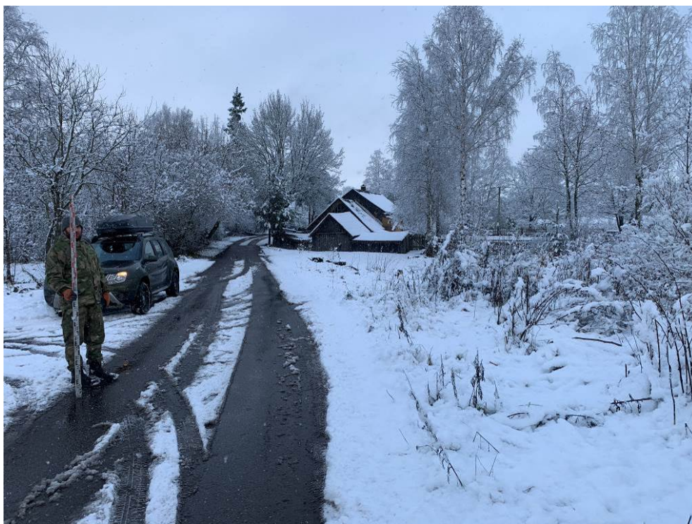
Рис. 105. Ленинградская область, Волховский район, «Распределительный газопровод и газопроводы-вводы в с. Старая Ладога». Участок 3-1. Точка фотофиксации 24. Вид с ЮЗ.
