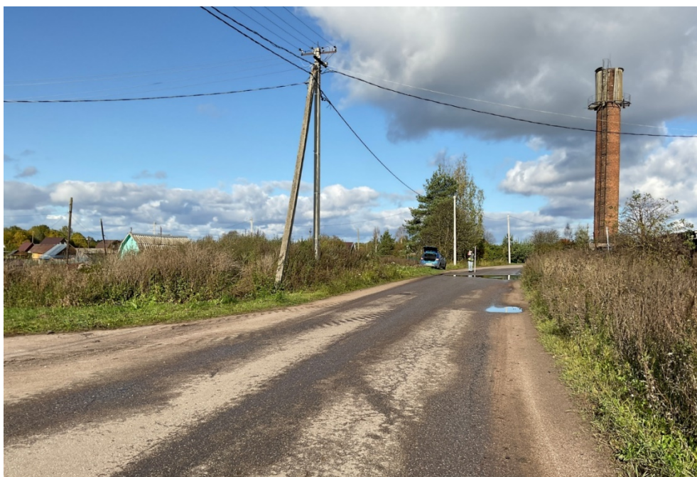
Рис. 60. Ленинградская область, Волховский район, «Распределительный газопровод и газопроводы-вводы в с. Старая Ладога». Участок 1. Точка фотофиксации 10. Вид с Ю.
