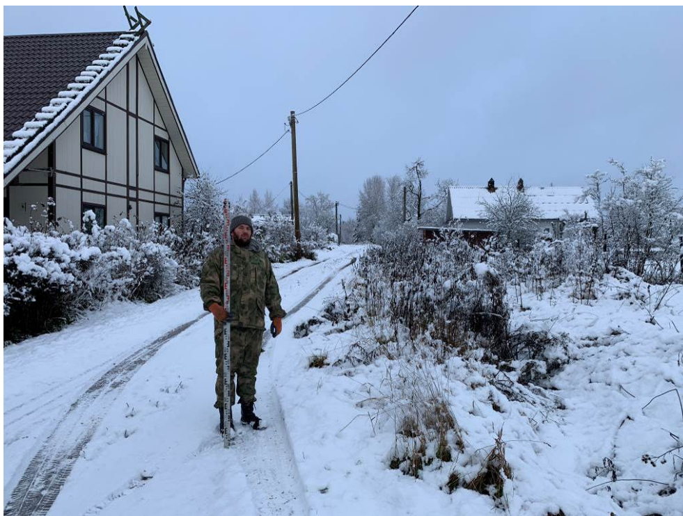
Рис. 153. Ленинградская область, Волховский район, «Распределительный газопровод и газопроводы-вводы в с. Старая Ладога». Участок 3-3. Точка фотофиксации 44. Вид с Ю.
