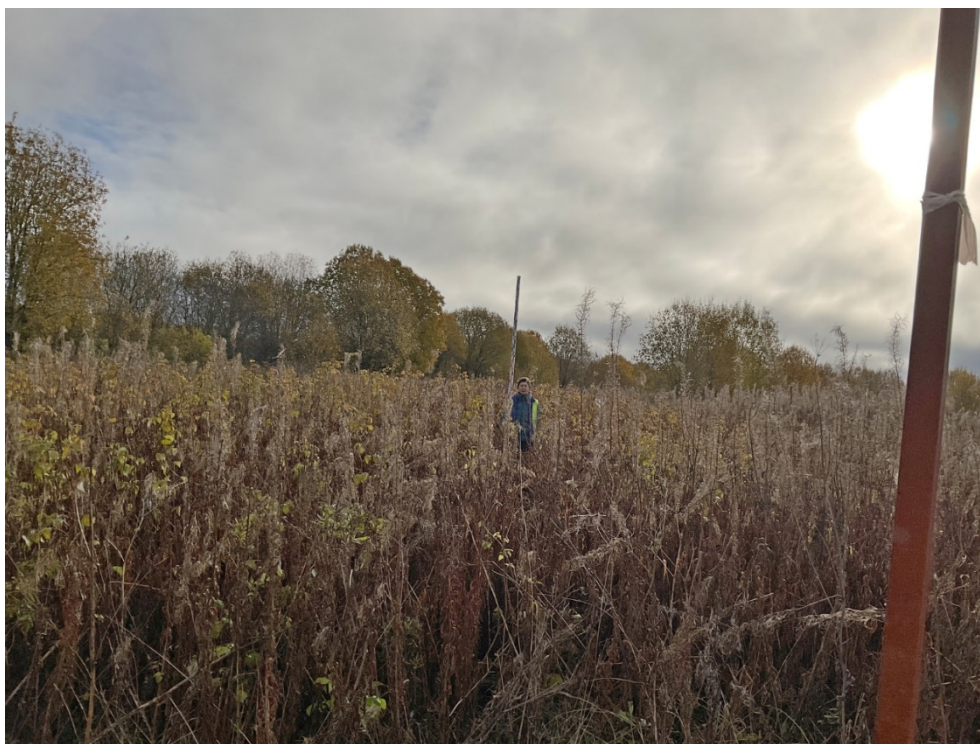
Рис. 14. Ленинградская область, Волховский район, «Распределительный газопровод и газопроводы-вводы в с. Старая Ладога». Участок 1. Точка фотофиксации 1. Вид с СЗ.
