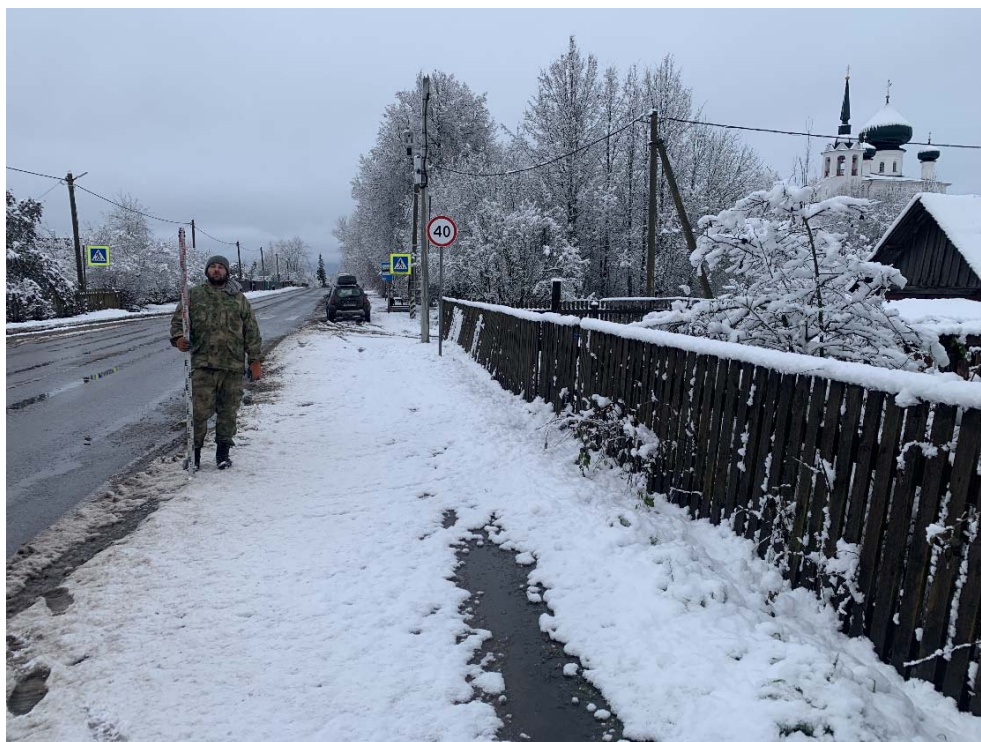
Рис. 128. Ленинградская область, Волховский район, «Распределительный газопровод и газопроводы-вводы в с. Старая Ладога». Участок 3-2. Точка фотофиксации 34. Вид с ЮЮЗ.
