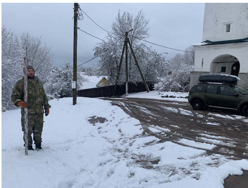
Рис. 137. Ленинградская область, Волховский район, «Распределительный газопровод и газопроводы-вводы в с. Старая Ладога». Участок 3-2. Точка фотофиксации 38. Вид с ЮВ.
