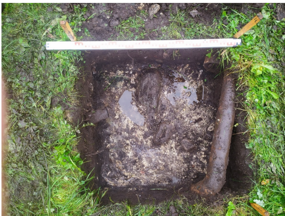
Рис. 53. Ленинградская область, Волховский район, «Распределительный газопровод и газопроводы-вводы в с. Старая Ладога». Участок 1. Шурф 6. Зачистка по материке. Вид сверху и с В.
