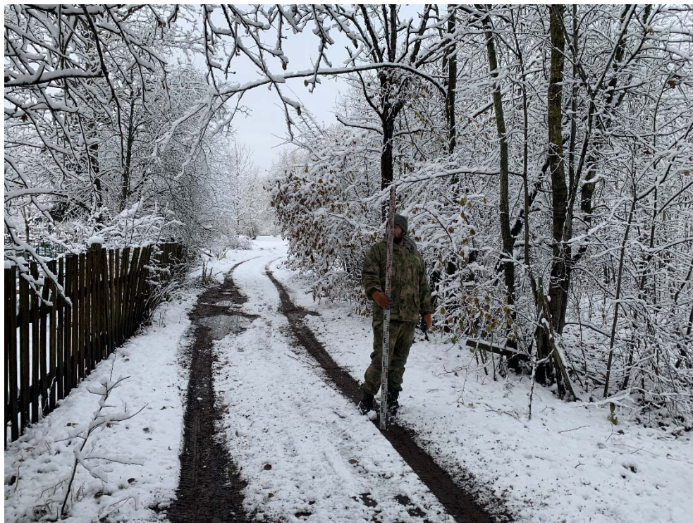
Рис. 192. Ленинградская область, Волховский район, «Распределительный газопровод и газопроводы-вводы в с. Старая Ладога». Участок 3-3. Точка фотофиксации 64. Вид с Ю.
