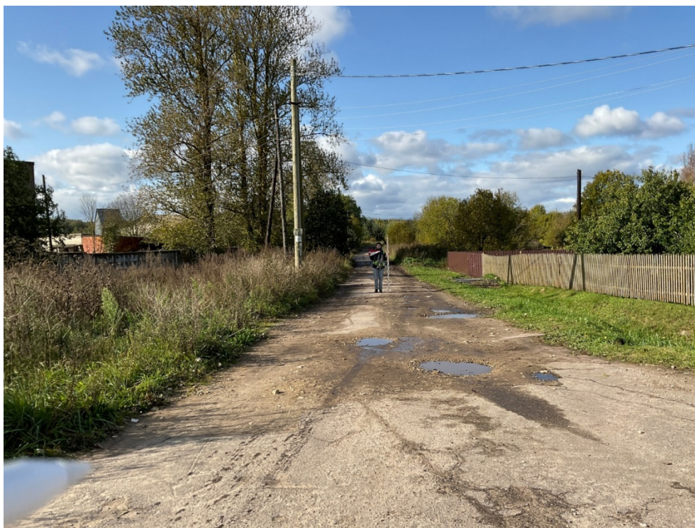
Рис. 61. Ленинградская область, Волховский район, «Распределительный газопровод и газопроводы-вводы в с. Старая Ладога». Участок 1. Точка фотофиксации 10. Вид с В.
