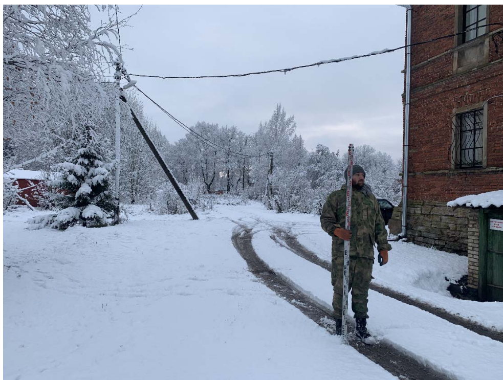
Рис. 121. Ленинградская область, Волховский район, «Распределительный газопровод и газопроводы-вводы в с. Старая Ладога». Участок 3-2. Точка фотофиксации 31. Вид с С.
