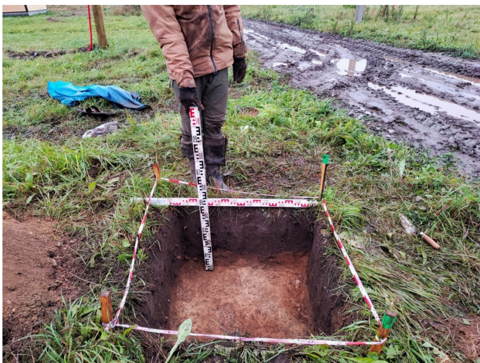
Рис. 27. Ленинградская область, Волховский район, «Распределительный газопровод и газопроводы-вводы в с. Старая Ладога». Участок 1. Шурф 3. Зачистка по матерiku. Общий вид с В.
