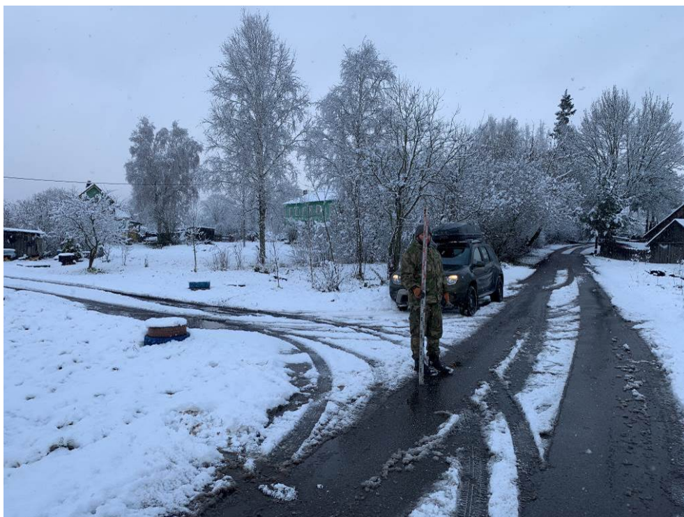
Рис. 106. Ленинградская область, Волховский район, «Распределительный газопровод и газопроводы-вводы в с. Старая Ладога». Участок 3-1. Точка фотофиксации 24. Вид с Ю.
