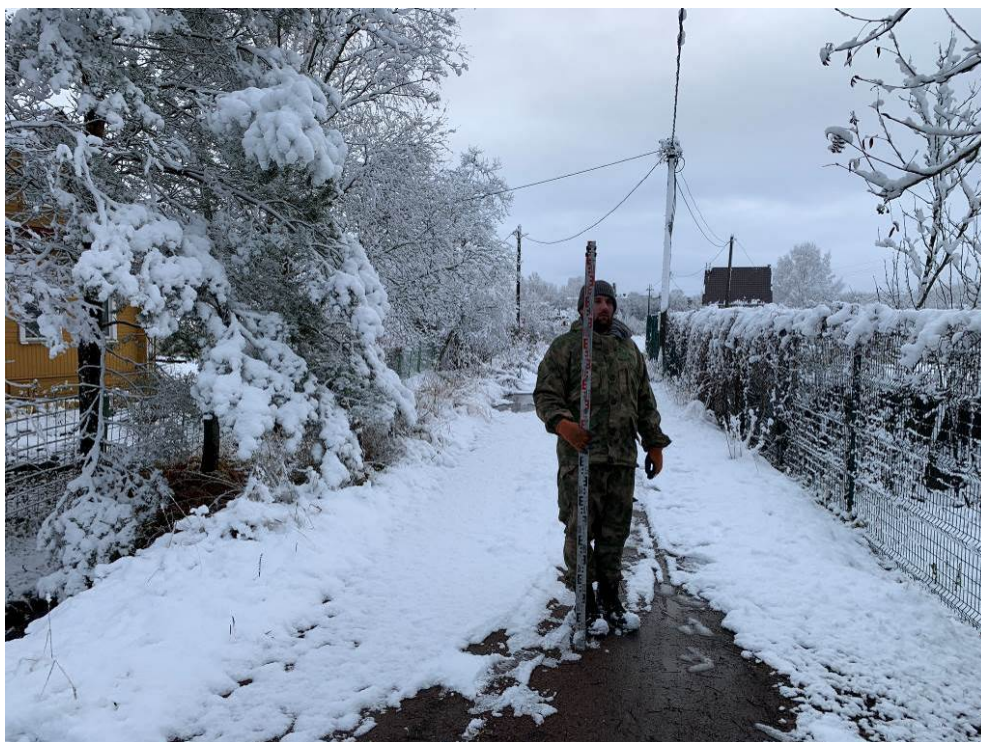
Рис. 152. Ленинградская область, Волховский район, «Распределительный газопровод и газопроводы-вводы в с. Старая Ладога». Участок 3-3. Точка фотофиксации 43. Вид с С.
