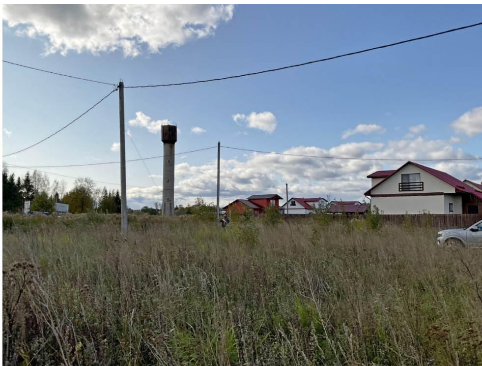
Рис. 63. Ленинградская область, Волховский район, «Распределительный газопровод и газопроводы-вводы в с. Старая Ладога». Участок 1. Точка фотофиксации 11. Вид с СВ.
