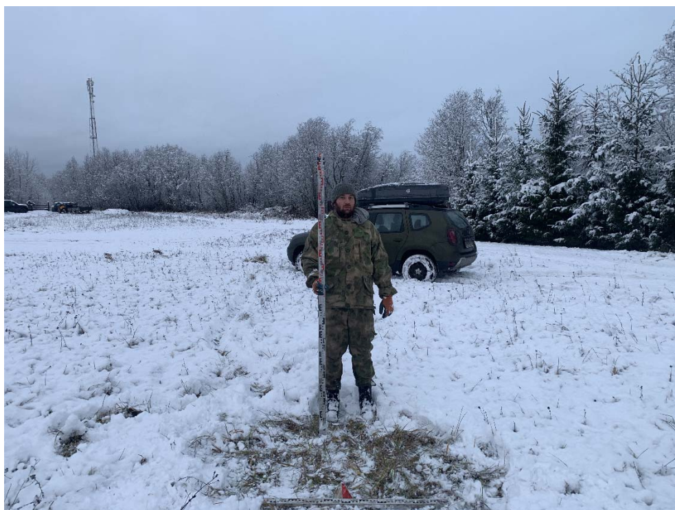
Рис. 201. Ленинградская область, Волховский район, «Распределительный газопровод и газопроводы-вводы в с. Старая Ладога». Участок 3-3. Шурф 8. Общий вид до начала работ с Ю.
