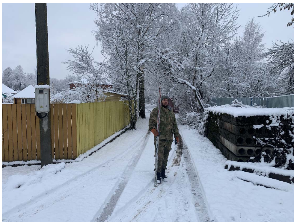
Рис. 131. Ленинградская область, Волховский район, «Распределительный газопровод и газопроводы-вводы в с. Старая Ладога». Участок 3-2. Точка фотофиксации 36. Вид с СВ.
