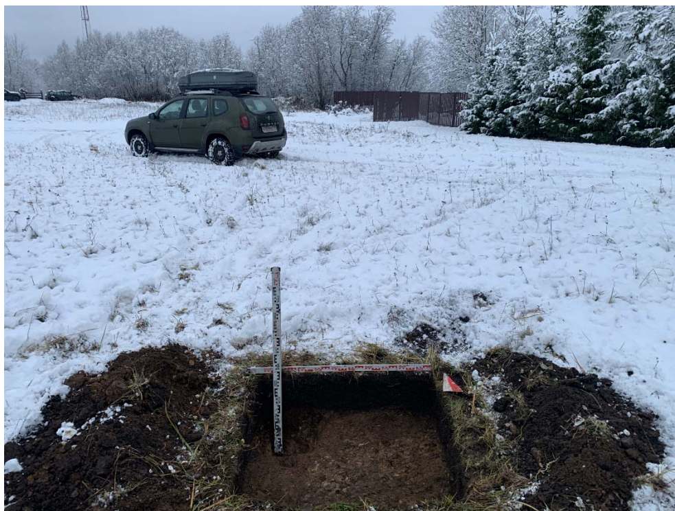
Рис. 202. Ленинградская область, Волховский район, «Распределительный газопровод и газопроводы-вводы в с. Старая Ладога». Участок 3-3. Шурф 8. Зачистка по материке. Общий вид с Ю.
