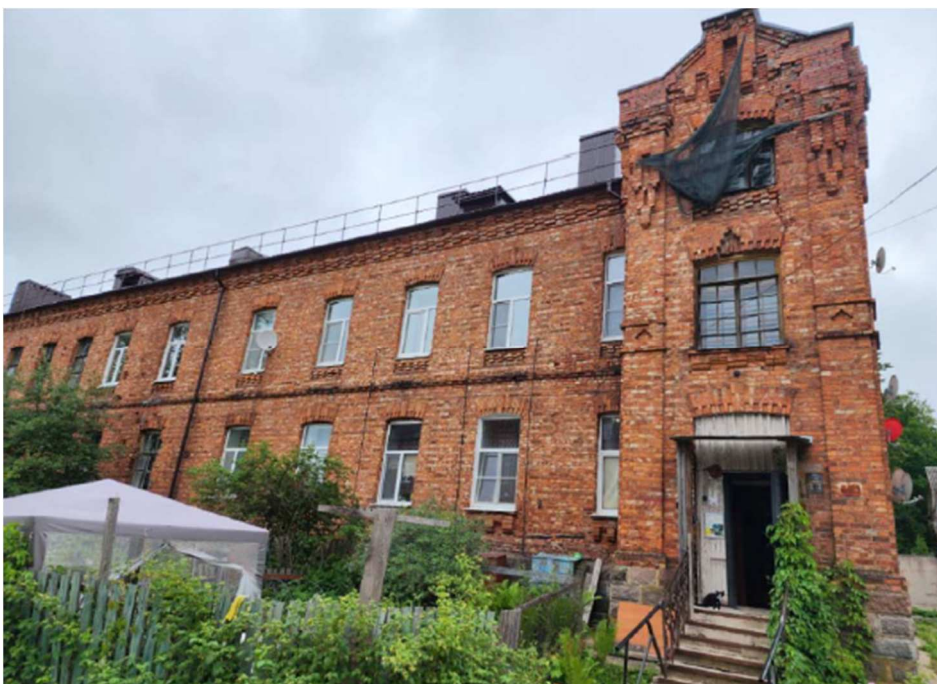
1. Западный фасад. Фрагмент.
