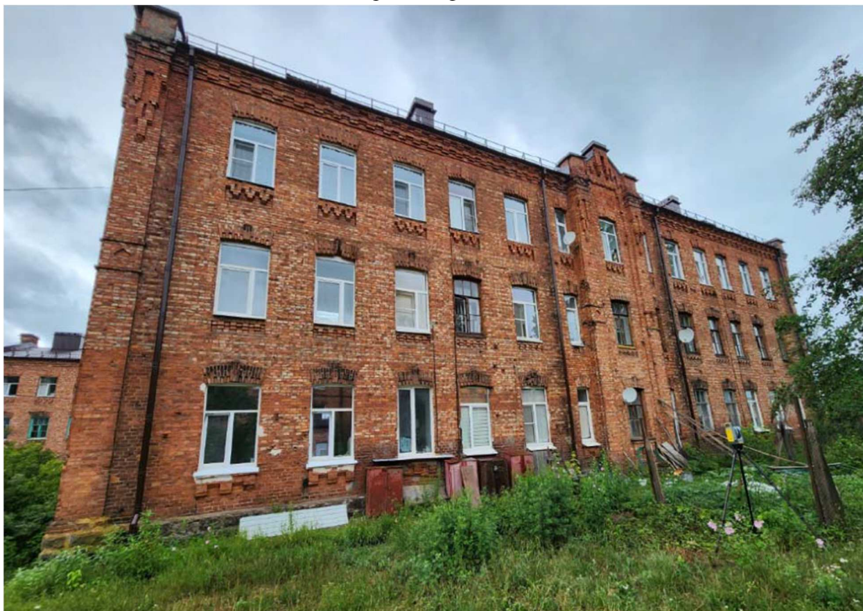
4. Восточный продольный фасад. Общий вид.
