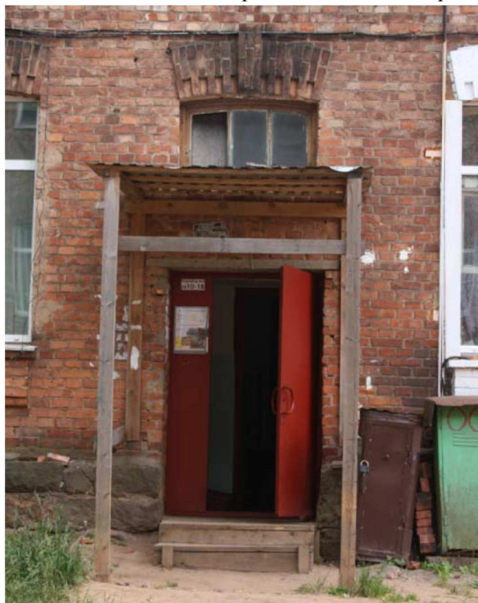
2. Деталь западного продольного фасада. Вид входного проема.
