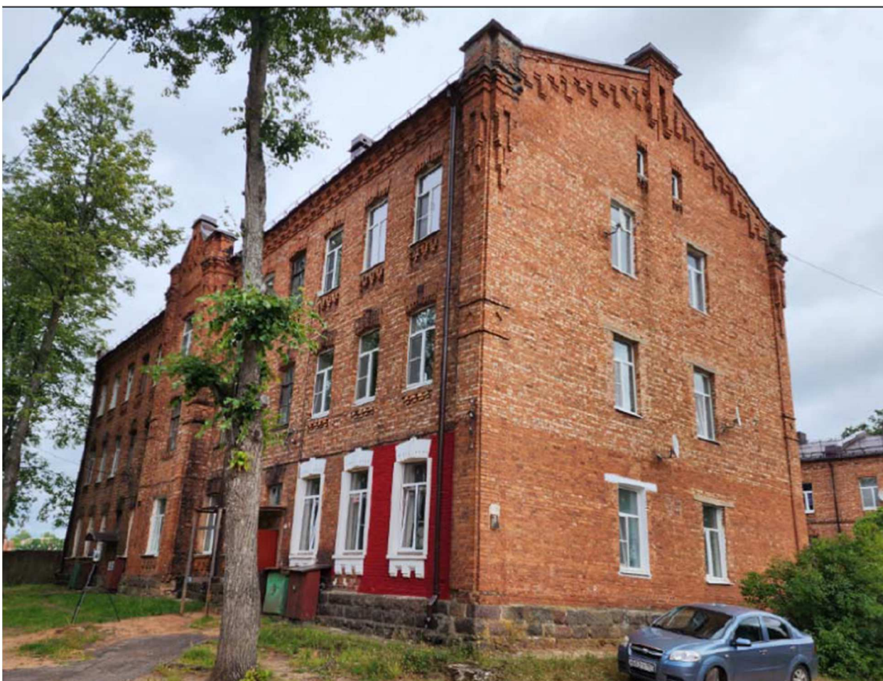
1. Общий вид объекта с юга. Южный торцевой и западный продольный фасады.
