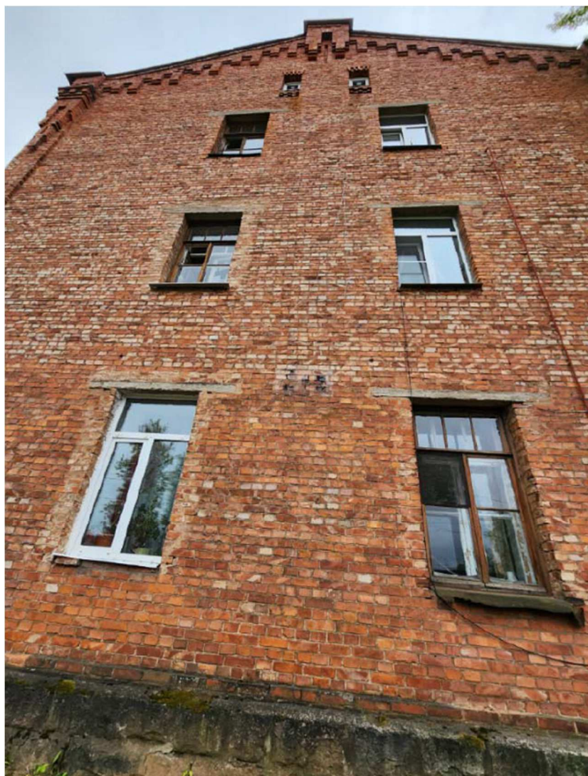
5. Северный торцевой фасад. Общий вид.
