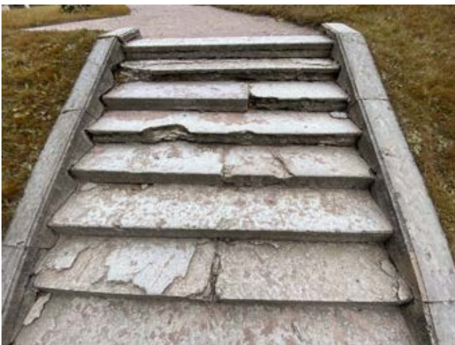
30. «Лестницы и террасы в Голландском и Верхнем садах, 1796 год» и лестниц Ботанического сада у Цветочной горки (район Дворцового парка – Ботанические сады и «Цветочная горка с каменными лестницами в Ботаническом саду»), Ленинградская область, Гатчинский муниципальный район, Гатчинское городское поселение, г. Гатчина, Дворцовый парк. Нижний голландский сад. Лестница №2. Общий вид. Фото 30.09.2023г.
