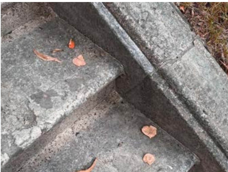
11. «Лестницы и террасы в Голландском и Верхнем садах, 1796 год» и лестниц Ботанического сада у Цветочной горки (район Дворцового парка – Ботанические сады и «Цветочная горка с каменными лестницами в Ботаническом саду»), Ленинградская область, Гатчинский муниципальный район, Гатчинское городское поселение, г. Гатчина, Дворцовый парк. Верхний ботанический сад. Лестница №3. Фрагмент. Фото 30.09.2023г.
