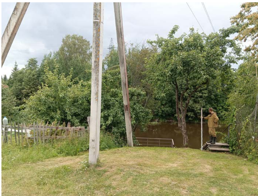
Рис. 70. Ленинградская область, Всеволожский район, «Межпоселковый газопровод до д. Резвых, д. Черная Речка Всеволожского района». 2023 г. Общий вид участка обследования. Точка фиксации 20. Вид с ЮВ
