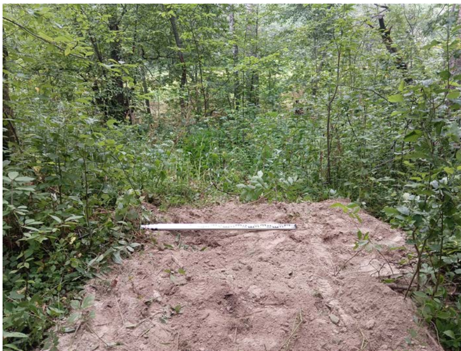
Рис. 39. Ленинградская область, Всеволожский район, «Межпоселковый газопровод до д. Резвых, д. Черная Речка Всеволожского района». 2023 г. Шурф 2. Рекультивация. Общий вид с Ю
