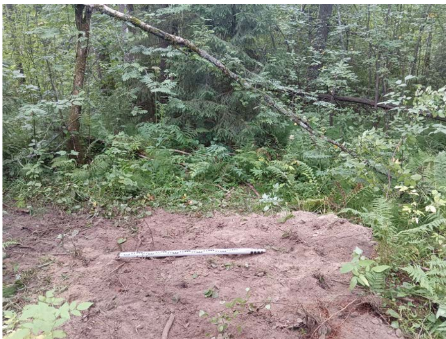
Рис. 54. Ленинградская область, Всеволожский район, «Межпоселковый газопровод до д. Резвых, д. Черная Речка Всеволожского района». 2023 г. Шурф 3. Рекультивация. Вид с Ю
