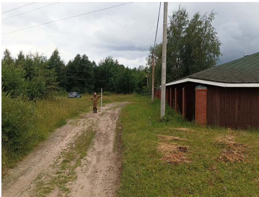
Рис. 63. Ленинградская область, Всеволожский район, «Межпоселковый газопровод до д. Резвых, д. Черная Речка Всеволожского района». 2023 г. Общий вид участка обследования. Точка фиксации 17. Вид с СВ
