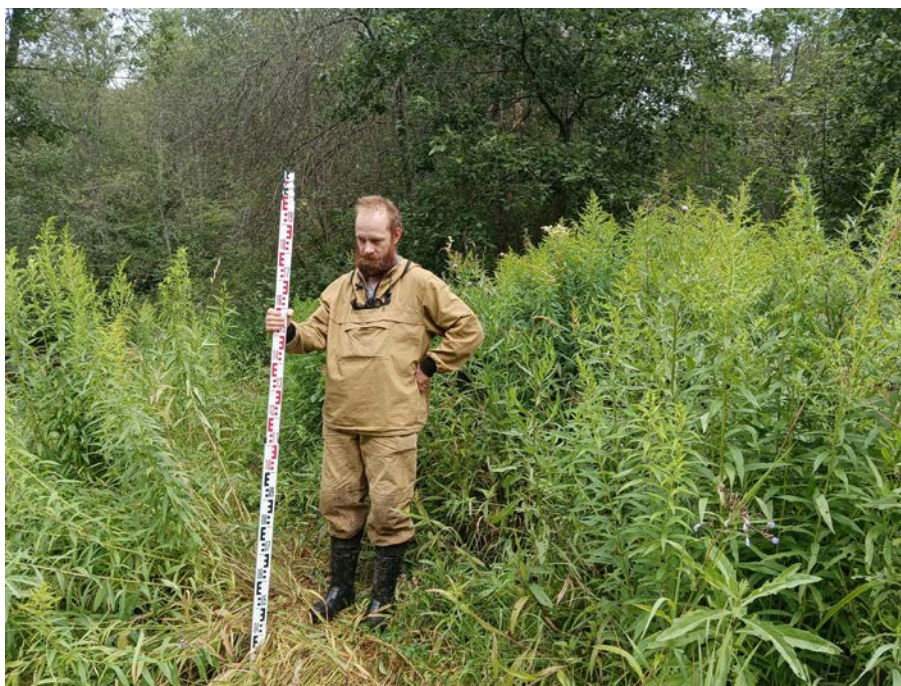
Рис. 30. Ленинградская область, Всеволожский район, «Межпоселковый газопровод до д. Резвых, д. Черная Речка Всеволожского района». 2023 г. Общий вид участка обследования. Точка фиксации 6. Вид с Ю
