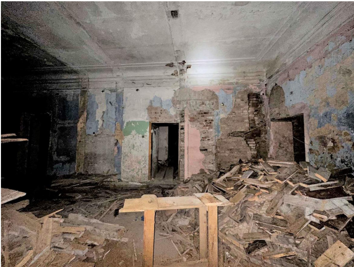
Фото 38. Пом. 1.16 – 1.14 – 1.18 – 1.21. Вид на юго-восточную стену с северо-запада. Дата съемки: 28.12.2022 г. Автор съемки: Глинская Н.Б.
