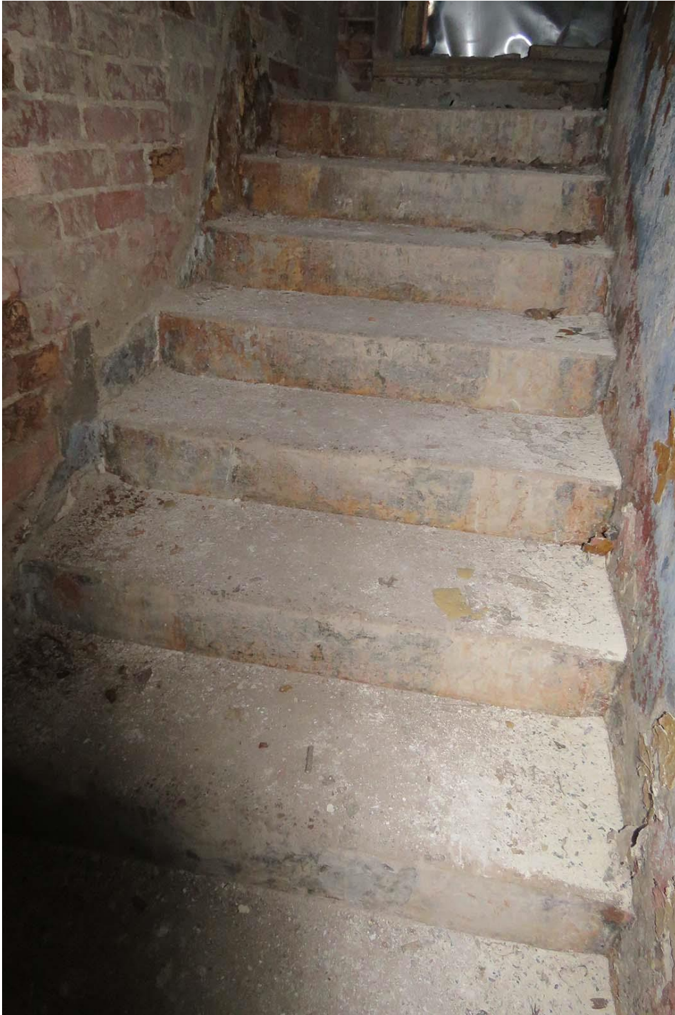
Фото 70. Нижний марш лестничной клетки ЛК-3. Дата съемки: 28.12.2022 г. Автор съемки: Глинская Н.Б.
