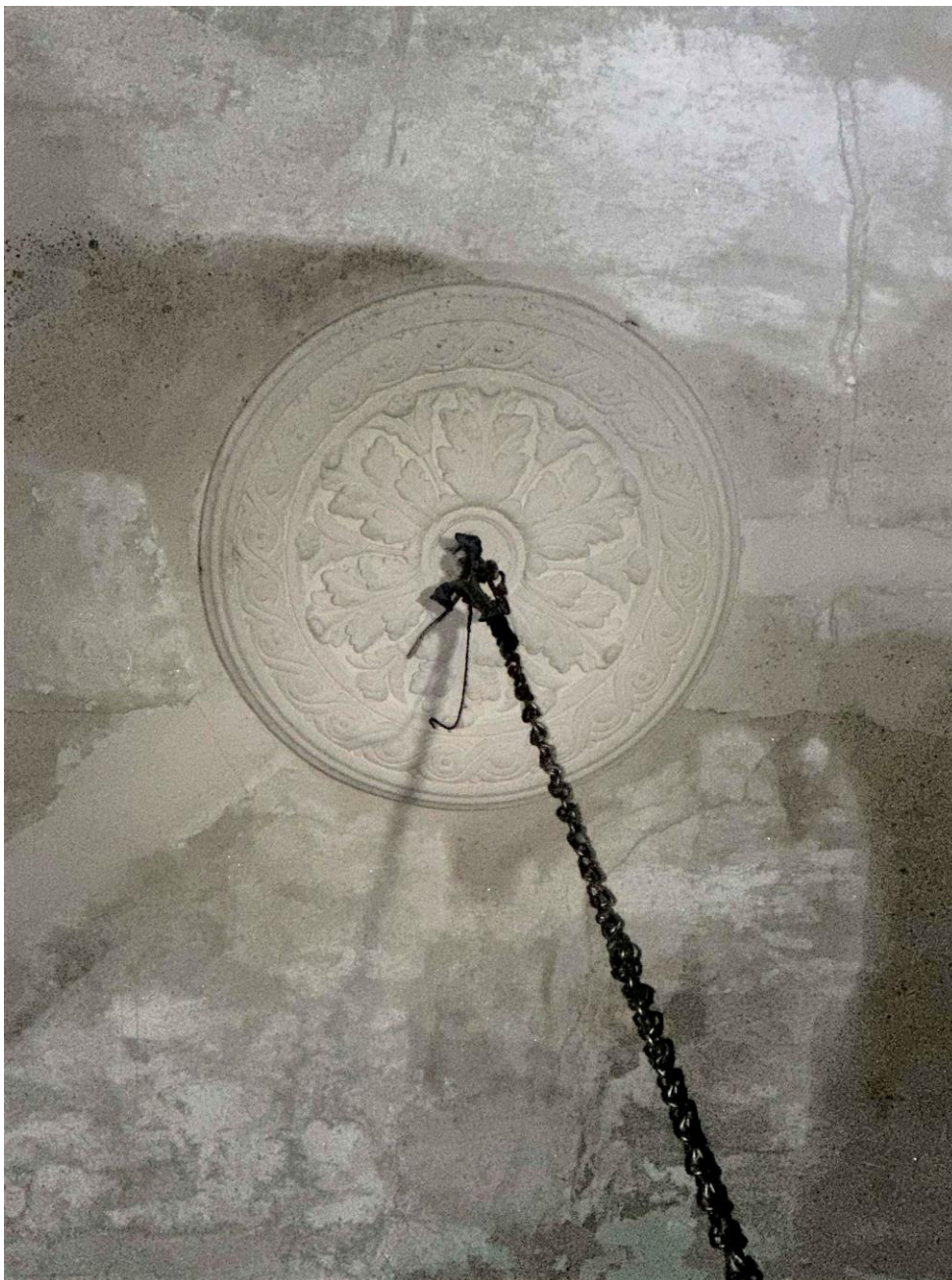
Фото 47. Пом. 2.3. Декоративная потолочная розетка. Дата съемки: 28.12.2022 г. Автор съемки: Глинская Н.Б.
