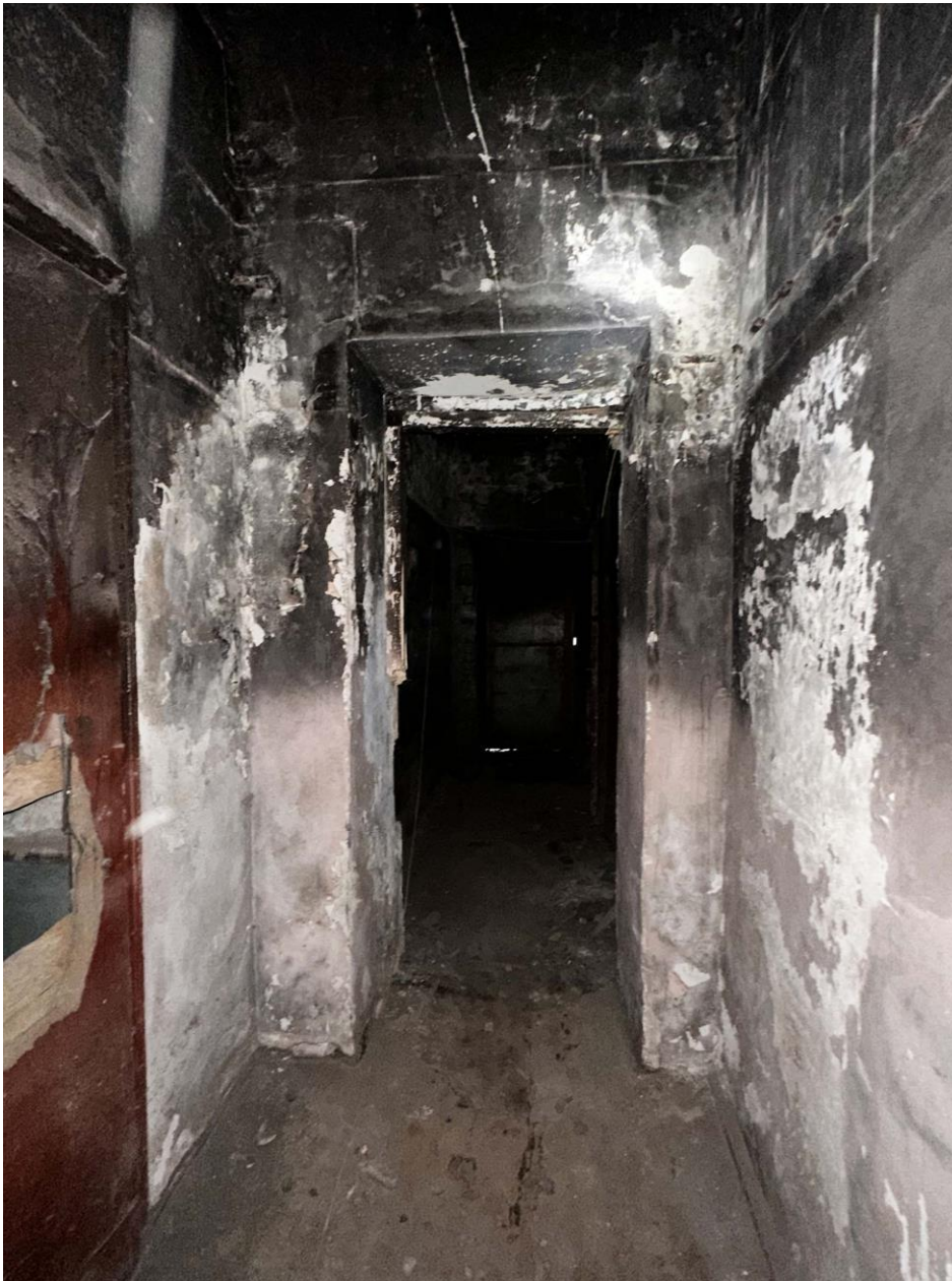
Фото 24. Пом. 1.2. Общий вид помещения с северо-востока. Дата съемки: 28.12.2022 г. Автор съемки: Глинская Н.Б.
