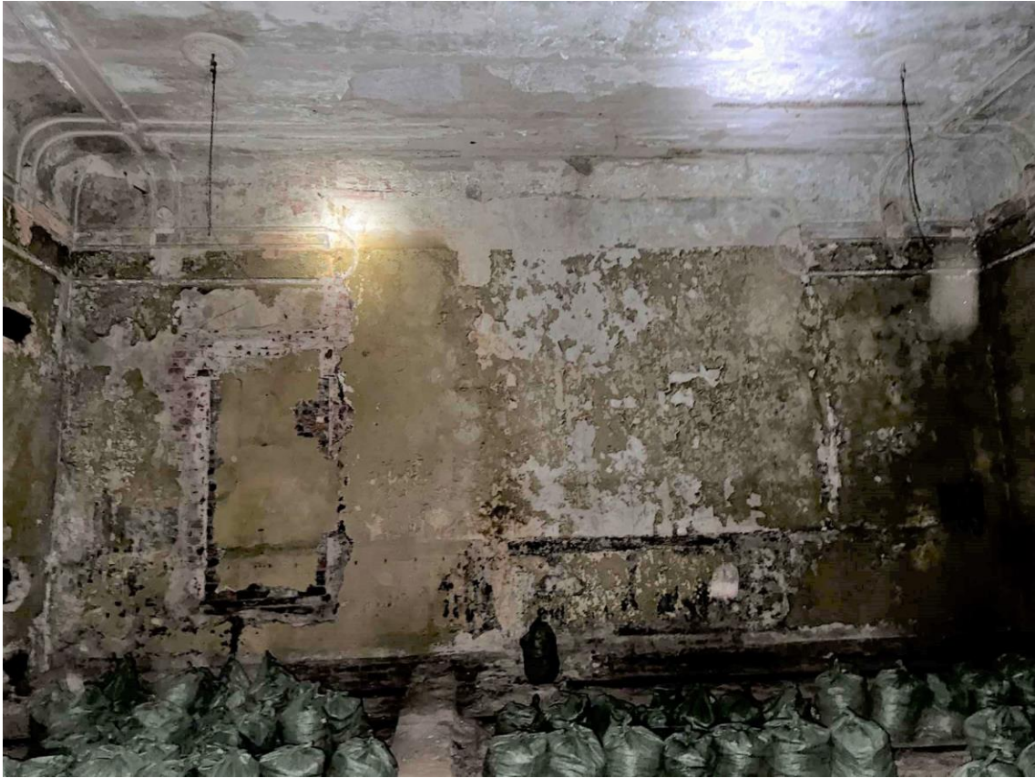
Фото 45. Пом. 2.3. Вид на северо-западную стену. Дата съемки: 28.12.2022 г. Автор съемки: Глинская Н.Б.
