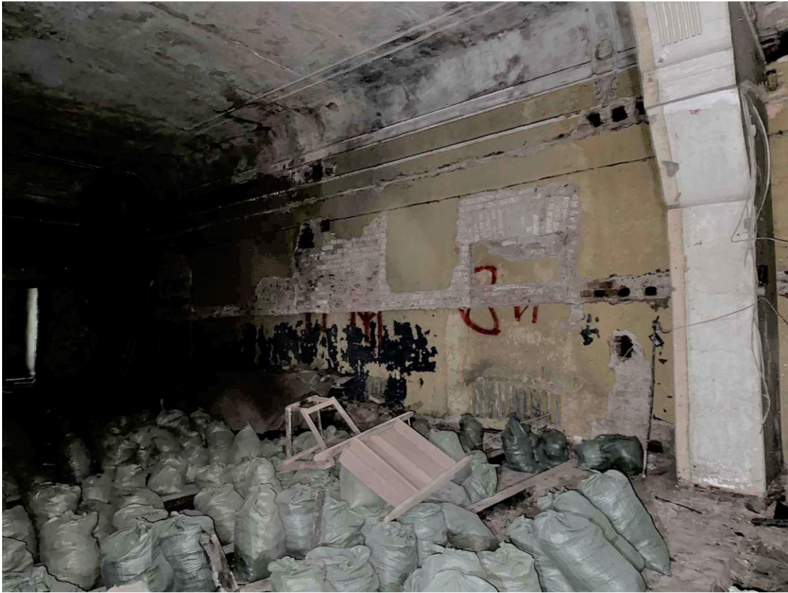
Фото 56. Пом. 2.5. Вид на юго-западную стену. Дата съемки: 28.12.2022 г. Автор съемки: Глинская Н.Б.
