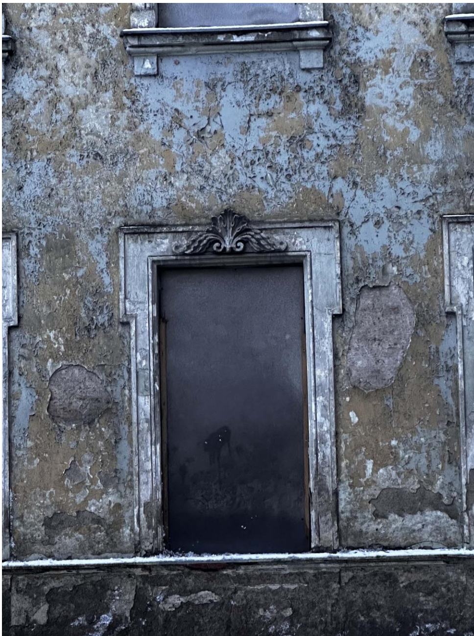
Фото 6. Фрагмент лицевого северо-восточного фасада. 1-ая часть центрального этажа. Дата съемки: 28.12.2022 г. Автор съемки: Глинская Н.Б.
