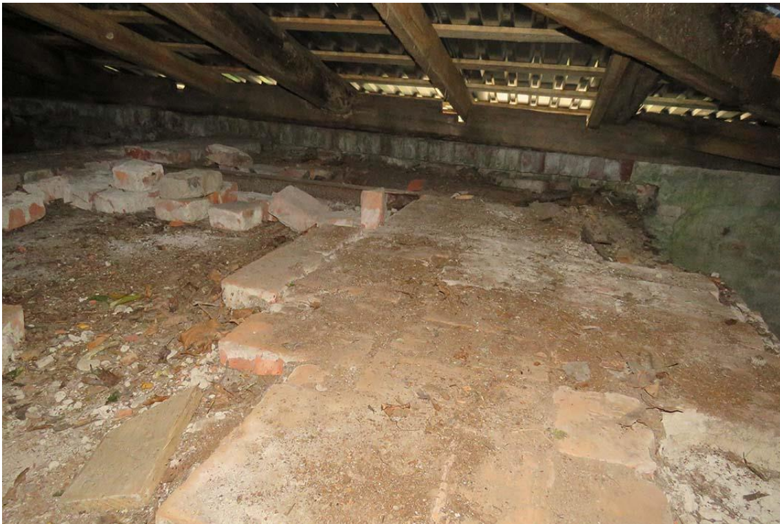
Фото 72. Вид на кирпичное покрытие чердака со стороны лестничной клетки ЛК-3. Дата съемки: 28.12.2022 г. Автор съемки: Глинская Н.Б.
