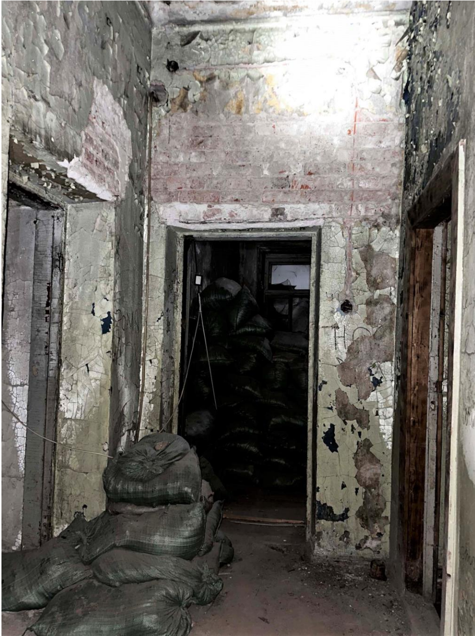
Фото 43. Пом. 2.1. Общий вид помещения северо-востока. Дата съемки: 28.12.2022 г. Автор съемки: Глинская Н.Б.
