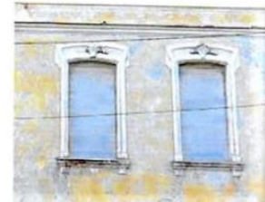
Обрамление оконных проемов 2-го этажа. С-В лицевой и Ю-В боковой фасады
