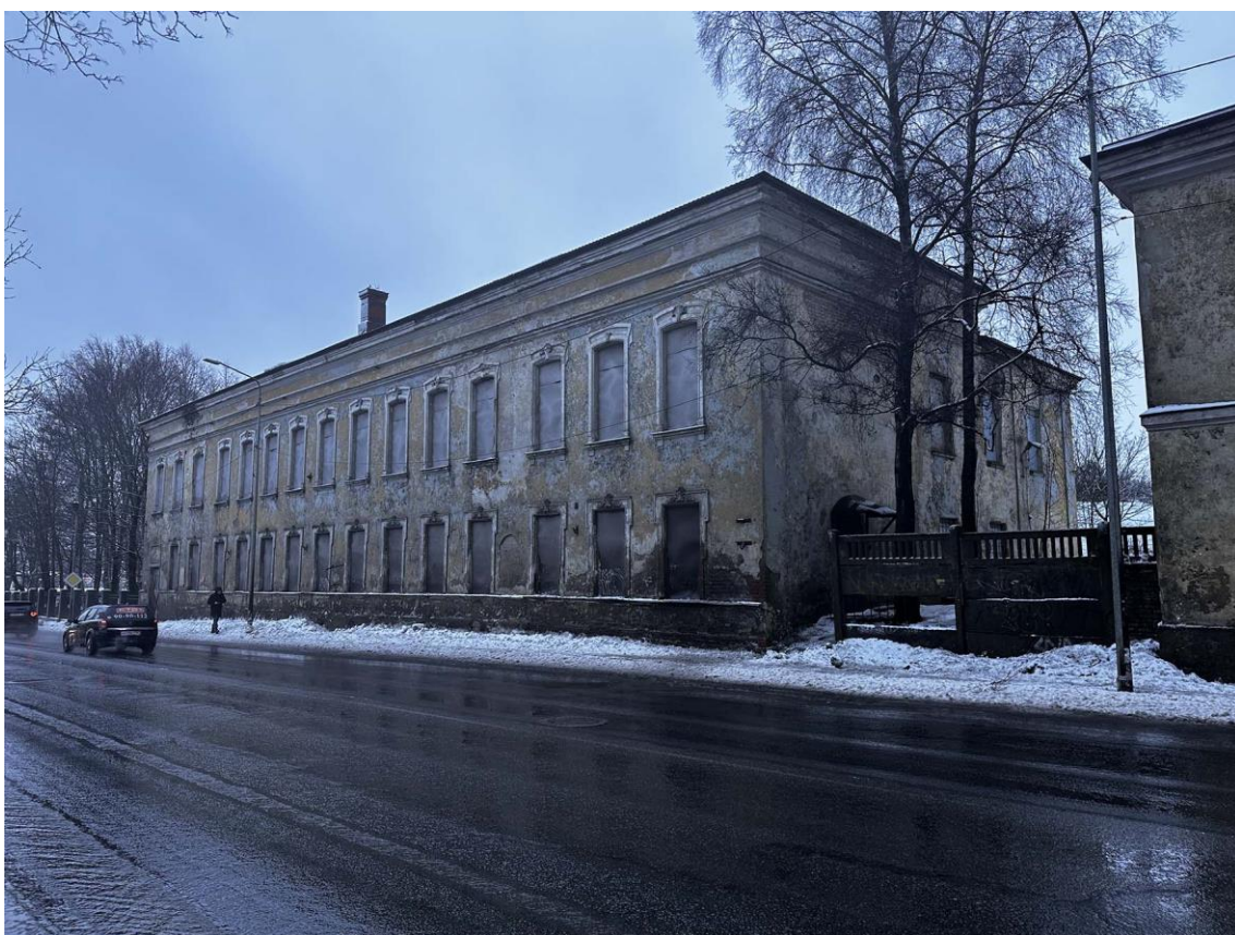
Фото 2. Общий вид здания с севера. Дата съемки: 28.12.2022 г. Автор съемки: Глинская Н.Б.
