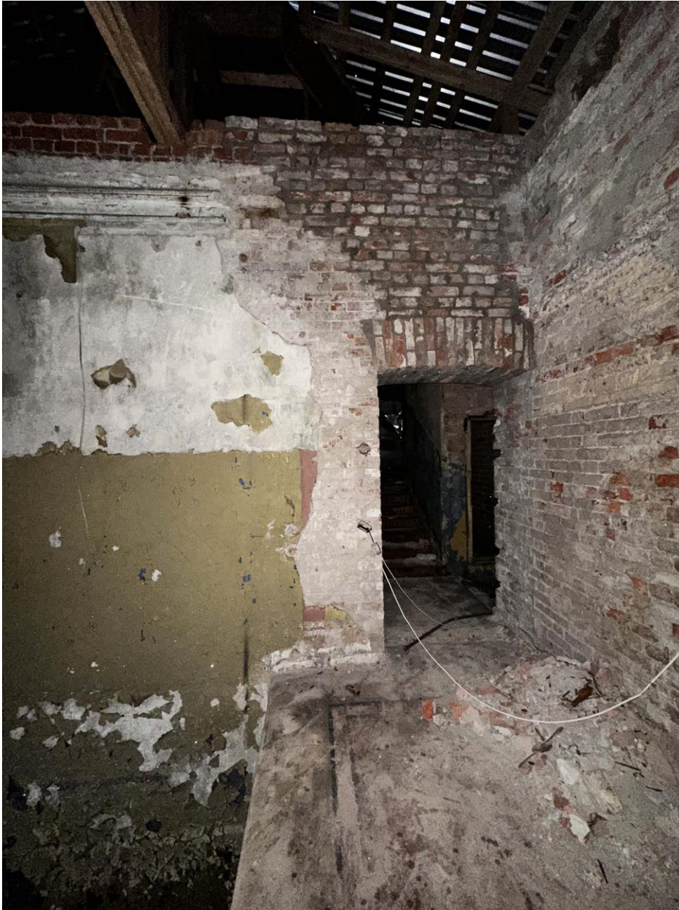
Фото 66. Верхняя площадка лестничной клетки ЛК-1. Дата съемки: 28.12.2022 г. Автор съемки: Глинская Н.Б.
