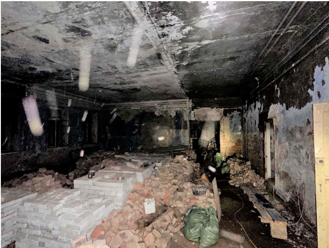
Фото 28. Пом. 1.8 – 1.9 – 1.10. Общий вид помещения с северо-запада. Дата съемки: 28.12.2022 г. Автор съемки: Глинская Н.Б.
