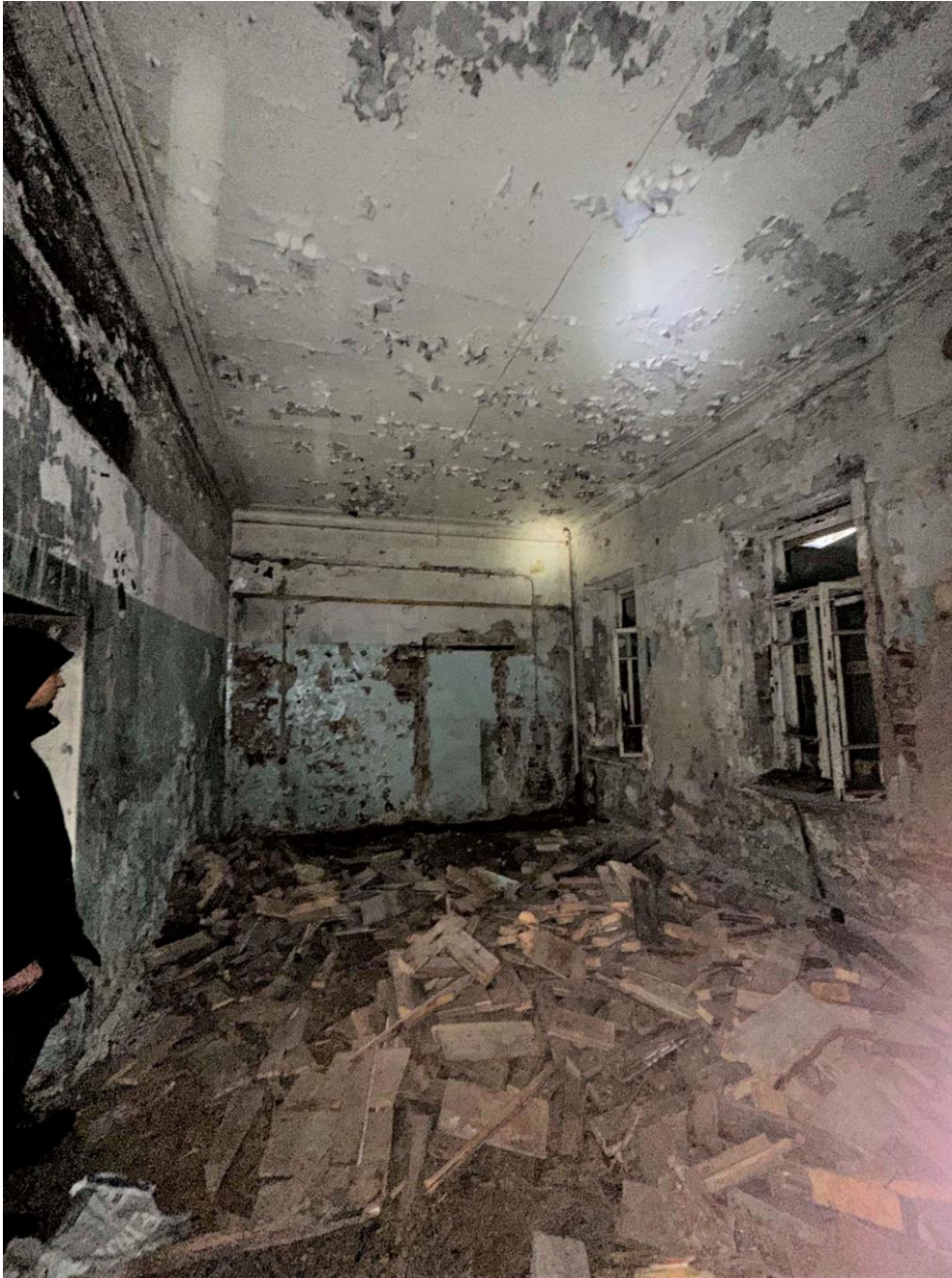
Фото 33. Пом. 1.12. Общий вид помещения с северо-востока. Дата съемки: 28.12.2022 г. Автор съемки: Глинская Н.Б.
