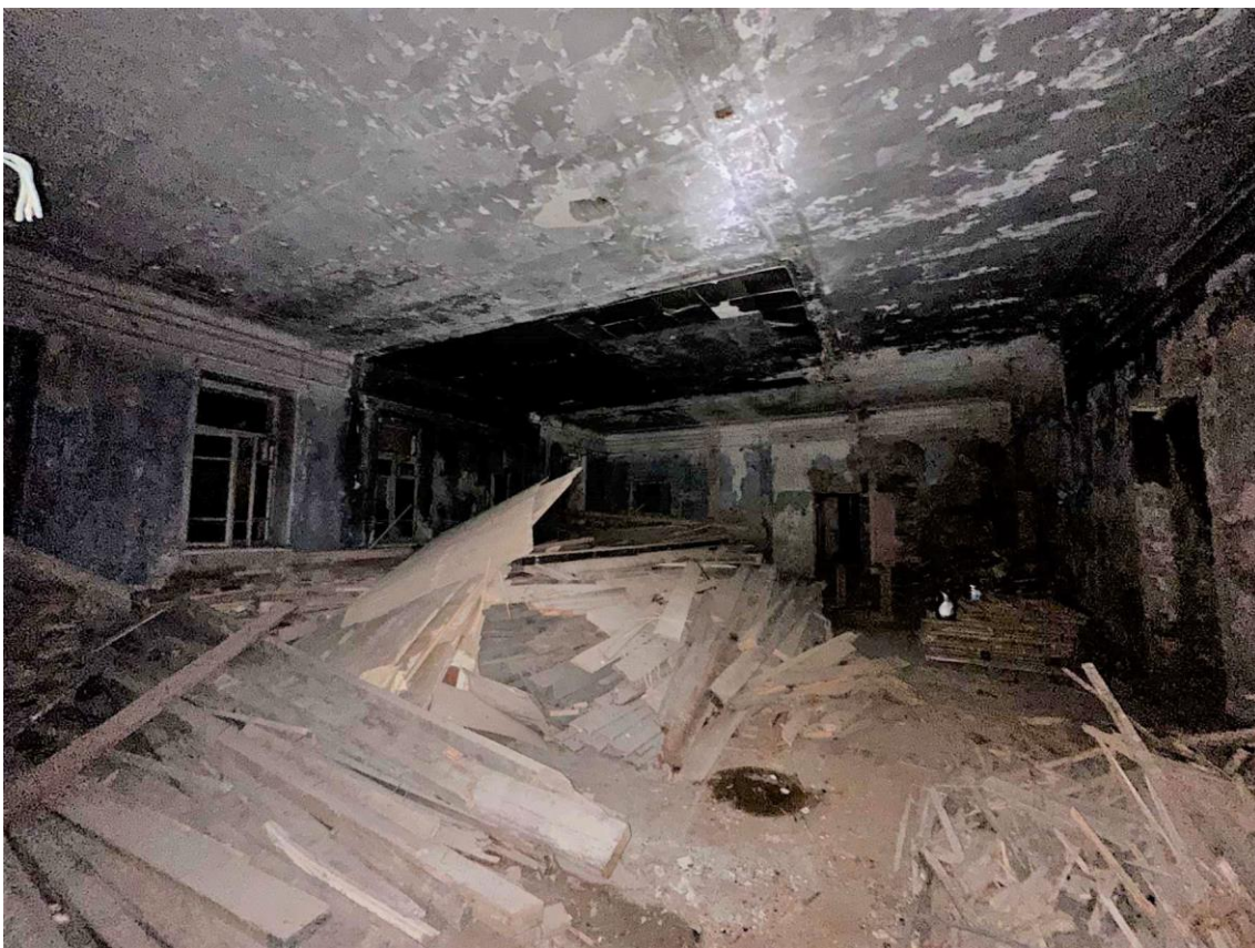
Фото 37. Пом. 1.13 – 1.18, 1.21. Общий вид помещения с северо-запада. Дата съемки: 28.12.2022 г. Автор съемки: Глинская Н.Б.
