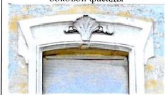
Сандрики проемов 2-го этажа (С-В и Ю-В боковой фасады)
