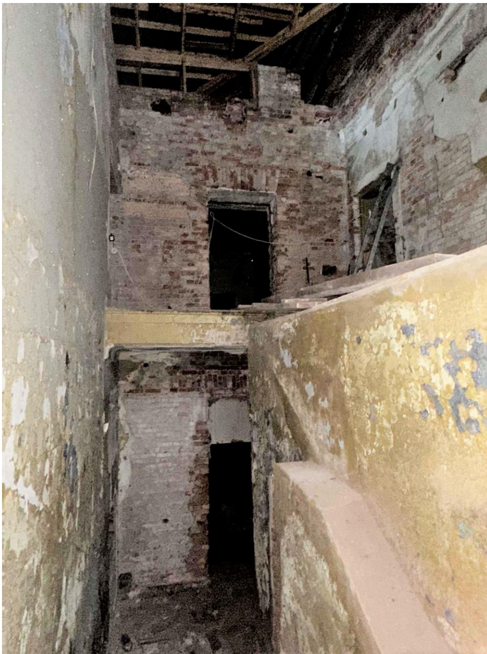
Фото 64. Общий вид лестничной клетки ЛК-1 с юго-востока. Дата съемки: 28.12.2022 г. Автор съемки: Глинская Н.Б.
