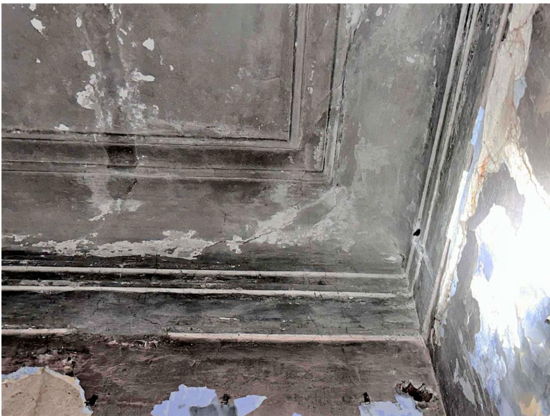
Фото 39. Пом. 1.18. Фрагмент потолочного карниза. Дата съемки: 28.12.2022 г. Автор съемки: Глинская Н.Б.
