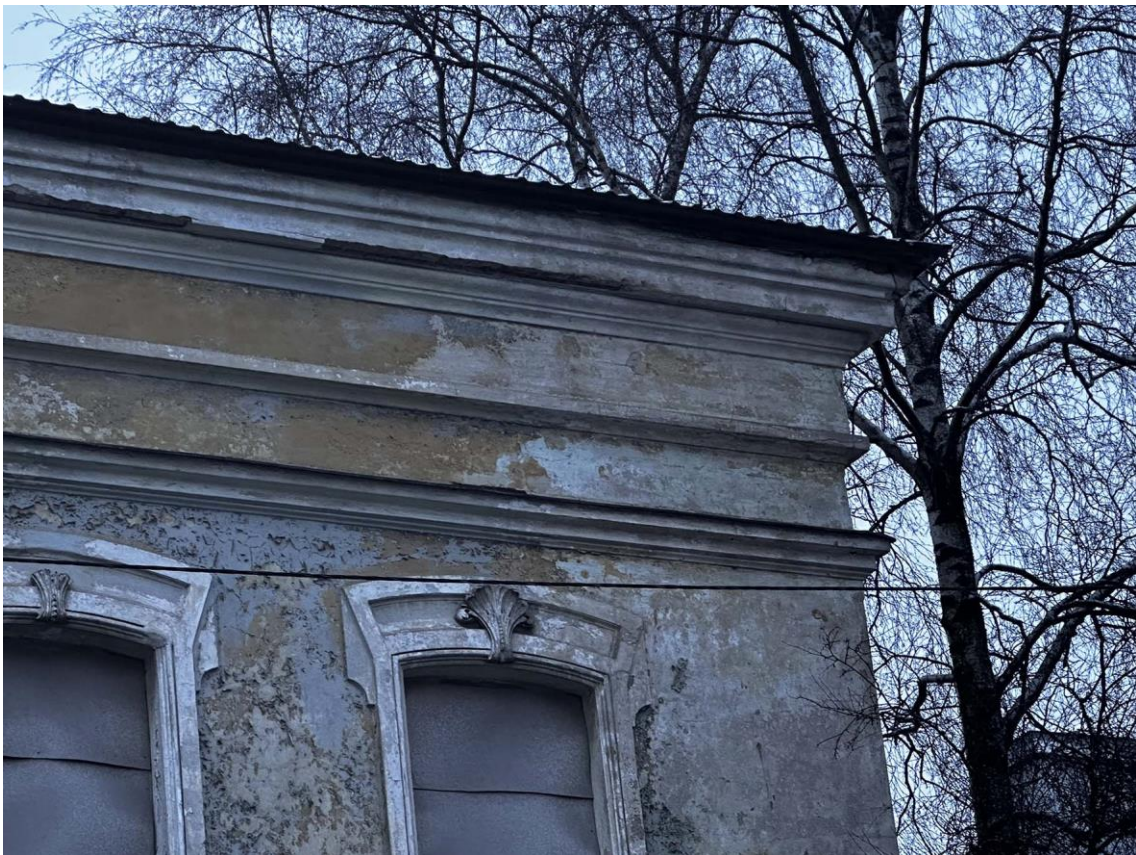
Фото 10. Фрагмент лицевого северо-восточного фасада. Венчающий карниз в правой части. Дата съемки: 28.12.2022 г. Автор съемки: Глинская Н.Б.
