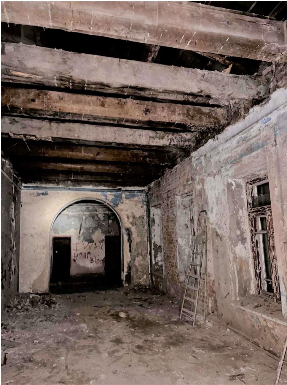
Фото 60. Пом. 2.13. Общий вид помещения с северо-запада. Дата съемки: 28.12.2022 г. Автор съемки: Глинская Н.Б.
