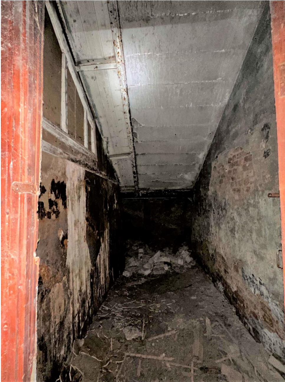
Фото 27. Пом. 1.7. Общий вид помещения с юго-востока. Дата съемки: 28.12.2022 г. Автор съемки: Глинская Н.Б.
