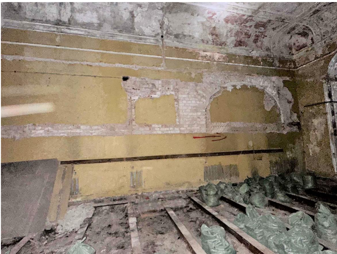
Фото 50. Пом. 2.4. Вид на юго-западную стену. Дата съемки: 28.12.2022 г. Автор съемки: Глинская Н.Б.
