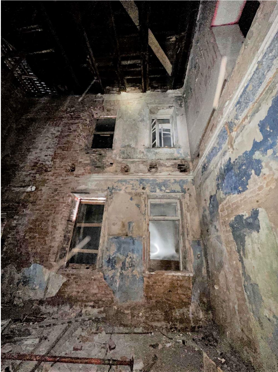
Фото 41. Пом. 1.20. Общий вид помещения с северо-востока. Дата съемки: 28.12.2022 г. Автор съемки: Глинская Н.Б.
