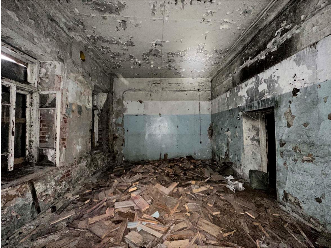
Фото 34. Пом. 1.12. Общий вид помещения с юго-востока. Дата съемки: 28.12.2022 г. Автор съемки: Глинская Н.Б.
