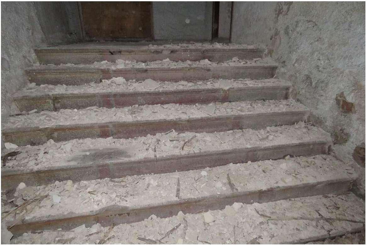
Фото 61. Пом. 1.25. Общий вид входной парадной лестницы. Дата съемки: 28.12.2022 г. Автор съемки: Глинская Н.Б.
