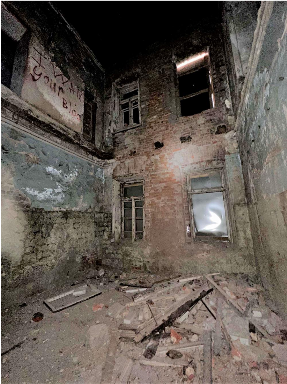
Фото 40. Пом. 1.19. Общий вид помещения с северо-востока. Дата съемки: 28.12.2022 г. Автор съемки: Глинская Н.Б.
