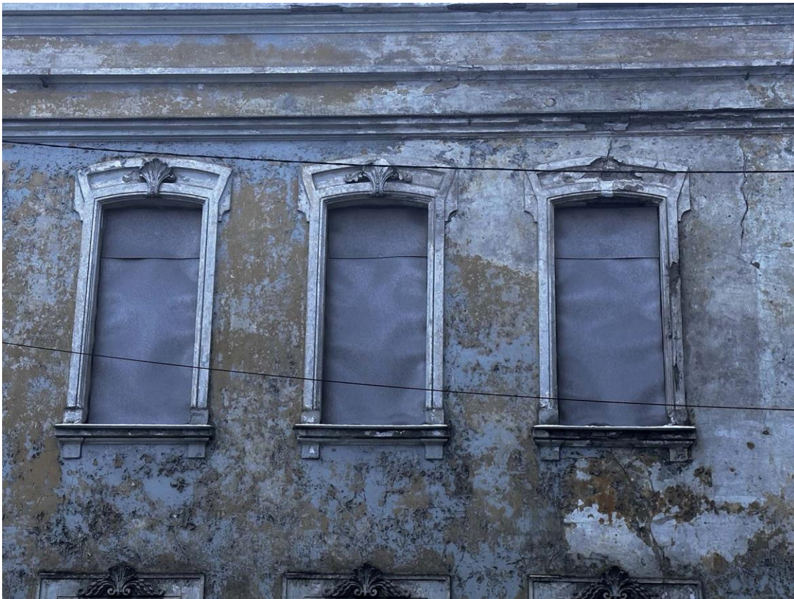
Фото 7. Фрагмент лицевого северо-восточного фасада. Центральная часть 2-го этажа. Дата съемки: 28.12.2022 г. Автор съемки: Глинская Н.Б.
