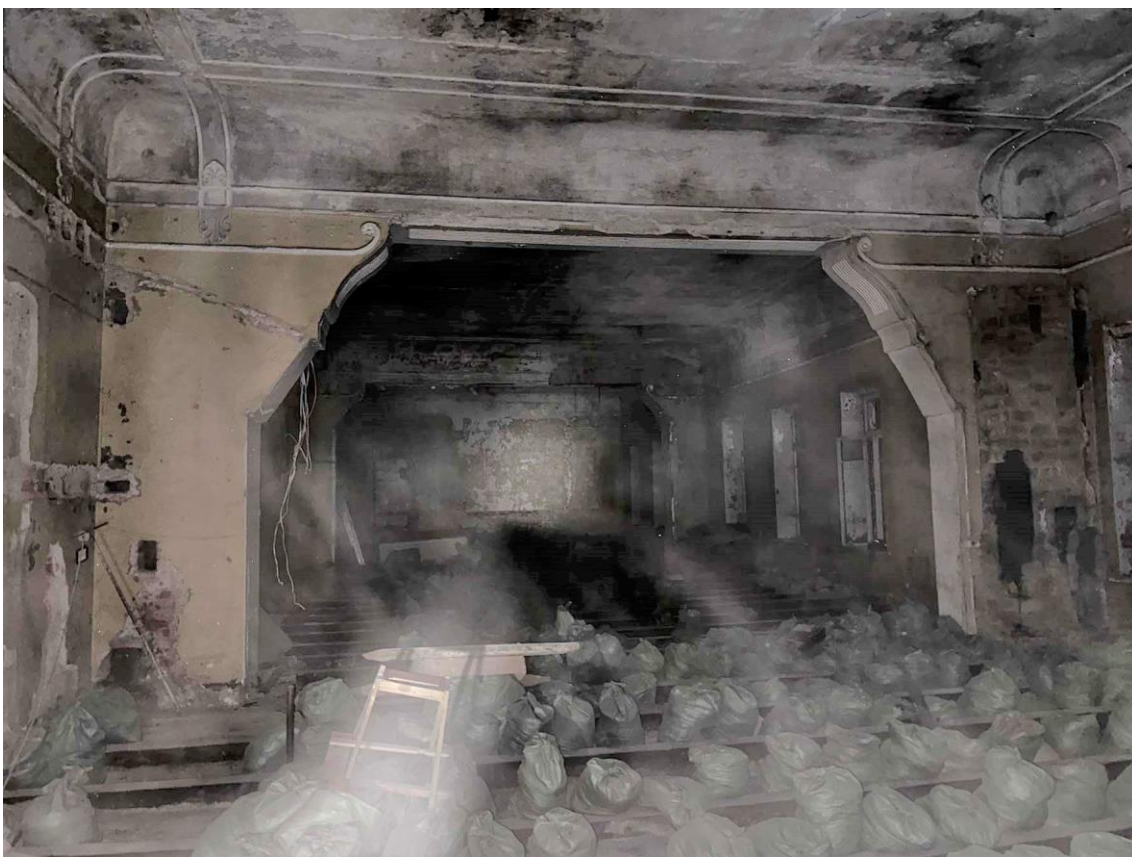
Фото 53. Пом. 2.5. Общий вид декоративной перегородки между пом. 2.4 и 2.5. Дата съемки: 28.12.2022 г. Автор съемки: Глинская Н.Б.
