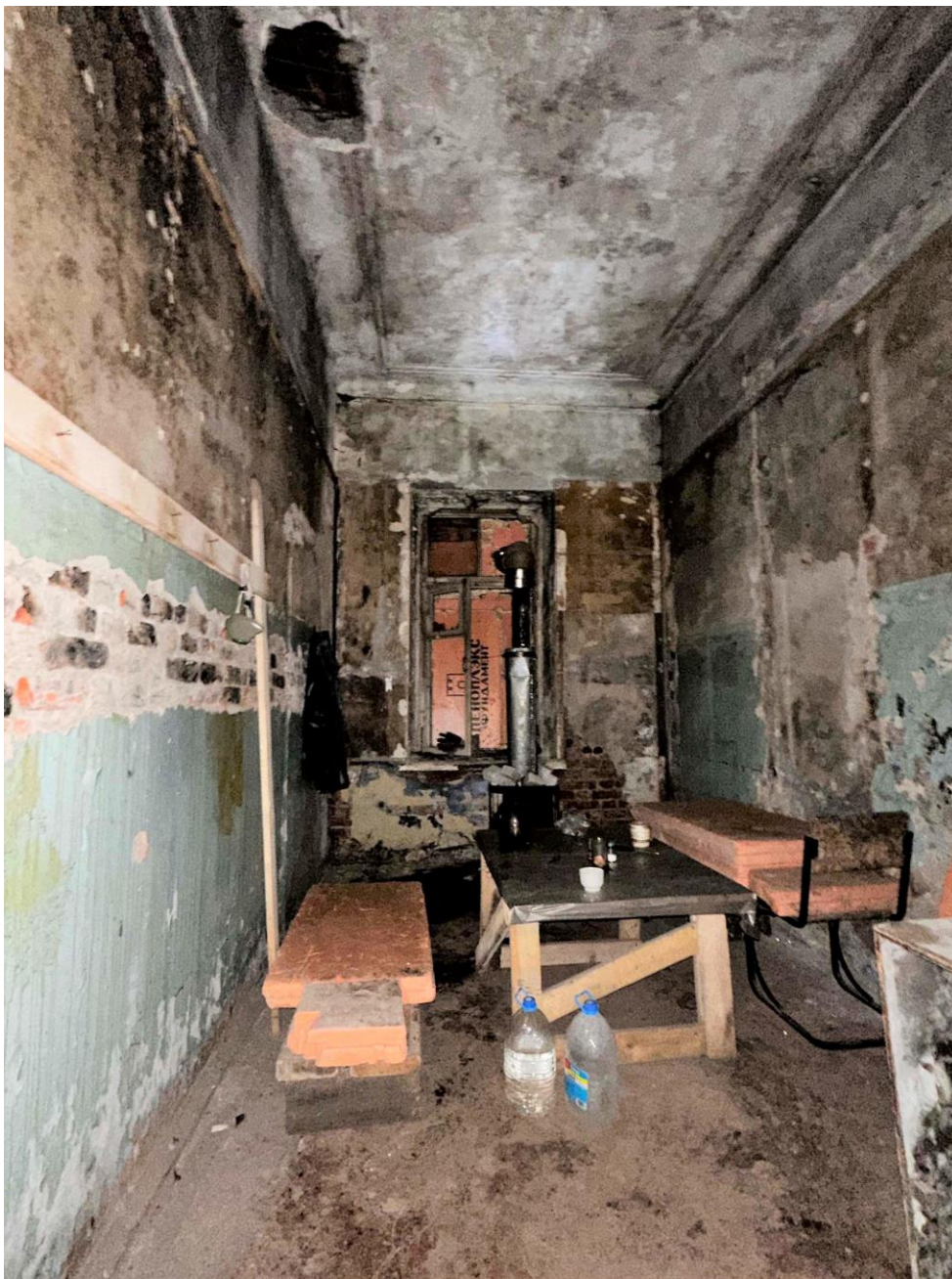
Фото 31. Пом. 1.11. Общий вид помещения с северо-востока. Дата съемки: 28.12.2022 г. Автор съемки: Глинская Н.Б.
