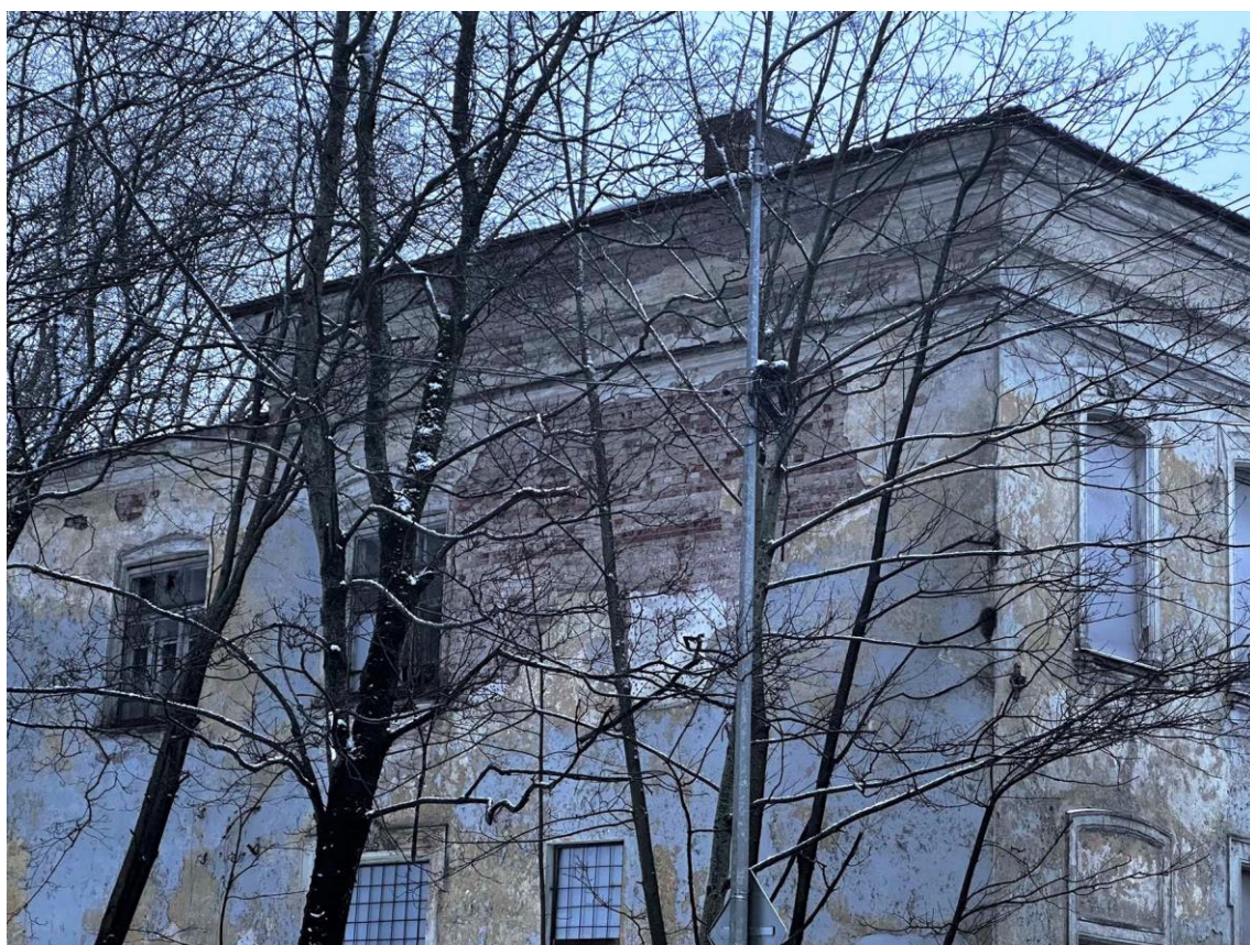
Фото 20. Фрагмент правой части юго-восточного фасада юго-восточной исторической пристройки здания. Дата съемки: 28.12.2022 г. Автор съемки: Глинская Н.Б.
