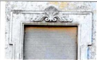
Верхняя часть оформления проемов 1-го этажа. С-В и Ю-В боковой фасады
