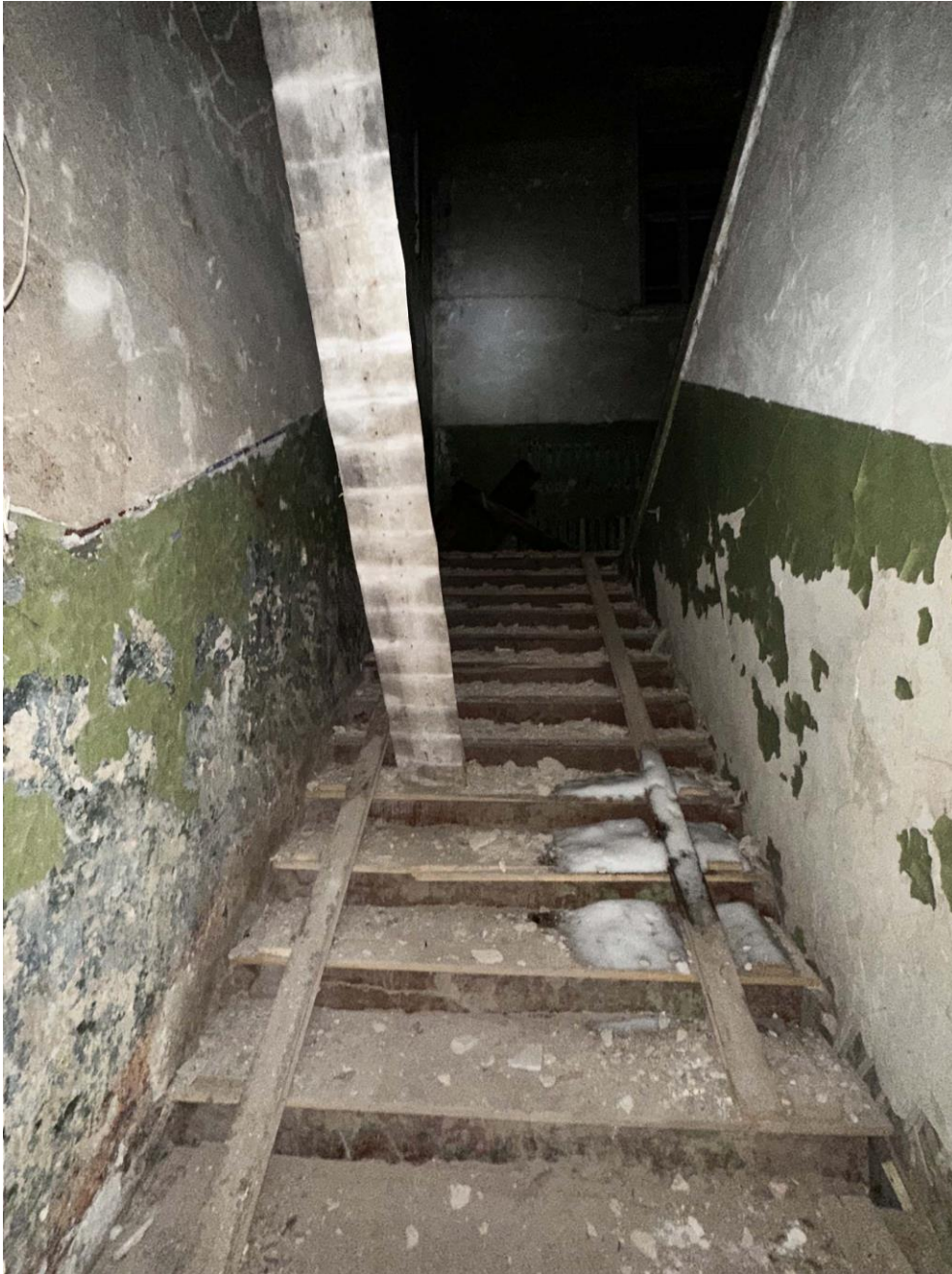
Фото 68. Нижний марш лестничной клетки ЛК-2 со стороны пом. 1.6. Дата съемки: 28.12.2022 г. Автор съемки: Глинская Н.Б.
