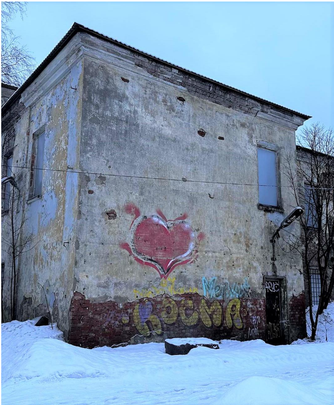
Фото 16. Общий вид юго-западного фасада северо-западной исторической пристройки здания с запада. Дата съемки: 28.12.2022 г. Автор съемки: Глинская Н.Б.
