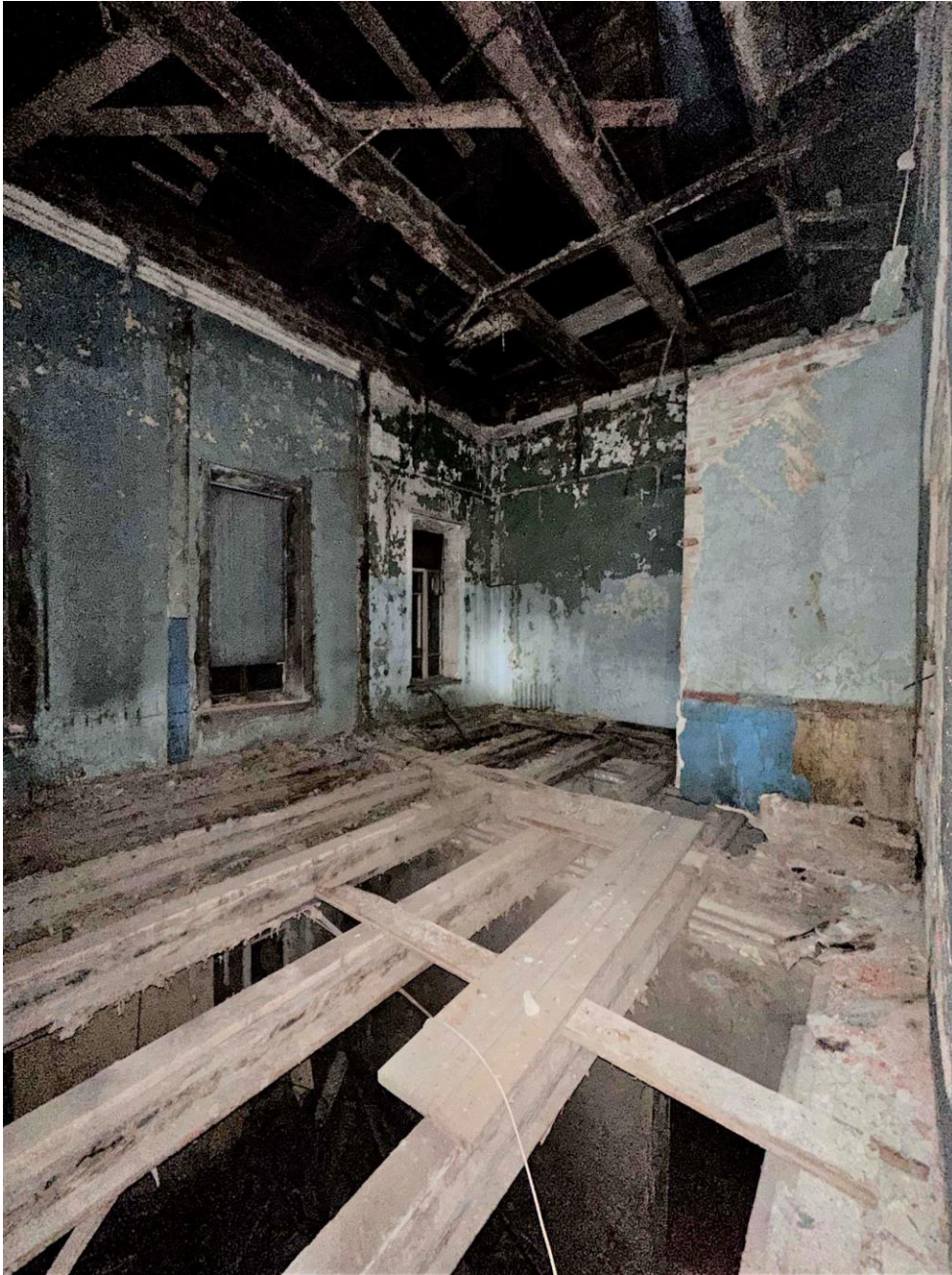
Фото 58. Пом. 2.7 – 2.10. Общий вид помещений с запада. Дата съемки: 28.12.2022 г. Автор съемки: Глинская Н.Б.
