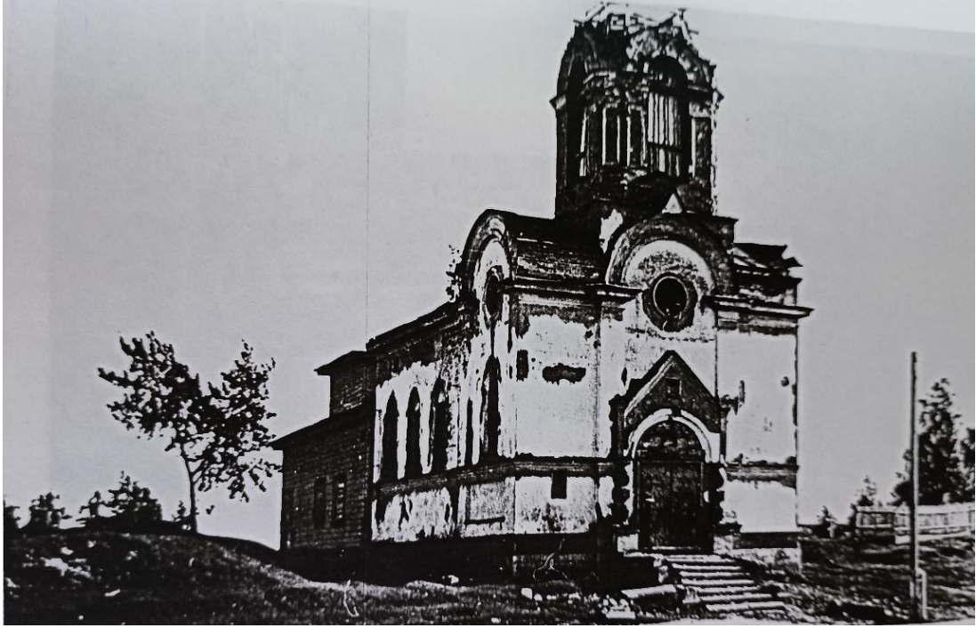
17. Церковь Св. Георгия (Суворовская) в Новой Ладоге. Вид с северо-запада. Фотография. 1950-е гг. Архив Ленинградского филиала проектного института по реставрации памятников истории и культуры «Спецпроектреставрация» (Материалы в ЦГА НТД СПб (Архив Института находится в обработке, доступ ограничен) и в Архиве Департамента по охране объектов культурного наследия Ленинградской области).
