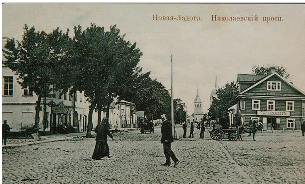
3. Новая Ладога. Вид Николаевского проспекта. Фотография. Начало XX в.
