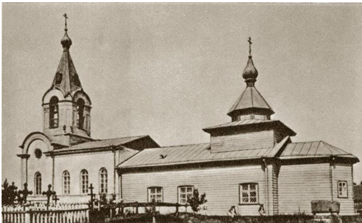
11. Церковь Св. Георгия (Суворовская) в Новой Ладогe. Общий вид (южный фасад). Фотография. 1912 г. ИИМК РАН. Булкин В.А., Овсянников О.В. По Неве и Волхову. Л., 1981. С. 41.
