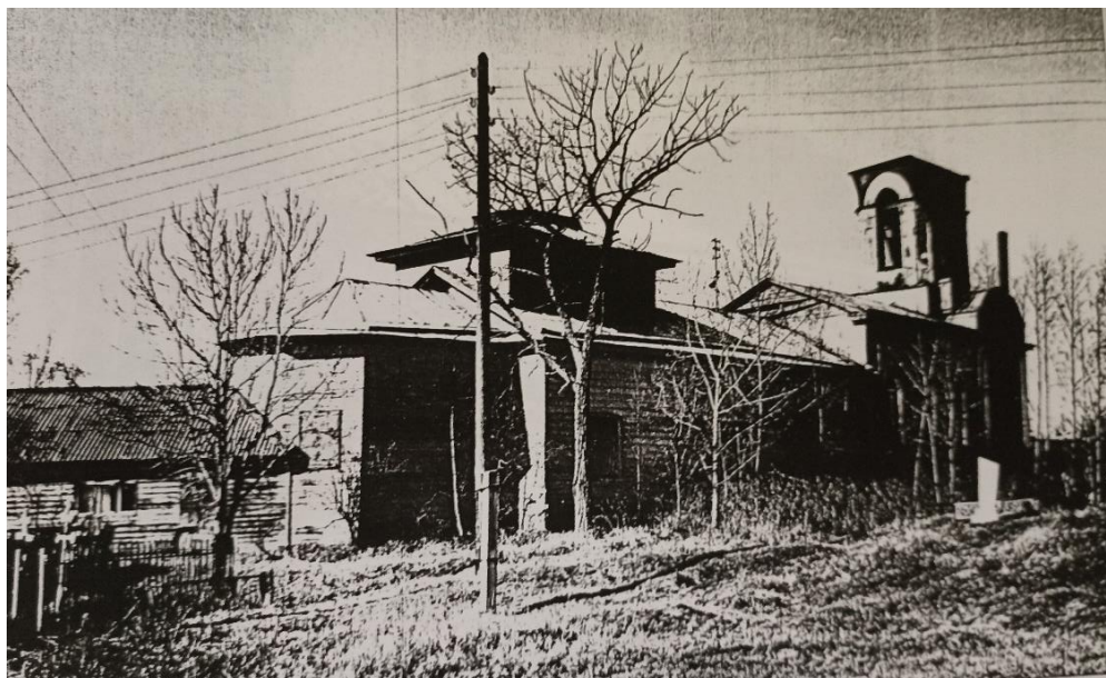
24. Церковь Св. Георгия (Суворовская) в Новой Ладоге. Общий вид с северо-востока. Фотография. 1986 г. Архив Ленинградского филиала проектного института по реставрации памятников истории и культуры «Спецпроектреставрация» (Материалы в ЦГА НТД СПб (Архив Института находится в обработке, доступ ограничен) и в Архиве Департамента по охране объектов культурного наследия Ленинградской области).
