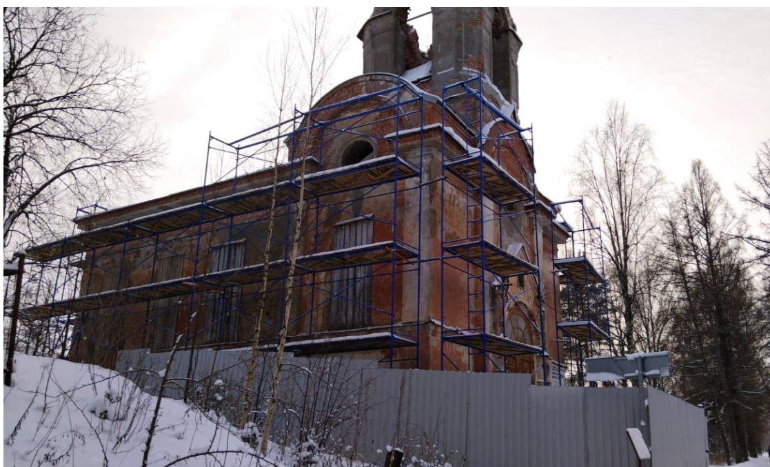
3. Объект культурного наследия регионального значения «Церковь Георгия «Суворовская» (деревянная), XVIII в.» по адресу: Ленинградская область, Волховский район, г. Новая Ладога, ул. Суворова, д. 14Б. Вид на северный фасад.
