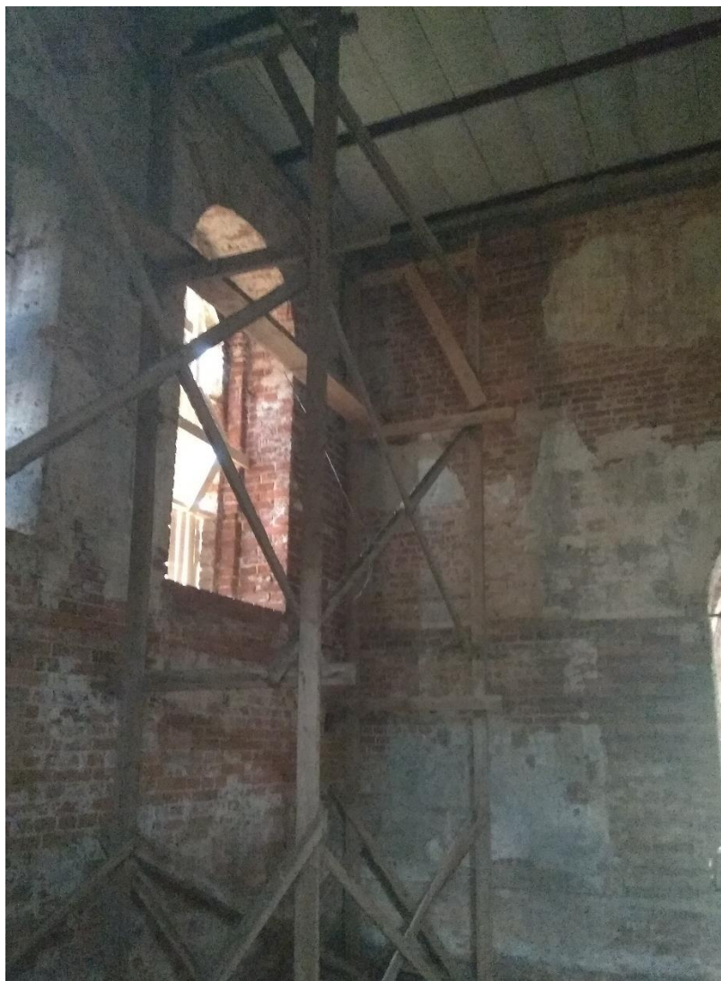
9. Объект культурного наследия регионального значения «Церковь Георгия «Суворовская» (деревянная), XVIII в.» по адресу: Ленинградская область, Волховский район, г. Новая Ладога, ул. Суворова, д. 14Б. Каменная часть церкви. Фрагмент интерьера.
