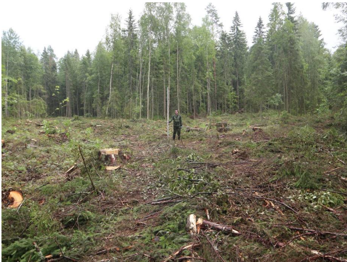
Рис.27. Общий вид территории проектирования линейного объекта. Точка фотофиксации 9. Вид на восток.
