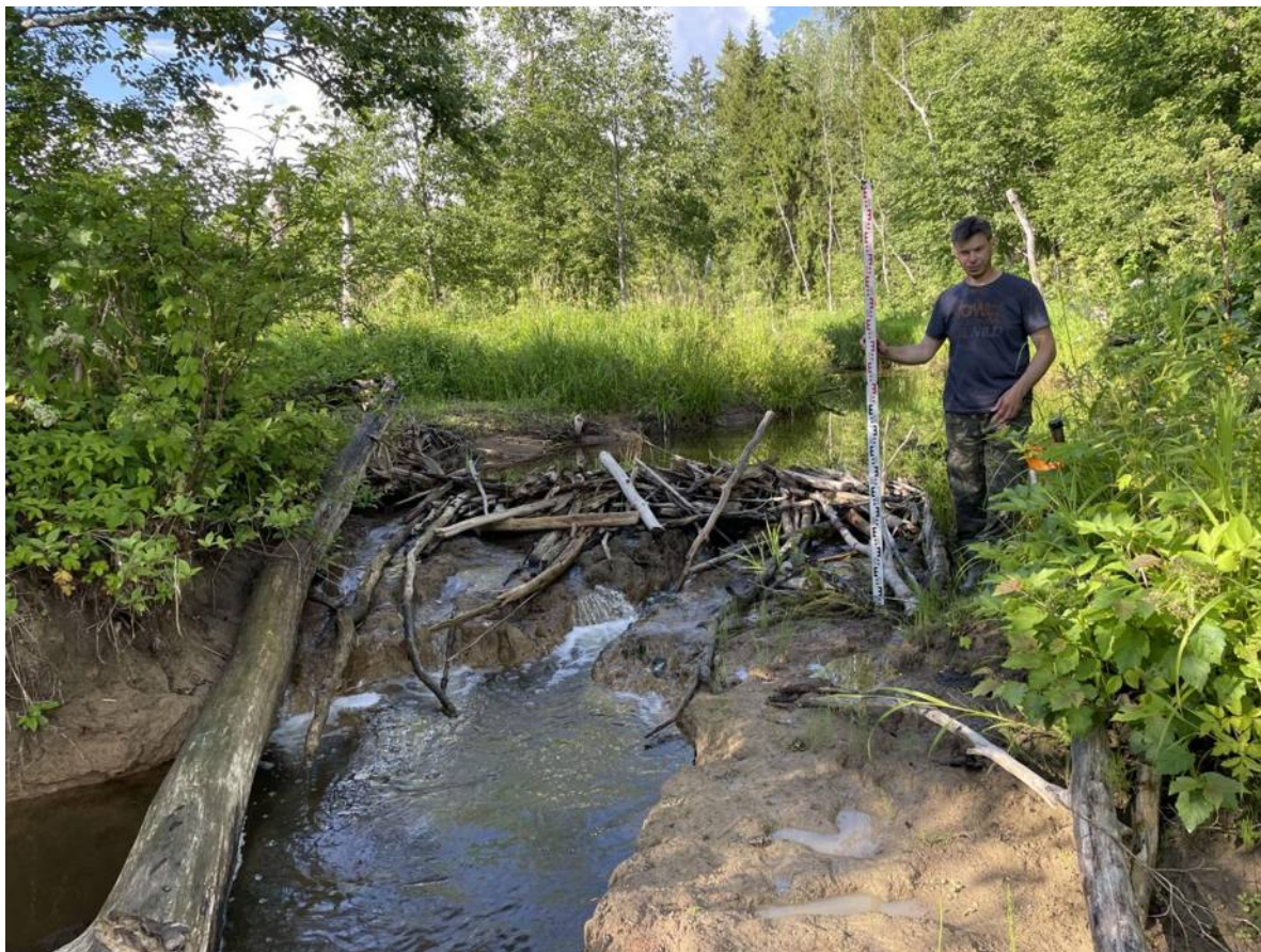
Рис. 51. Общий вид территории проектирования линейного объекта. Точка фотофиксации 33. Вид на север.
