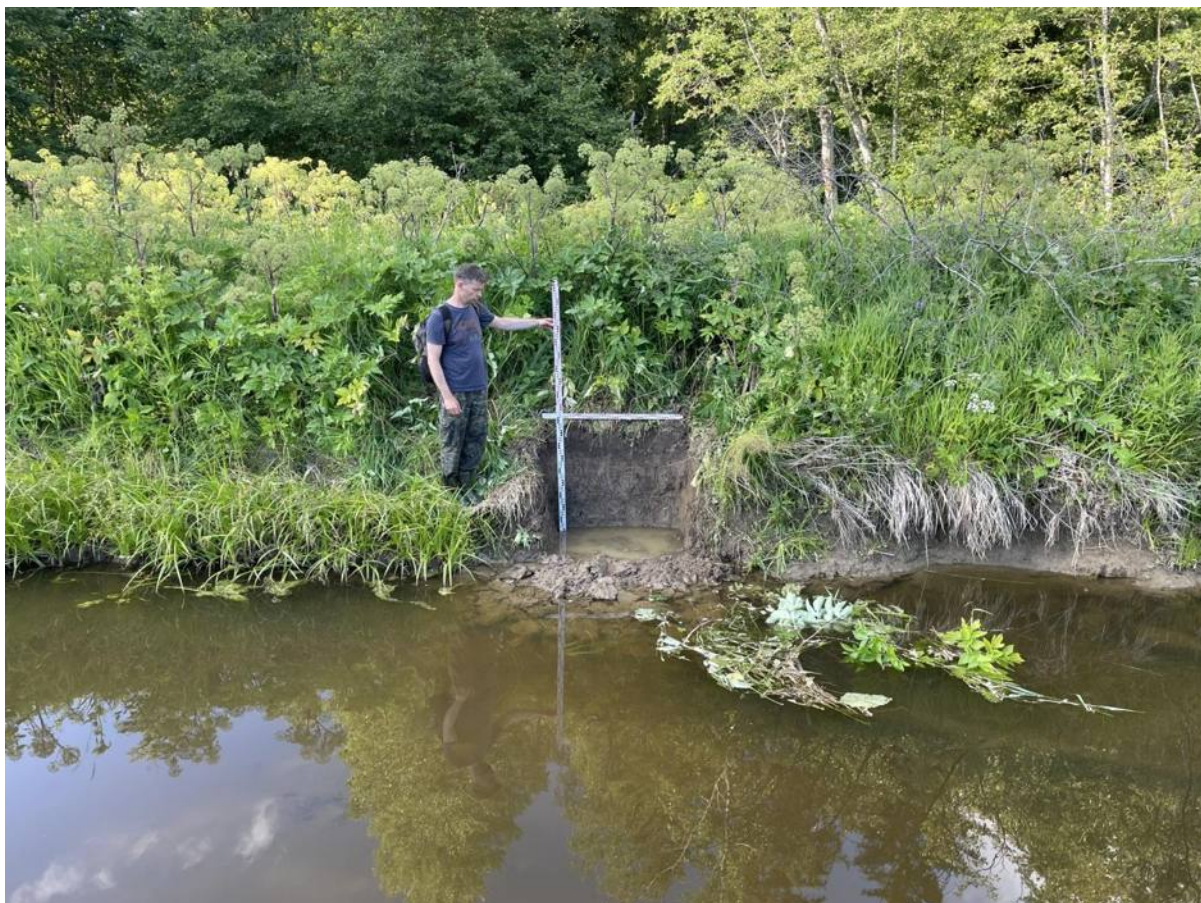
Рис.177. Зачистка 25. Общий вид после окончания работ. Вид на северо-восток.
