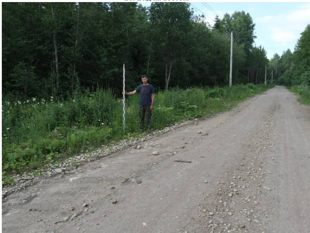
Рис. 40. Общий вид территории проектирования линейного объекта. Точка фотофиксации 22. Вид на север.
