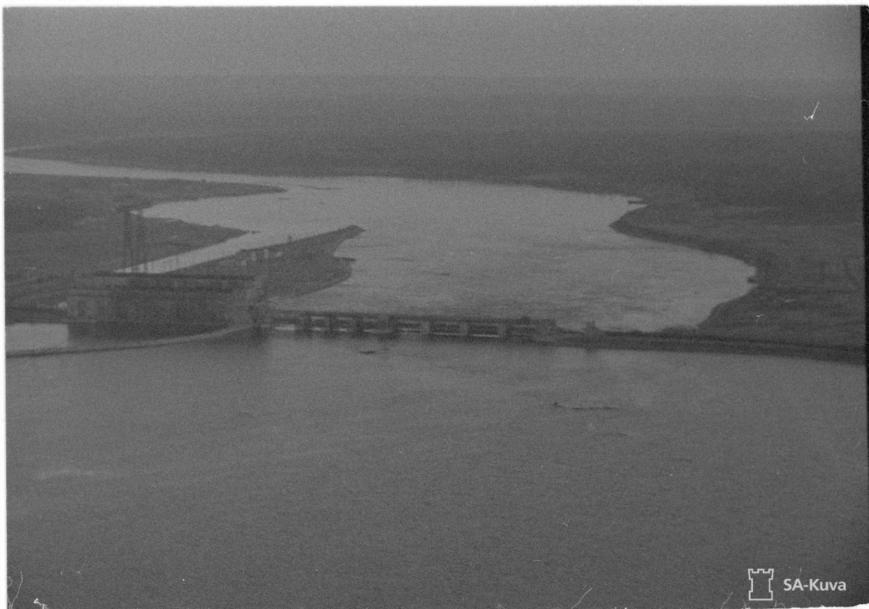
Илл. 11. Вид на ГЭС. Фото 1943 года.
