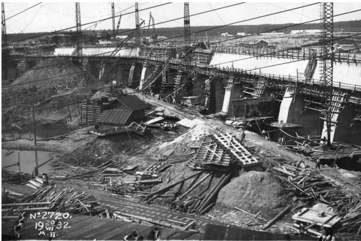
Илл. 5. Фото 1932 год. Строительство ледозащитной стенки
