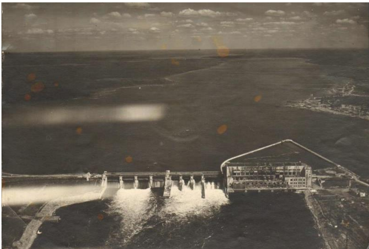
Илл. 13. Панорамный аэрофотоснимок разрушенной Нижне-Свирской ГЭС (здание силовой станции и плотина). 1944 г. // Лодейнопольский филиал Государственного бюджетного учреждения культуры Ленинградской области "Музейное агентство" - Лодейнопольский историко-краеведческий музей // https://goskatalog.ru/
