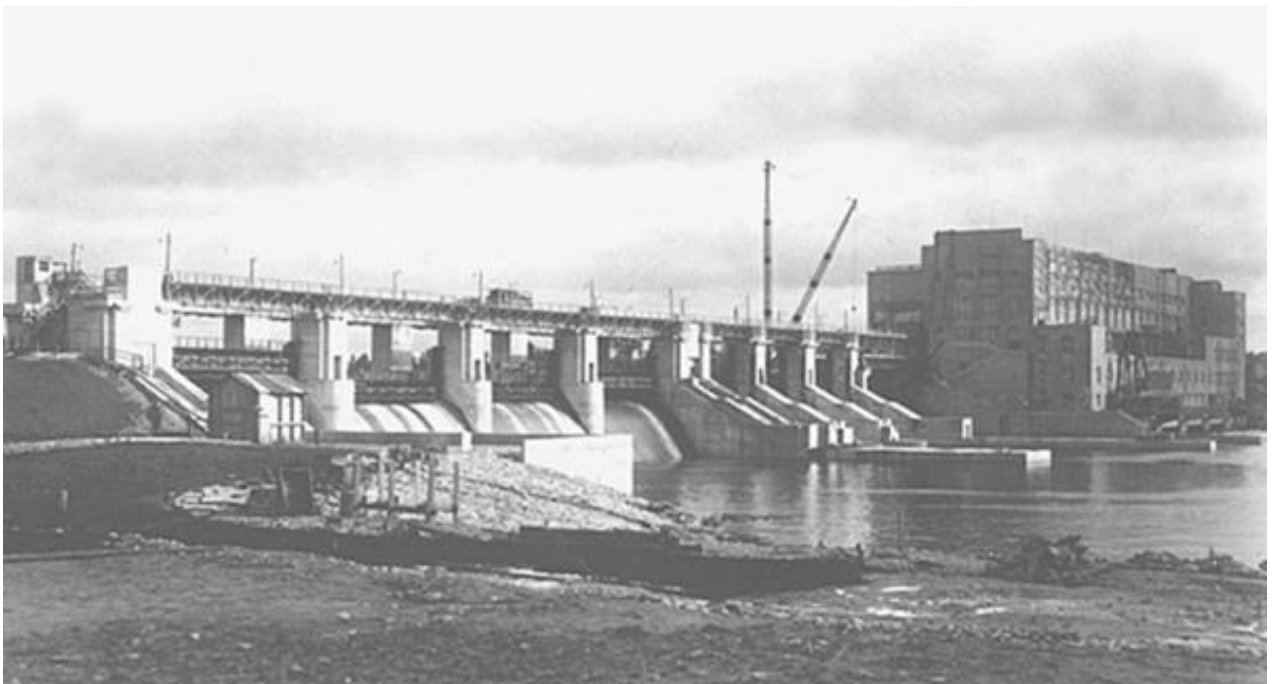
Илл. 8. Строительство ГЭС. Фото 1934 год
