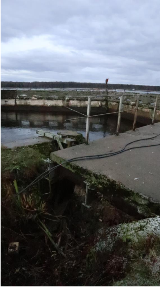
Фото 5. Переход с причальной стенки на устой ледозащитной стенки
