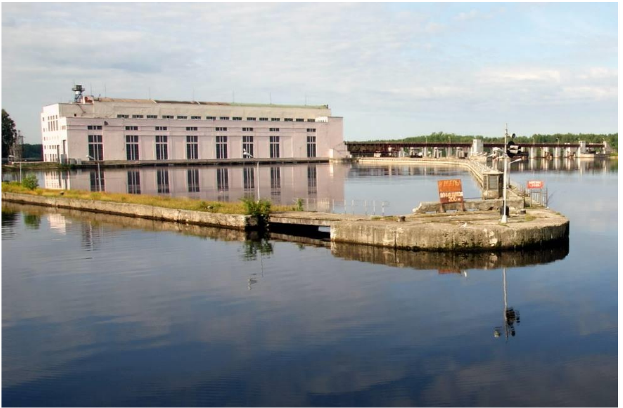
Илл. 20. Современный вид причальной стенки и устоя.
