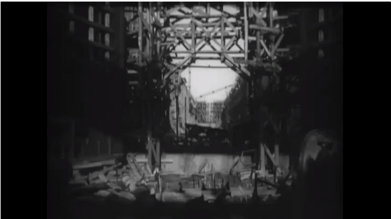
Илл. 4. Кадр из документальной ленты «Пуск ГЭС на Свири». Процесс строительства шлюза. 1932 год.
