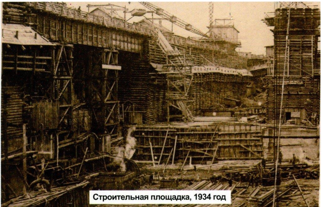
Илл. 7. Строительство ГЭС. Фото 1934 год.
