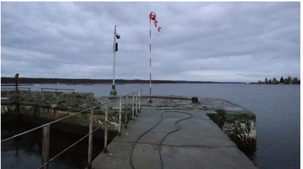
Фото 4. Устой ледозащитной стенки
