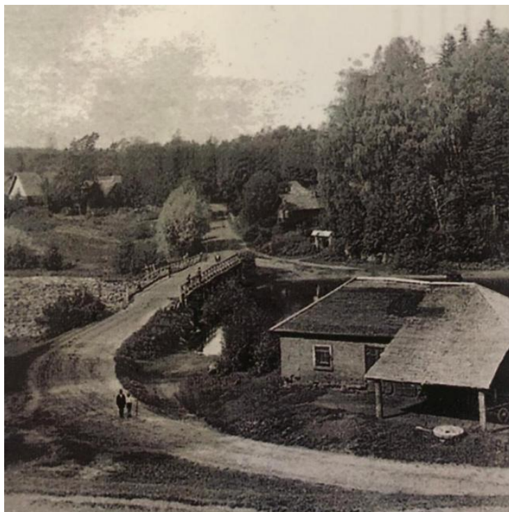
Илл. 22. Вид на кузницу, мост через реку, старое кладбище. Нач. XX века.
