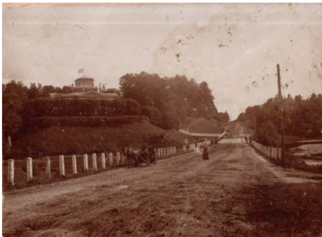
Илл. 32. Вид на усадьбу с главной дороги, фото 1900-х гг
