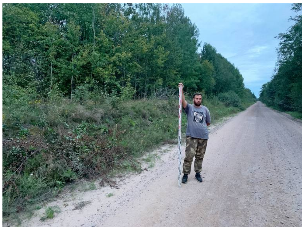
Илл. 133. Ленинградская обл., Кировский район, Газопровод межпоселковый к д. Кобона Кировского района Ленинградской области. Точка фотофиксации №16. Вид с С-СЗ.
