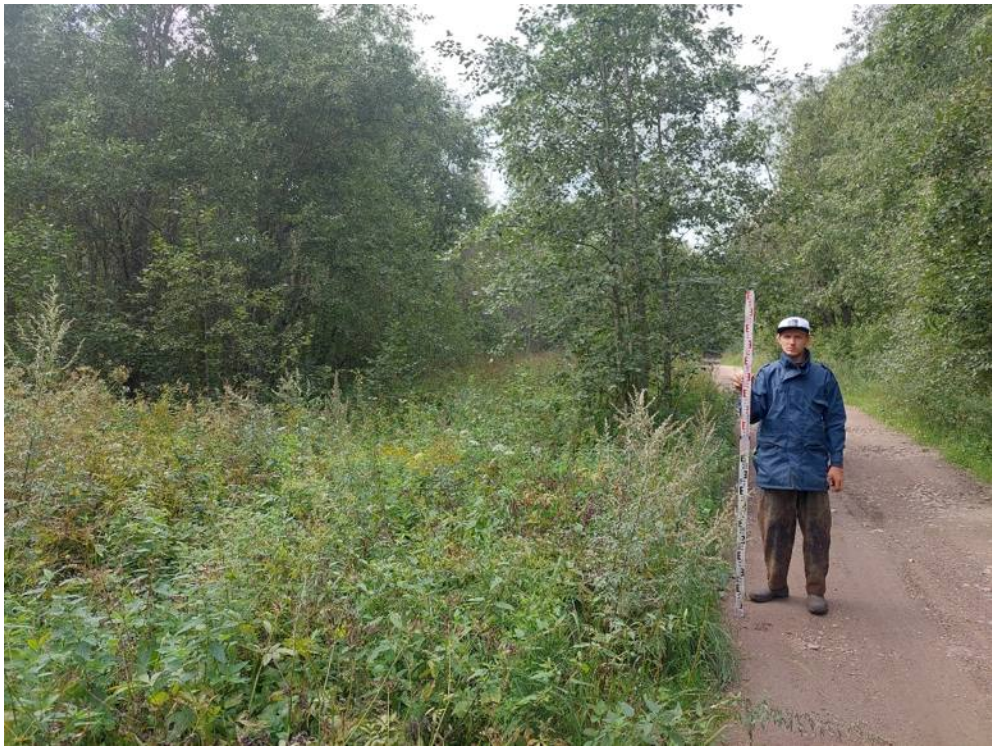
Илл. 20. Ленинградская обл., Кировский район, Газопровод межпоселковый к д. Кобона Кировского района Ленинградской области. Точка фотофиксации №3. Вид с СВ.
