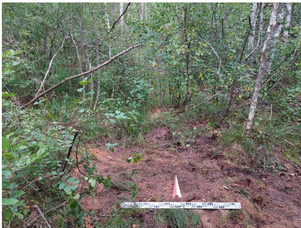
Илл. 72. Ленинградская обл., Кировский район, Газопровод межпоселковый к д. Кобона Кировского района Ленинградской области. Шурф №8. Засыпка. Вид с Ю.
