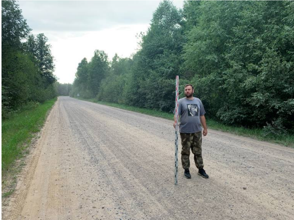
Илл. 110. Ленинградская обл., Кировский район, Газопровод межпоселковый к д. Кобона Кировского района Ленинградской области. Точка фотофиксации №11. Вид с В.
