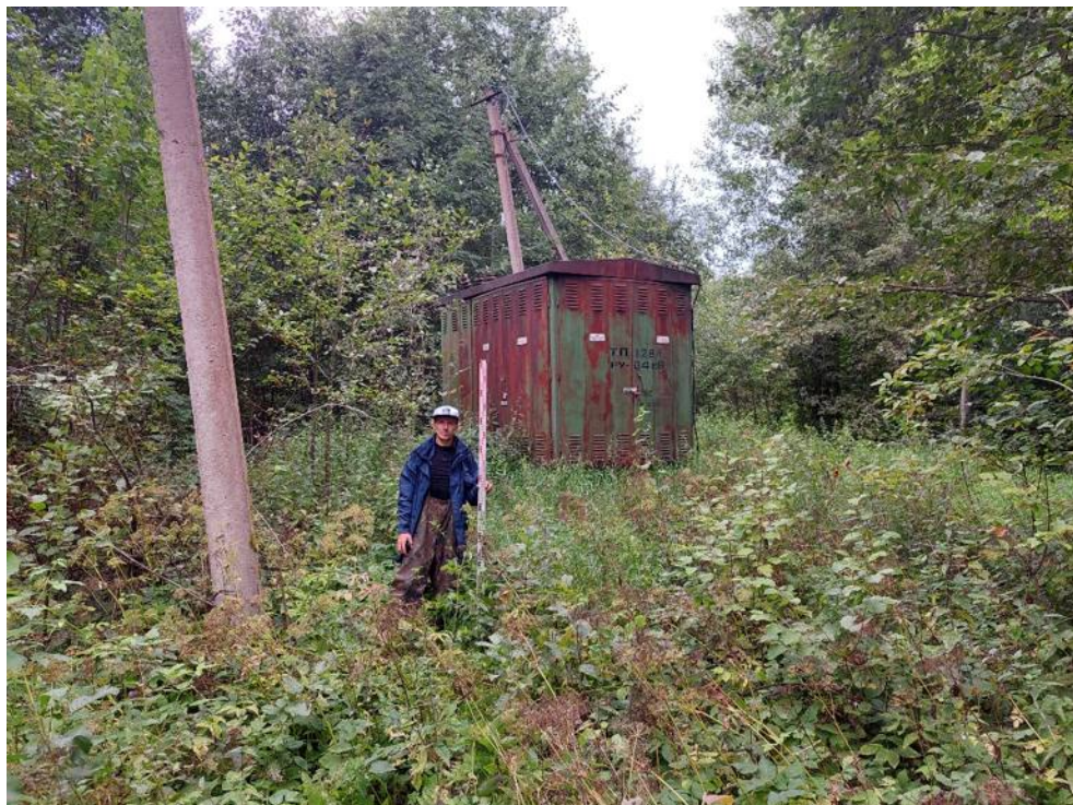
Илл. 79. Ленинградская обл., Кировский район, Газопровод межпоселковый к д. Кобона Кировского района Ленинградской области. Точка фотофиксации №9. Вид с ЮВ.
