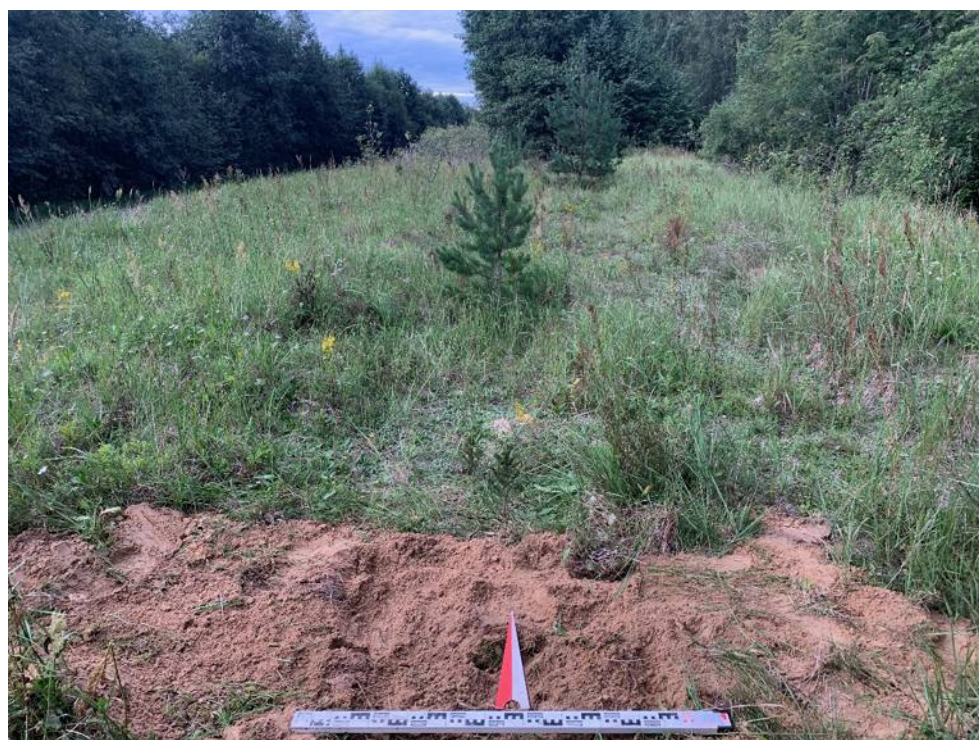
Илл. 125. Ленинградская обл., Кировский район, Газопровод межпоселковый к д. Кобона Кировского района Ленинградской области. Шурф №15. Засыпка. Вид с Ю.
