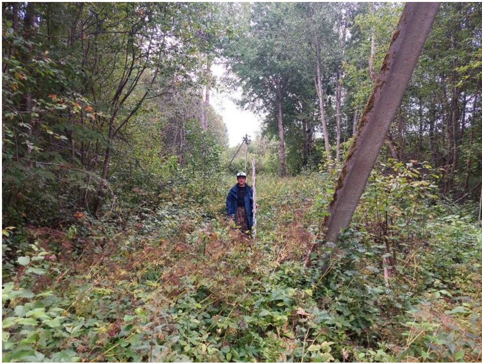
Илл. 78. Ленинградская обл., Кировский район, Газопровод межпоселковый к д. Кобона Кировского района Ленинградской области. Точка фотофиксации №9. Вид с СЗ.
