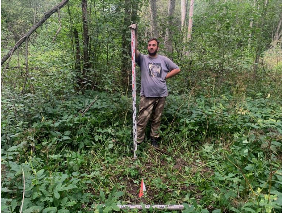
Илл. 100. Ленинградская обл., Кировский район, Газопровод межпоселковый к д. Кобона Кировского района Ленинградской области. Шурф №13. Местоположение. Вид с Ю.
