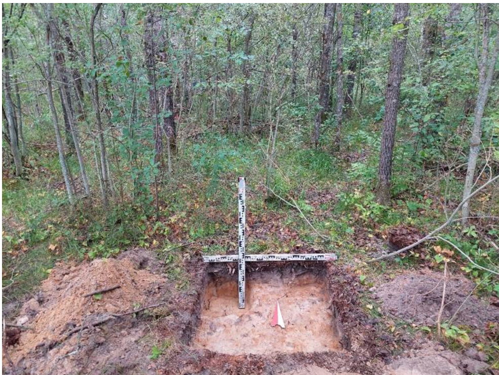
Илл. 57. Ленинградская обл., Кировский район, Газопровод межпоселковый к д. Кобона Кировского района Ленинградской области. Шурф №7. Вскрытый. Вид с Ю.
