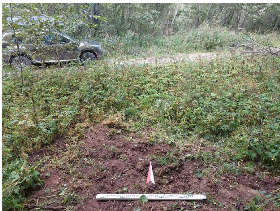
Илл. 55. Ленинградская обл., Кировский район, Газопровод межпоселковый к д. Кобона Кировского района Ленинградской области. Шурф №6. Засыпка. Вид с Ю.
