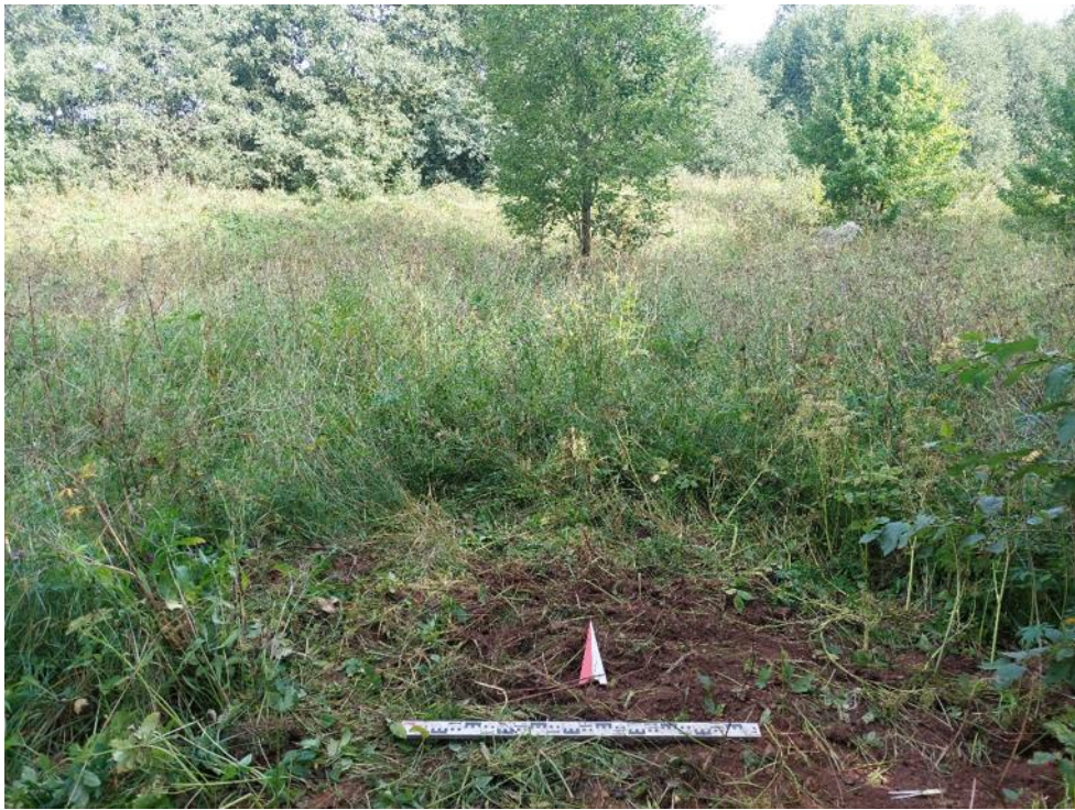
Илл. 30. Ленинградская обл., Кировский район, Газопровод межпоселковый к д. Кобона Кировского района Ленинградской области. Шурф №1. Засыпка. Вид с Ю.
