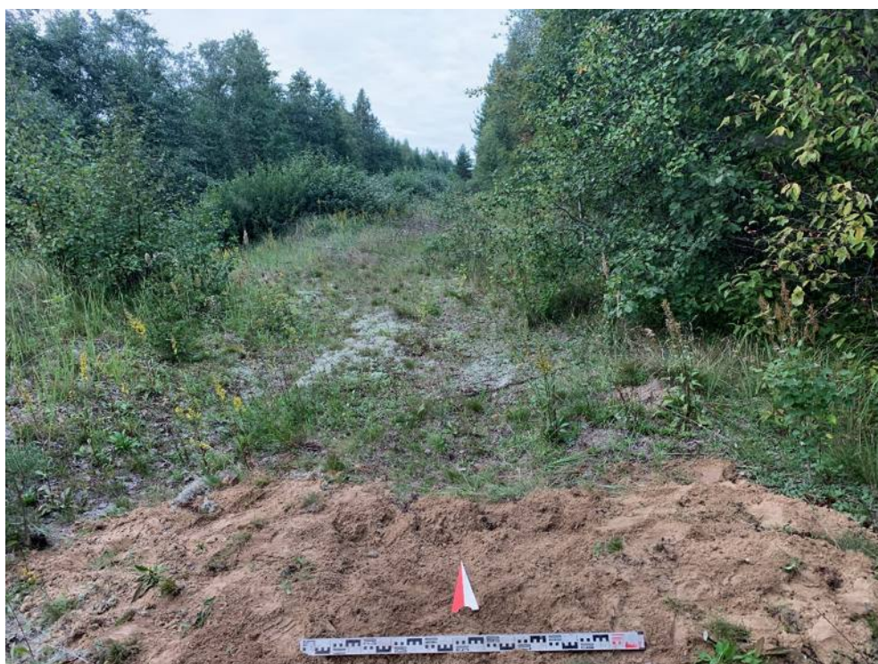
Илл. 143. Ленинградская обл., Кировский район, Газопровод межпоселковый к д. Кобона Кировского района Ленинградской области. Шурф №16. Засыпка. Вид с Ю.
