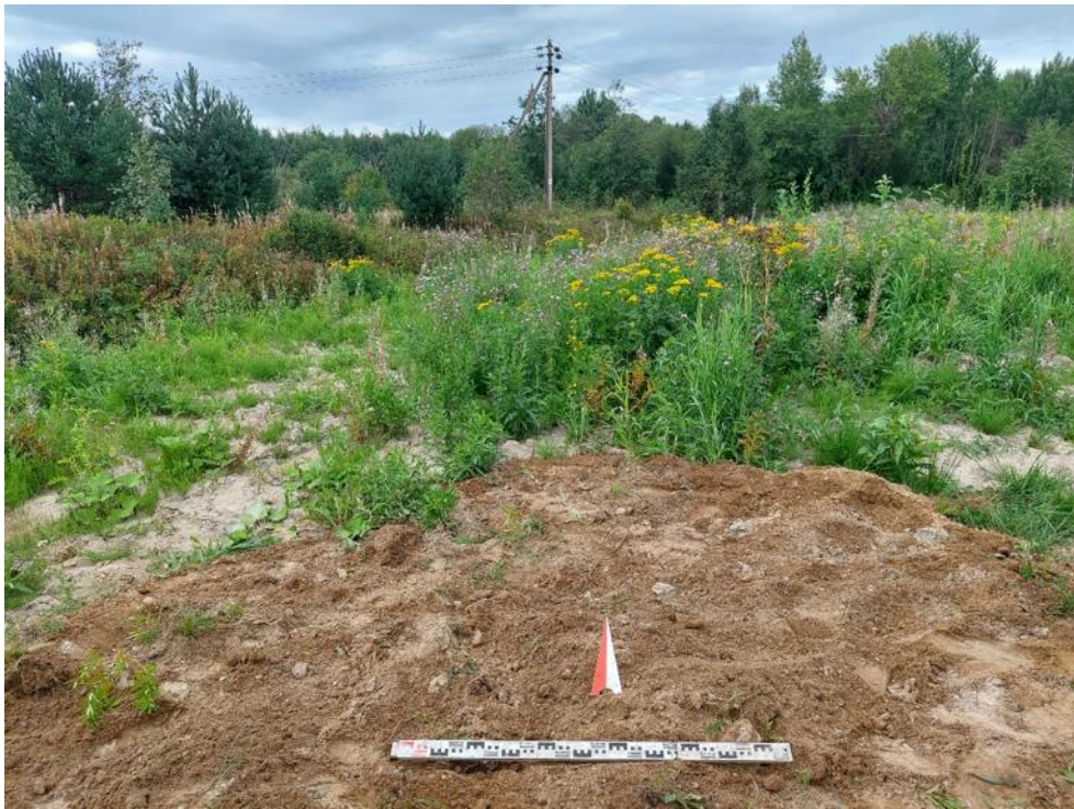
Илл. 84. Ленинградская обл., Кировский район, Газопровод межпоселковый к д. Кобона Кировского района Ленинградской области. Шурф №9. Засыпка. Вид с Ю.
