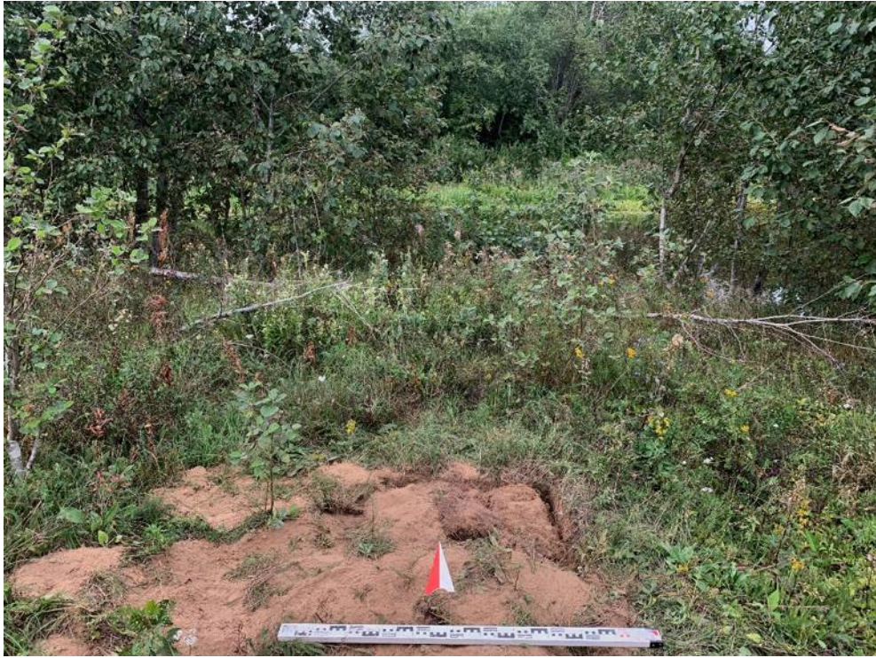
Илл. 94. Ленинградская обл., Кировский район, Газопровод межпоселковый к д. Кобона Кировского района Ленинградской области. Шурф №11. Засыпка. Вид с Ю.
