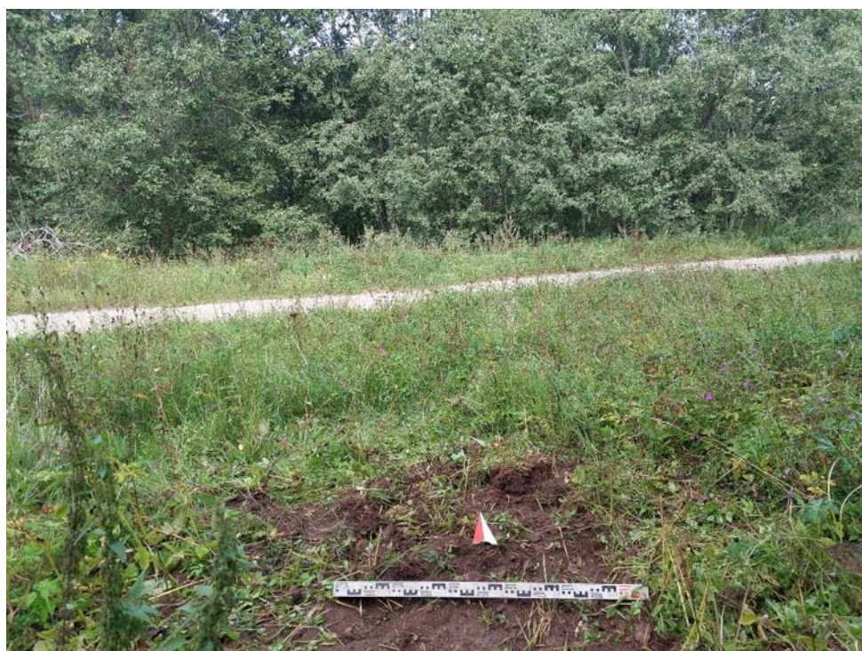
Илл. 45. Ленинградская обл., Кировский район, Газопровод межпоселковый к д. Кобона Кировского района Ленинградской области. Шурф №4. Засыпка. Вид с Ю.
