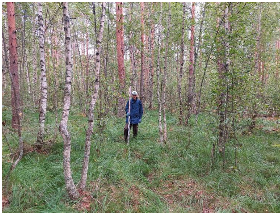
Илл. 64. Ленинградская обл., Кировский район, Газопровод межпоселковый к д. Кобона Кировского района Ленинградской области. Точка фотофиксации №6. Вид с ЮЗ.
