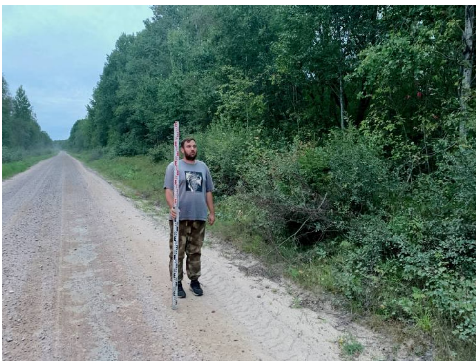
Илл. 131. Ленинградская обл., Кировский район, Газопровод межпоселковый к д. Кобона Кировского района Ленинградской области. Точка фотофиксации №15. Вид с Ю-ЮЗ.
