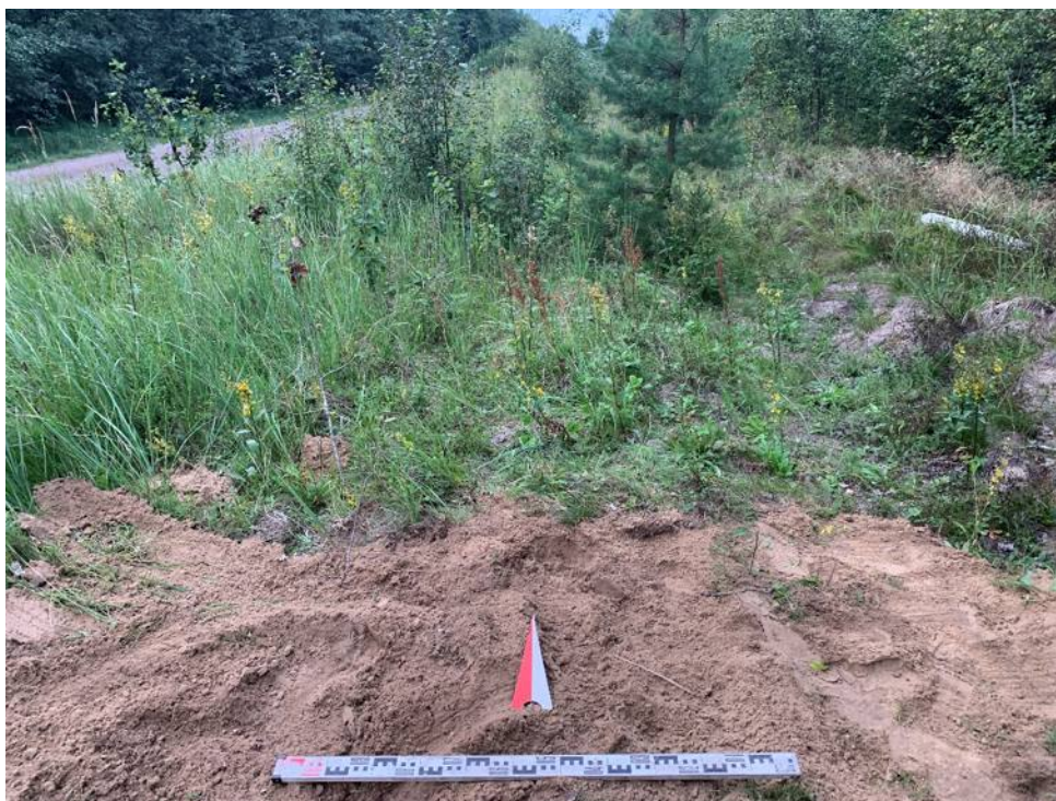
Илл. 148. Ленинградская обл., Кировский район, Газопровод межпоселковый к д. Кобона Кировского района Ленинградской области. Шурф №17. Засыпка. Вид с Ю.
