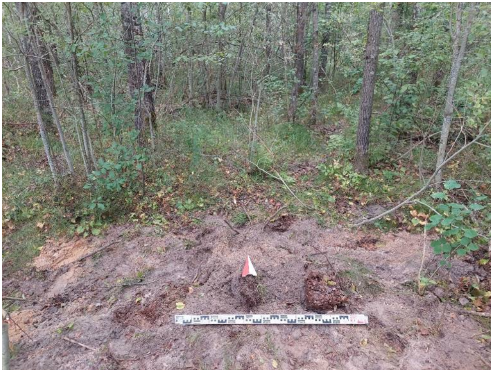
Илл. 60. Ленинградская обл., Кировский район, Газопровод межпоселковый к д. Кобона Кировского района Ленинградской области. Шурф №7. Засыпка. Вид с Ю.
