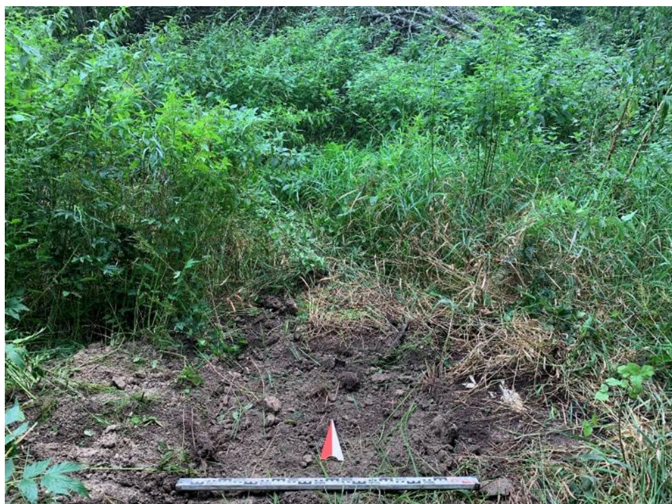
Илл. 99. Ленинградская обл., Кировский район, Газопровод межпоселковый к д. Кобона Кировского района Ленинградской области. Шурф №12. Засыпка. Вид с Ю.
