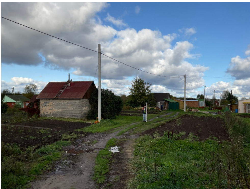
Рис. 44. Ленинградская область, Волховский район, «Распределительный газопровод и газопроводы-вводы в с. Старая Ладога». Участок 1. Точка фотофиксации 8. Вид с Ю.
