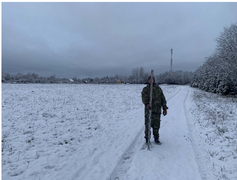
Рис. 207. Ленинградская область, Волховский район, «Распределительный газопровод и газопроводы-вводы в с. Старая Ладога». Участок 3-3. Точка фотофиксации 69. Вид с Ю-ЮВ.
