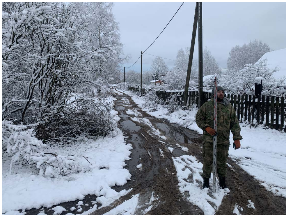
Рис. 131. Ленинградская область, Волховский район, «Распределительный газопровод и газопроводы-вводы в с. Старая Ладога». Участок 3-2. Точка фотофиксации 35. Вид с СЗ.
