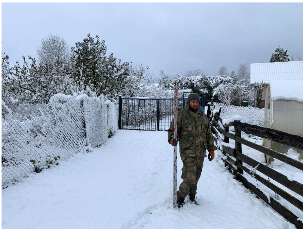
Рис. 149. Ленинградская область, Волховский район, «Распределительный газопровод и газопроводы-вводы в с. Старая Ладога». Участок 3-3. Точка фотофиксации 41. Вид с ВЮВ.
