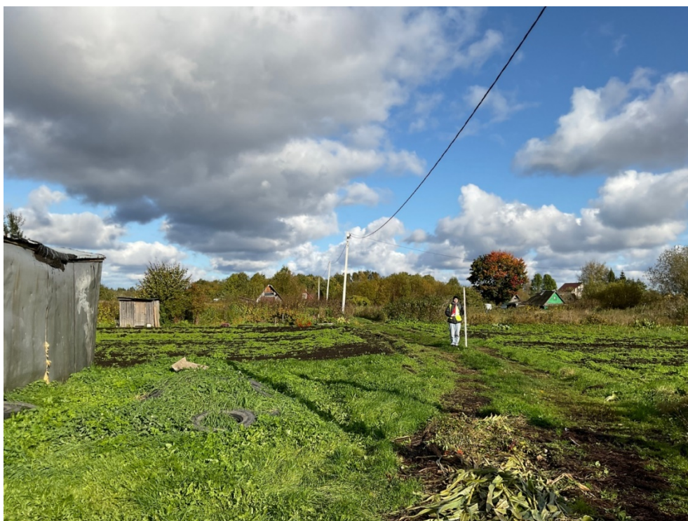
Рис. 43. Ленинградская область, Волховский район, «Распределительный газопровод и газопроводы-вводы в с. Старая Ладога». Участок 1. Точка фотофиксации 7. Вид с Ю.
