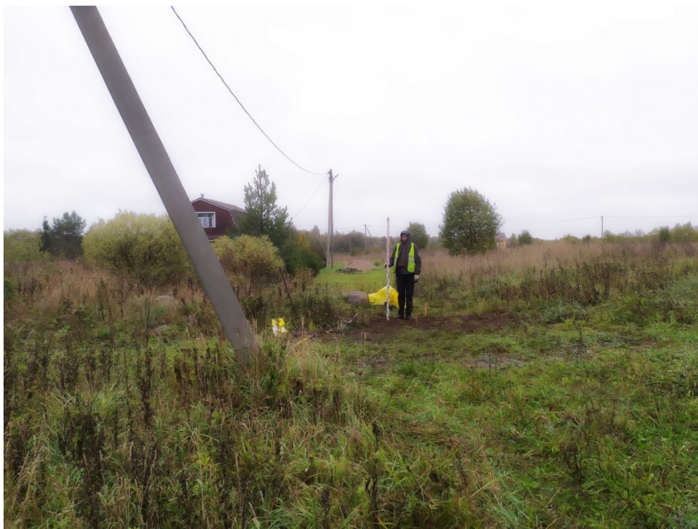
Рис. 42. Ленинградская область, Волховский район, «Распределительный газопровод и газопроводы-вводы в с. Старая Ладога». Участок 1. Шурф 4. Рекультивация. Вид с Ю.
