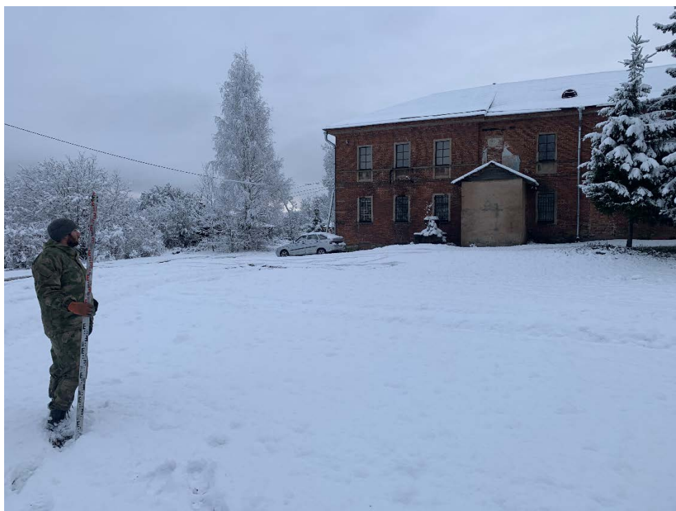
Рис. 126. Ленинградская область, Волховский район, «Распределительный газопровод и газопроводы-вводы в с. Старая Ладога». Участок 3-2. Точка фотофиксации 32. Вид с СЗ.
