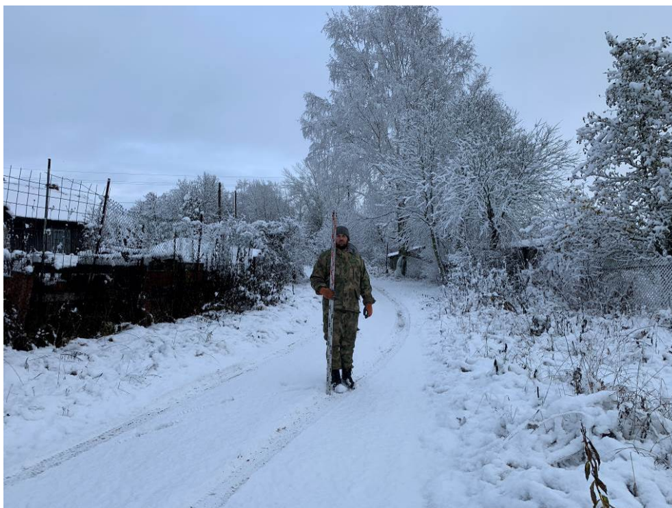
Рис. 156. Ленинградская область, Волховский район, «Распределительный газопровод и газопроводы-вводы в с. Старая Ладога». Участок 3-3. Точка фотофиксации 45. Вид с ЗЮЗ.
