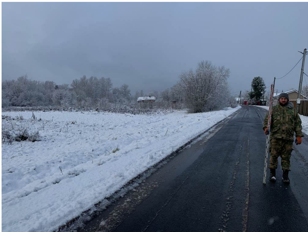
Рис.97. Ленинградская область, Волховский район, «Распределительный газопровод и газопроводы-вводы в с. Старая Ладога». Участок 3-1. Точка фотофиксации 20. Вид с ЮВ.
