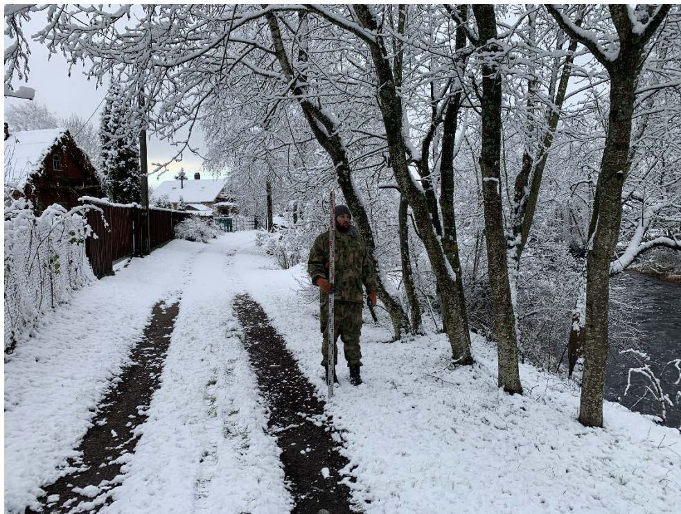
Рис. 165. Ленинградская область, Волховский район, «Распределительный газопровод и газопроводы-вводы в с. Старая Ладога». Участок 3-3. Точка фотофиксации 51. Вид с ССЗ.
