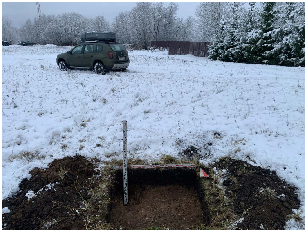
Рис. 203. Ленинградская область, Волховский район, «Распределительный газопровод и газопроводы-вводы в с. Старая Ладога». Участок 3-3. Шурф 8. Зачистка по матерiku. Общий вид с Ю.
