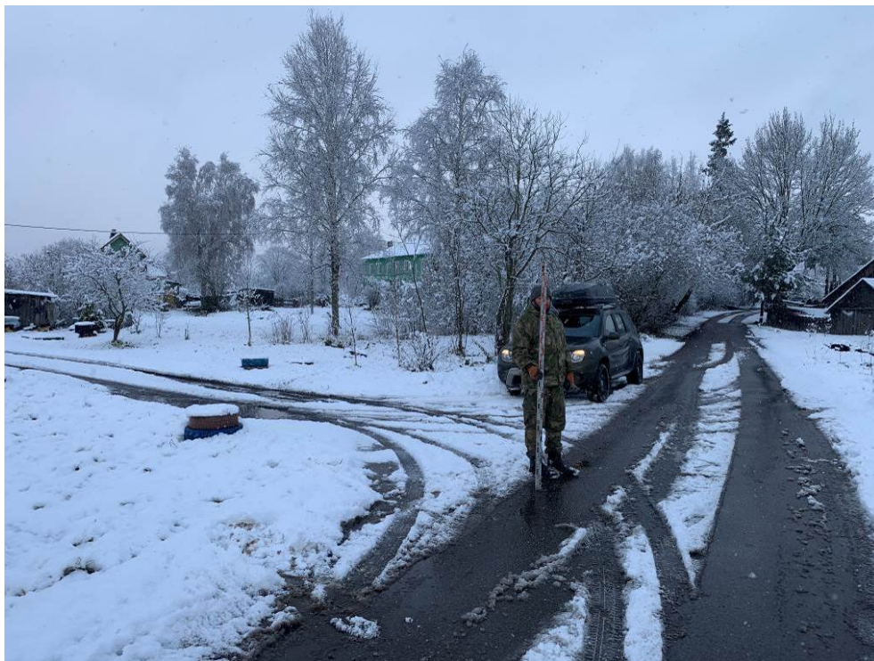
Рис. 107. Ленинградская область, Волховский район, «Распределительный газопровод и газопроводы-вводы в с. Старая Ладога». Участок 3-1. Точка фотофиксации 24. Вид с Ю.
