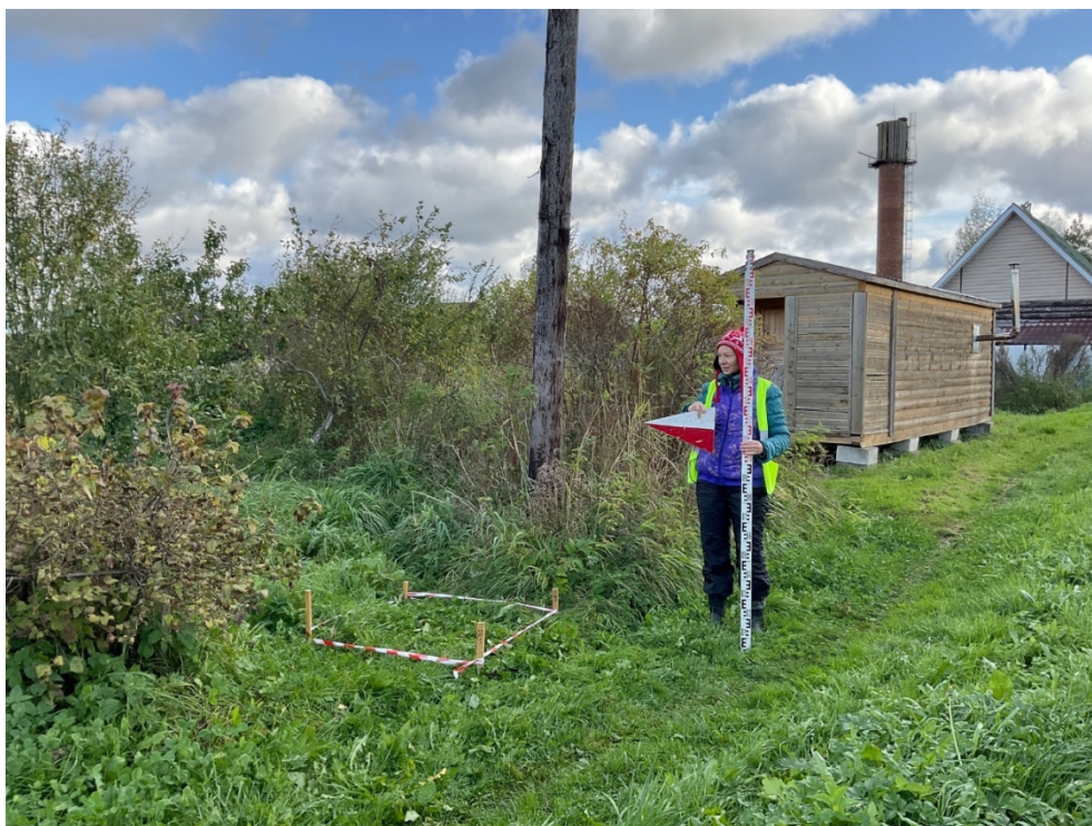
Рис. 52. Ленинградская область, Волховский район, «Распределительный газопровод и газопроводы-вводы в с. Старая Ладога». Участок 1. Шурф 6. Общий вид до начала работ с ЮЗ.
