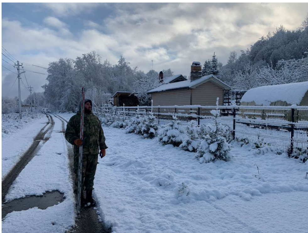
Рис. 87. Ленинградская область, Волховский район, «Распределительный газопровод и газопроводы-вводы в с. Старая Ладога». Участок 2. Точка фотофиксации 18. Вид с СЗ.
