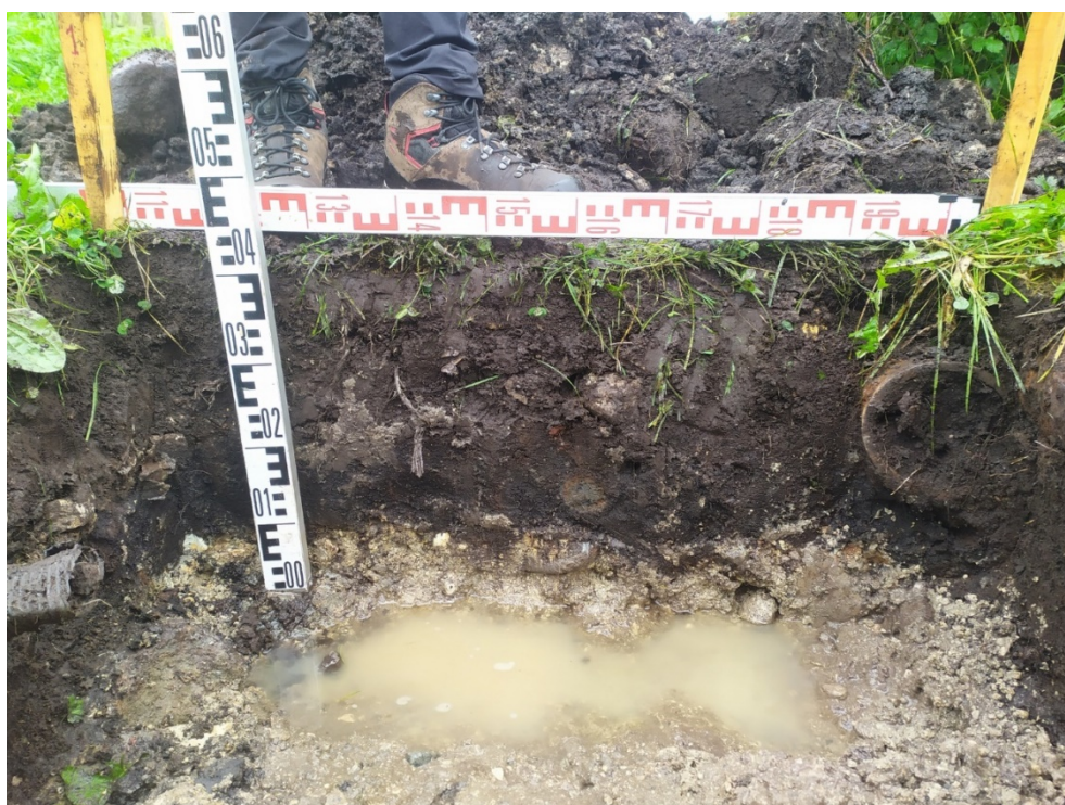
Рис. 57. Ленинградская область, Волховский район, «Распределительный газопровод и газопроводы-вводы в с. Старая Ладога». Участок 1. Шурф 6. Западная стенка и контрольный прокоп. Вид с В.
