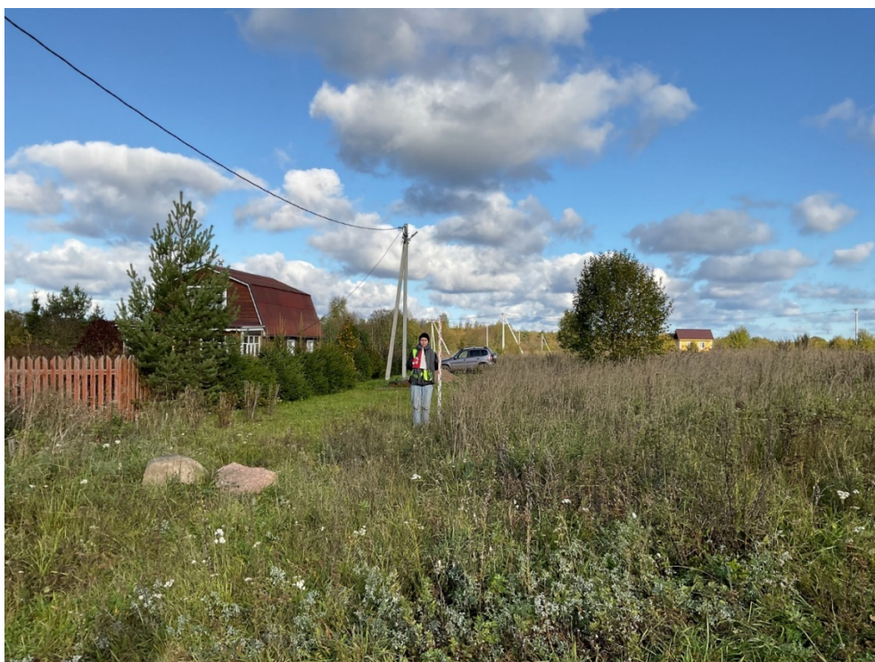
Рис. 39. Ленинградская область, Волховский район, «Распределительный газопровод и газопроводы-вводы в с. Старая Ладога». Участок 1. Шурф 4. Общий вид до начала работ с Ю.
