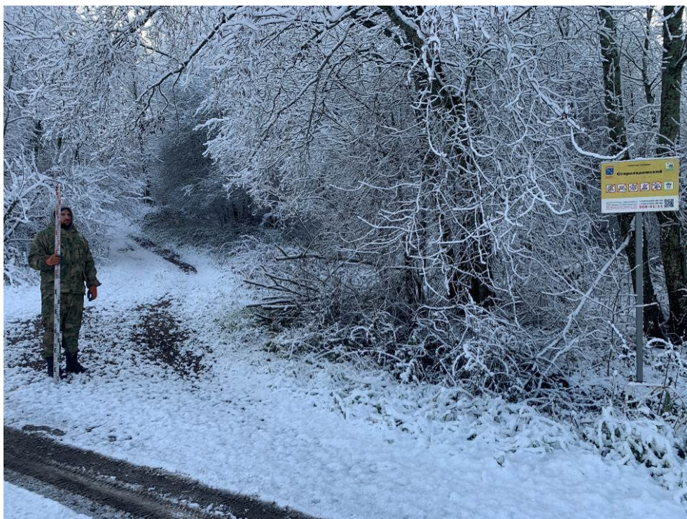
Рис.77. Ленинградская область, Волховский район, «Распределительный газопровод и газопроводы-вводы в с. Старая Ладога». Участок 2. Точка фотофиксации 17. Вид с С.
