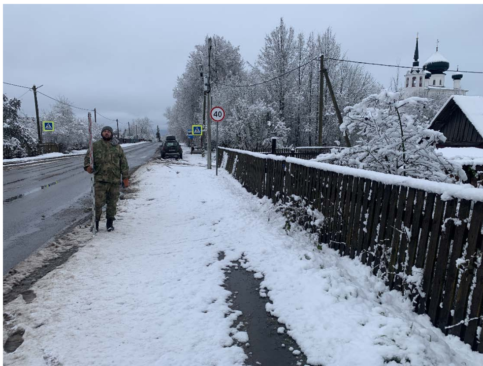
Рис. 129. Ленинградская область, Волховский район, «Распределительный газопровод и газопроводы-вводы в с. Старая Ладога». Участок 3-2. Точка фотофиксации 34. Вид с ЮЮЗ.
