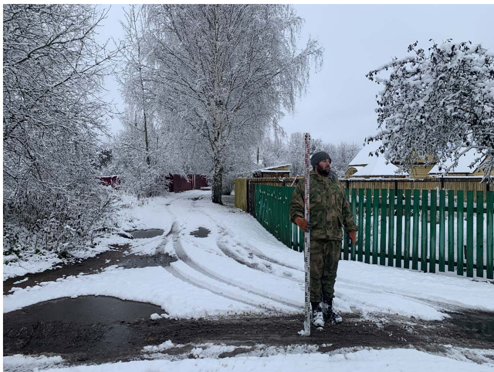
Рис. 127. Ленинградская область, Волховский район, «Распределительный газопровод и газопроводы-вводы в с. Старая Ладога». Участок 3-2. Точка фотофиксации 32. Вид с Ю-ЮЗ.
