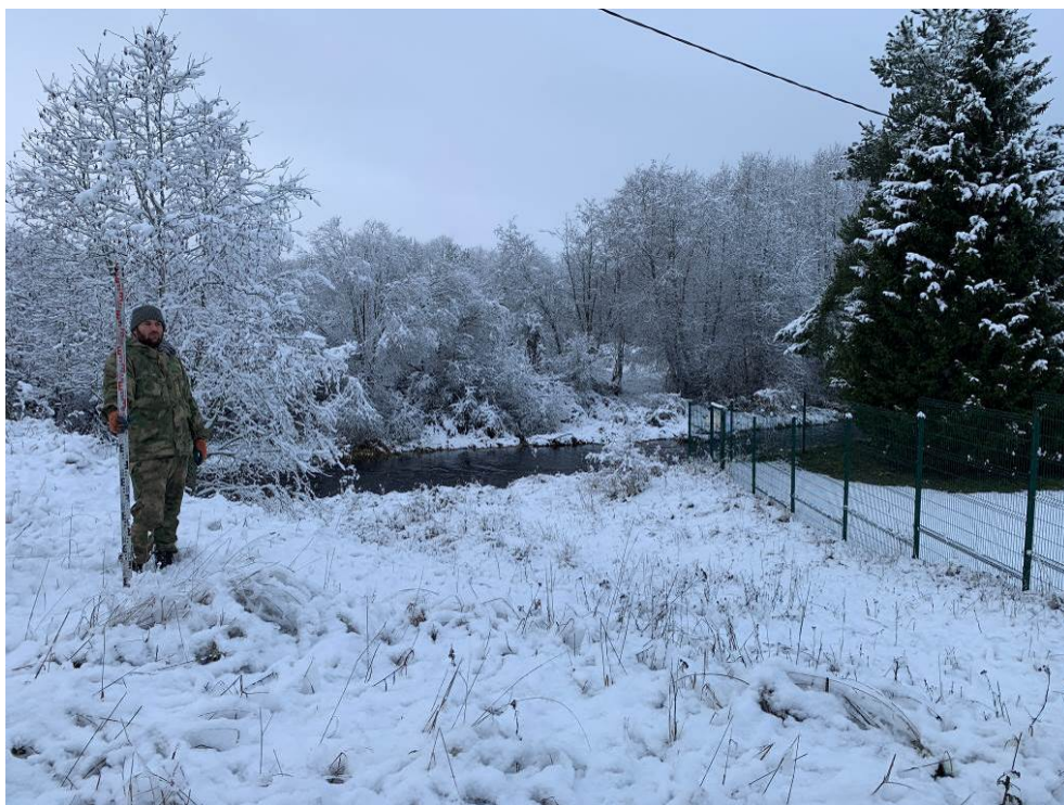
Рис. 158. Ленинградская область, Волховский район, «Распределительный газопровод и газопроводы-вводы в с. Старая Ладога». Участок 3-3. Точка фотофиксации 46. Вид с ЮВ.
