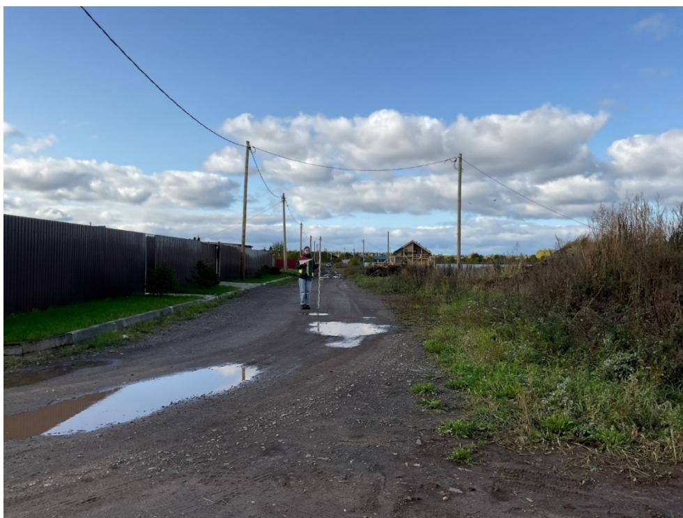
Рис. 33. Ленинградская область, Волховский район, «Распределительный газопровод и газопроводы-вводы в с. Старая Ладога». Участок 1. Точка фотофиксации 4. Вид с В.
