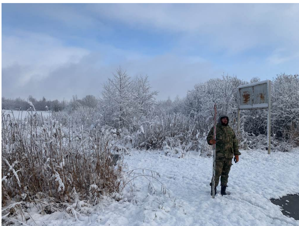
Рис. 70. Ленинградская область, Волховский район, «Распределительный газопровод и газопроводы-вводы в с. Старая Ладога». Участок 2. Точка фотофиксации 14. Вид с З.
