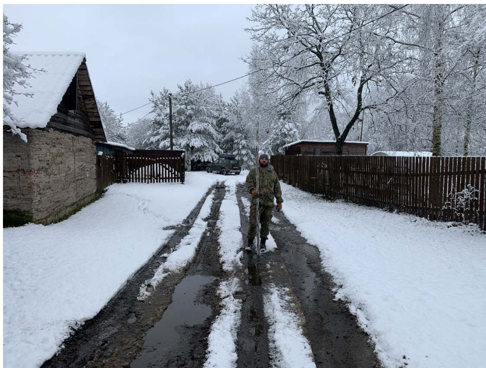
Рис. 171. Ленинградская область, Волховский район, «Распределительный газопровод и газопроводы-вводы в с. Старая Ладога». Участок 3-3. Точка фотофиксации 54. Вид с С.
