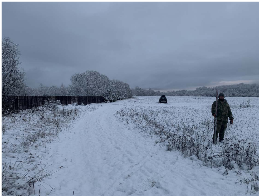
Рис. 201. Ленинградская область, Волховский район, «Распределительный газопровод и газопроводы-вводы в с. Старая Ладога». Участок 3-3. Точка фотофиксации 68. Вид с ССЗ.
