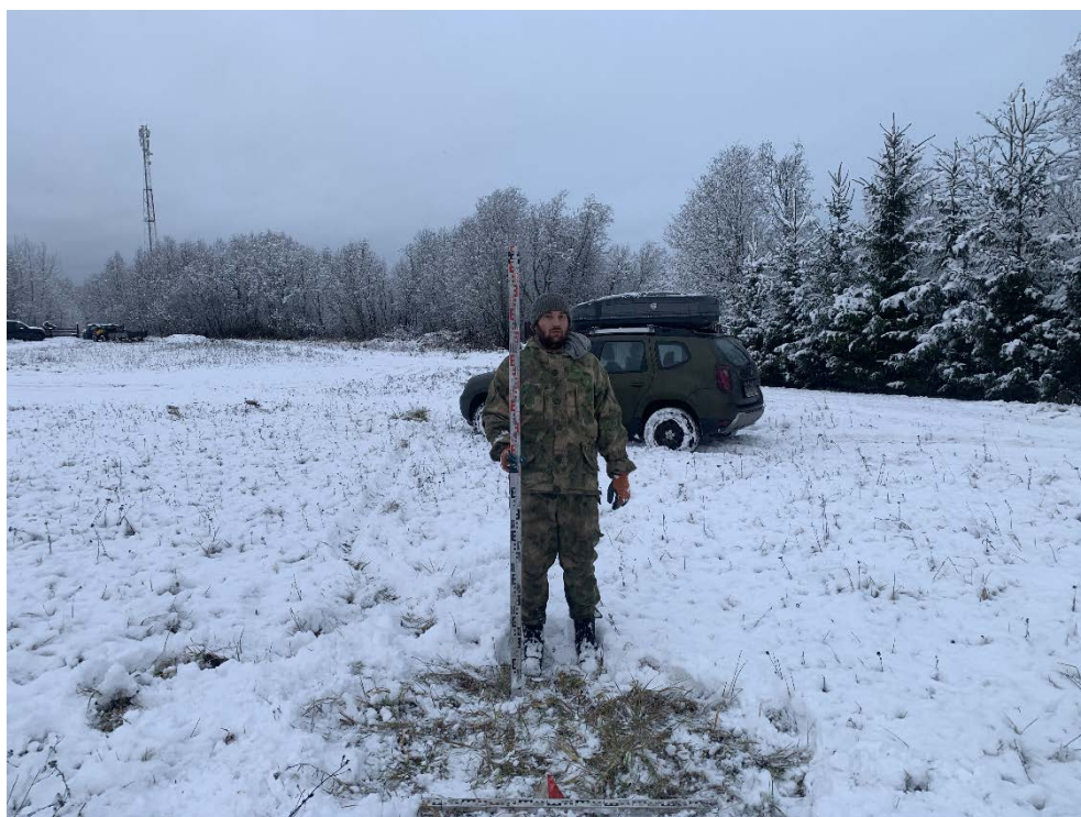
Рис. 202. Ленинградская область, Волховский район, «Распределительный газопровод и газопроводы-вводы в с. Старая Ладога». Участок 3-3. Шурф 8. Общий вид до начала работ с Ю.
