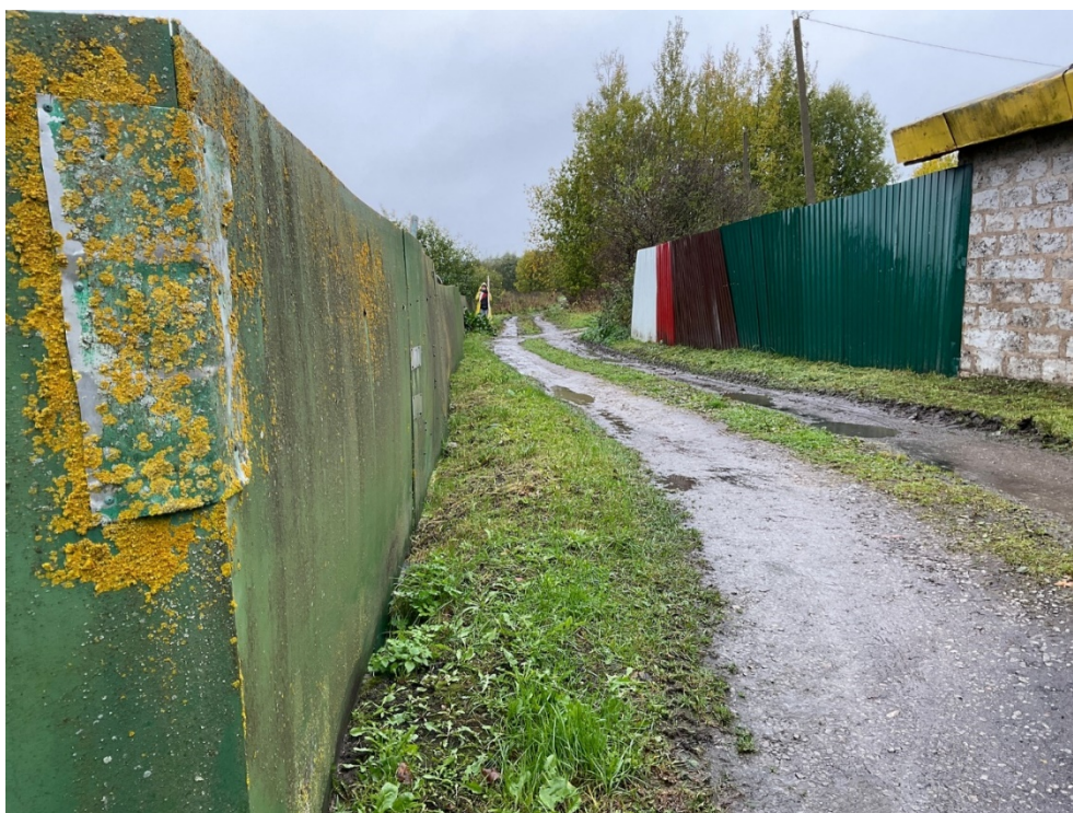
Рис. 45. Ленинградская область, Волховский район, «Распределительный газопровод в д. Княщина Волховского района Ленинградской области». Точка фотофиксации 9. Вид с С.
