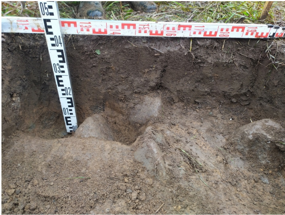
Рис. 32. Ленинградская область, Волховский район, «Распределительный газопровод в д. Княщина Волховского района Ленинградской области». Шурф 2. Контрольный прокоп. Вид с В.
