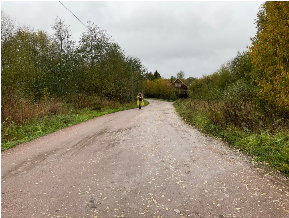
Рис. 20. Ленинградская область, Волховский район, «Распределительный газопровод в д. Княщина Волховского района Ленинградской области». Точка фотофиксации 2. Вид с ЮЗ.
