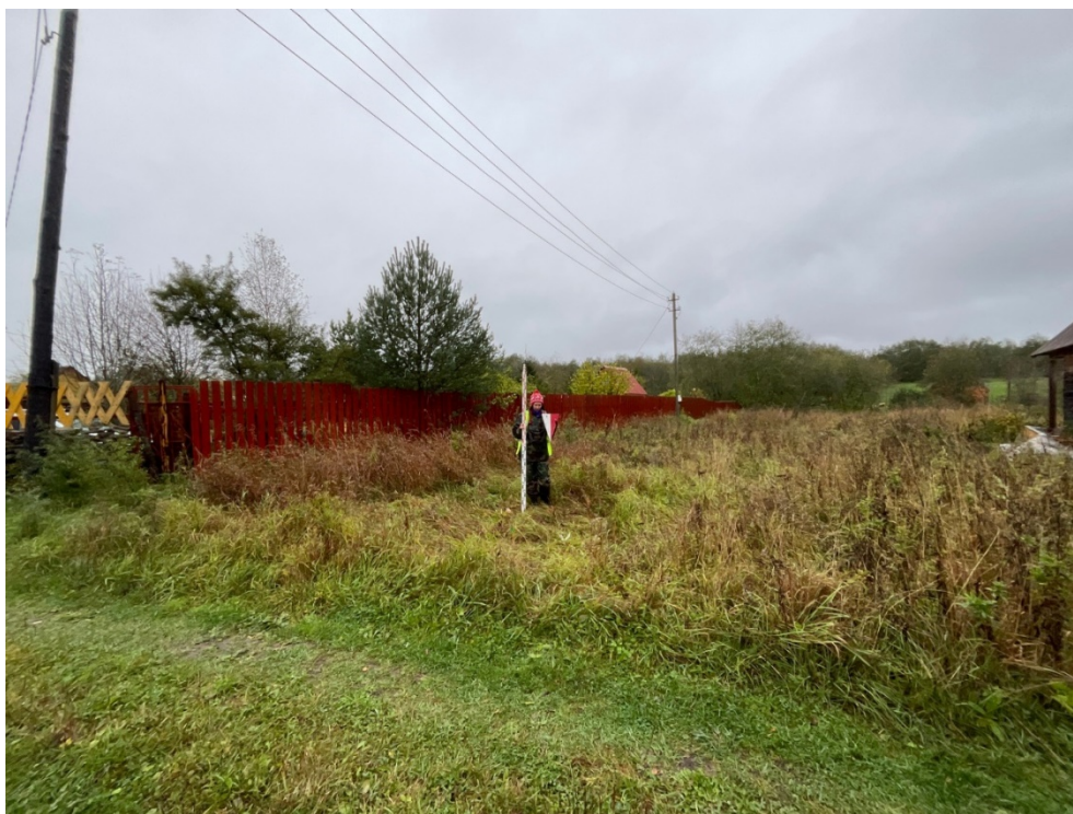
Рис. 28. Ленинградская область, Волховский район, «Распределительный газопровод в д. Княщина Волховского района Ленинградской области». Шурф 2. До начала работ. Вид с Ю.
