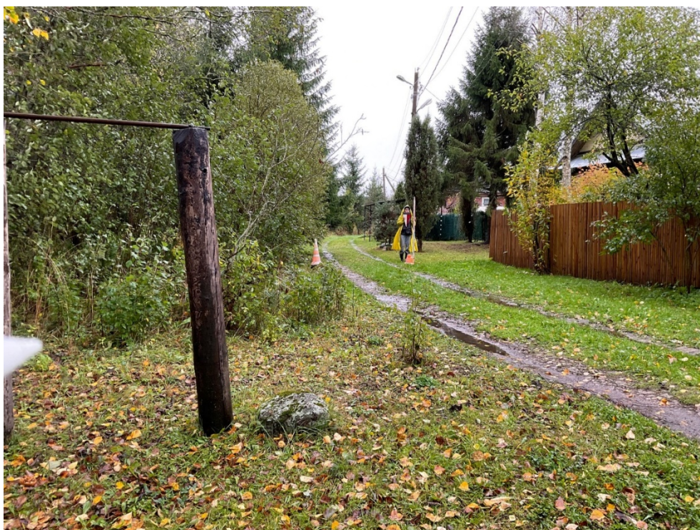
Рис. 37. Ленинградская область, Волховский район, «Распределительный газопровод в д. Княщина Волховского района Ленинградской области». Точка фотофиксации 7. Вид с С.
