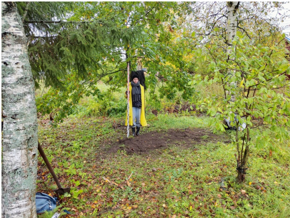
Рис. 43. Ленинградская область, Волховский район, «Распределительный газопровод в д. Княщина Волховского района Ленинградской области». Шурф 3. Рекультивация. Вид с З.
