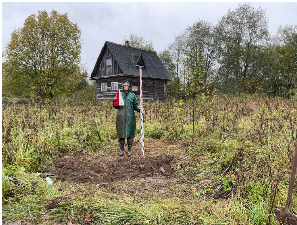
Рис. 26. Ленинградская область, Волховский район, «Распределительный газопровод в д. Княщина Волховского района Ленинградской области». Шурф 1. Рекультивация. Вид с Ю.
