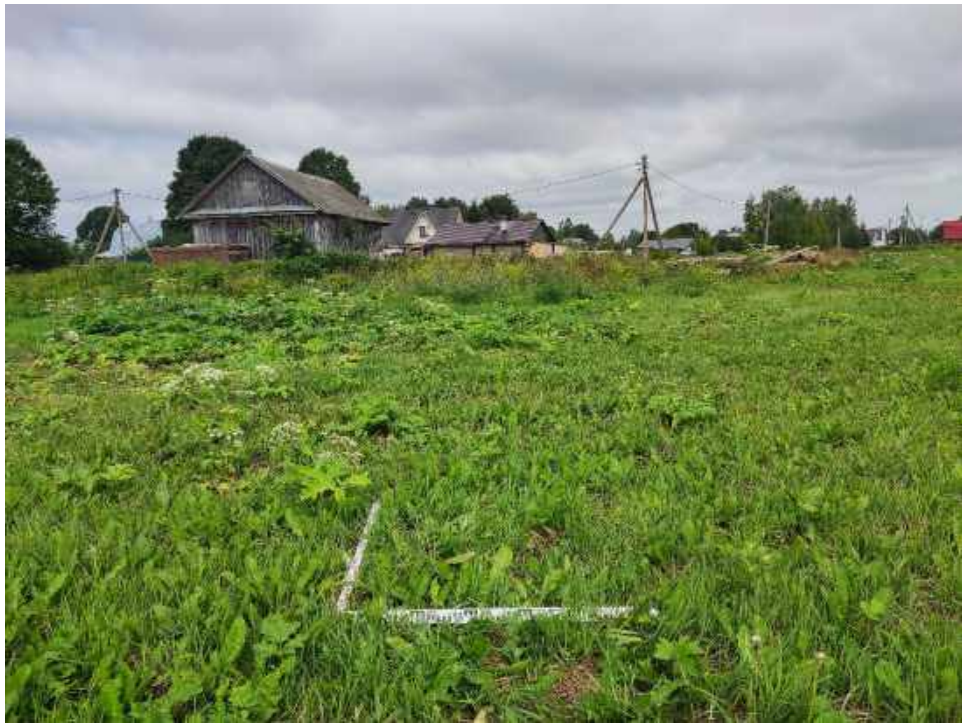
Илл. 267. Ленинградская область, Лужский район, Объект «Володарское». Шурф 25. До начала земляных работ. Вид на С.
