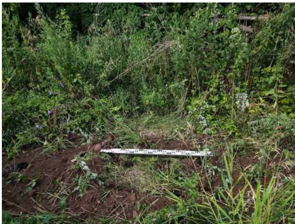
Илл. 125. Ленинградская область, Лужский район, Объект «Володарское». Шурф 11. Рекультивация. Вид на С.
