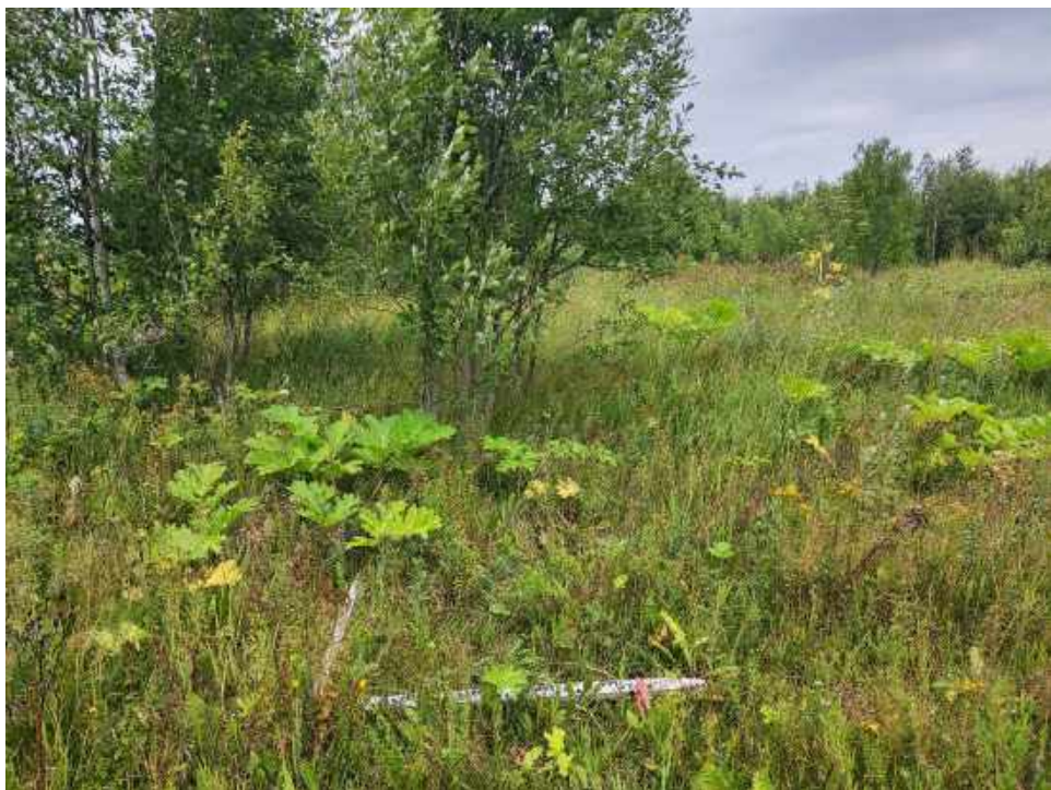
Илл. 276. Ленинградская область, Лужский район, Объект «Володарское». Шурф 26. До начала земляных работ. Вид на С.
