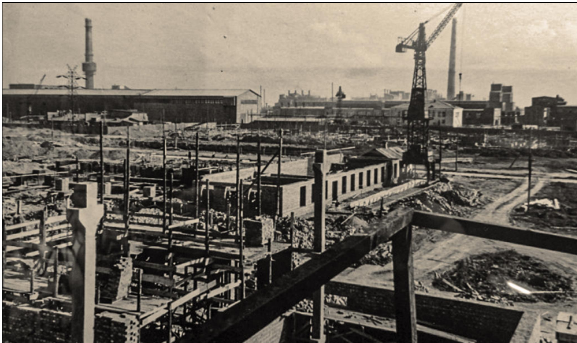
Илл. 11. Строительство Волховского алюминиевого комбината. Фотография. Первая половина XX в. Автор съемки: неизвестен. Электронный ресурс: https://историческийбагаж.рф .
