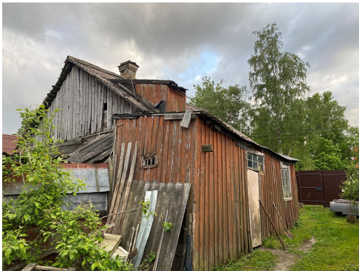
Фото 26. Северо-восточный и Северо-западный фасады здания, подлежащего демонтажу. Вид с севера.
