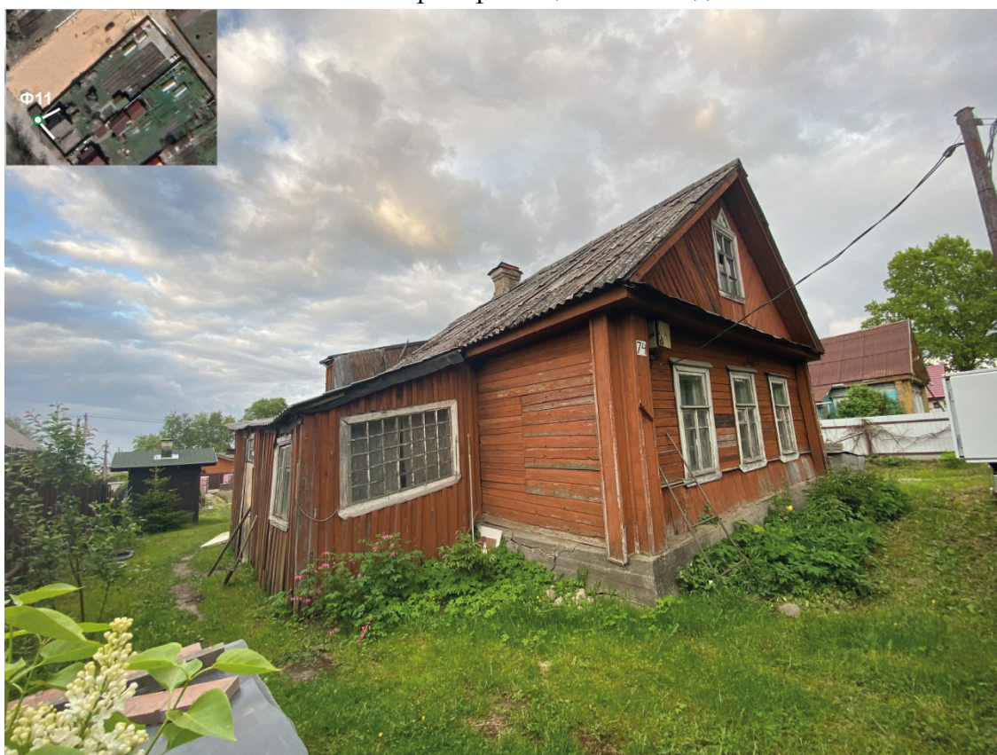
Фото 18. Точка фотофиксации Ф11. Вид с запада.
