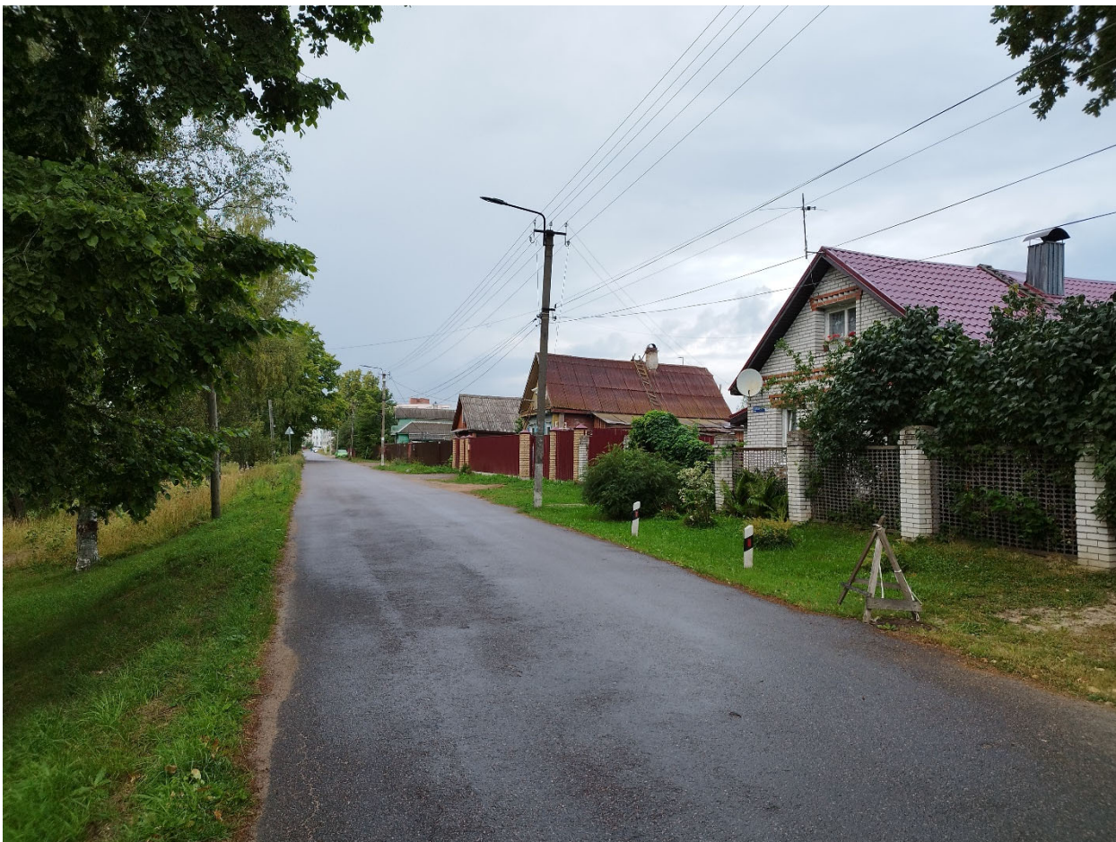
Илл. 2. Ленинградская обл., г. Шлиссельбург. ул. Староладожский канал. Точка съемки Ф1. Вид с юга.
