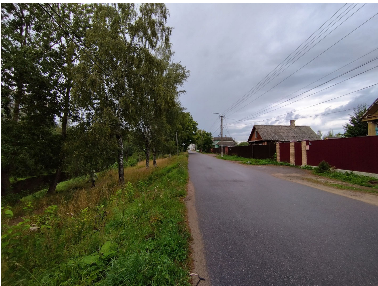
Илл. 3. Ленинградская обл., г. Шлиссельбург. ул. Староладожский канал. Точка съемки Ф2. Вид с юга.
