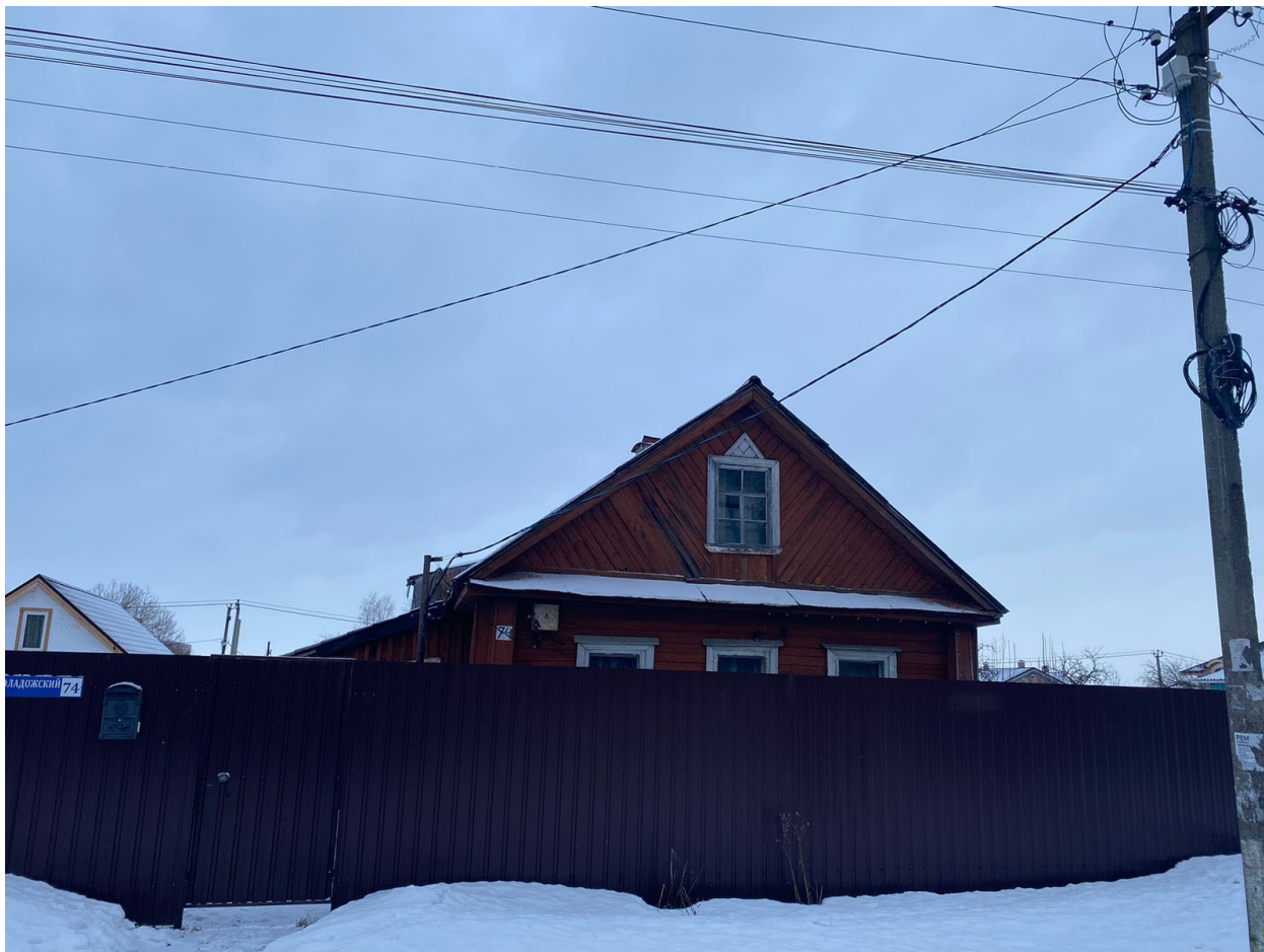
Илл. 11. Ленинградская обл., г. Шлиссельбург. ул. Староладожский канал. Точка съемки Ф3. Вид с запада.
