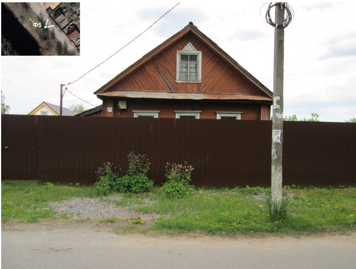
Фото 9. Точка фотофиксации Ф5. Вид с юго-запада.
