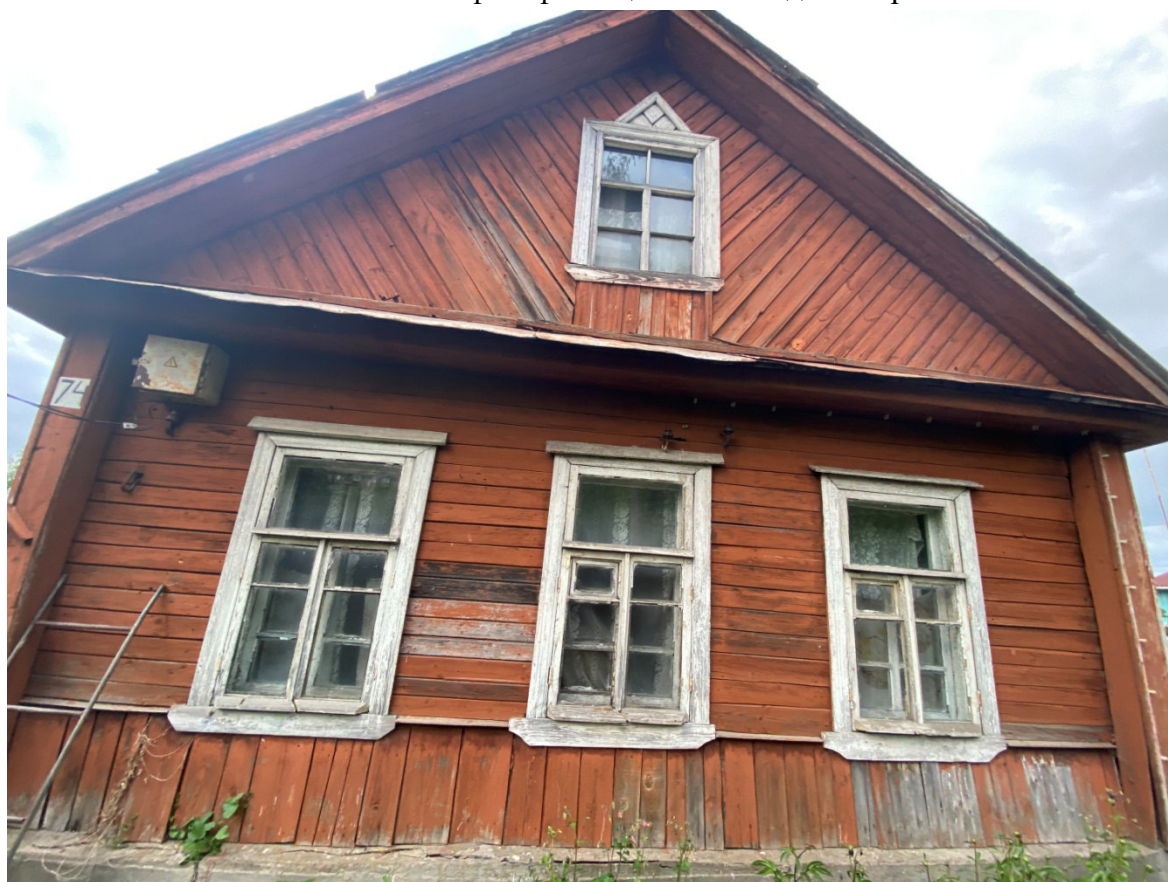
Фото 24. Юго-западный фасад здания, подлежащего демонтажу. Вид с юго-запада.
