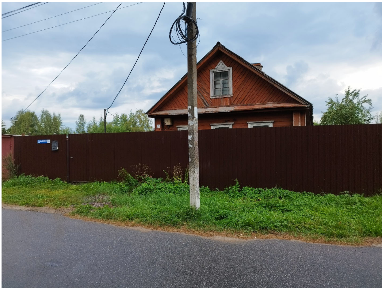
Илл. 4. Ленинградская обл., г. Шлиссельбург. ул. Староладожский канал. Точка съемки Ф3. Вид с запада.
