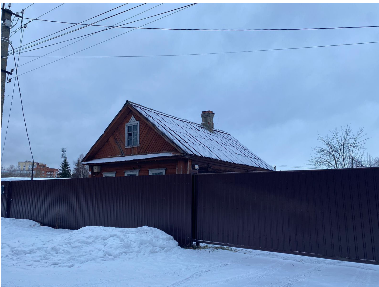
Илл. 10. Ленинградская обл., г. Шлиссельбург. ул. Староладожский канал. Точка съемки Ф2. Вид с юга.
