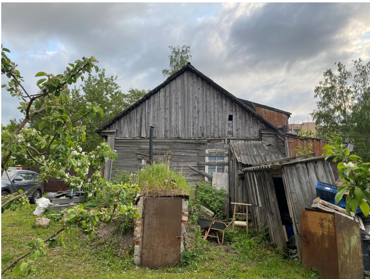
Фото 27. Северо-восточный фасад здания, подлежащего демонтажу. Вид с северо-востока.
