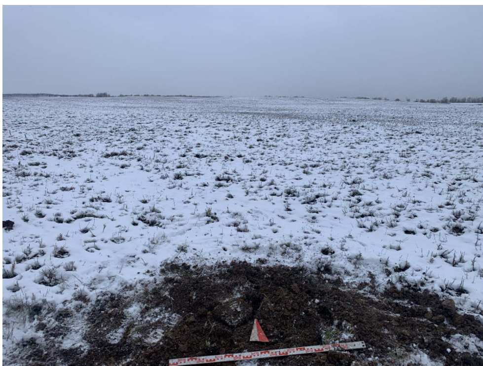
Илл. 23. Ленинградская область, Гатчинский район. 2023 г. «Межпоселковый газопровод до д. Корпикюля Гатчинского района». Шурф №1. Рекультивация. Вид с Ю.
