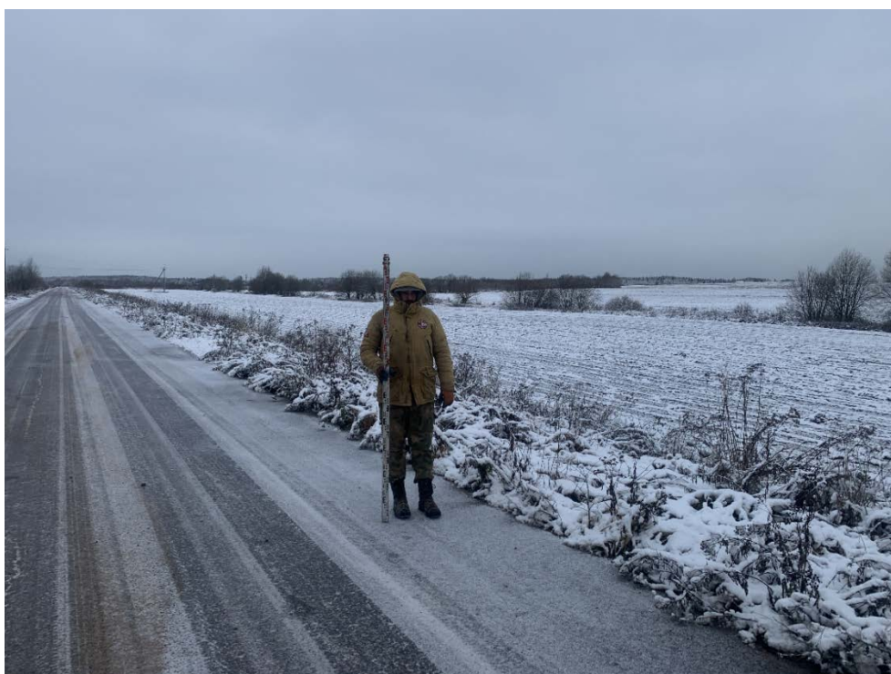
Илл. 25. Ленинградская область, Гатчинский район. 2023 г. «Межпоселковый газопровод до д. Корпикюля Гатчинского района». Общий вид участка обследования. Точка фотофиксации №2. Вид с ЮВ.
