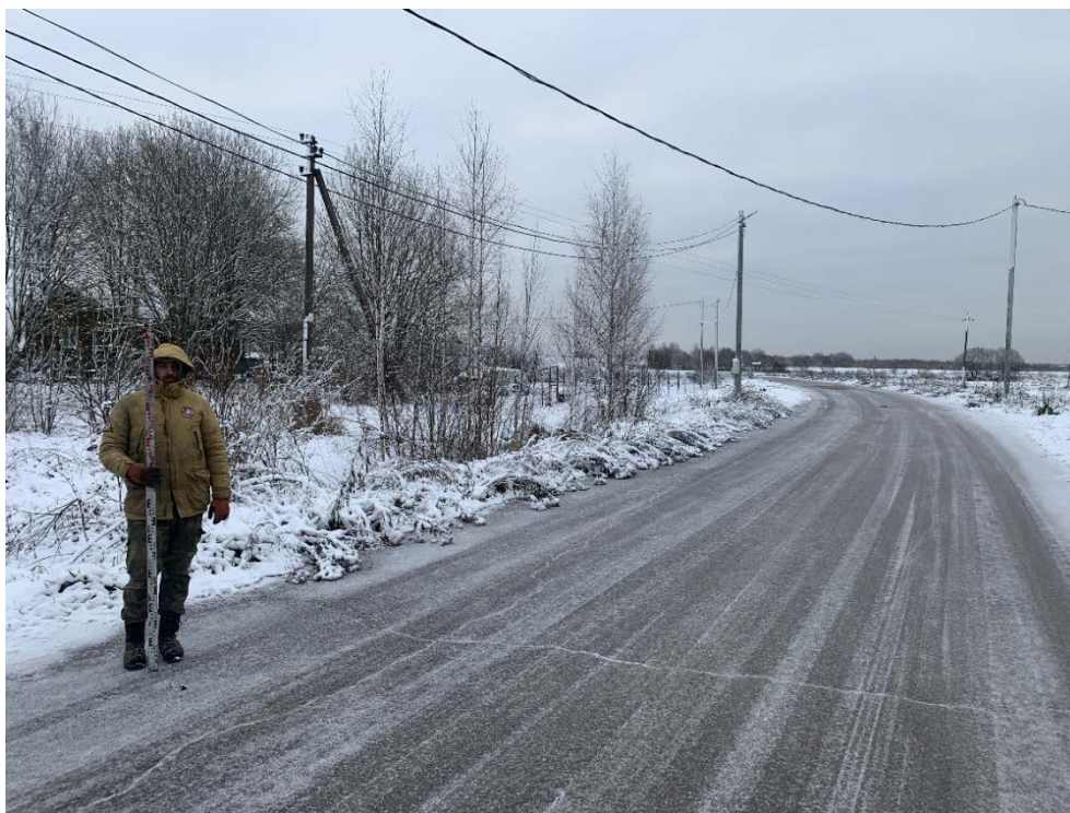
Илл. 36. Ленинградская область, Гатчинский район. 2023 г. «Межпоселковый газопровод до д. Корпикюля Гатчинского района». Общий вид участка обследования. Точка фотофиксации №5. Вид с СЗ.
