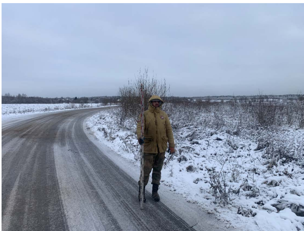
Илл. 27. Ленинградская область, Гатчинский район. 2023 г. «Межпоселковый газопровод до д. Корпикюля Гатчинского района». Общий вид участка обследования. Точка фотофиксации №3. Вид с ЮВ.
