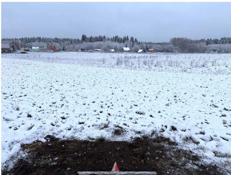
Илл. 74. Ленинградская область, Гатчинский район. 2023 г. «Межпоселковый газопровод от д. Алексеевка – д. Луйсковицы – д. Таровицы – д. Дубицы с отводом на д. Волгово Гатчинского района». Шурф №7. Рекультивация. Вид с Ю.
