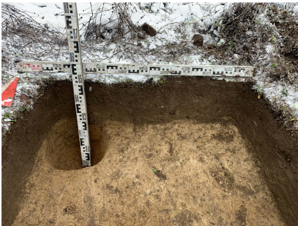
Илл. 21. Ленинградская область, Гатчинский район. 2023 г. «Межпоселковый газопровод от д. Алексеевка – д. Луйсковицы – д. Таровицы – д. Дубицы с отводом на д. Волгово Гатчинского района». Шурф №1. Северная стенка и контрольный прокоп. Вид с Ю.
