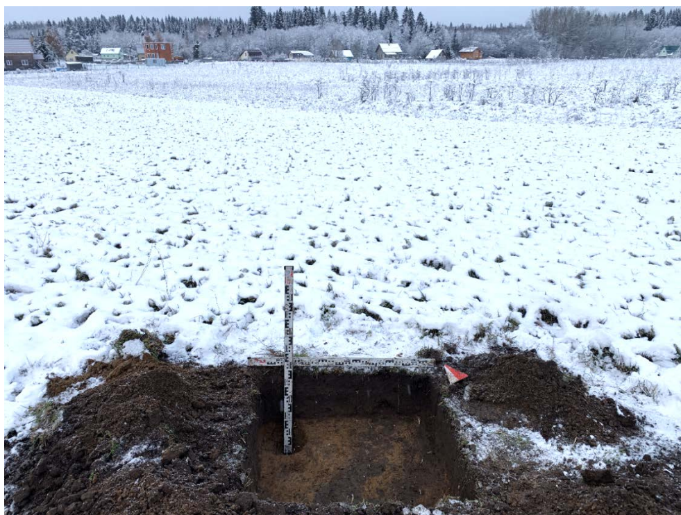
Илл. 71. Ленинградская область, Гатчинский район. 2023 г. «Межпоселковый газопровод от д. Алексеевка – д. Луйсовицы – д. Таровицы – д. Дубицы с отводом на д. Волгово Гатчинского района». Шурф №7. Зачистка по материке. Общий вид с Ю.
