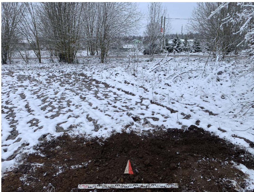
Илл. 30. Ленинградская область, Гатчинский район. 2023 г. «Межпоселковый газопровод от д. Алексеевка – д. Луйсковицы – д. Таровицы – д. Дубицы с отводом на д. Волгово Гатчинского района». Шурф №2. Рекультивация. Вид с Ю.
