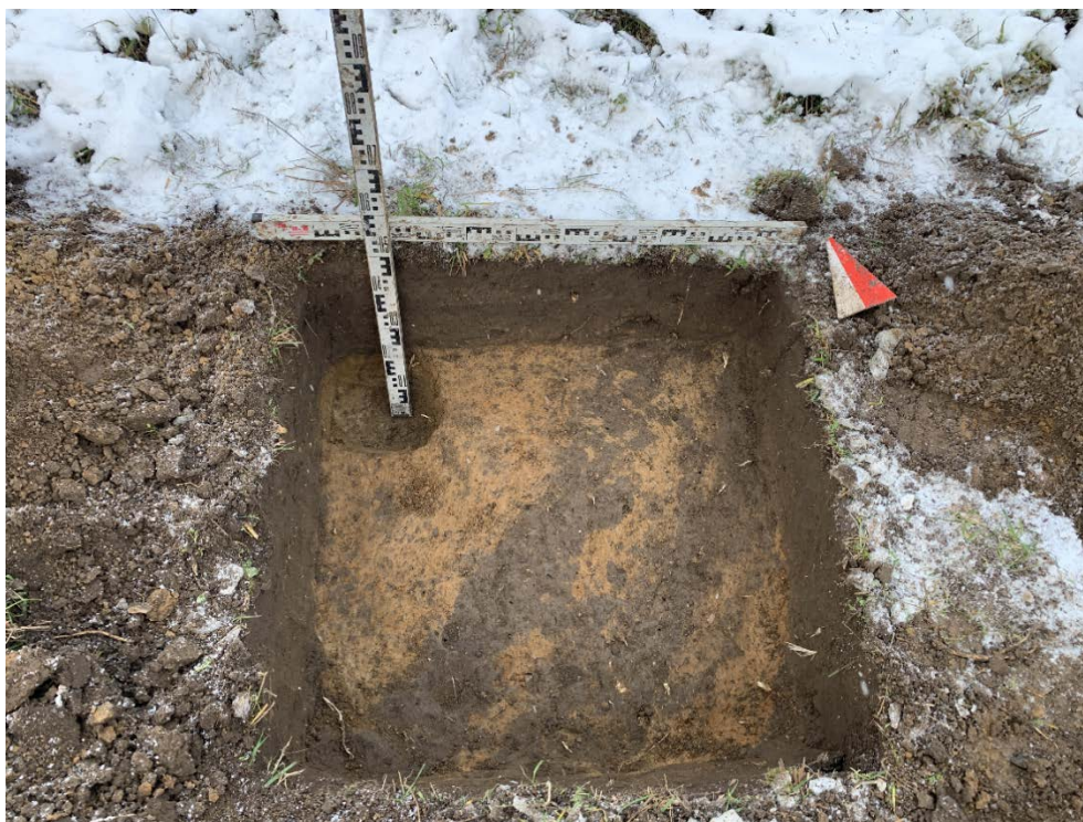
Илл. 72. Ленинградская область, Гатчинский район. 2023 г. «Межпоселковый газопровод от д. Алексеевка – д. Луйсовицы – д. Таровицы – д. Дубицы с отводом на д. Волгово Гатчинского района». Шурф №7. Материк. Предметный вид с Ю.
