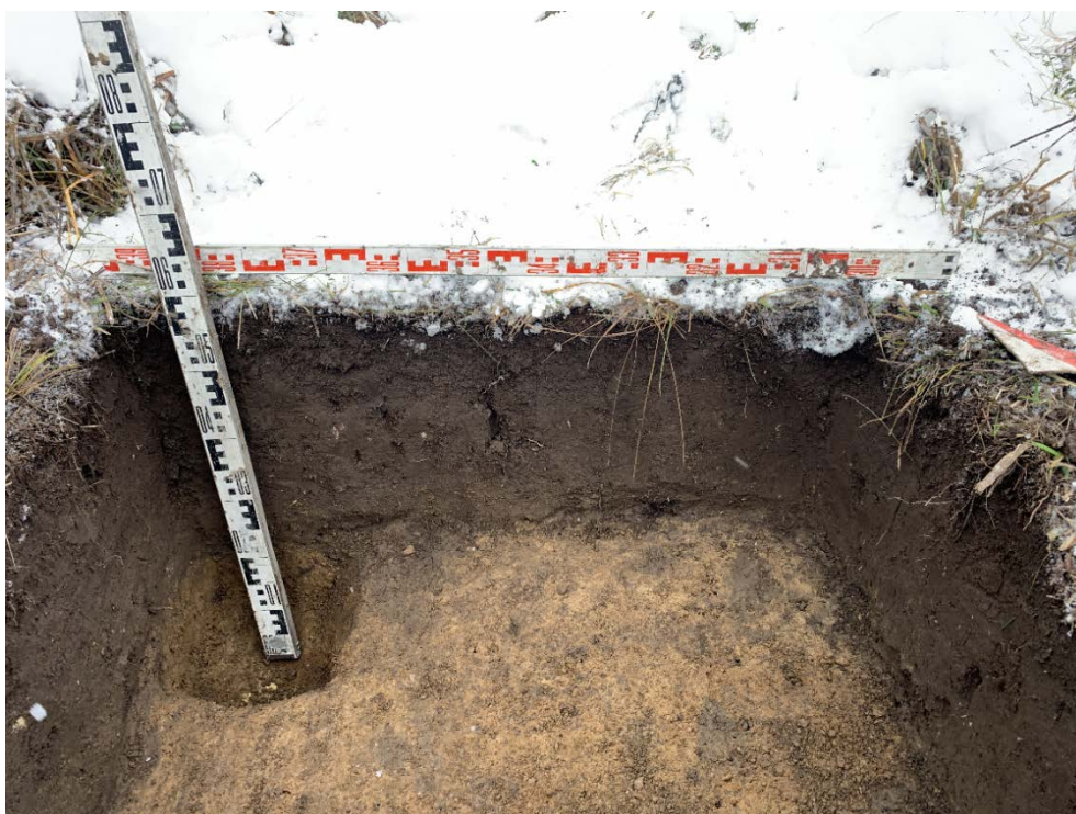
Илл. 63. Ленинградская область, Гатчинский район. 2023 г. «Межпоселковый газопровод от д. Алексеевка – д. Луйсковичи – д. Таровицы – д. Дубицы с отводом на д. Волгово Гатчинского района». Шурф №6. Северная стенка и контрольный прокоп. Вид с Ю.
