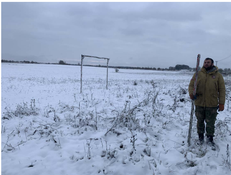
Илл. 50. Ленинградская область, Гатчинский район. 2023 г. «Межпоселковый газопровод от д. Алексеевка – д. Луйсовицы – д. Таровицы – д. Дубицы с отводом на д. Волгово Гатчинского района». Общий вид участка обследования. Точка фотофиксации №6. Вид с СВ.
