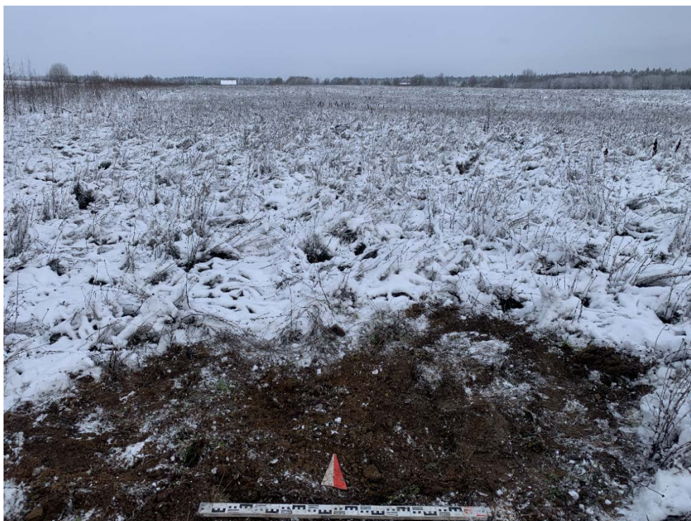
Илл. 22. Ленинградская область, Гатчинский район. 2023 г. «Межпоселковый газопровод от д. Алексеевка – д. Луйсковицы – д. Таровицы – д. Дубицы с отводом на д. Волгово Гатчинского района». Шурф №1. Рекультивация. Вид с Ю.
