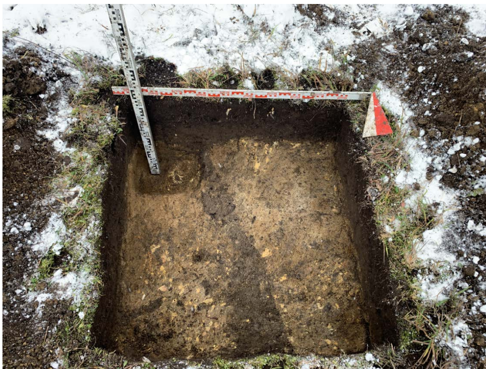
Илл. 54. Ленинградская область, Гатчинский район. 2023 г. «Межпоселковый газопровод от д. Алексеевка – д. Луйсовицы – д. Таровицы – д. Дубицы с отводом на д. Волгово Гатчинского района». Шурф №5. Материк. Предметный вид с Ю.
