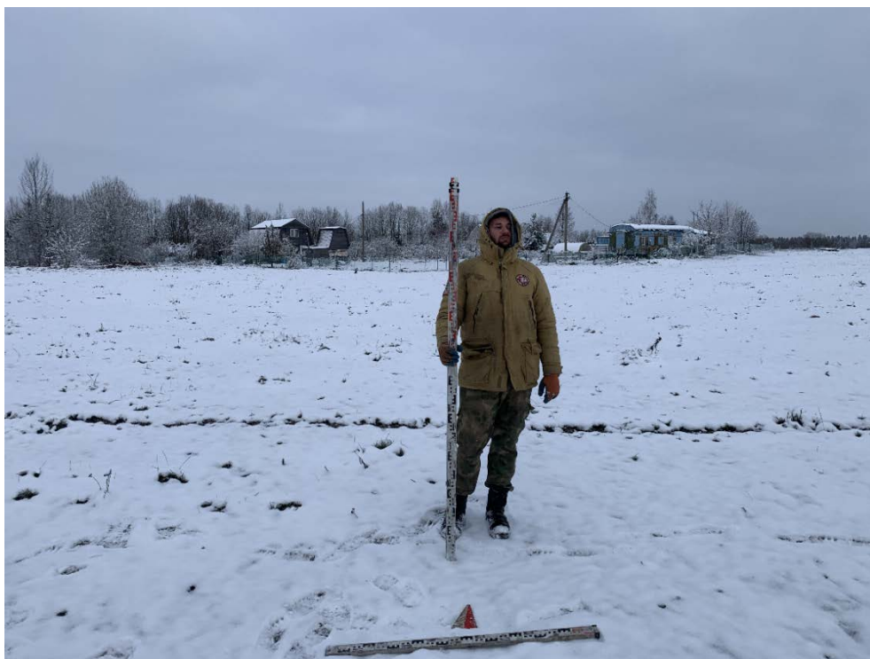
Илл. 31. Ленинградская область, Гатчинский район. 2023 г. «Межпоселковый газопровод от д. Алексеевка – д. Луйсковицы – д. Таровицы – д. Дубицы с отводом на д. Волгово Гатчинского района». Шурф №3. Местоположение. Вид с Ю.
