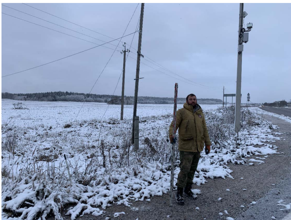
Илл. 67. Ленинградская область, Гатчинский район. 2023 г. «Межпоселковый газопровод от д. Алексеевка – д. Луйсковицы – д. Таровицы – д. Дубицы с отводом на д. Волгово Гатчинского района». Общий вид участка обследования. Точка фотофиксации №9. Вид с ЮЗ.
