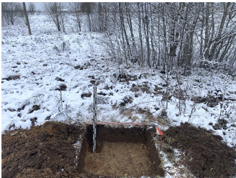
Илл. 45. Ленинградская область, Гатчинский район. 2023 г. «Межпоселковый газопровод от д. Алексеевка – д. Луйсковичи – д. Таровицы – д. Дубицы с отводом на д. Волгово Гатчинского района». Шурф №4. Зачистка по материке. Общий вид с Ю.
