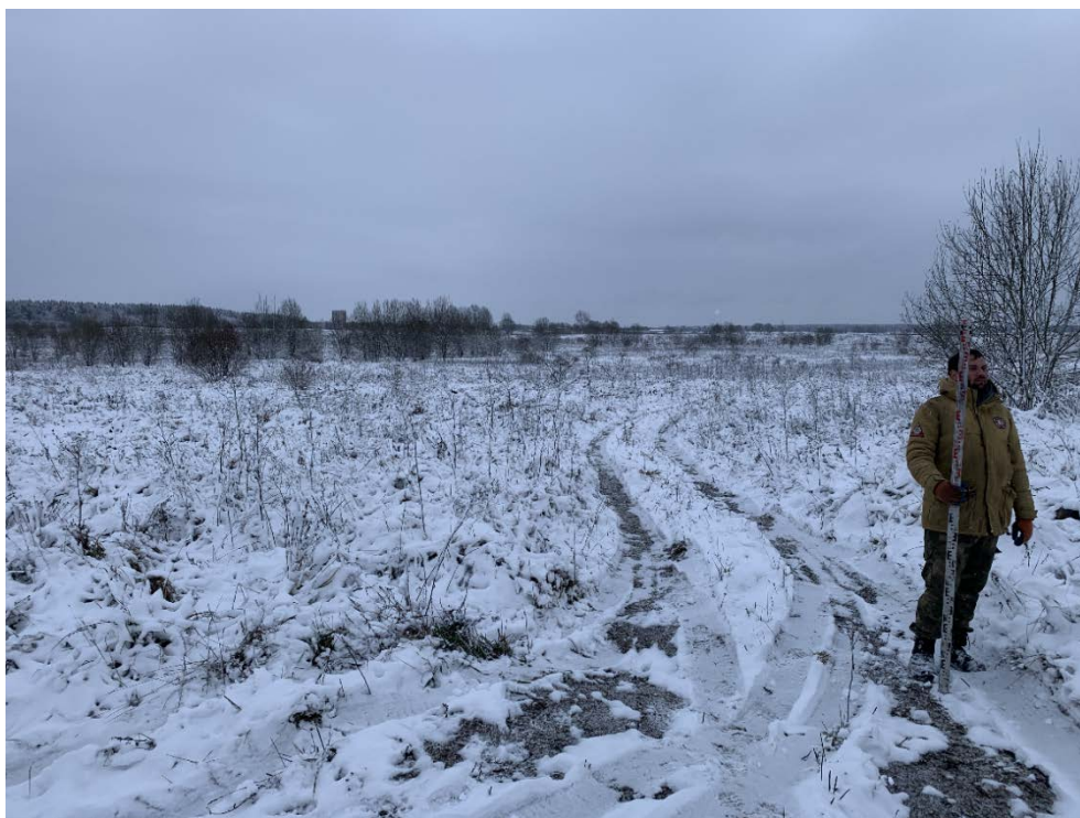
Илл. 58. Ленинградская область, Гатчинский район. 2023 г. «Межпоселковый газопровод от д. Алексеевка – д. Луйсковицы – д. Таровицы – д. Дубицы с отводом на д. Волгово Гатчинского района». Общий вид участка обследования. Точка фотофиксации №7. Вид с С-СЗ.
