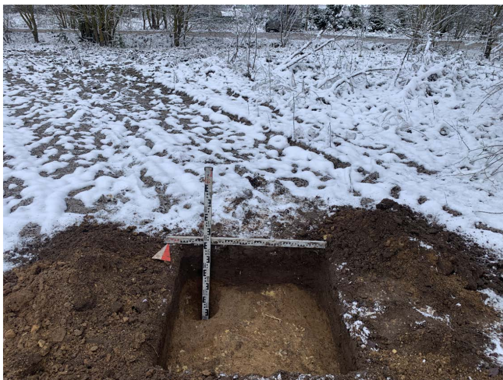
Илл. 27. Ленинградская область, Гатчинский район. 2023 г. «Межпоселковый газопровод от д. Алексеевка – д. Луйсковичи – д. Таровицы – д. Дубицы с отводом на д. Волгово Гатчинского района». Шурф №2. Зачистка по материке. Общий вид с Ю.
