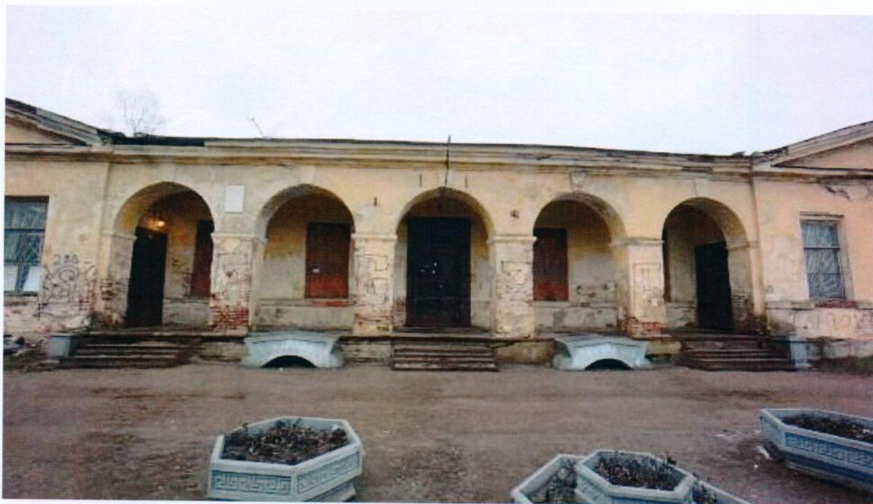
Фото 1. Общий вид. Главный корпус.
