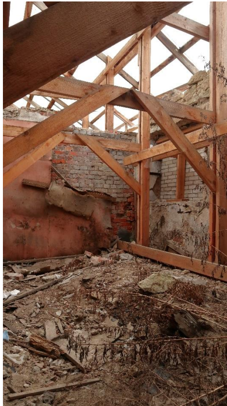
Фото 66. Помещение левого флигеля.
