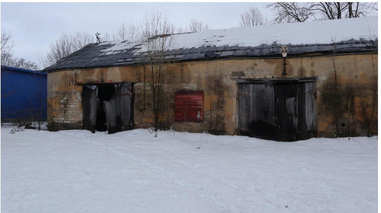
Фото 14. Дворовой фасад правого флигеля. Фрагмент.
