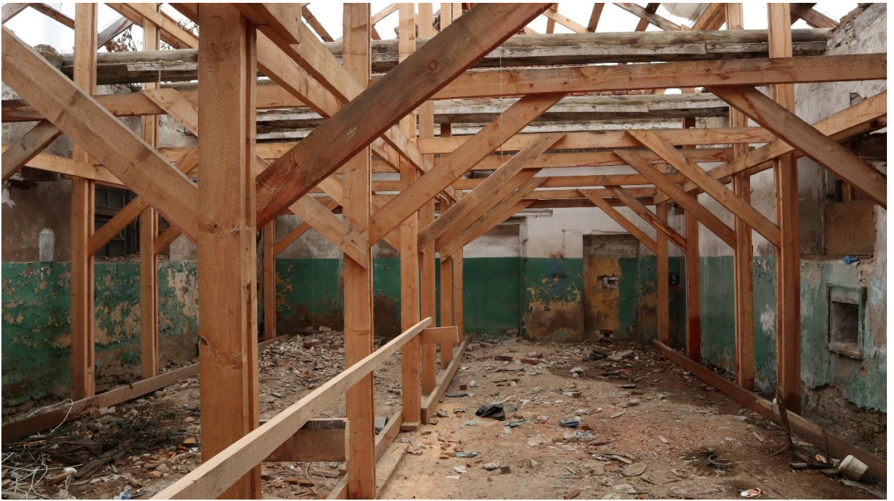
Фото 57. Помещение левого флигеля.
