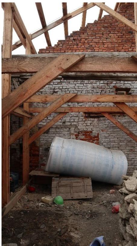
Фото 73. Помещение левого флигеля.
