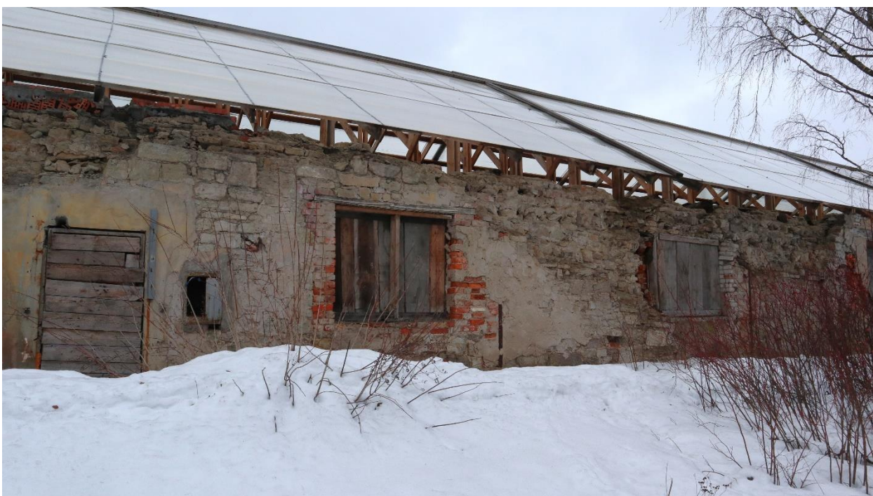
Фото 26. Дворовой (восточный) фасад левого флигеля. Фрагмент.
