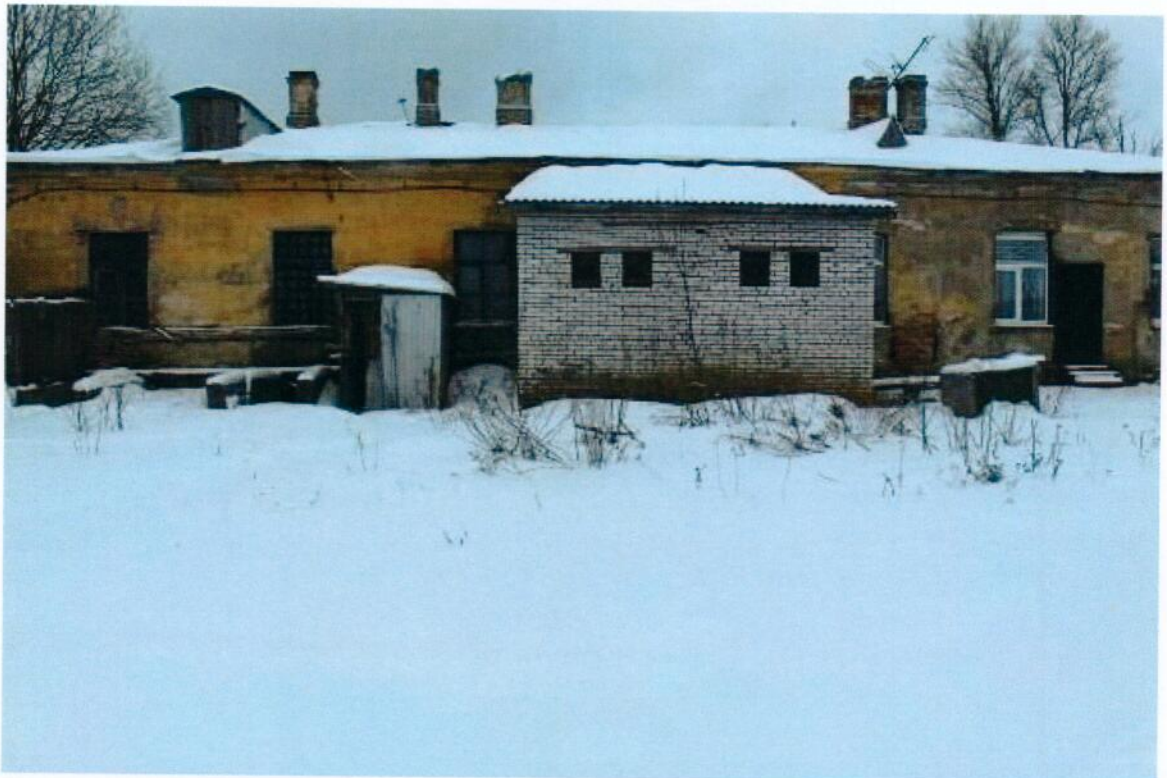
Фото 8. Главный корпус (вид во дворе).
