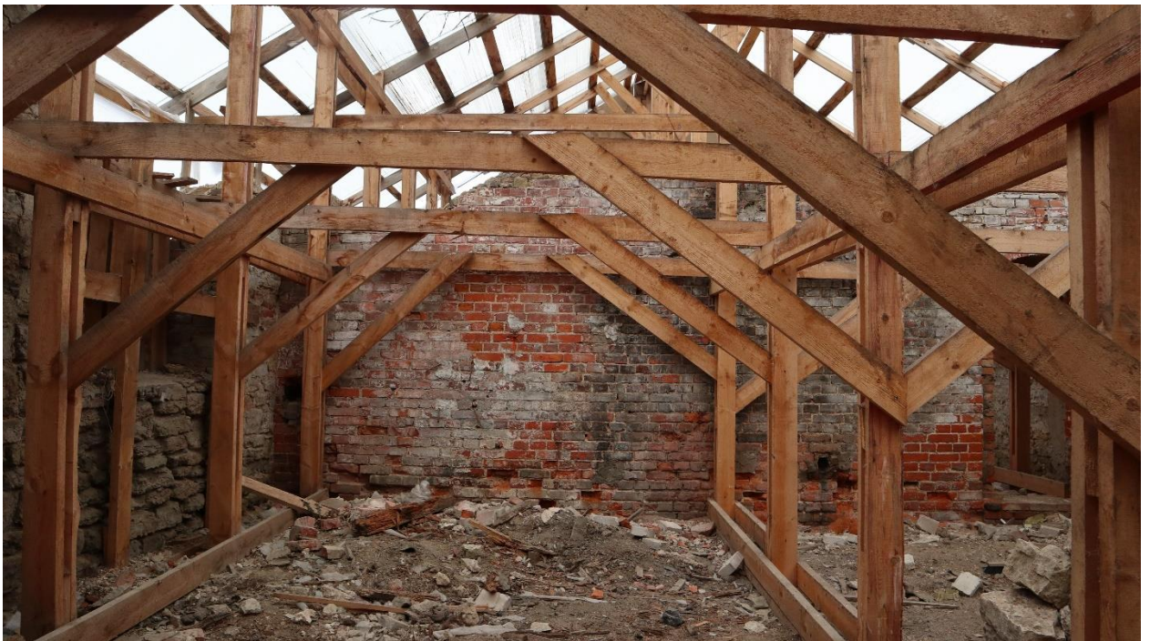
Фото 72. Помещение левого флигеля.
