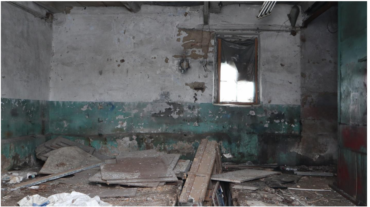
Фото 53. Помещение правого флигеля.
