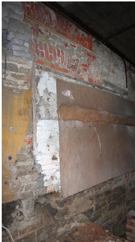
Фото 62. Помещение левого флигеля.
