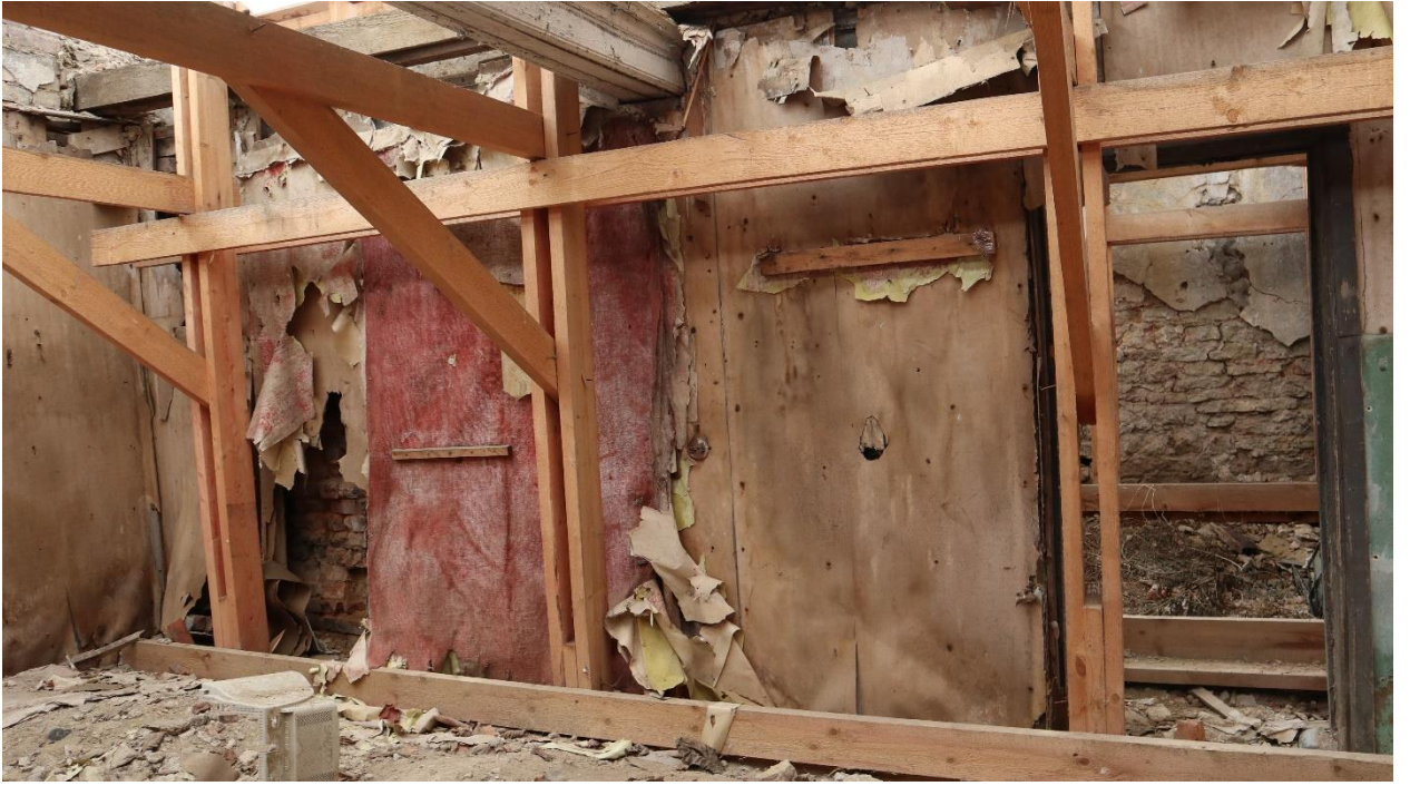
Фото 65. Помещение левого флигеля.
