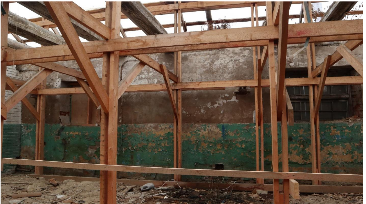
Фото 58. Помещение левого флигеля.
