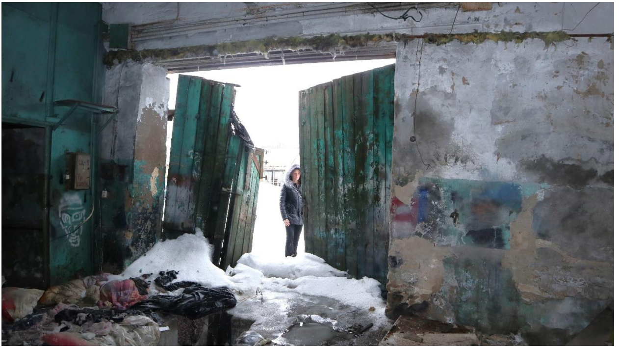
Фото 55. Помещение правого флигеля.
