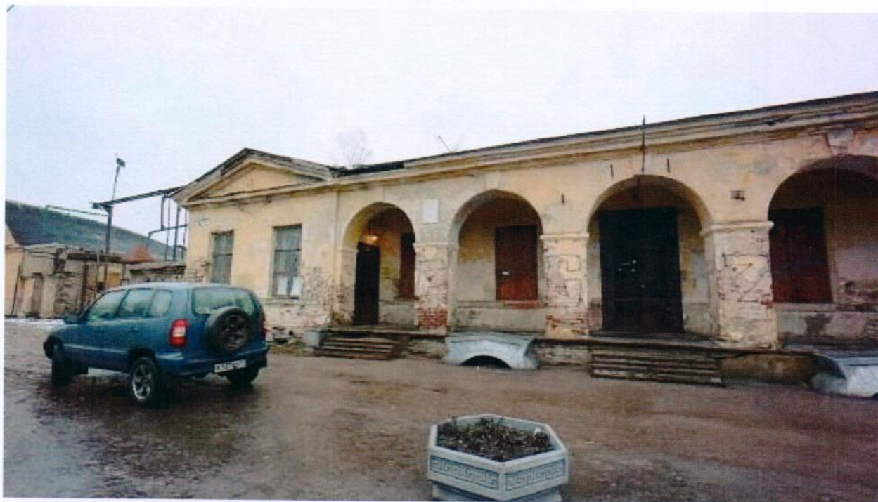
Фото 2. Общий вид. Главный корпус.
