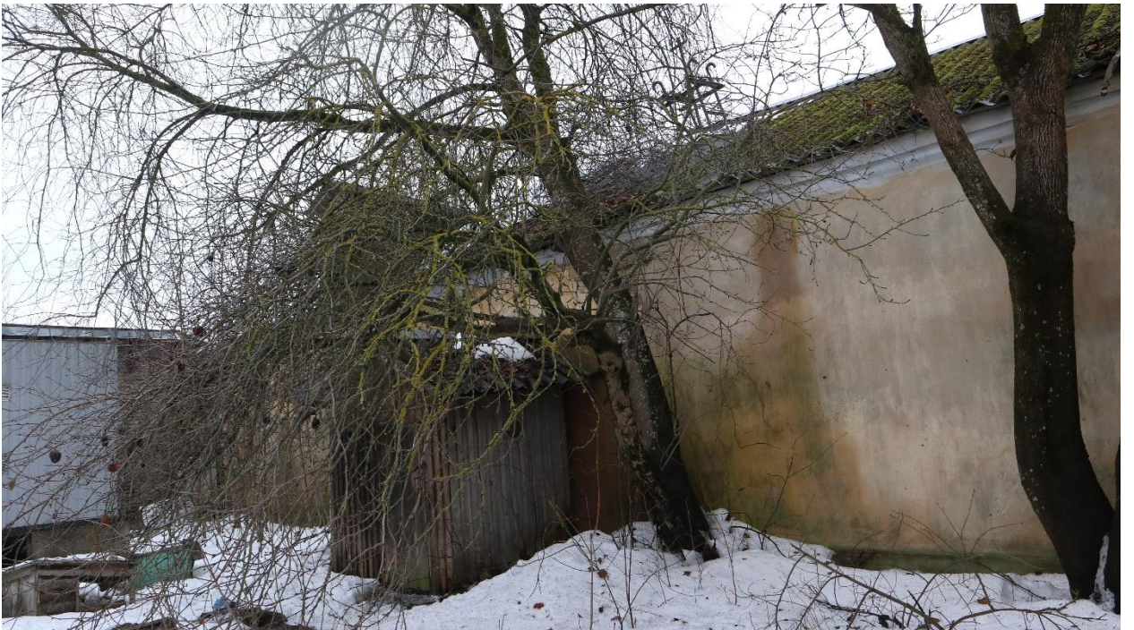
Фото 16. Дворовой фасад правого флигеля. Фрагмент.
