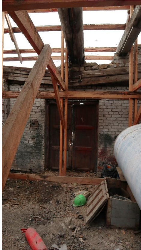
Фото 71. Помещение левого флигеля.
