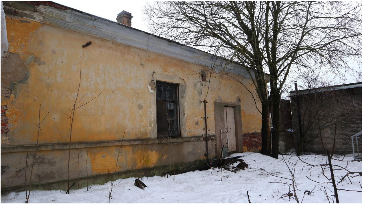
Фото 9. Восточный (торцевой) фасад главного здания почтовой станции.
