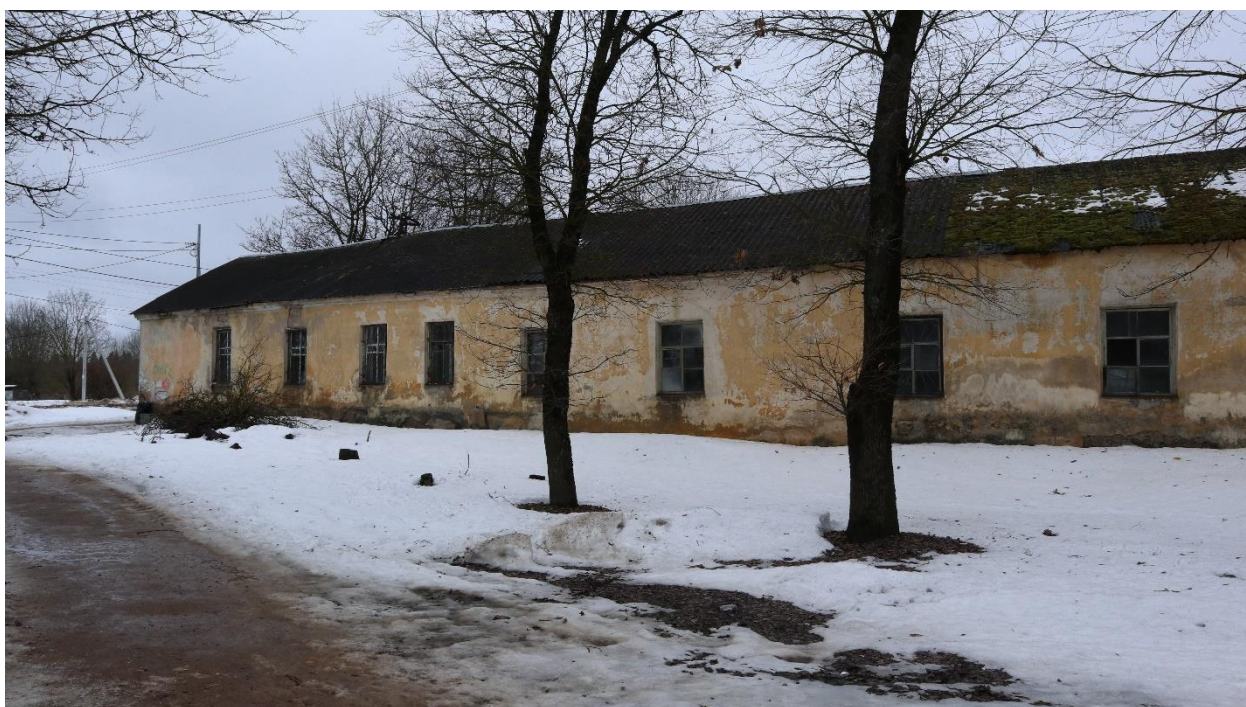
Фото 18. Лицевой восточный фасад правого флигеля. Фрагмент.
