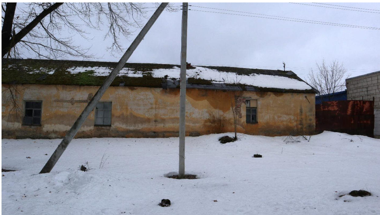
Фото 17. Лицевой восточный фасад правого флигеля. Фрагмент.
