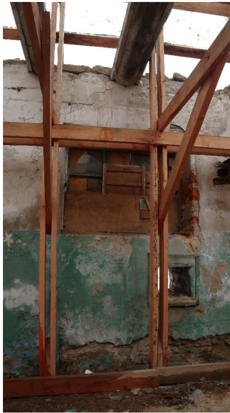
Фото 61. Помещение левого флигеля.
