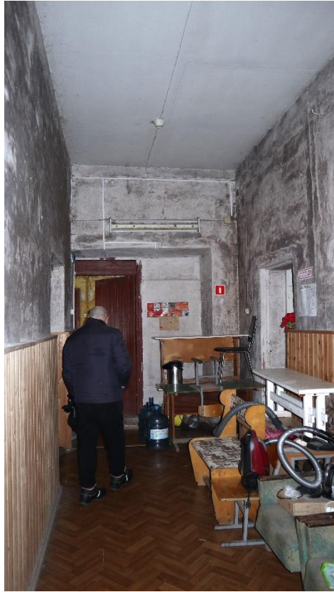
Фото 35. Помещение лицевого флигеля.
