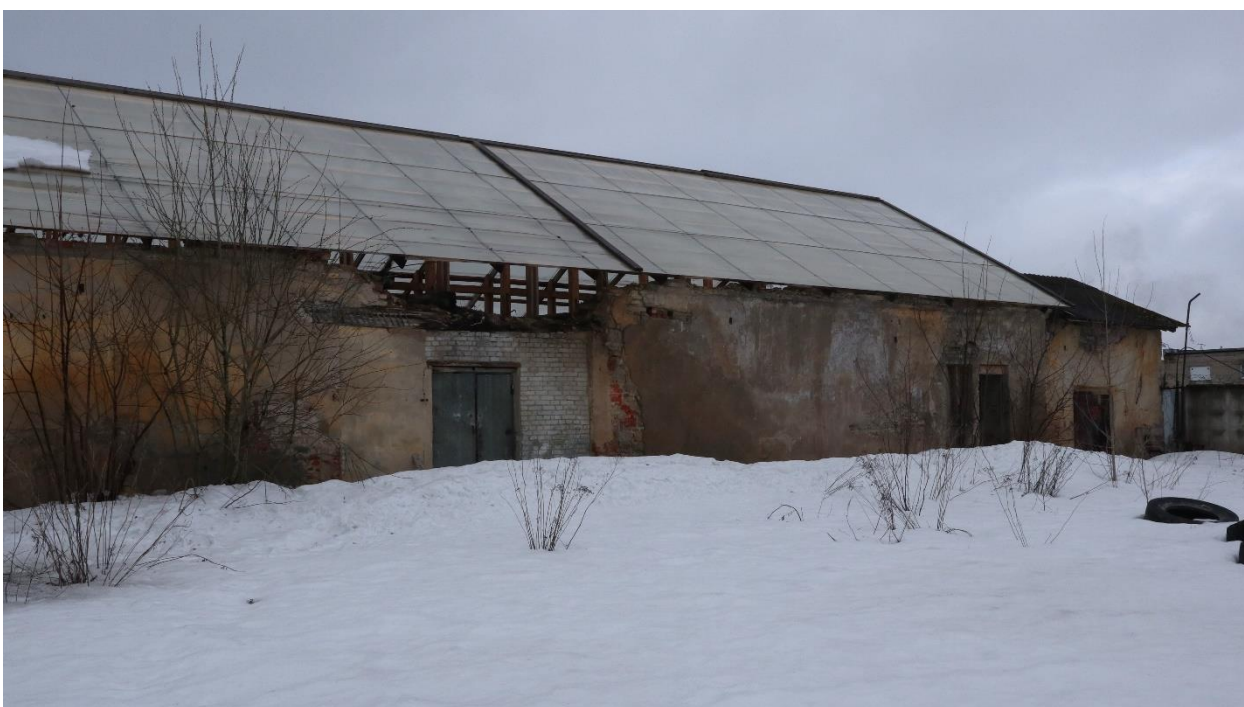
Фото 20. Дворовой (восточный) фасад левого флигеля. Фрагмент.
