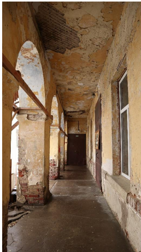
Фото 8. Лицевой фасад главного здания почтовой станции. Фрагмент. Центральная аркада.
