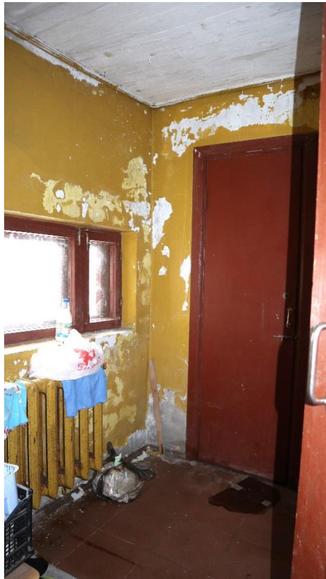
Фото 36. Помещение лицевого здания.
