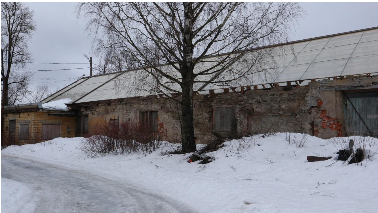
Фото 23. Дворовой (восточный) фасад левого флигеля. Фрагмент.
