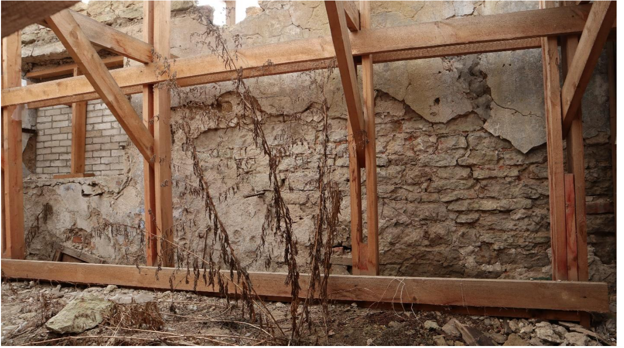
Фото 67. Помещение левого флигеля.
