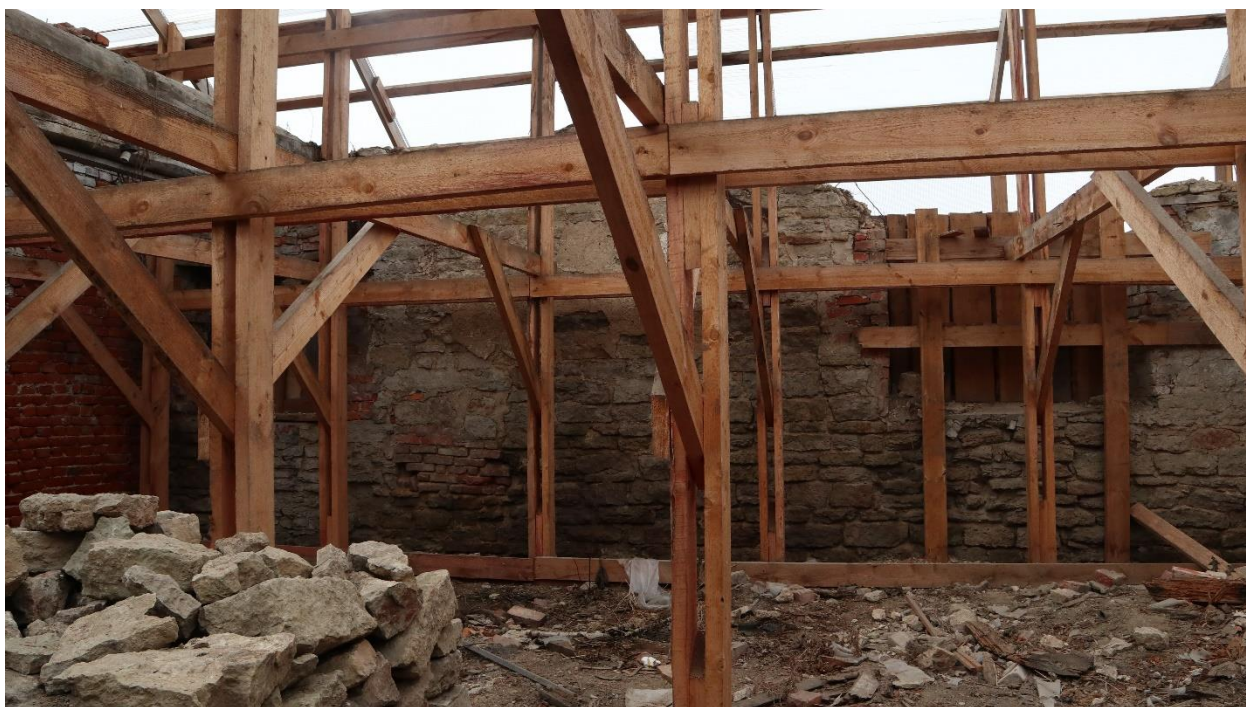
Фото 74. Помещение левого флигеля.
