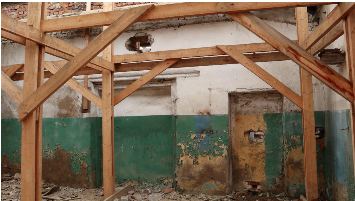
Фото 59. Помещение левого флигеля.
