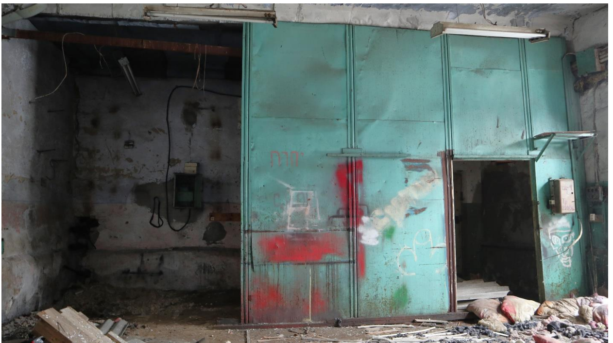
Фото 54. Помещение правого флигеля.
