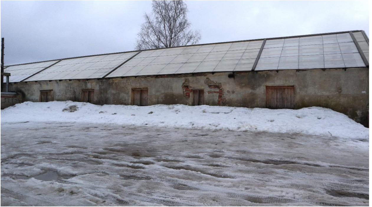
Фото 27. Левый (западный) флигель. Лицевой западный фасад.
