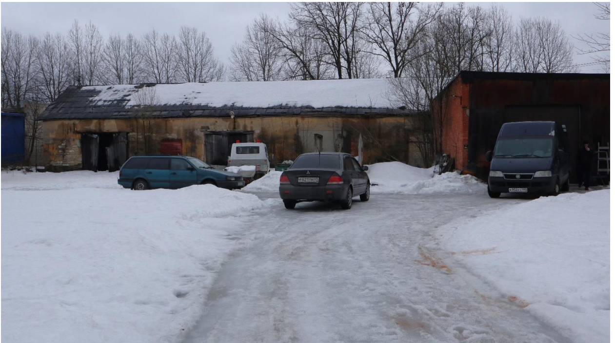
Фото 13. Дворовой фасад правого флигеля.
