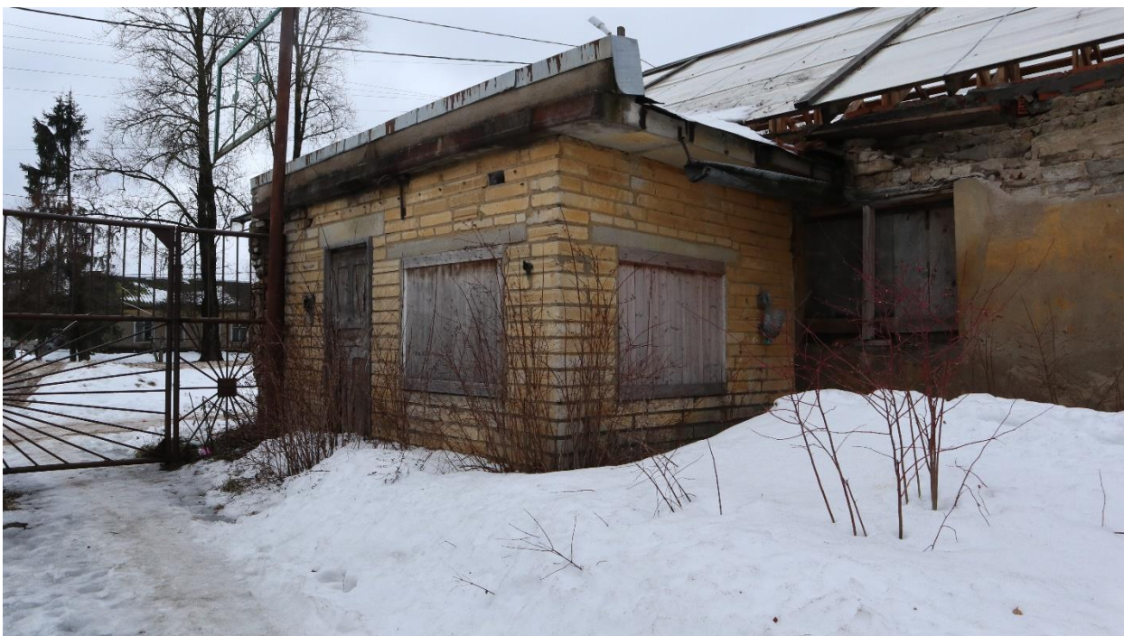
Фото 25. Пристройка к левому (западному) фасаду. Вид с дворовой территории.
