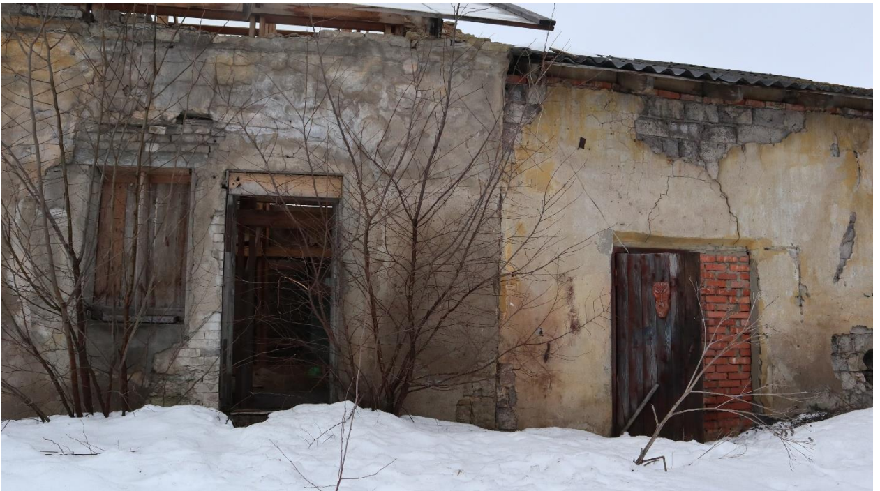
Фото 22. Дворовой (восточный) фасад левого флигеля. Фрагмент.
