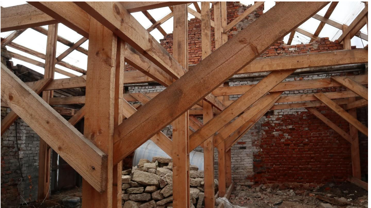
Фото 70. Помещение левого флигеля.
