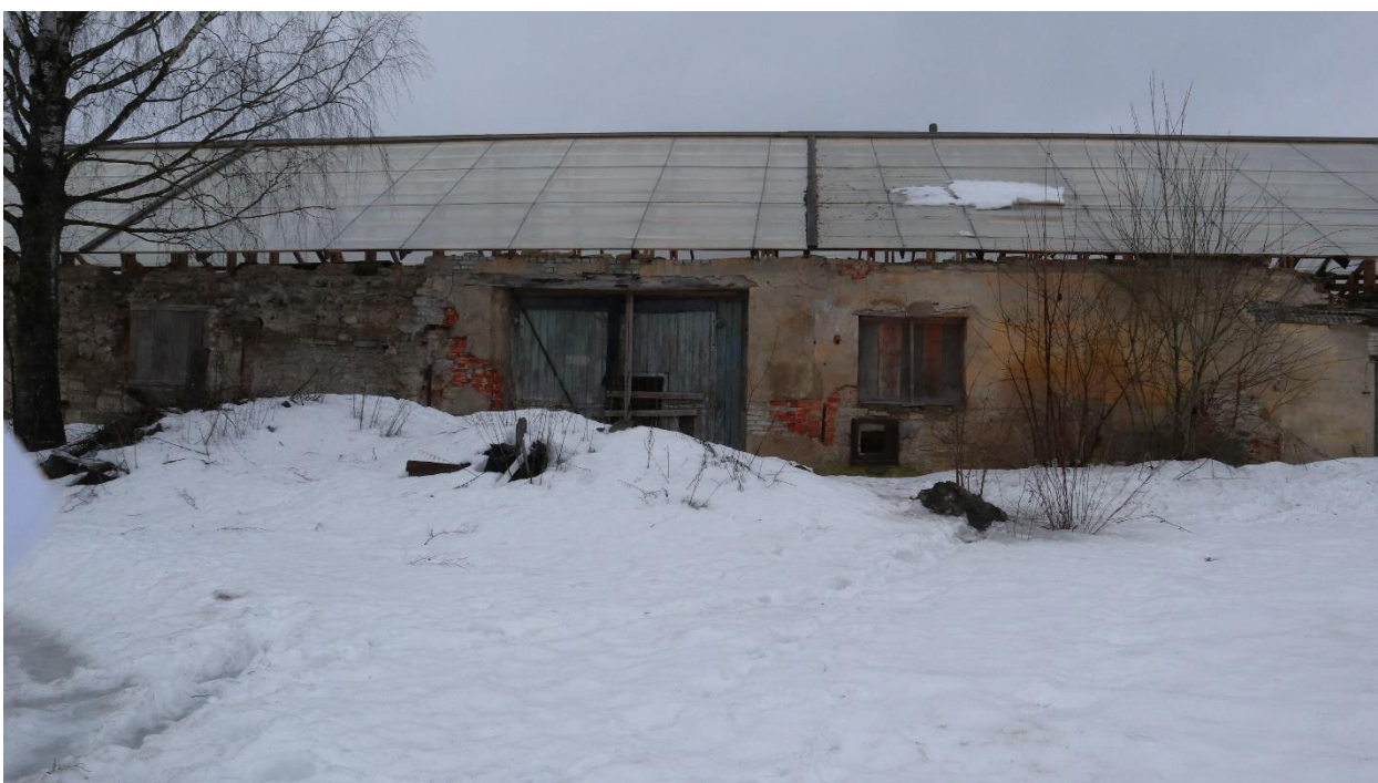
Фото 24. Дворовой (восточный) фасад левого флигеля. Фрагмент.
