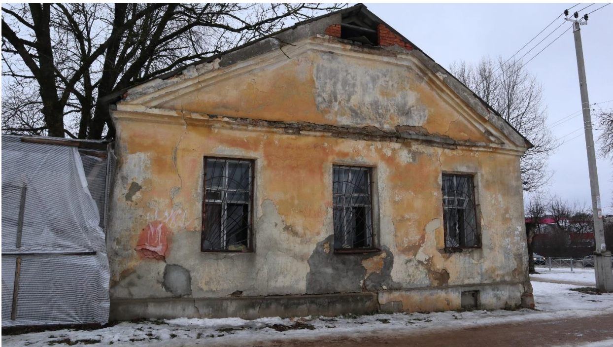
Фото 11. Лицевой (торцевой) фасад правого (восточного) флигеля.
