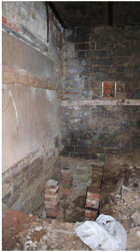
Фото 63. Помещение левого флигеля.
