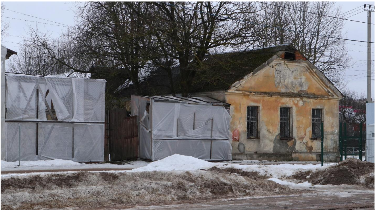
Фото 10. Лицевой (торцевой) фасад правого (восточного) флигеля.
