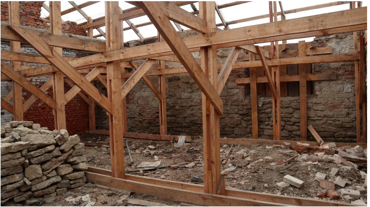
Фото 69. Помещение левого флигеля.
