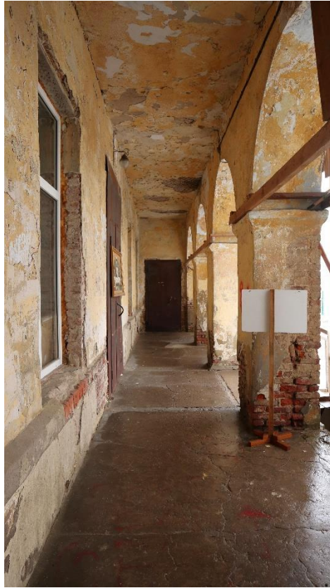
Фото 7. Лицевой фасад главного здания почтовой станции. Фрагмент. Центральная аркада.
