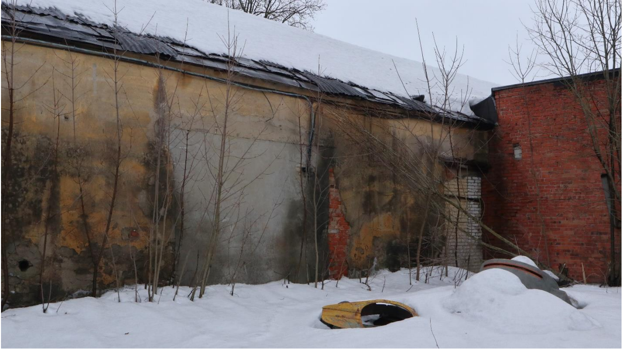
Фото 15. Дворовой фасад правого флигеля. Фрагмент.
