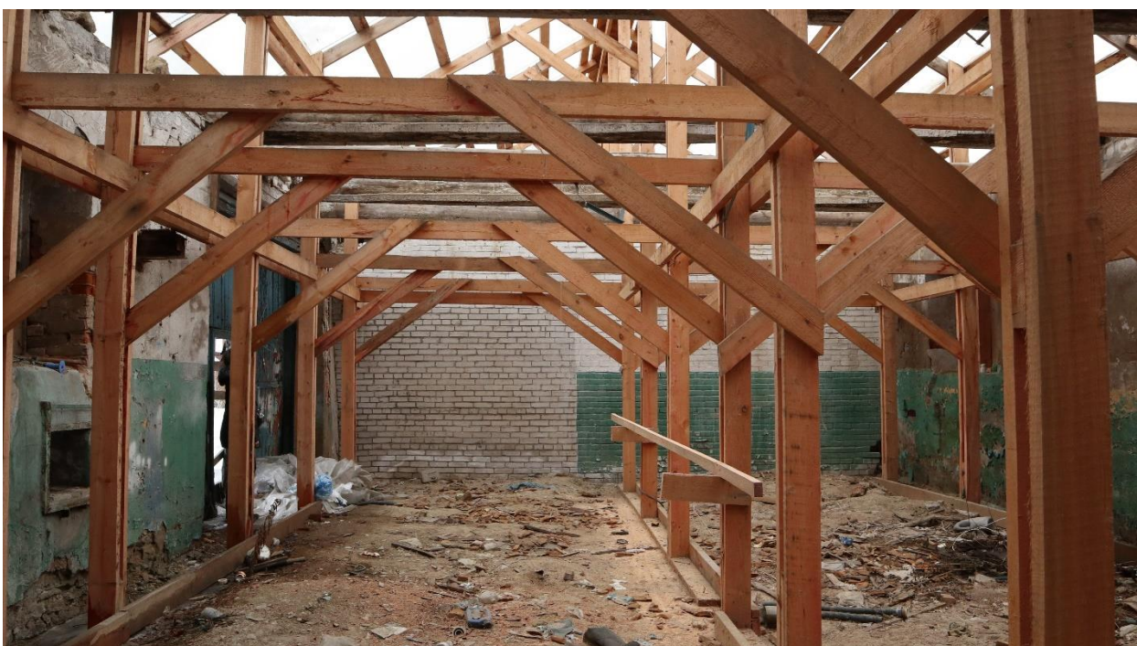
Фото 60. Помещение левого флигеля.
