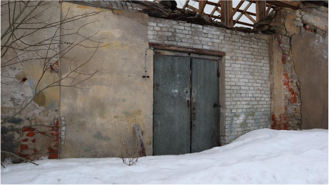
Фото 21. Дворовой (восточный) фасад левого флигеля. Фрагмент.
