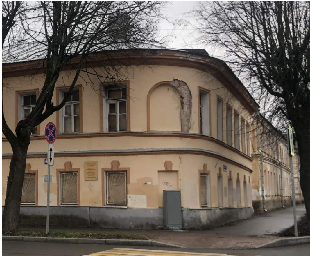
Фото 4. Фасад скругленного угла здания.
