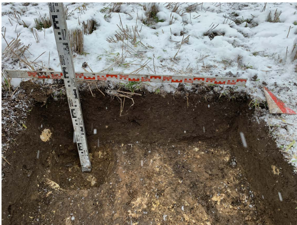
Илл. 22. Ленинградская область, Гатчинский район. 2023 г. «Межпоселковый газопровод до д. Авколево с отводом д. Вероланцы Гатчинского района». Шурф №1. Северная стенка и контрольный прокоп. Вид с Ю.
