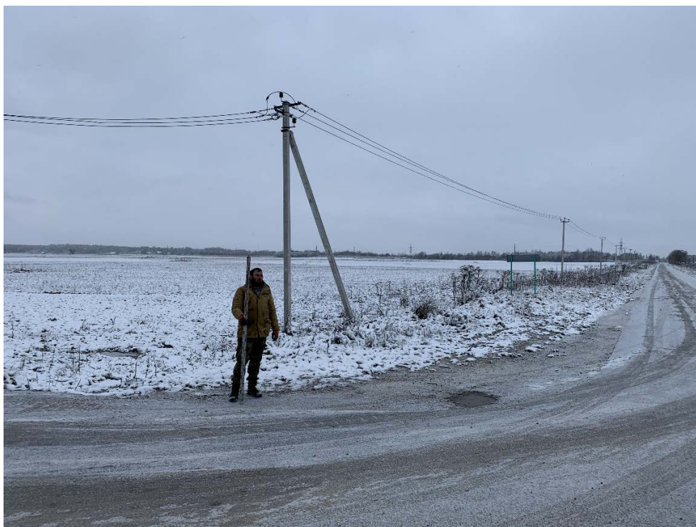
Илл. 36. Ленинградская область, Гатчинский район. 2023 г. «Межпоселковый газопровод до д. Авколево с отводом д. Вероланцы Гатчинского района». Общий вид участка обследования. Точка фотофиксации №5. Вид с ЮВ.
