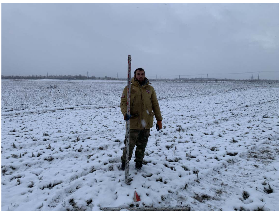
Илл. 39. Ленинградская область, Гатчинский район. 2023 г. «Межпоселковый газопровод до д. Авколево с отводом д. Вероланцы Гатчинского района». Шурф №3. Местоположение. Вид с Ю.
