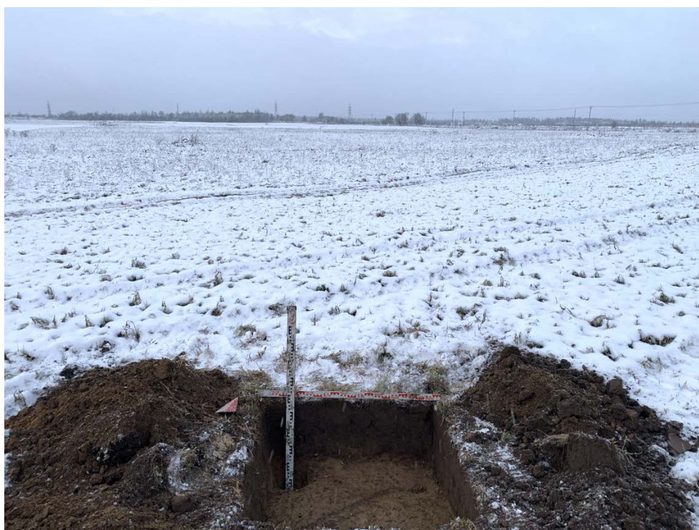
Илл. 41. Ленинградская область, Гатчинский район. 2023 г. «Межпоселковый газопровод до д. Авколево с отводом д. Вероланцы Гатчинского района». Шурф №3. Зачистка по матерiku. Общий вид с Ю.
