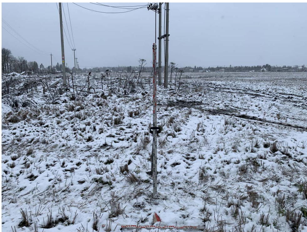
Илл. 18. Ленинградская область, Гатчинский район. 2023 г. «Межпоселковый газопровод до д. Авколево с отводом д. Вероланцы Гатчинского района». Шурф №1. Местоположение. Вид с Ю.
