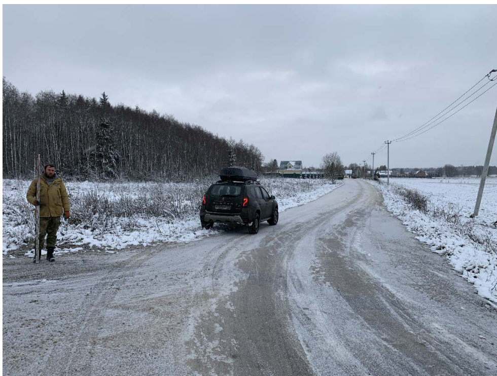
Илл. 38. Ленинградская область, Гатчинский район. 2023 г. «Межпоселковый газопровод до д. Авколево с отводом д. Вероланцы Гатчинского района». Общий вид участка обследования. Точка фотофиксации №5. Вид с СВ.
