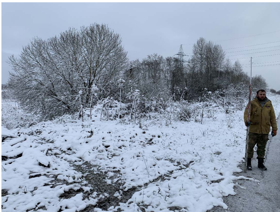
Илл. 26. Ленинградская область, Гатчинский район. 2023 г. «Межпоселковый газопровод до д. Авколево с отводом д. Вероланцы Гатчинского района». Общий вид участка обследования. Точка фотофиксации №2. Вид с СЗ.
