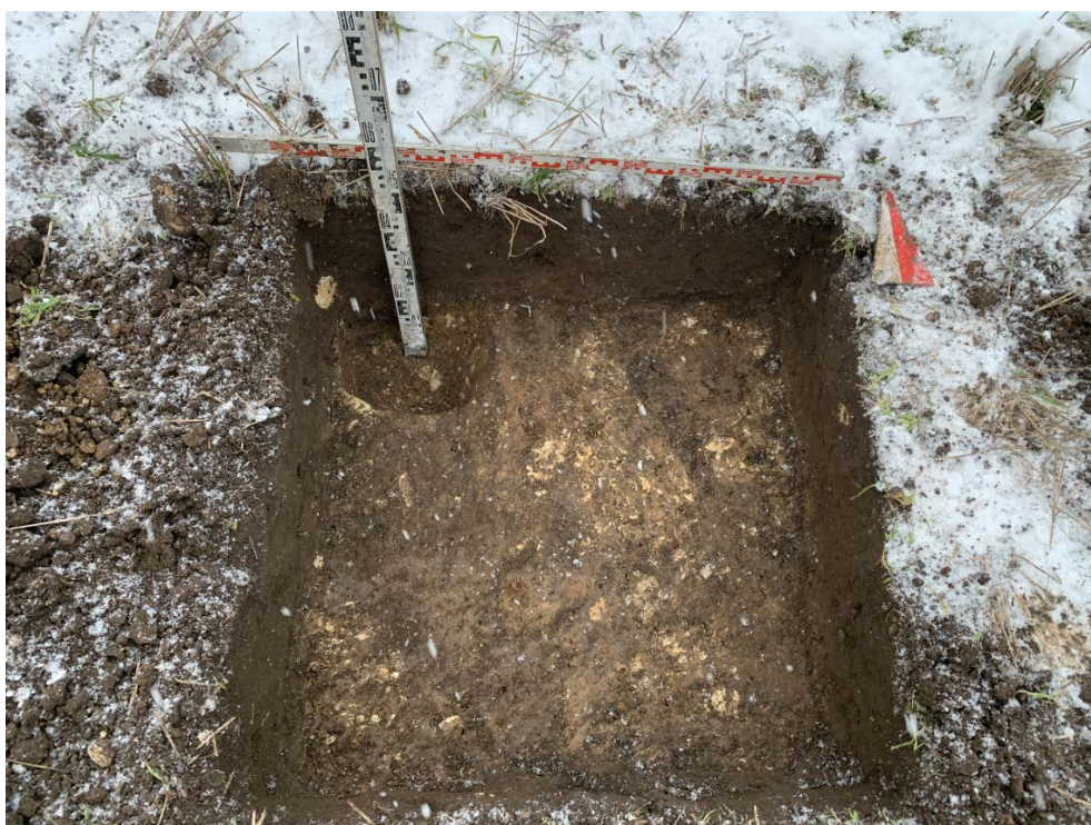
Илл. 21. Ленинградская область, Гатчинский район. 2023 г. «Межпоселковый газопровод до д. Авколево с отводом д. Вероланцы Гатчинского района». Шурф №1. Материк. Предметный вид с Ю.
