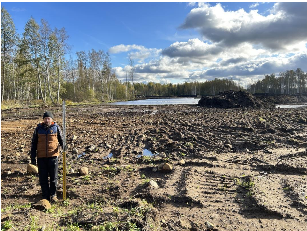
Илл. 15. Пос. им. Морозова. Земельный участок кад. номер 47:07:1703021:150. Точка фотофиксации Ф4. Вид на участок с северо-запада. 23.10.2023 г.
