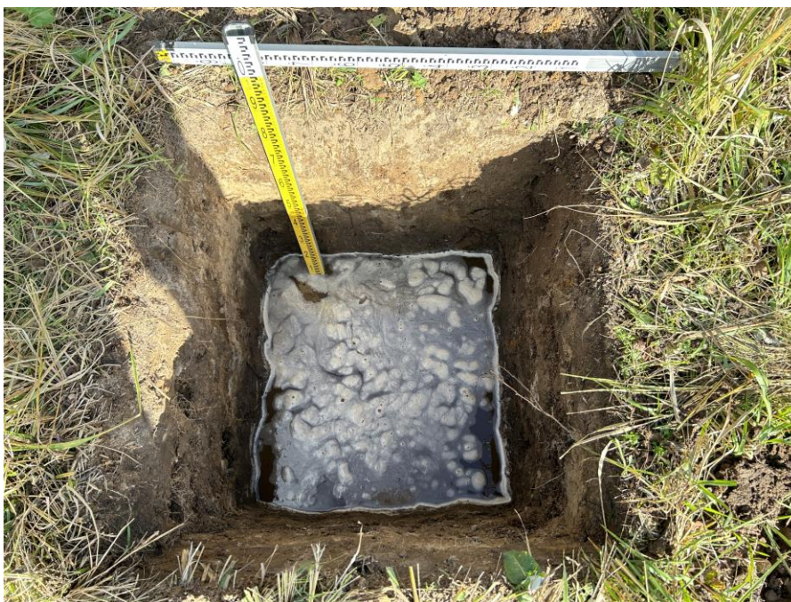
Илл. 24. Пос. им. Морозова. Земельный участок кад. номер 47:07:1703021:150. Шурф 2 по завершении земляных работ. Вид с юга сверху.
