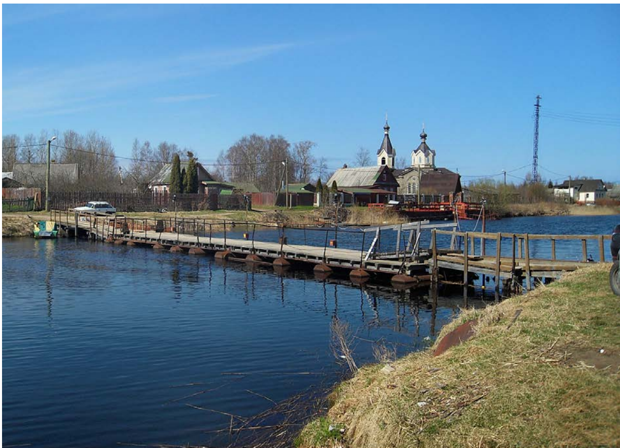
Илл. 67. Наплавной мост через Новоладожский канал в с. Черное. 2017 г.
