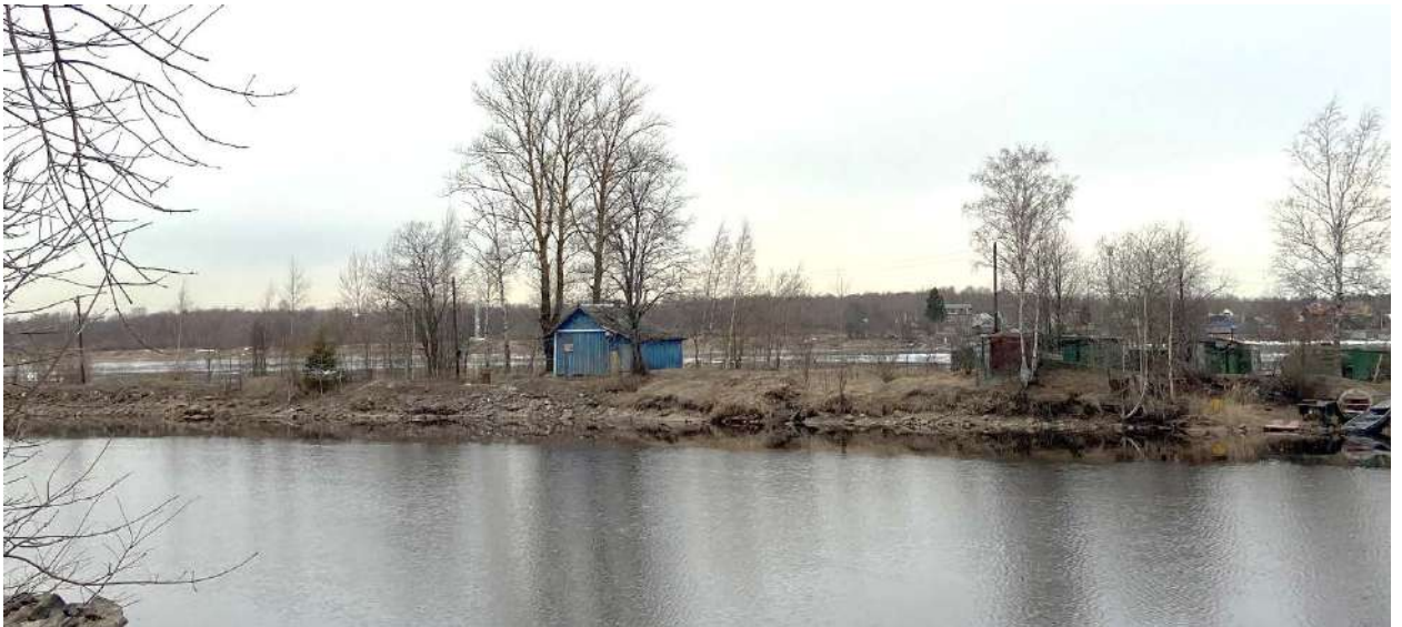
Фото 3.1. Вид на историческую дамбу, устроенную вдоль Ладожского озера, берега оплыли, частично видно берегоукрепление в виде каменной наброски, на дамбе расположились поздние строения.
