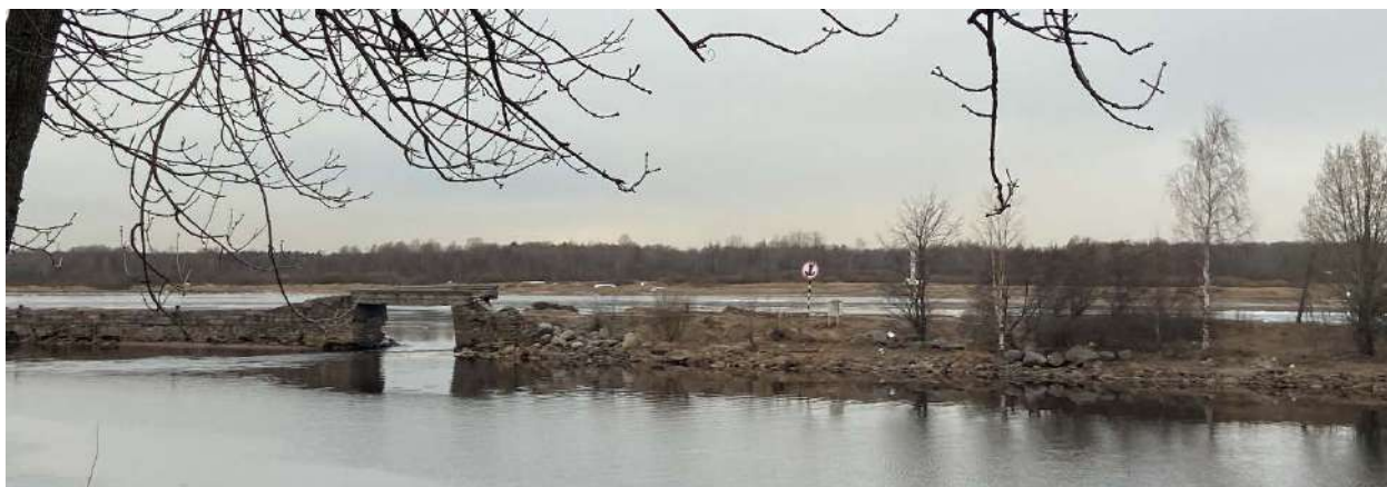
Фото 2. Вид на сопряжения участка первоначальной дамбы, устроенной со стороны Ладожского озера и участка мола, устроенного позже в 1906 г.
