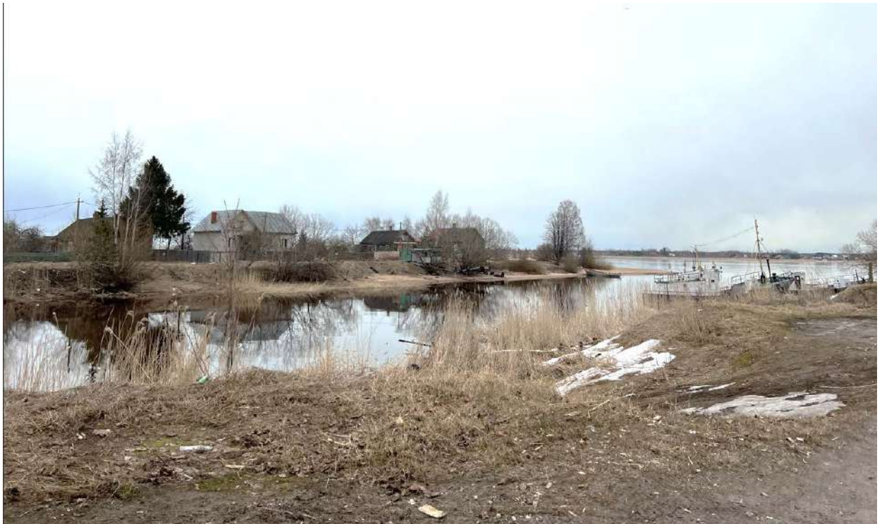
Фото 10. Вид на исток Новолодожского канала из р. Волхов, на берегу в пределах жилой застройки размещены различные причалы лодок и спуски к воде.
