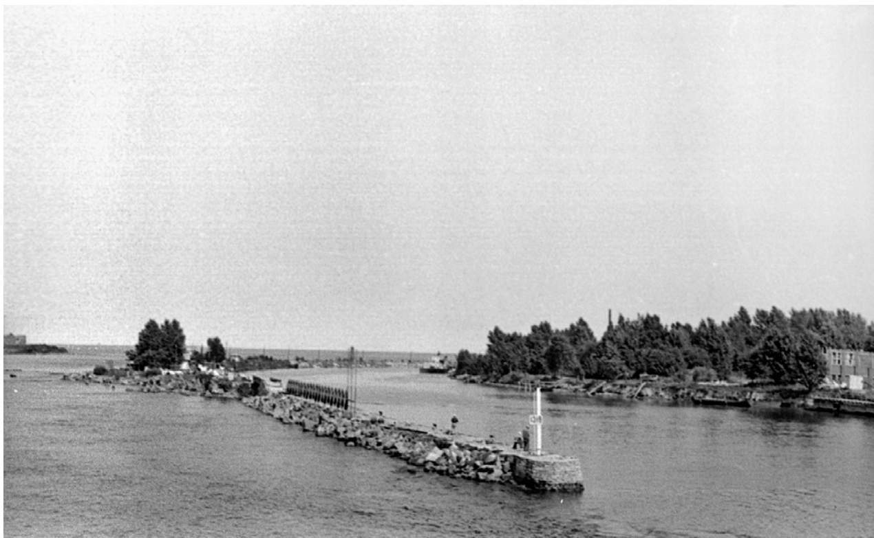
Илл. 39. Вход в Новоладожский канал. 1981 г.
