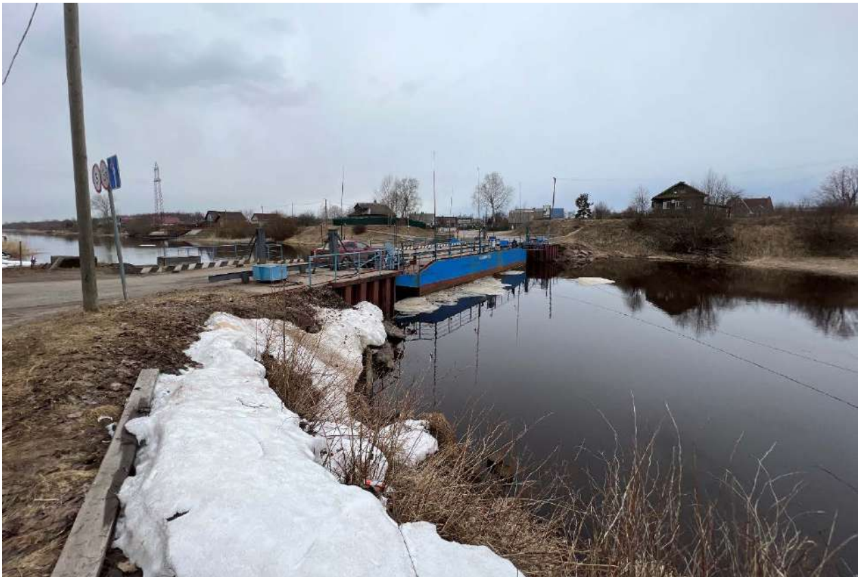
Фото 5. Вид на мост через Новоладожский канал с восточной стороны (со стороны р.Волхов)
