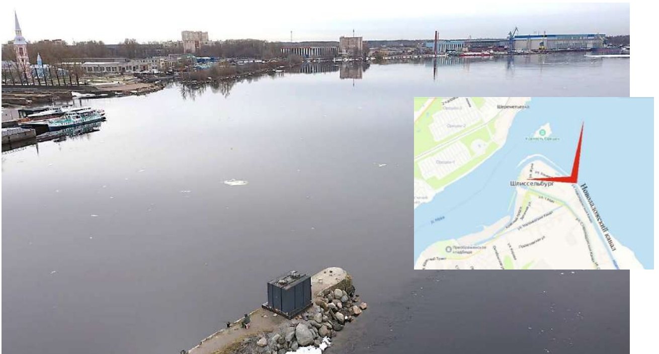
Фото 4. (аэрофотосъемка) Вид на оконечность Новолодожского канала в г. Шлиссельбурге и реку Неву.
