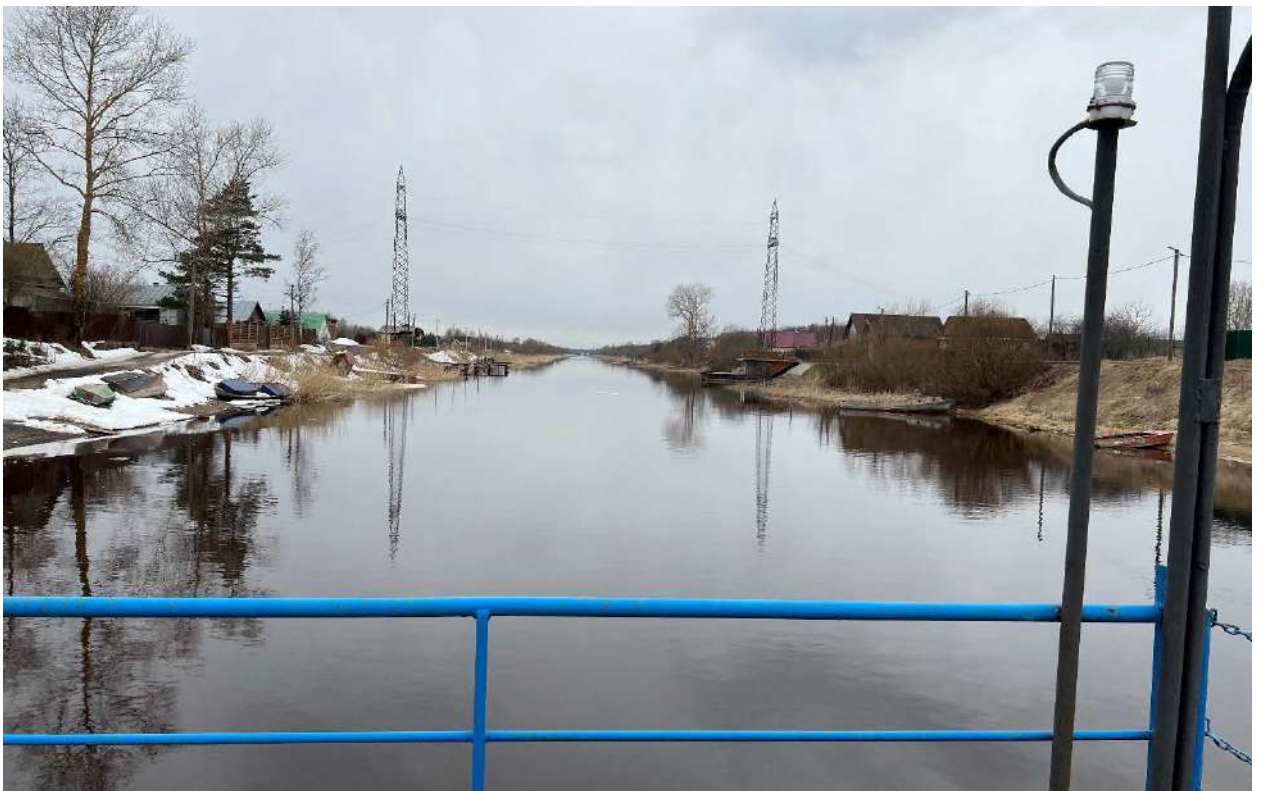
Фото 6. Вид по оси Новоладожского канала в западном направлении с моста через канал в г. Новой Ладогe.
