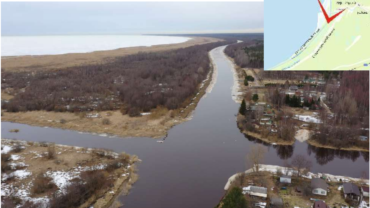
Фото 23. (аэрофотосъемка) Вид на Новолодожский канал, проходящий вдоль Ладожского озера в сторону г. Новой Ладоги, и место пересечения с р. Лавой.
