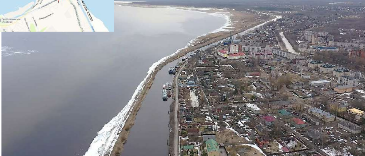
Фото 2. (аэрофотосъемка) Вид на участок Новоладожского канала в г. Шлиссельбурге.
