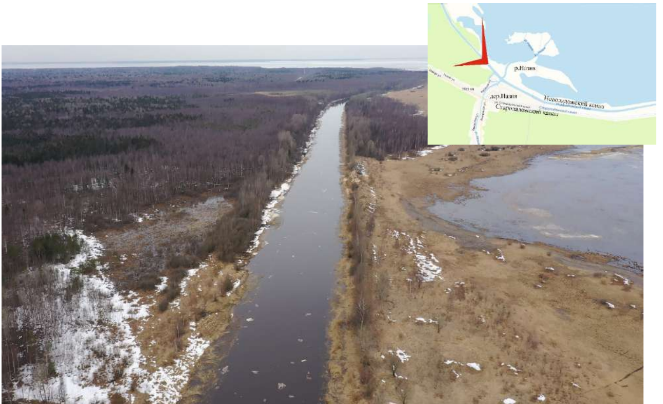
Фото 16. (аэрофотосъемка) Вид на Новолодожский канал в западном направлении (в сторону Шлиссельбурга).
