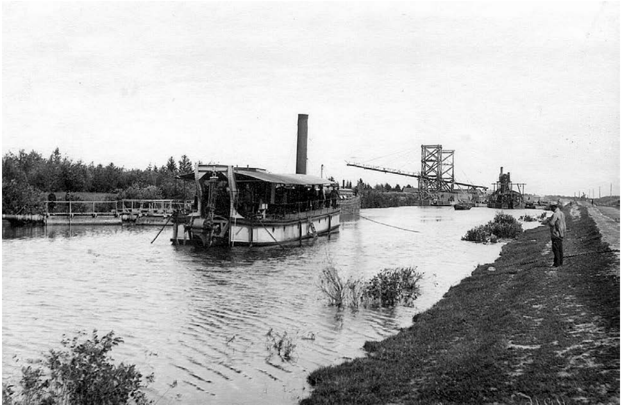
Илл. 53. Канал императора Александра II. Работы по углублению канала. 1908 г. – ЦГАКФФД.
