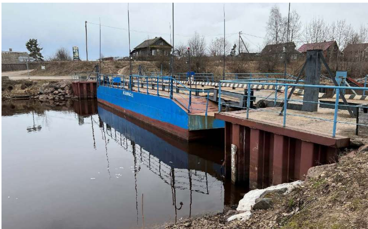
Фото 4. Вид на мост через Новоладожский канал с западной стороны в г. Новой Ладоге.
