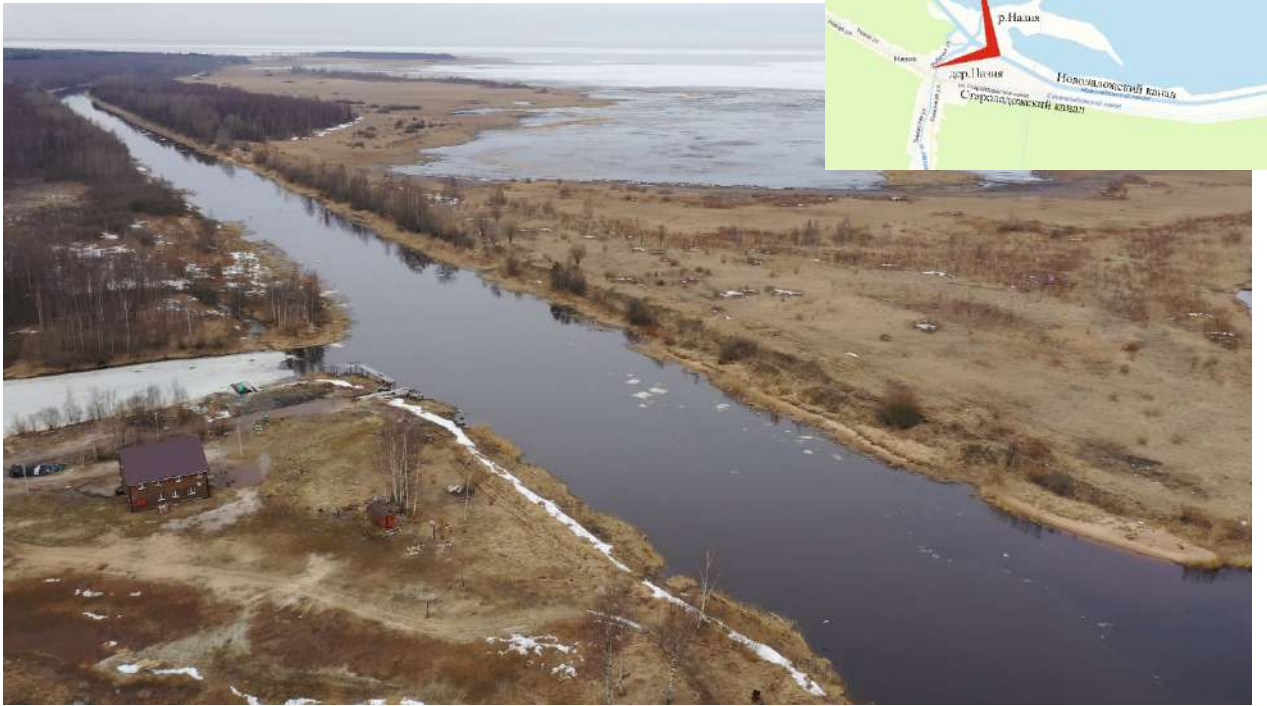
Фото 15. (аэрофотосъемка) Вид на Новолодожский канал в западном направлении (в сторону Шлиссельбурга).
