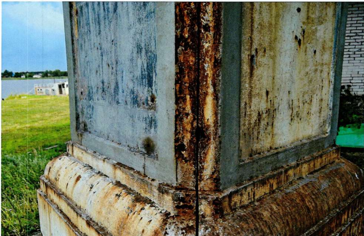
Фото 5. Обелиск, сооруженный в честь строительства Ладожского канала. Место соединения двух элементов пьедестала. Вид с запада.
