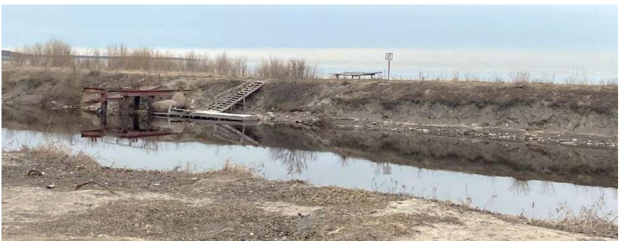
Фото 3.4. Вид на Новолодожский канал, вдоль берега устроены спуски к воде.
