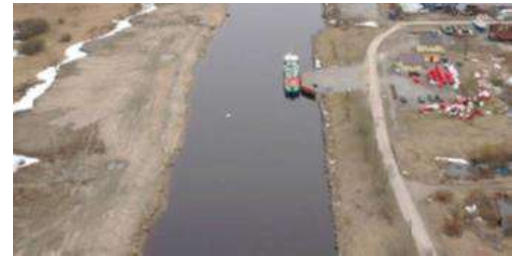
Вид на Новолоджский канал и трассы прибрежных бечевников к востоку от Шлиссельбурга
