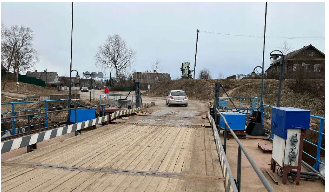
Фото 8. Вид с моста на берег и сопряжение пролетной части моста с проезжей дорогой.
