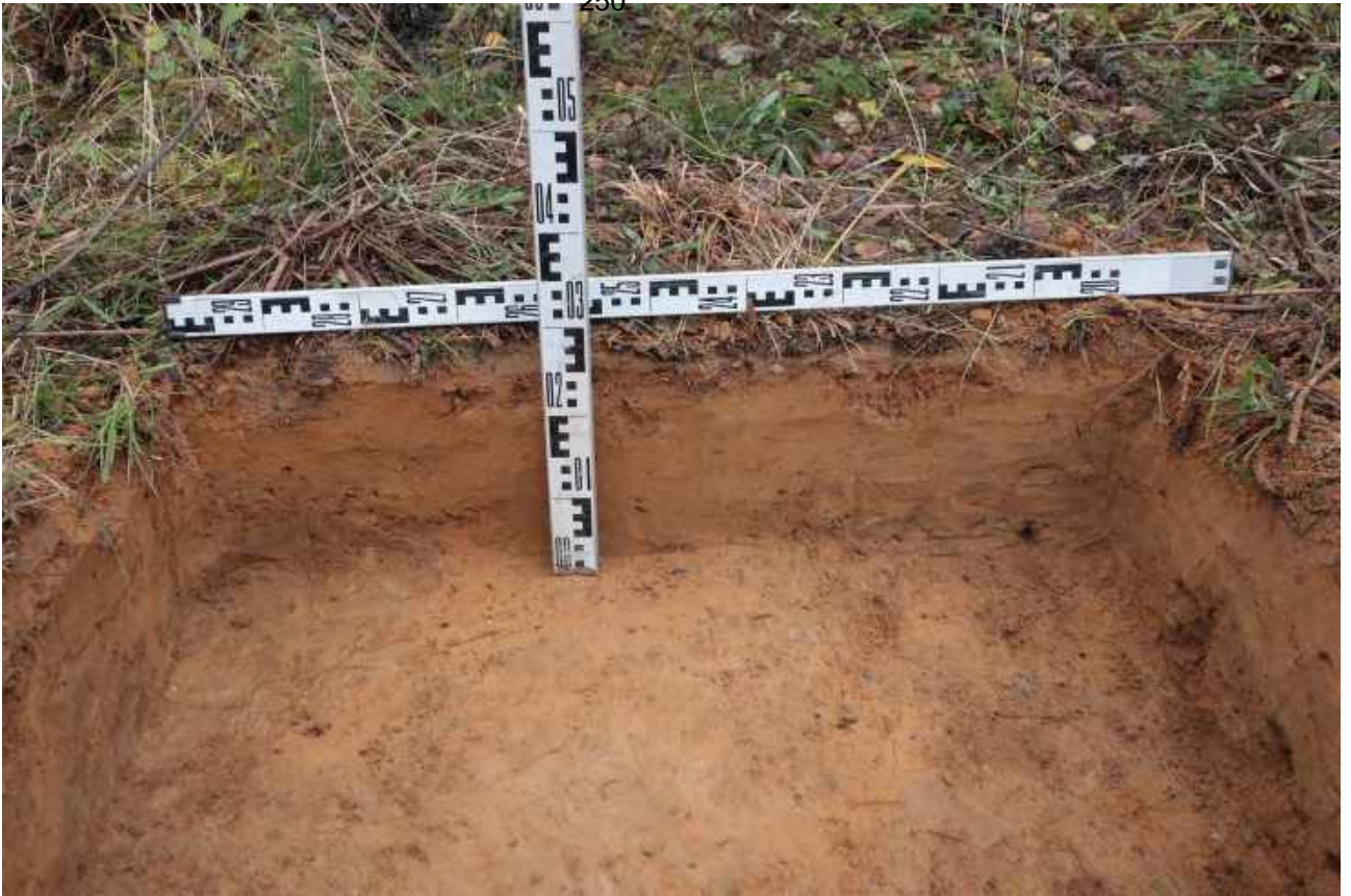
Рис. 199. Ленинградская область, Всеволожский район. «Рекреационно - досуговый парк, расположенный по адресу: Ленинградская область, Всеволожский муниципальный район, г.п. Токсово, ул. Некрасова». Шурф 38. Стратиграфия северной стенки. Вид с юга
