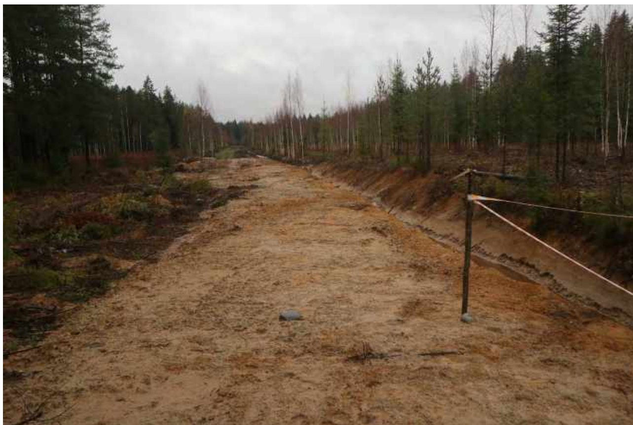
Рис. 48. Ленинградская область, Всеволожский район. «Рекреационно - досуговый парк, расположенный по адресу: Ленинградская область, Всеволожский муниципальный район, г.п. Токсово, ул. Некрасова». Прокладка мелиоративной канавы в западной части территории обследования. Вид с юга
