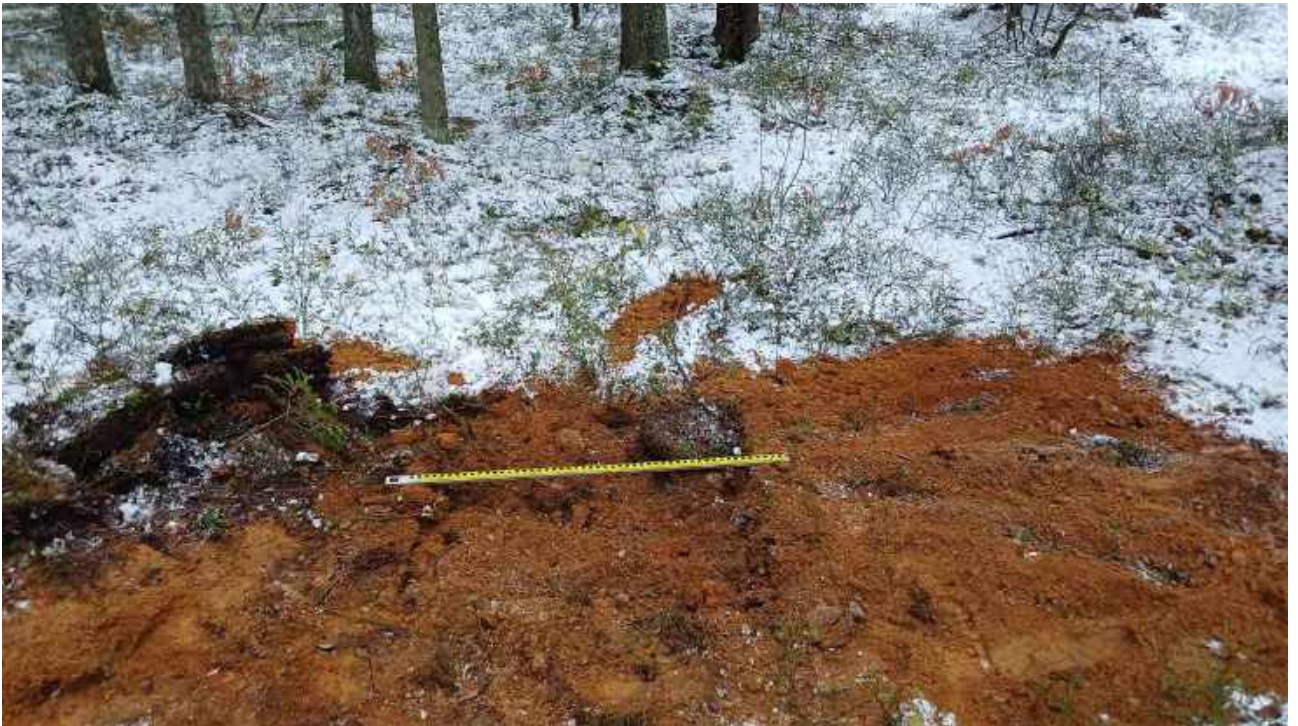
Рис. 330. Ленинградская область, Всеволожский район. «Рекреационно - досуговый парк, расположенный по адресу: Ленинградская область, Всеволожский муниципальный район, г.п. Токсово, ул. Некрасова». Шурф 72. Рекультивация. Вид с юга
