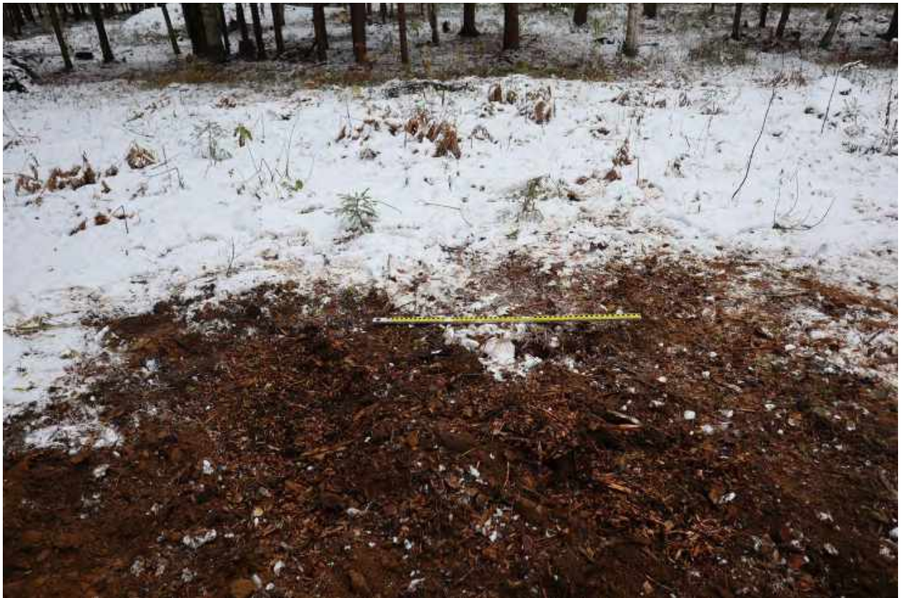
Рис. 282. Ленинградская область, Всеволожский район. «Рекреационно - досуговый парк, расположенный по адресу: Ленинградская область, Всеволожский муниципальный район, г.п. Токсово, ул. Некрасова». Шурф 60. Рекультивация. Вид с юга
